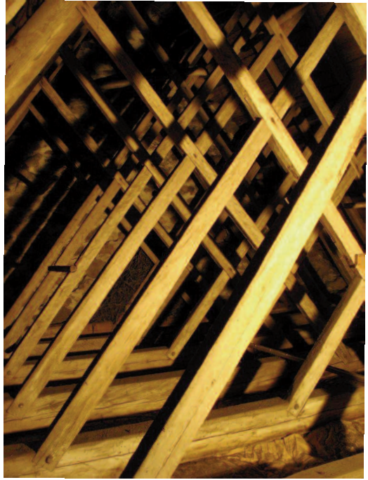
Fig. 6. Det tidigmedeltida taklaget över långhuset i Norra Solberga gamla kyrka. Foto förf. – Roof trusses of the nave of Norra Solberga Old Church.
