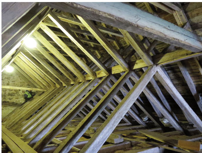
Fig. 2. Det tidigmedeltida taklaget över långhuset i Kumla kyrka. Notera den profilerade styrplankan som nu ligger upp och ned på bindbjälkarna. Foto förf. —The early medieval roof trusses of the nave of Kumla Church.
