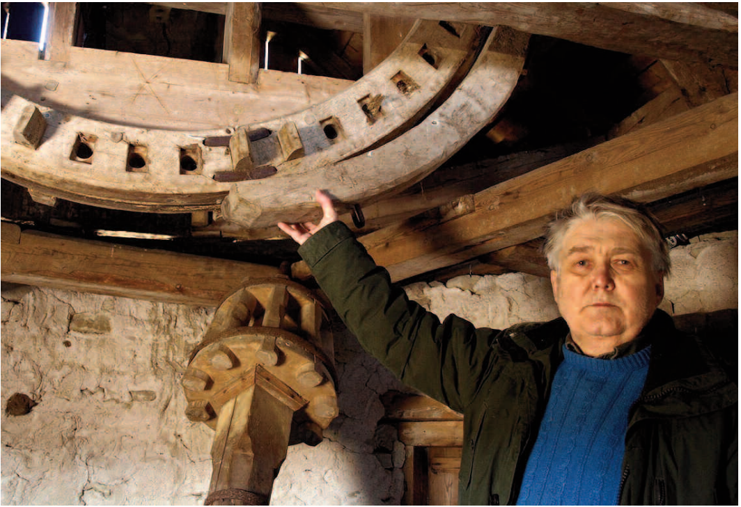
Fig. 3. Den mittersta av tre väderkvarnar vid Hundlausar i Vamlingbo, 1800-talet. Förf. med det stora balanshjulet och dess friktionsbroms »pärseen». Foto förf
