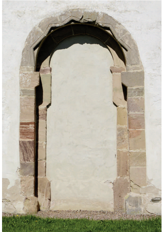
Fig. 3. Sydportalen med chevrongsmyskad båge av sandsten. Foto förf. —South portal with chevron decoration.
