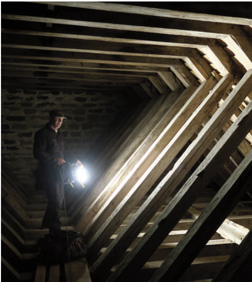
Fig. 4. Långhusets taklag sett från väster. Foto förf. —Nave's roof beams.
