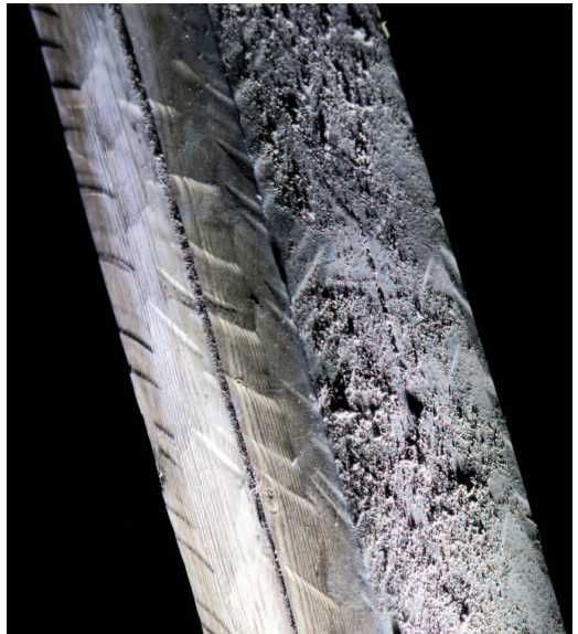
Fig. 5. Sprätthuggning på stödben. Foto förf. —Surface treatment on roof strut.
