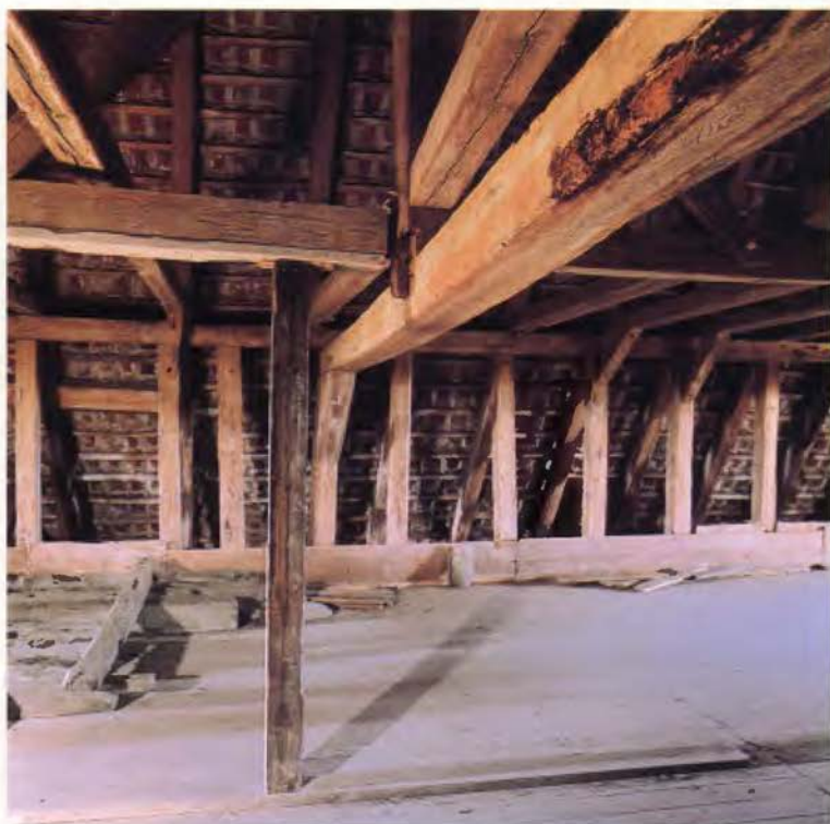
Den övre vinden med sin imponerande takstol och det understrukna tegeltaket.
