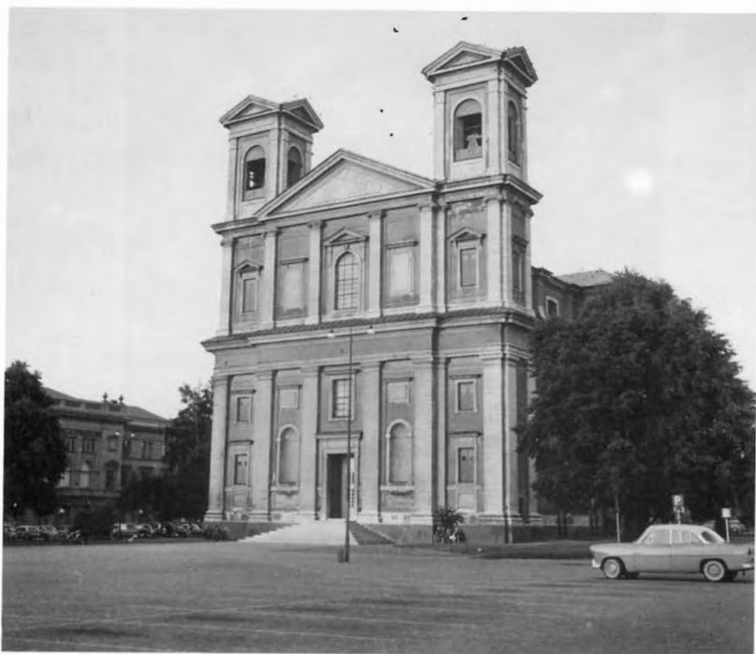
Figur 54. Fredrikskyrkan i Karlskrona med lisener och omfattningar av öländsk kalksten. Uppförd efter ritningar av Nicodemus Tessin d.y. 1721-44. Foto S. Hallgren 1960, Riksantikvarieämbetet.
