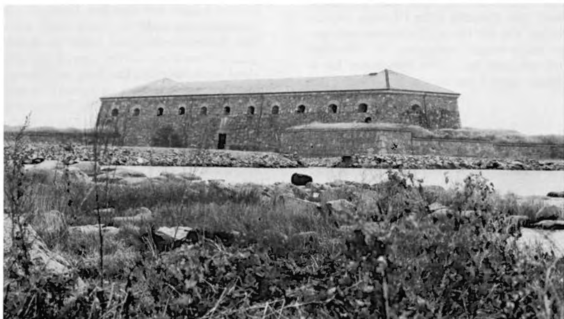
Figur 53. Drottningkärs kastell med fasader av grovt huggen granit samt omfattningar, friser och inskriftstavlor av öländsk kalksten, 1680–1750. Uppförd efter ritningar av Erik Dahlberg. Fotograf okänd, ca 1970, Blekinge läns museum.
