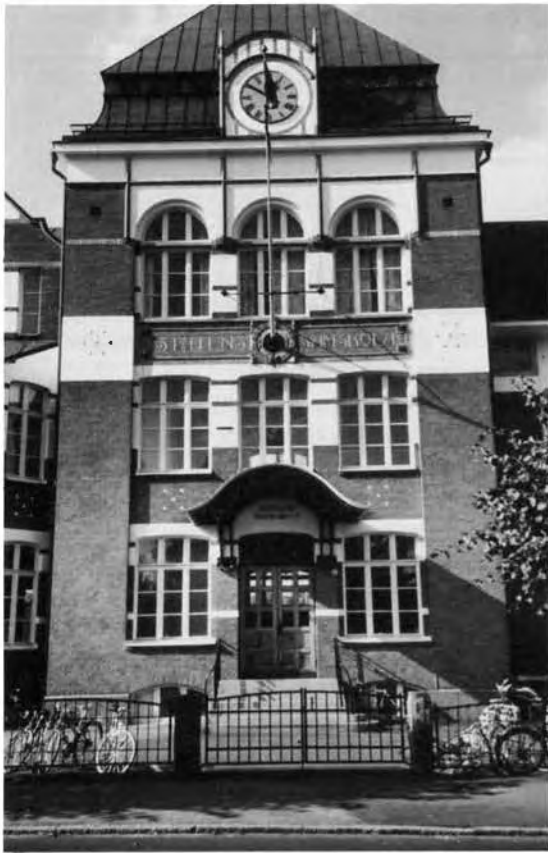
Figur 41. Statens samskola från 1906, Vimmerby. Inskriftstavla av troligen öländsk kalksten, lister och omfattningar av Yxhultskalksten. Foto Ö. Molander 1992, Länsstyrelsen i Kalmar.
