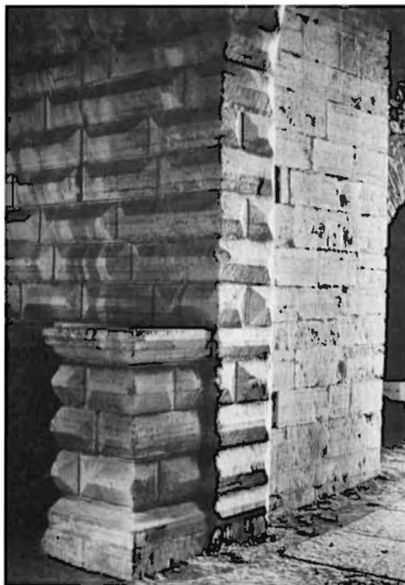
Figur 37. Diamantrusicering av öländsk kalksten, 1580-tal. Borgholms slottsruin, Öland. Foto R. Edlund 1992, Länsstyrelsen i Kalmar.
