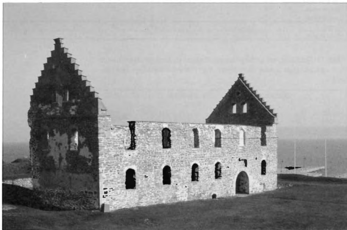
Figur 9. Visingsborgs slott är ett av länets få slottsbyggnader. Ätten Brahe byggde upp slottet under 1500- och 1600-talen. Idag återstår endast vallar, bastioner och ruinen efter den södra slottslängan. Finhuggen natursten är sparsam och återfinns bl.a. som dörrromfattningar av Visingsösandsten. Foto C. Hederström 1995, Jönköpings läns museum.
