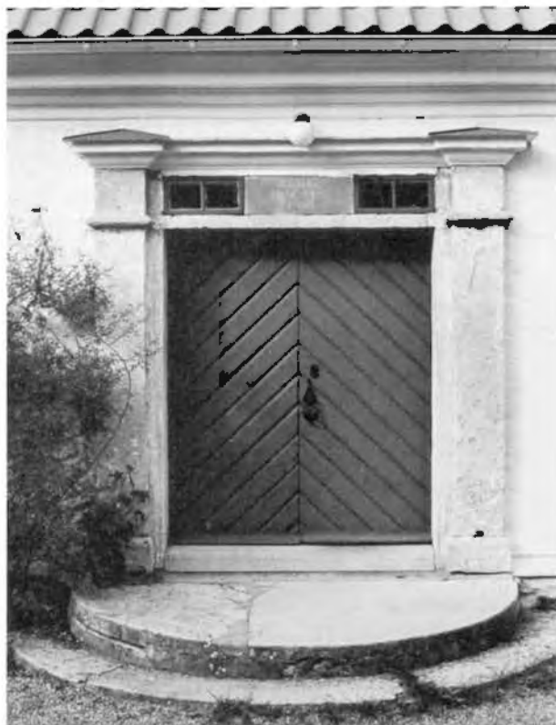
Figur 38. Löts f.d. skolhus med portal från 1850, öländsk kalksten. Foto R. Edlund 1992, Länsstyrelsen i Kalmar.
