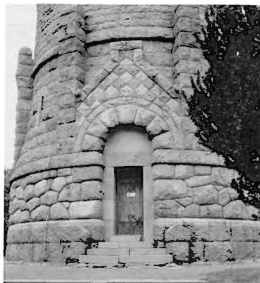
Figur 13. I vattentornet i Eksjö från 1898 har den okända arkitekten laborerat med olika urbergarter med olika kulör och behuggning. Uttrycksformen tycks närmast ansluta sig till amerikanska förebilder. Foto A. Franzén 1992, Jönköpings läns museum.
