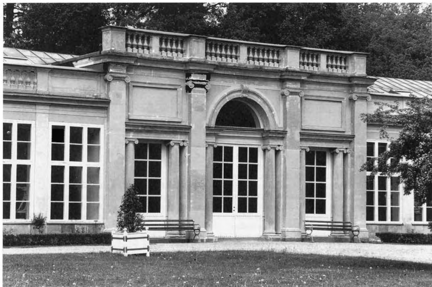
Figur 11. Ulriksdals orangeri av Nicodemus Tessin den yngre, 1705. Kolonner och pilastrar är utförda i gotländsk sandsten medan byggnaden i övrigt är putsad. Foto A. Ulfstrand 1996, Stockholms läns museum.
