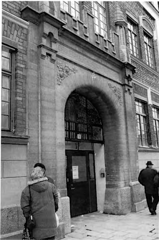
Figur 43. Eskilstuna Stålpressings AB, ritat av arkitekt Emil Befwe, är uppfört år 1899 av tegel med naturstensutsmyckning av Yxhultskalksten. Foto A. Thornberg Knutsson 1992, Södermanlands museum.
