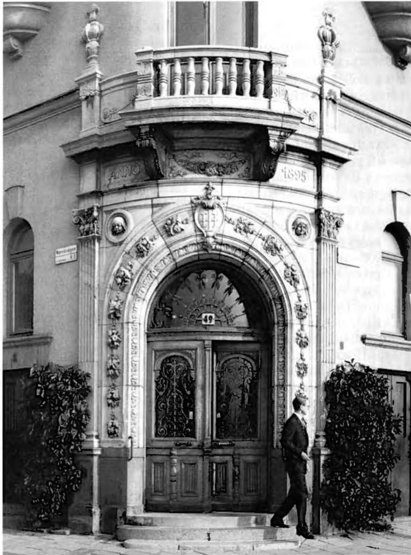
Figur 31. Portal och fasad från 1894 byggt av Mölnbomarmor med inslag av Mälars/Roslags/Gävlesandsten. Strandvägen 49 i Stockholm, ritat av arkitekt S. Kjellberg. Foto B. A. Lundberg 1993.
