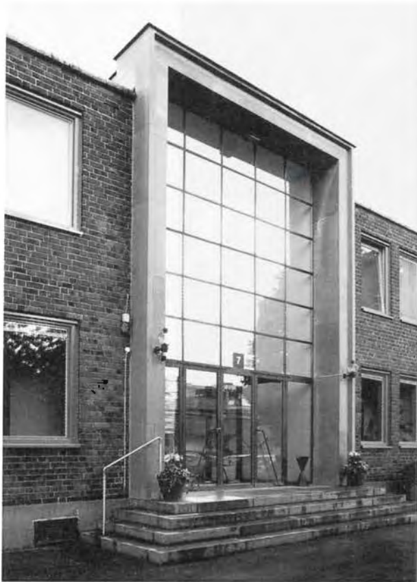
Figur 16. Atlas Copco, kontorsbyggnad från omkring 1940 med portal av granit. Foto E. Grape 1996, Stockholms läns museum.
