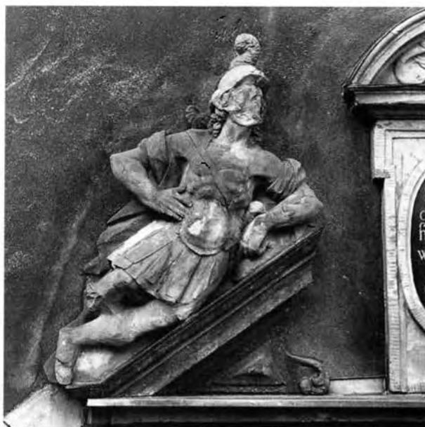
Figur 30. Krigare av gotländsk sandsten med kraftiga vittringsskador på portal från 1600-talet, Stortorget 20, Gamla Stan i Stockholm. Foto B. A. Lundberg 1991.
