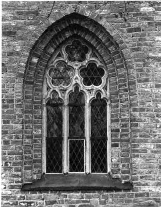
Figur 8. Håtuna kyrka i Upplands-Bro kommun. Fönster i masverk utfört på 1300-talet av kalksten från Gotland. Foto K. Pettersson 1992, Stockholms läns museum.
