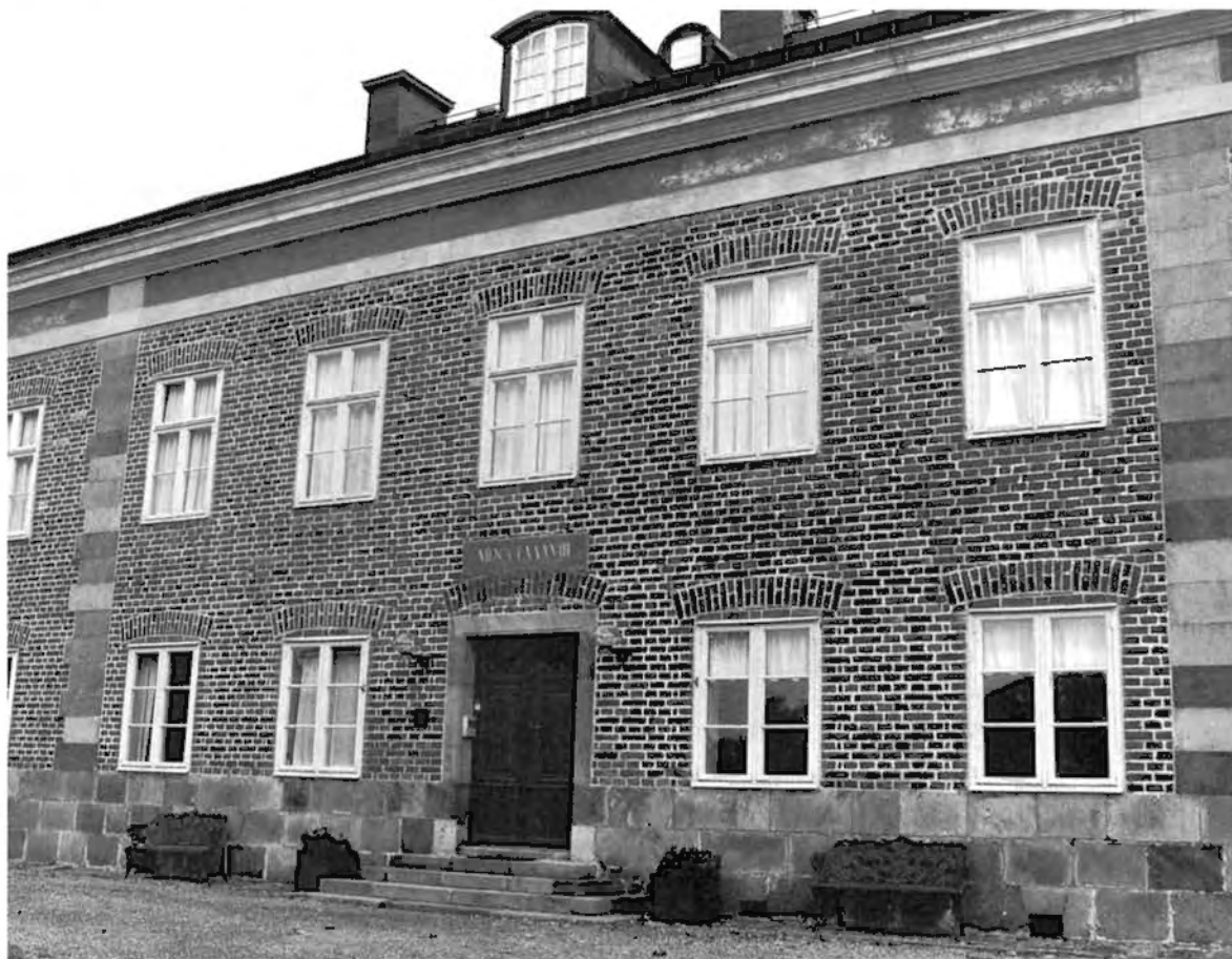
Figur 10. Tullhuset på Dalarö byggdes 1788 med Erik Palmstedt som arkitekt. Byggnadsmaterialet är tegel. Hörnkedjor, lisener och dörrromfattning är utförda i Mälars/Roslags/Gävlesandsten. Foto K. Pettersson 1992, Stockholms läns museum.
