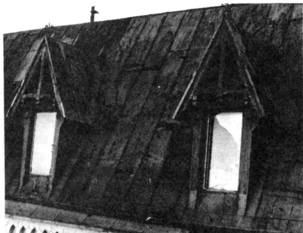
Plåttak före åtgärd. Mariaberget, Stockholm. Foto 1976.
