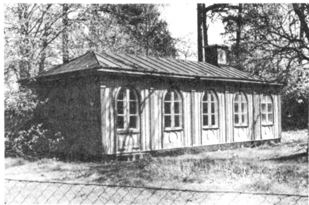
Trädgårdsbyggnaden vid Annelund, Solna. Foto 1975.
