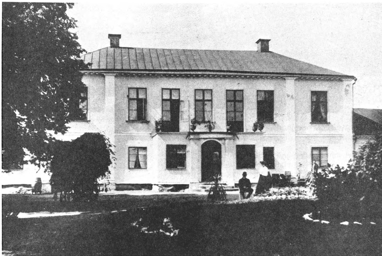
Älvsjö gård på 1890-talet. Svartplåttak i "småformat", 45 × 59 cm. Dessutom skorstensöverbeslag, fotränna, stuprör och listavtäckningar i järnplåt. Stockholms Stadsmuseums arkiv.
