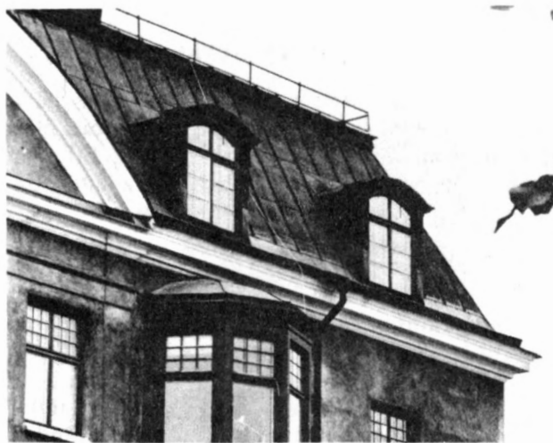
Skyddsräcke mellan övre och nedre takfall. Ett utsatt läge som, när konsekvenserna för byggnadens helhetsverkan ej beaktas, lätt blir störande. Mariaberget, Stockholm. Foto 1980.
