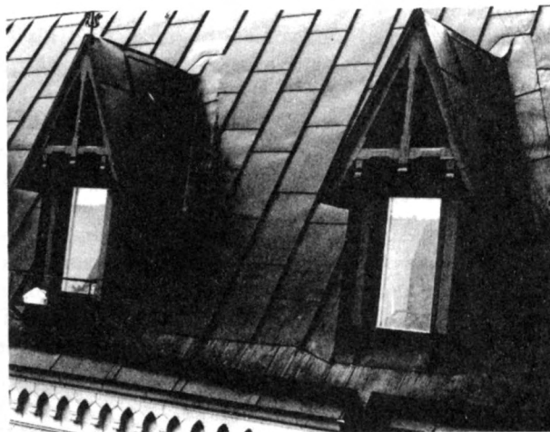
Samma tak efter åtgärd, vilket här innebar total omläggning. Foto 1980.
