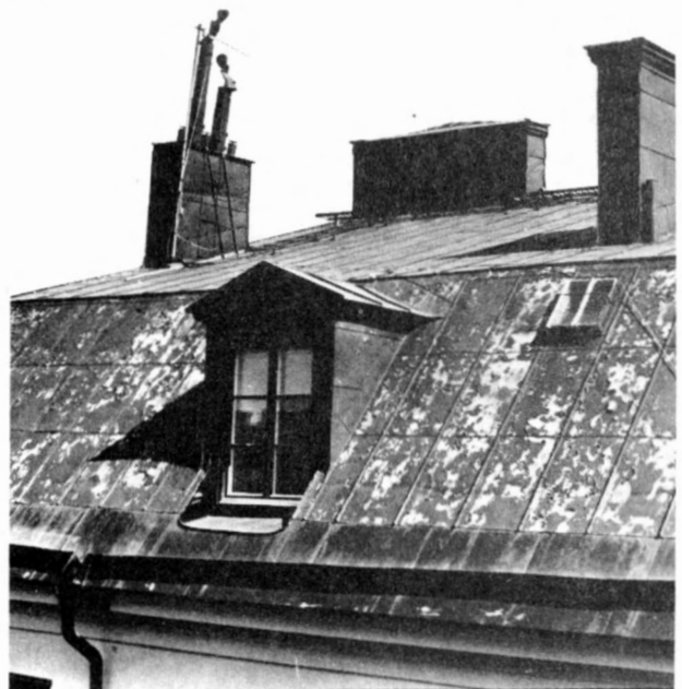
Utän en mycket omsorgsfull rengöring är det svårt att få färgen att fästa på ny förzinkad plåt. Norrmalm, Stockholm. Foto 1979.
