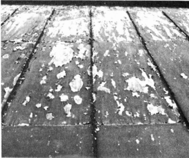
Skador orsakade av ovarsam snöskottning. Foto Rune Ahlqvist 1978.
