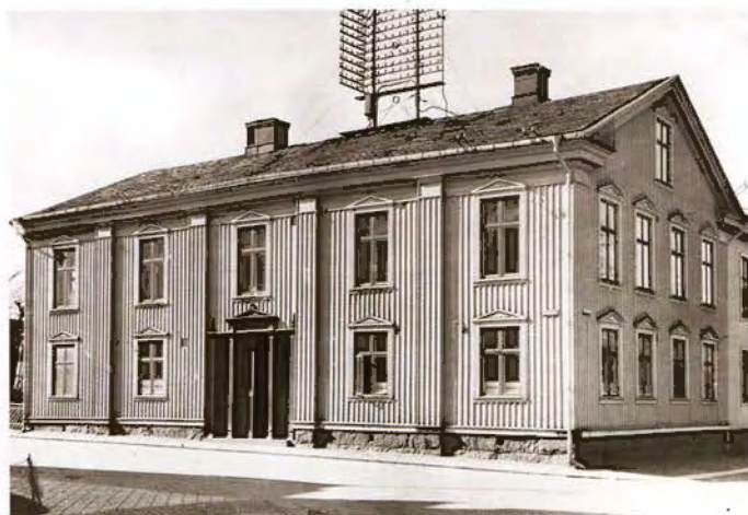
I små städer blev rådhuset den naturliga centralpunkten för telekommunikation till och från staden. I Åmål fick rådhuset en spindelliknande konstruktion uppförd på taket. Foto Åmåls kommunarkiv.
