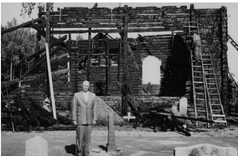
Aspeboda kyrka efter branden 1959. Träkyrkan totalförstördes men sakristian klarade i viss mån branden. Timret från sakristian kunde återanvändas till det södra vapenhuset i den nya tegelkyrka som uppfördes på samma plats. Foto: Harald G. Fornstedt, ATA.
