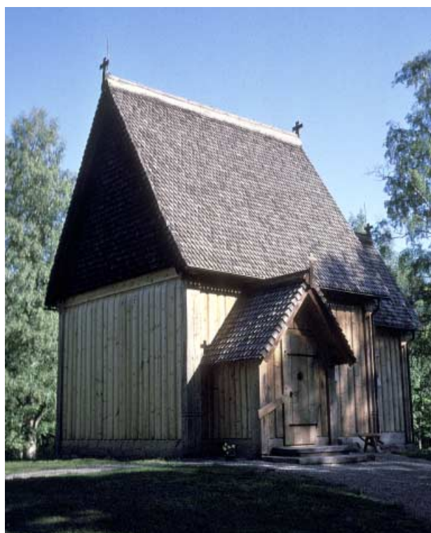
Skaga kapell brann år 2000. Kapellet uppfördes i slutet av 1950-talet och var en rekonstruktion av en tidigare stavkyrka. Efter branden återuppbyggdes kapellet enligt ritningarna från 1950-talet, men med ett nytt vapenhus tillfogat enligt äldre avbildningar av det allra första kapellet.
