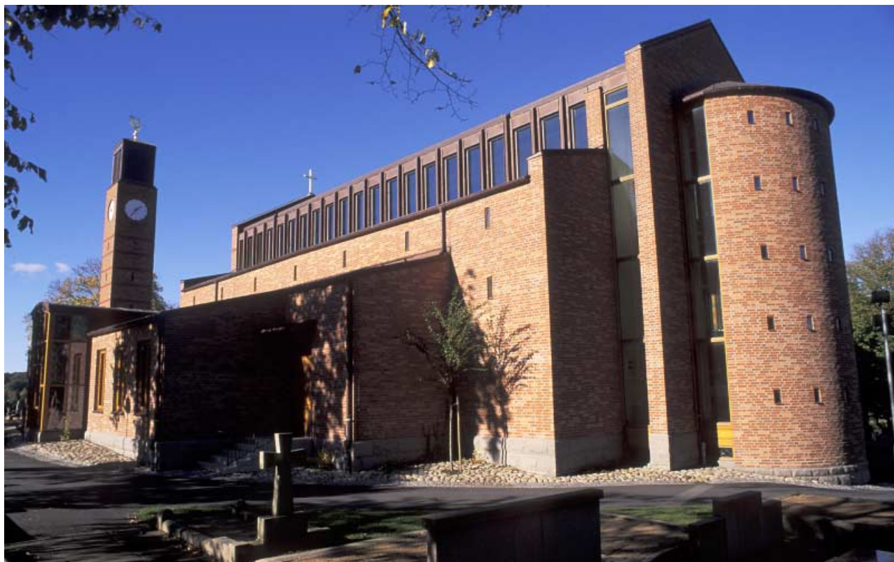
Lundby nya kyrka. Den nygotiska tegelkyrkan från 1886 brann 1993. En helt nygestaltad tegelkyrka uppfördes på samma plats 1996 ritad av FFNS West (M. Diedrich, E. Granden och A. Zimdal). Foto: Pär Greilert.
