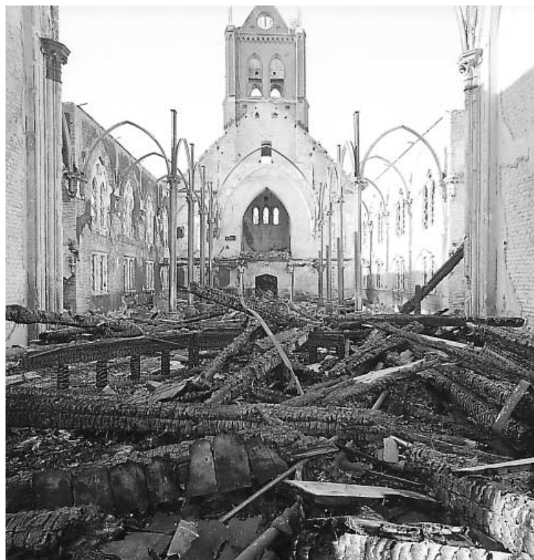
Aspeboda kyrka efter branden 1959. Träkyrkan totalförstördes men sakristian klarade i viss mån branden. Timret från sakristian kunde återanvändas till det södra vapenhuset i den nya tegelkyrka som uppfördes på samma plats. Foto: Harald G. Fornstedt, ATA.
