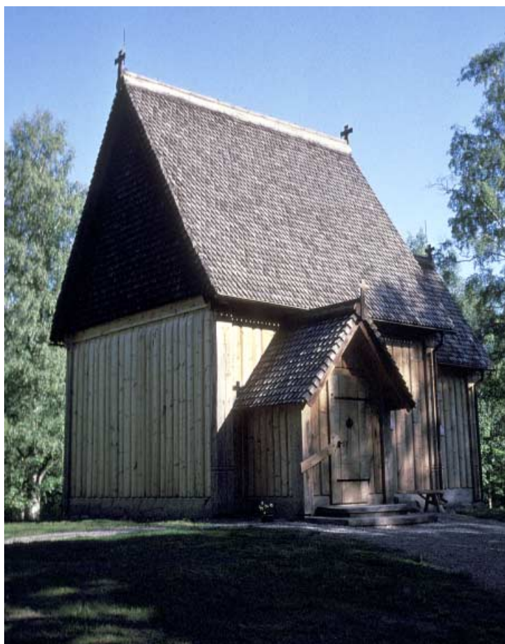
Skaga kapell brann år 2000. Kapellet återuppbyggdes enligt ritningarna från 1950-talet, men med ett nytt vapenhus tillfogat enligt äldre avbildningar av det allra första kapellet. Foto: Kerstin Alexandersson, 2002.
