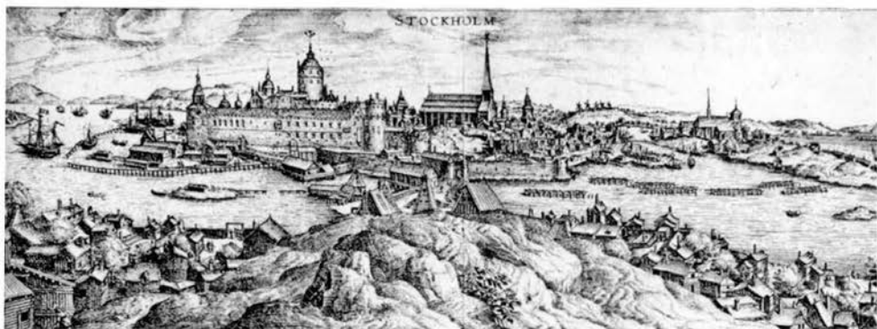
Pålkransen runt Stockholm syns tydligt på Franz Hogenbergs kopparstick 1588. Det finns spår av liknande vid Birkas hamnar.
