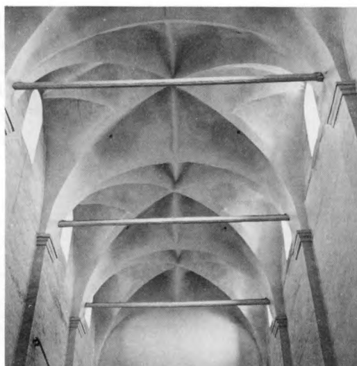
159. Kryssvalv av tegel med sex kappor samt stickkupor vid fönsteröppningarna. Dragankarbjälkar i kleristorievåningens fasta murpelare mellan fönstren. 1590-tal. Mitsukskeppet, Genarps kyrka, Skåne. Foto K Andersson 1976
