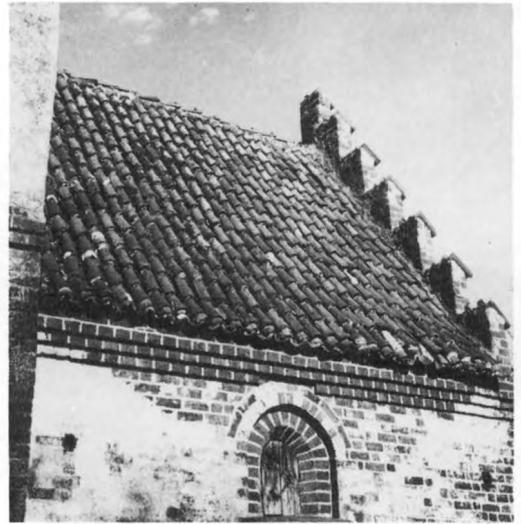
193. Takläggning med tegel av medeltida typ. Koret, Araslövs kyrka, Skåne. Foto ATA
