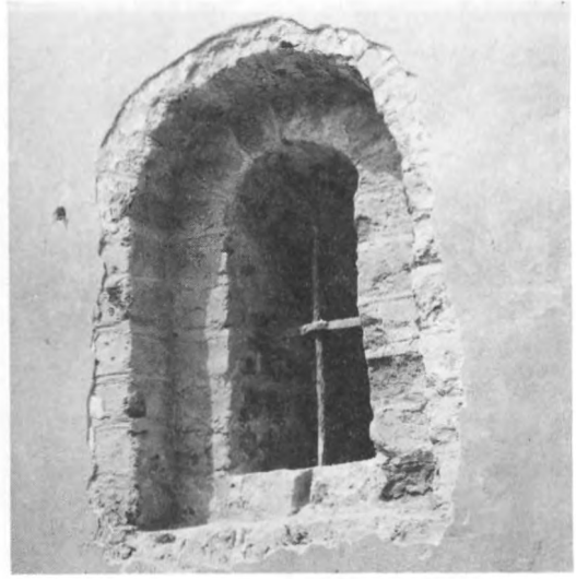
116. Stickbågig ensprångig fönsteröppning med galler, sedd utifrån. 1400-tal. Göksholms slott, Närke.
