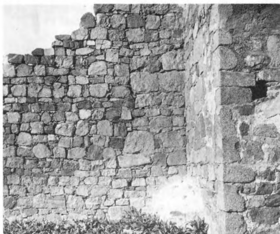
1. Murverk av tuktad gråsten med regelbunden skiffläggning. Återkommande tunna avjämnings-skift. Rester av originalputs med kvaderrits th om den välhuggna hörnkedjan. Observera även förtagningen i bildens mitt. Omkr 1100. S:t Pers kyrkoruin, Sigtuna, Uppland. Foto ATA O Sörling 1890-tal
