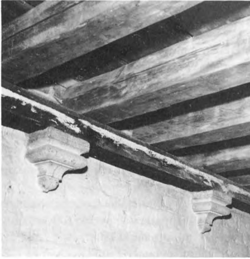
146. Bjälktak buret av kalkstenskonsoler och bärlina. Har säkerligen haft en dekorativ takpanel. 1300-tal. Textilkammaren ö om n tvärskeppet, Uppsala domkyrka, Uppland. Foto G Hildebrand 1974
