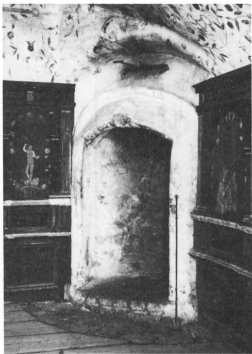
170. Spis av tegel med uppsvängd spiskupa med dragspjäll, raka sidostycken och härdplan samt eldstadsplan av tegel. Sent 1500-tal. Karl IX:s kammare, Gripsholms slott, Södermanland. Foto ATA I Anderson 1937
