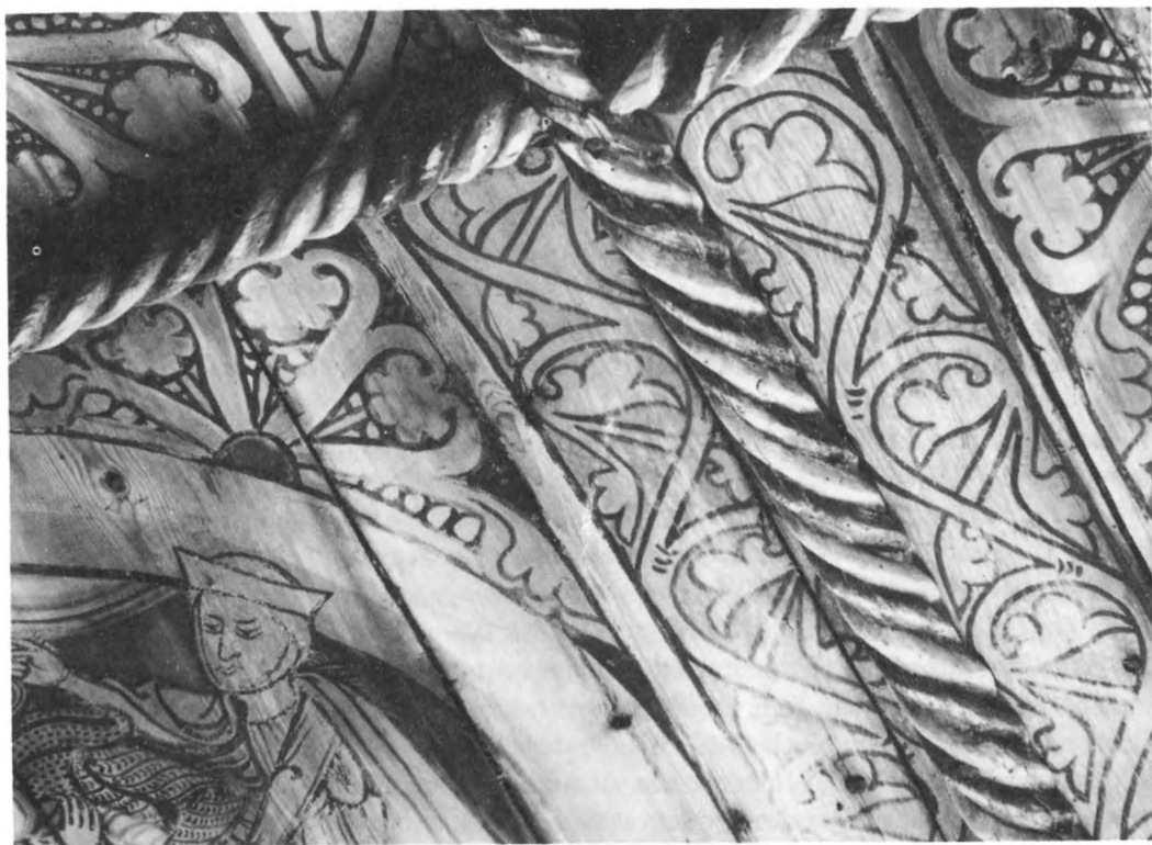
145. Brädtak med påspikade repstavslister. Sent 1200-tal. Dädesjö kyrka, Småland. Foto ATA I Anderson 1939
