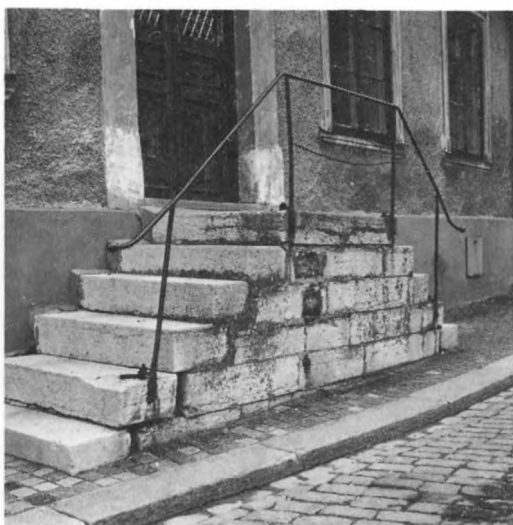
168. Dubbeltrappa av kalksten med handledare av järn. Smedjegatan, Visby, Gotland. Foto A Hildebrand 1976
