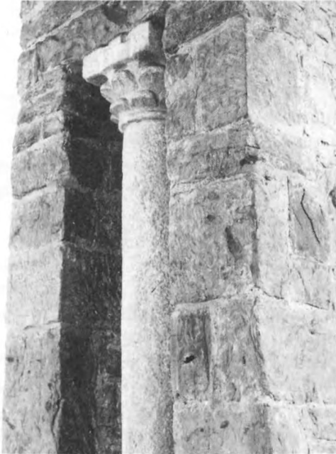
9. Grovt tillhuggen kvader (troligen med bredhacka) i pelaren och pikhugget kolonnskäft. Växlande stenarter. 1000-talets senare del. Dalby kyrka, Skåne. Foto LUHM E Cinthio
