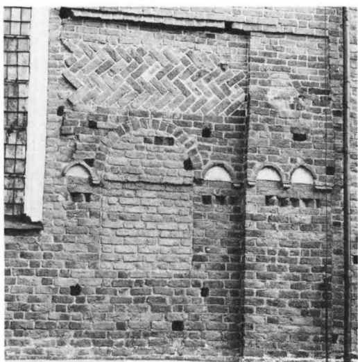
37. Mönstermurning, sk fiskbensmurning, blinderingar och sågskift. Sent 1200-tal. Sakristian, Strängnäs domkyrka, Södermanland. Foto ATA S Hallgren 1963
