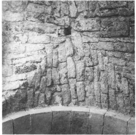
155. Kryssvalv i tuffsten. Arkadbågar av sandsten. 1100-tal. Förhallen, Dalby kyrka, Skåne. Foto LUHM M Rydbeck
