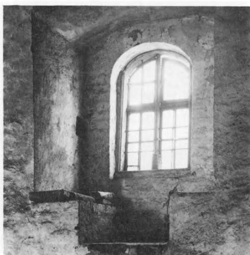
120. Fönster med renässansutformning. Den stickbågiga fönsternischen har sittbänkar. I den korgbågiga fönsteröppningen finns en träkarm med snidad mittpost och profilerade sidostycken. Örups slott, Skåne.
