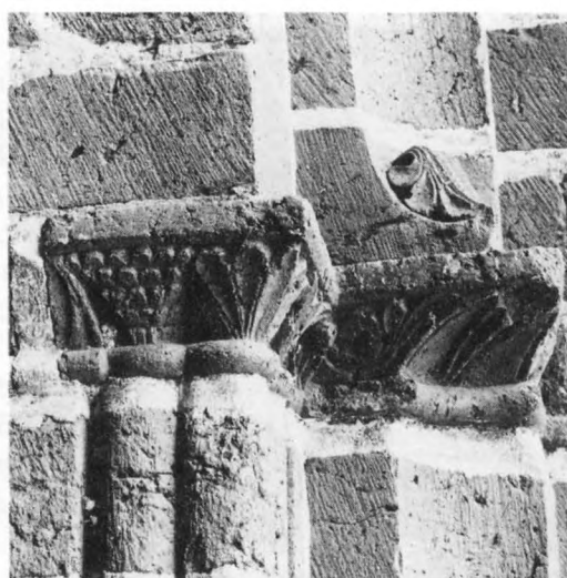
40. Räfflat tegel och skurna dekorativa element, allt utfört före bränningen. 1200-tal. Västportalen, Skoklosters kyrka, Uppland. Foto ATA C F Mannerstråle 1962
