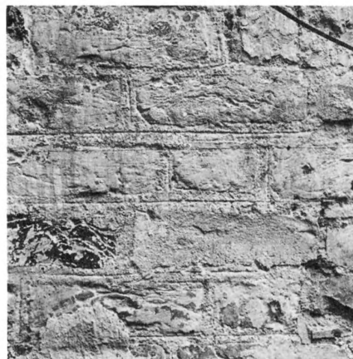
51. Tegelmurverk med ritsad planfog. 1400-tal. "Kalentehuset", Halmstad, Halland. Foto I Anderson 1964
