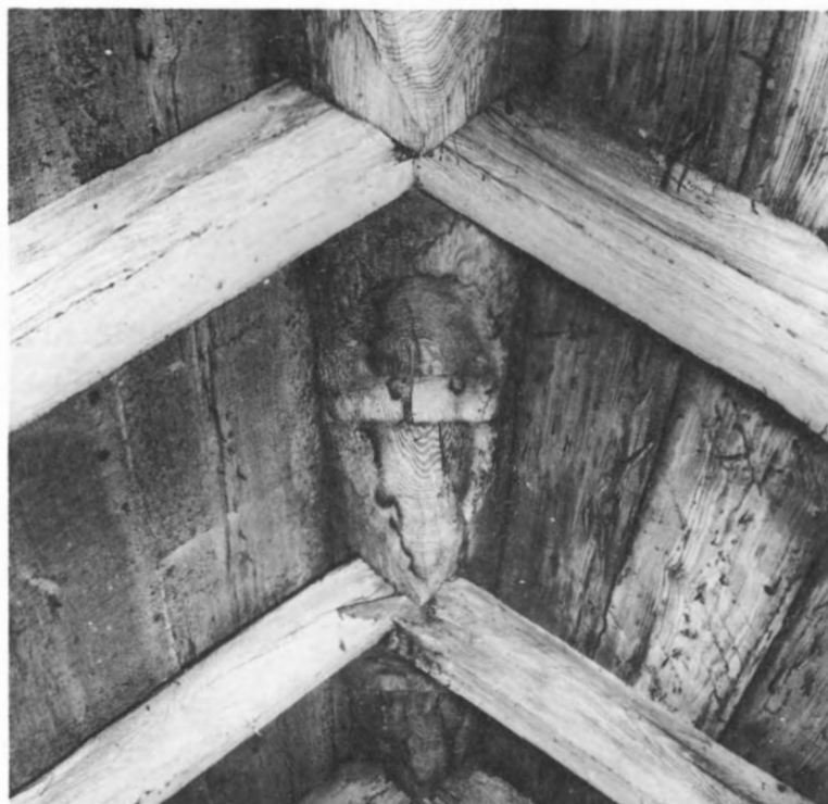
183. Detalj av nockås, ornerad med bågsnitt med bottenremsa. 1100-tal. Herrestads kyrka, Östergötland. Foto ATA I Anderson 1939
