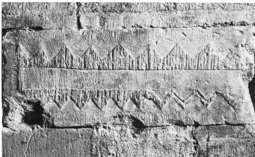
11. Ornerad sandstenskvader med kanthuggning och två olika grova bredmejslar använda vid skrädhuggningen. 1100-talets början. Kryptan, n. sakristian, Lunds domkyrka, Skåne. Foto LUHM E Cinthio 1957
