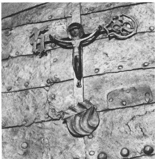
80. Detalj av järnbeslagen dörr. De små nitade järnplåtarna av utsmitt och hopvällt järn. 1500-tal. Romfartuna kyrka, Västmanland. Foto K Andersson 1976
