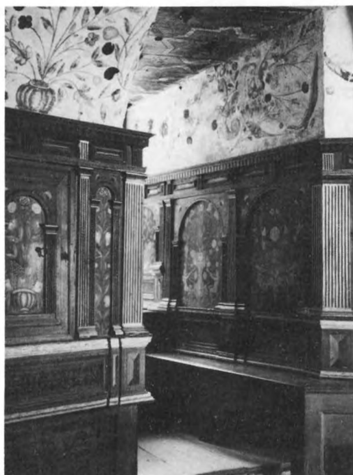
176. Den höga renässanspanelen går in i fönstersmygen med sin fasta bänk. 1570-tal. Hertig Karls kammare, Gripsholms slott, Södermanland. Foto ATA CP Curman
