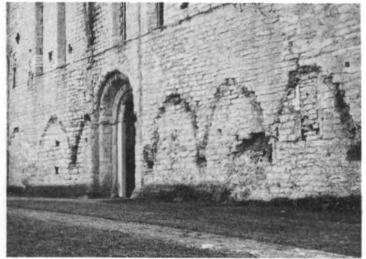
108. Spår av försvunnet kryssvalv till korsgång i kloster. Nicolai kyrkoruin, norra fasaden, Visby, Gotland. Foto A Hildebrand 1976
