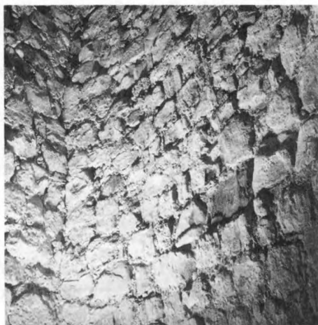
2. Murverk av i huvudsak valda markstenar (gråsten och sandsten). Regelbunden skiffläggning. Fogningen borta. Slutet av 1100-talet. Hagby kyrka, Småland. Foto I Anderson 1965
