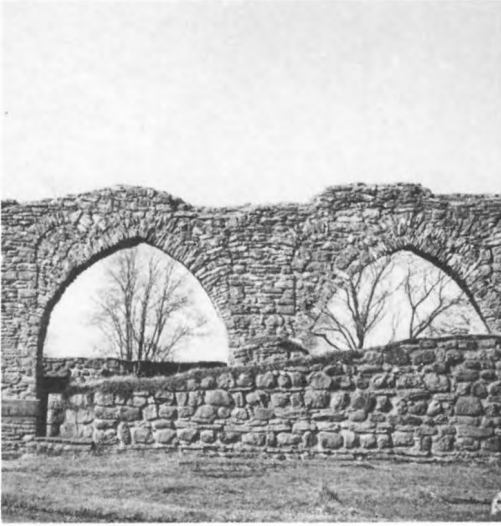
7. Murverk av vald gråsten i litet format. Regelbundet återkommande avjämningskift av kalkstensflis. Omfattningar och hörn av huggen kalksten. 1100-talet. Gudhems kloster, Vg. Foto ATA B Hedström 1969
