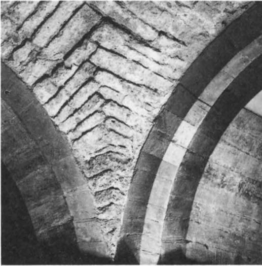
154. Detalj av kryssvalv, svickel av tuffsten. Arkadbågar av sandsten. 1100-tal. Kryptan, Lunds domkyrka, Skåne. Foto LUHM O Rydbeck 1940
