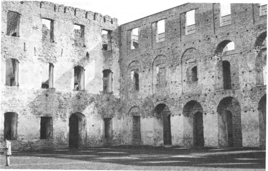
102. Bomhål för byggnadsställningar. 1600-tal. Borgholms slottsruin, Öland. Foto K Andersson 1974
