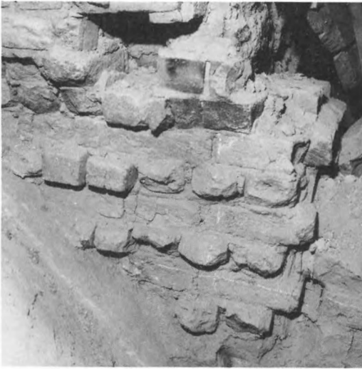
103. Förtagningar i murlivet och tvärs genom murbredden. Murlivsförtagningen utförd för planerade valvkappor. Förtagningen genom muren, till höger i bilden, representerar en byggnadsetapps (kapellens) avslutning och förberedelse för nästa etapps bygge av högmur till sidoskeppen. 1300-tal. Södra kapellvinden, Uppsala domkyrka, Uppland. Foto G Hildebrand 1975
