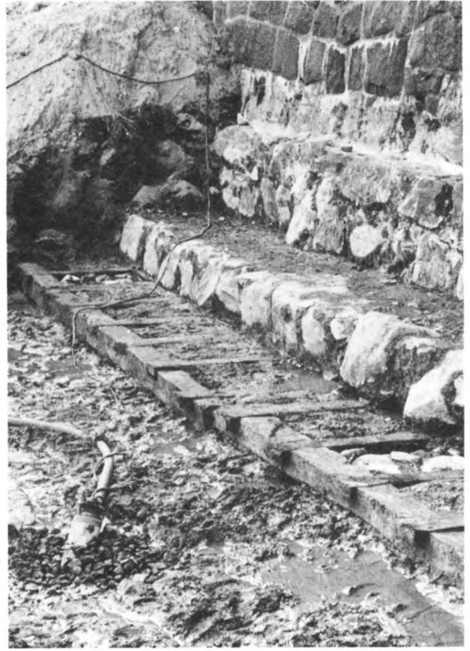
92. Rustbädd av fyrkantstimmer av ek. Tvärgående bindare sammanfogade med längsgående virken genom bladning med hel laxstjärt. Mellanrum (kistor) fyllda med packning av marksten. Omkr 1600. Bastion Grå munken, Varbergs fästning, Halland. Foto K Andersson 1975
