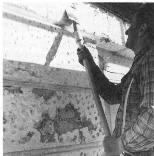
63. Borttagning av vattrivning över 1600-talets slätputs, Skoklosters slott, Uppland. Foto O Hidemark 1975
