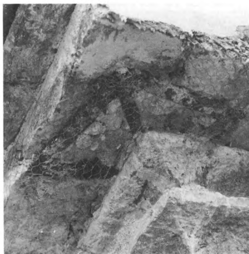
82. Bärning av plattjärn för takgesims. 1700-talets förra hälft. Svartsjö slott, Uppland. Foto R Edenheim 1976
