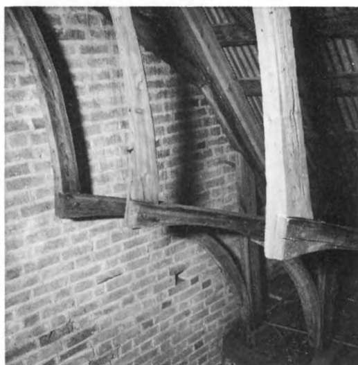
189. Detalj av takstol som haft treklövervalv av trä. Stödbenen intappade i det inre remstycket. Bågträn (lötar) sammanfogade med varandra med bladning halvt i halvt och dymling. Sent 1200-tal. Koret, Tensta kyrka, Uppland.
