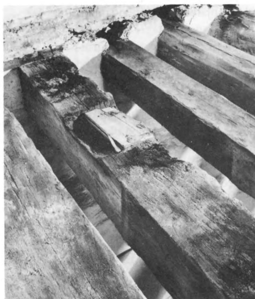
127. Tätt lagda kraftiga bjälkar, som vilar på murupplag i väggen. Mellan bjälkarna tegelfyllning. Bjälkändarna isolerade med näver. 1500-tal. Sjöfartsmuseet, Kalmar slott, Småland.
