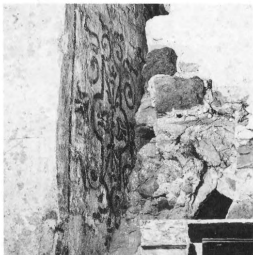
66. Kalkmålning med moreskmotiv i grått på vit puts i invändig fönsternisch. Sent 1500-tal. Gamla stenhuset, Skokloster, Uppland. Foto G Hildebrand 1975
