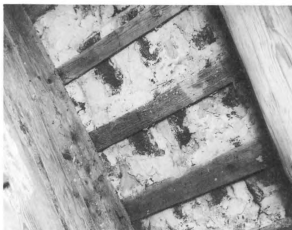
202. Tak av vingtegel, understruket med kalkbruk blandat med nöthår. 1600-tal. Skoklosters slott, Uppland. Foto O Hidemark
