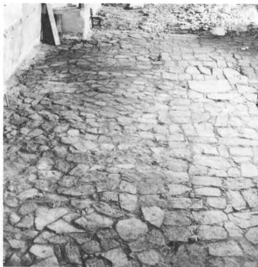
136. Golv av stenhällar Medeltid. Skee kyrka, Bohuslän.
