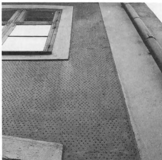
61. Mönsterputs, intryck med pinnbräda på hel fasadyta. Verkygets storlek och rapportering syns tydligt. Slätputsade hörn och fönsteromfattningar. Putsen reparerad på 1900-talet men kopierar 1700-talsutseendet. Malmgårdsvägen 55, Stockholm. Foto K Andersson 1976
