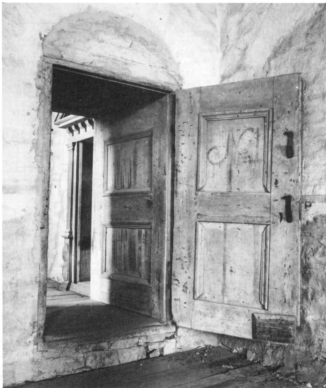
125. Passage i bevarad renässansform. En kraftig avlastningsbåge bär murverket över dörren. 1500-tal. Vadstena slott, Östergötland. Foto ATA I Anderson 1938
