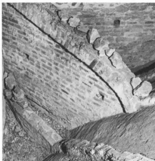
160. Ovansidan av stjärnvalv. Tegelribborna extra belastade av en extra rad murtegel. Kappor av halvstenstegel. Svicklarna är ofta av tekniska skäl fyllda med stenskrot och kalkbruk; i detta fall har också mothäll ordnats med strävmur av tegel. Sent 1500-tal. Vadstena slott, Östergötland.
