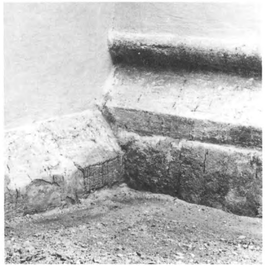
100. Hörnet mellan tornet och långhuset. Tornet med enkelt snedfasad sockel tv, 1200-talets början och långhuset med rikt profilerad sockel th, omkring 1300. Etelhems kyrka, Gotland. Foto ATA S Hallgren 1963
