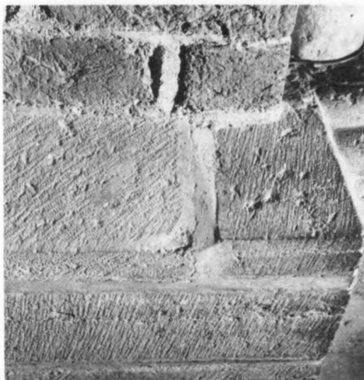
14. Tandmejselhuggning på kalkstenssockel. 1200-tal. Strängnäs domkyrka, Södermanland. Foto ATA S Hallgren 1963
