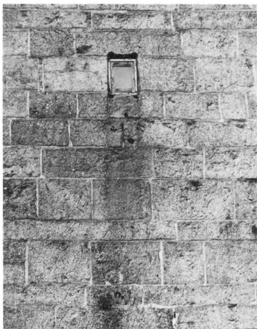
5. Murverk av mycket finhuggna sandstenskvader i jämna skift med växlande höjder. Stenarnas längd uppgår ända till 240 cm. 1100-talet. Söne kyrka, Västergötland. Foto ATA A Roland 1912
