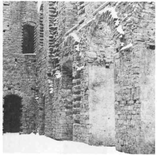
104. Förtagningar, insatta och utskjutna skift för mellanväggar och valv, kalksten. Ofullbordat murverk. Bruktstockningen slutar vid valvanfang. 1600-tal. Borgholms slott, Öland. Foto K Andersson 1974
