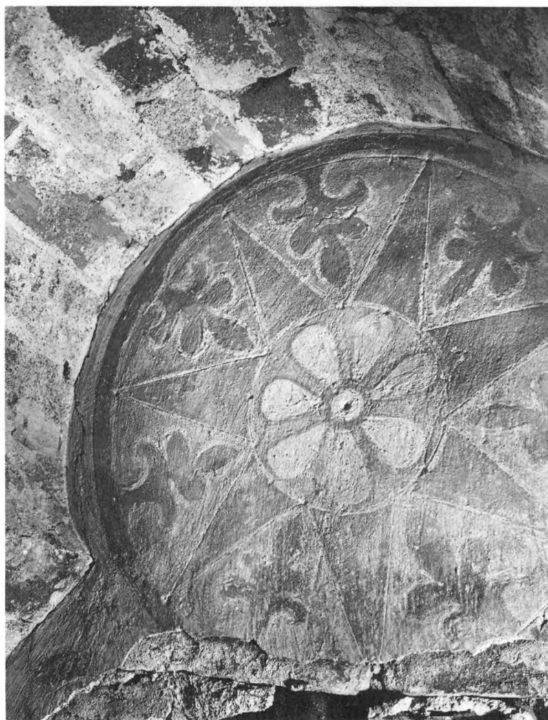
65. Dekorativt måleri i tegelrött, gråblått, vitt och ockragult i ut- vändig fönsternisch. Dekorens uppläggning ritsad i våt puts. Smygsidorna omväx- lande randade i grå- blått och tegelrött. Falska vita fogar. 1200-tal. Norra län- gan, Vadstena gård och kloster, Östergöt- land. Foto I Anderson
