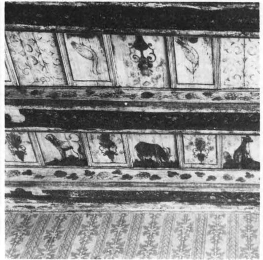
151. Bjälktak av profilerade bjälkar och med fyllningar lagda på lock. 1600-talets mitt. Stenbockska palatset, Riddarholmen, Stockholm. Foto ATA A Nilsson
