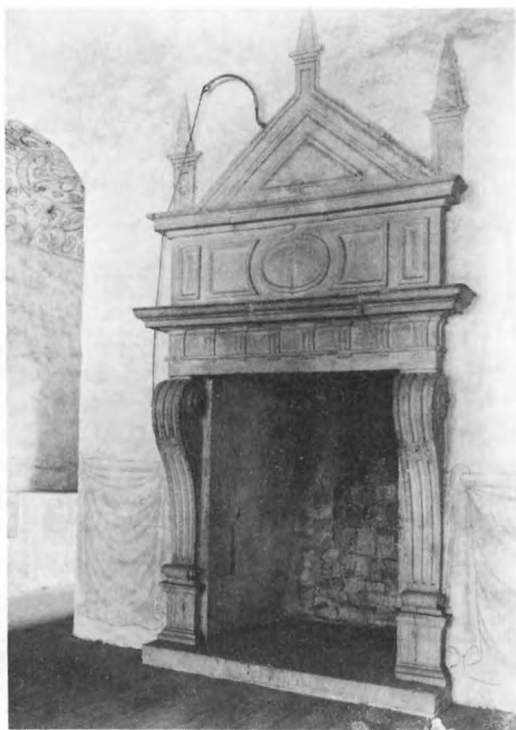
171. Spis byggd av tegel med dekorativ renässansomfattning i kalksten. Krönparti i kalkmålning. Vippsjäll. Drottningssalen, Kalmar slott, Småland. Foto ATA M Olsson 1929
