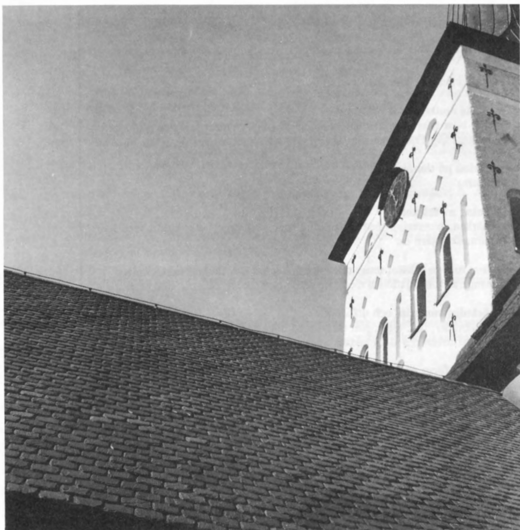
203. Taktäckning av skifferplattor. 1911. Romfartuna kyrka, Västmanland. Foto K Andersson 1976
