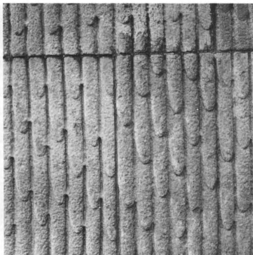
17. Dekorativ ythuggning på sandsten. 1600-tal. Övre logårdstrappan i Stockholms slott, östra längan. Foto K Andersson 1976
