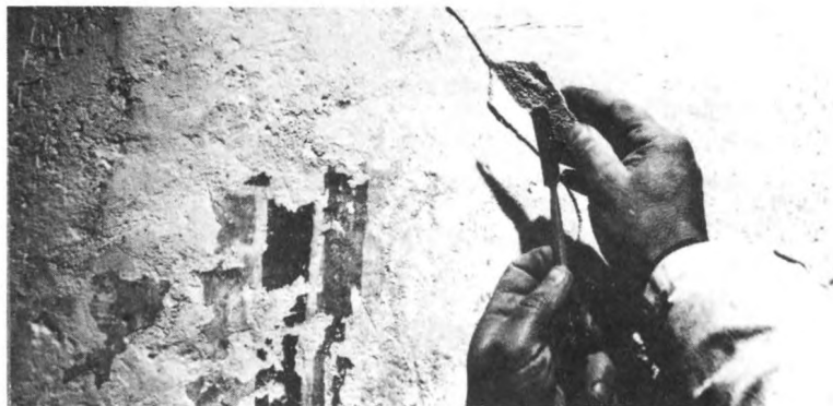
71. Murverk och putsstratigrafi. Spritputsens (1820-talet) slutar intill den nu bortbilade sträv- pelaren, medan det senare slätputs-skiktet går ut över den bilade tegelytan. Norra längan, Vad- stena gård och kloster, Östergötland. Foto I Anderson
