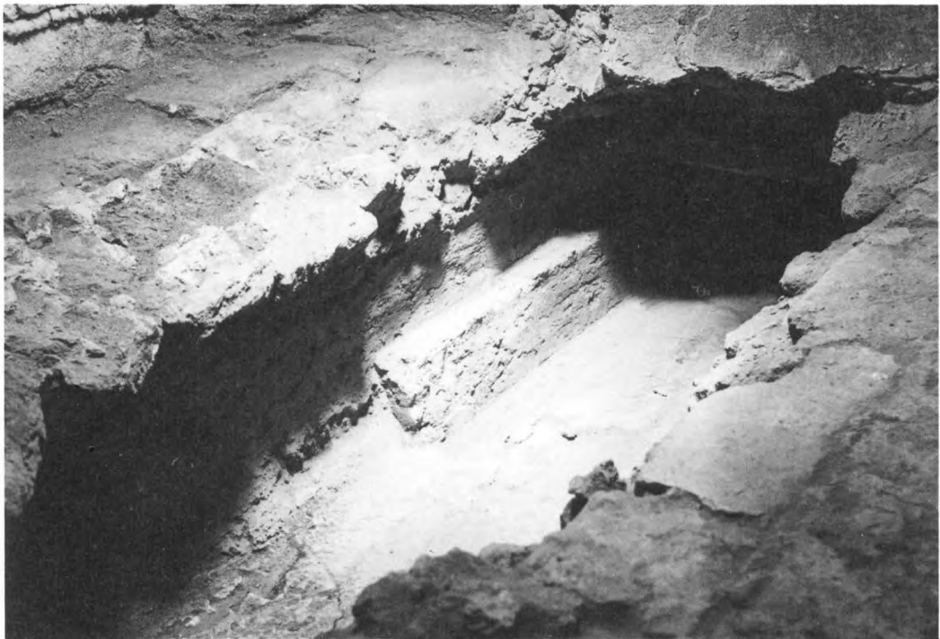
97. Spår av bortruttnad träarmering i tegelmur. 1200-tal. Norra längan eller palatset, Vadstena gård och kloster, Östergötland. Foto I Anderson
