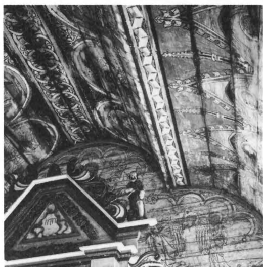
188. Bevarat brädpanelat treklövervalv i koret. 1300-talets början. Södra Råda kyrka, Västmanland.
