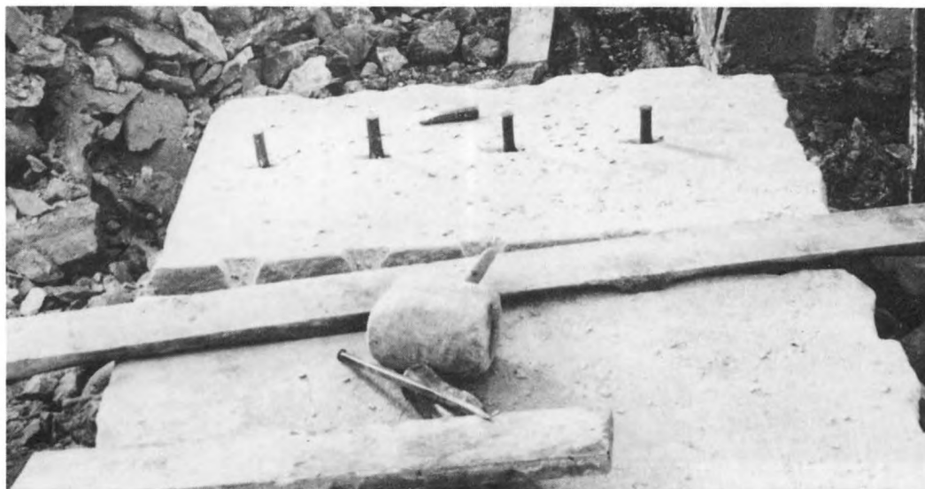
20. Klyvning av sten med järnkilar. Först uppborras hål med jämna mellanrum i stenen. Järnbleck och kilar sätts i hålen. Kilar slås växelvis ned med jämna slag med sätthammaren tills stenen spricker. Fide kyrka, Gotland. Foto ATA A Edle 1950
