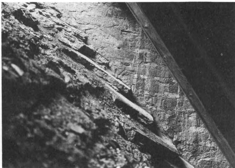
196. Tunnvalv av sten täckt av kalkstensflis lagda på lock. 1100-tal. Ö Ingelstads kyrka, Skåne. Foto LUHM Th Wählin
