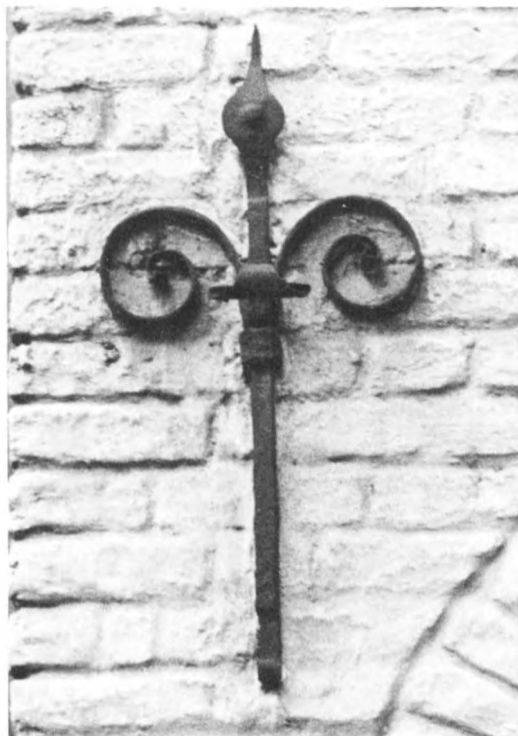
133. Ankarslut med dekorativa voluter och mittblad, nedskjuten genom en böjd ögla i dragjärnet. 1600-tal. Storkyrkobrinken 6, Gamla Stan, Stockholm.
