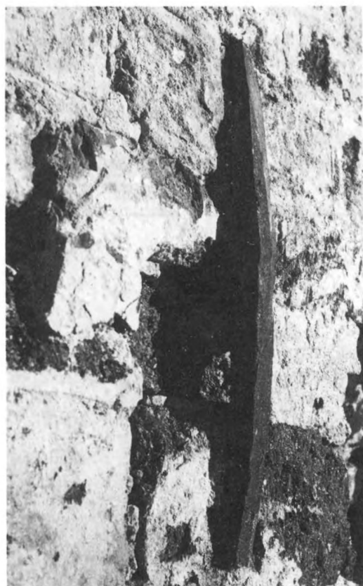
129. Rak ankarlut hopsmidd (hophetsad) med dragjärnet. 1400-tal. Göksholms slott, Närke. Foto ATA I Anderson 1955
