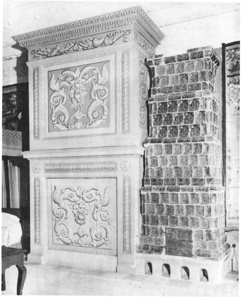
173. Kombination av öppen spis och sättugn av kakelplattor. 1600-tal. Skoklosters slott, Uppland. Foto Nord. mus. Ek- berg 1946
