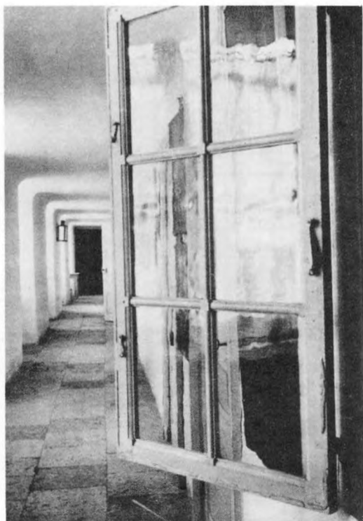
122. Fönster utan tvärpost. Sent 1700-tal. Gripsholms slott, Kavaljersflygeln, Söderman- land. Foto ATA I Anderson
