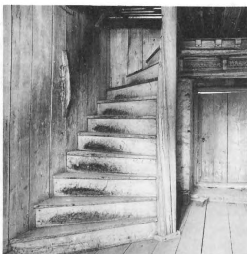
169. Innertrappa av trä med spindel försedd med spiralformigt löpande profilering. Omkring 1600. Vadstena slott, Östergötland. Foto ATA I Anderson 1938
