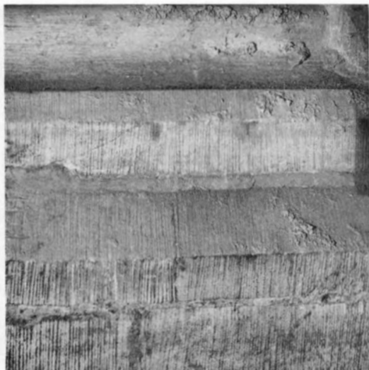
13. Bredmejselhuggning (skrädhuggning) på kalkstenssockel. Sockeln har redan tidigt, då planen förändrats, kommit att ligga inomhus. Sent 1200-tal. Silverkammaren, Uppsala domkyrka, Uppland. Foto G Hildebrand 1975
