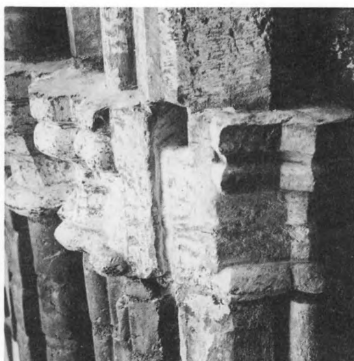
119. Detalj av masverksfönster. Observera hålet för delnings- eller stagjärn högst upp på kapitälet. 1300-tal. Hornska gravkoret, Uppsala domkyrka, Uppland.
