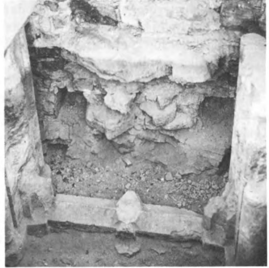
118. Rester av masverksfönster. Stenarna i mittpost och sidopost formade med fals för glasning. 1200-tal. Drottningssalen, Kalmar slott, Småland.
