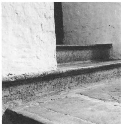
165. Trappa med raka trapplopp och vilplan. Plan- och sättsteg av kalksten. Planstegens framkant profilerad. 1500-tal. Kyrktrappan, Kalmar slott, Småland. Foto A Hildebrand 1976
