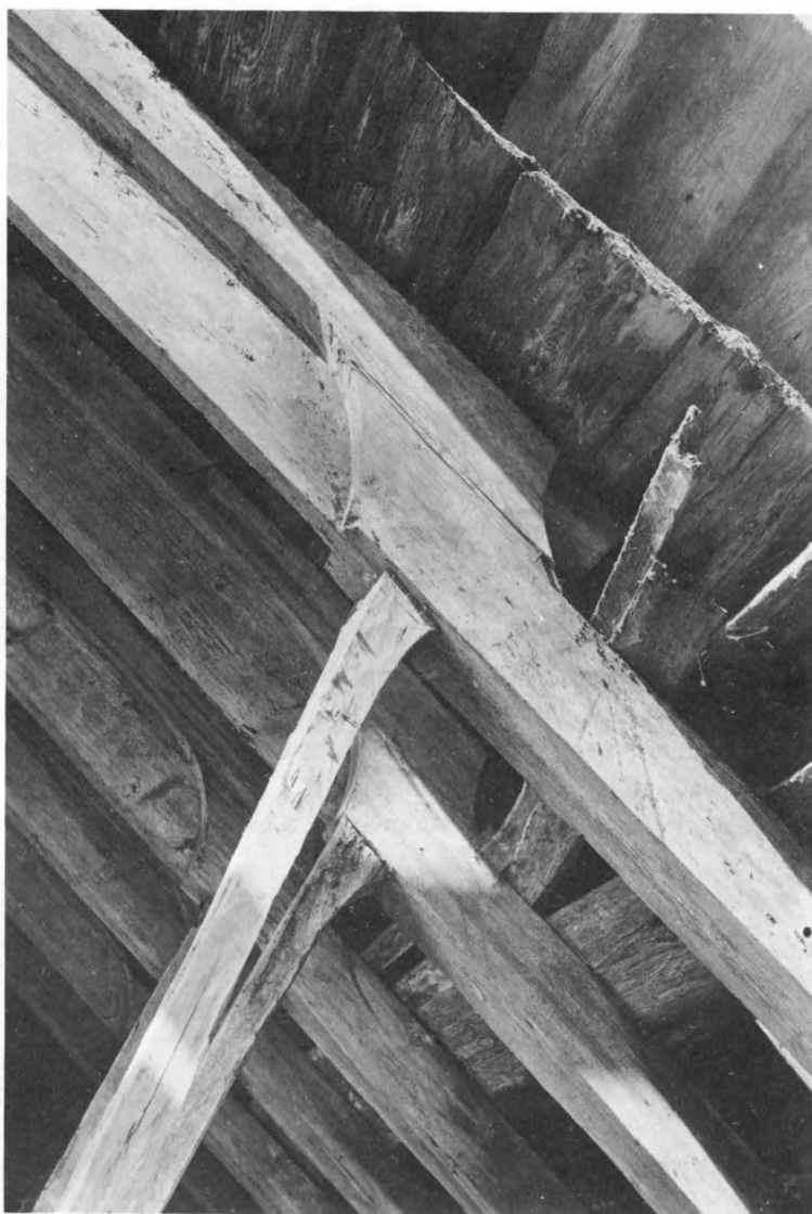
185. Detalj av Garde- takstolen. Snedsträ- vornas sammanfog- ning med sparrarna. 1100-tal. Foto ATA E Edle 1931
