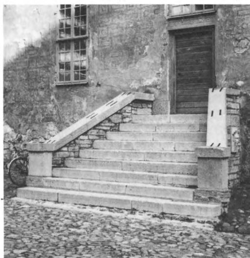
166. Utvändig fritrappa av kalksten. Murade trapppräcken täckta av stora kalkstensplattor sammanfogade med järnkramlor. Sidoplantar med dekorativ ytbehuggning. 1600-tal. Ståthällaretrappan, Kalmar slott, Småland. Foto A Hildebrand 1976
