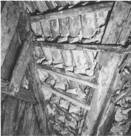
194. Taktegel på läkt. Understrykning delvis bortfallen. Änglahuset, Ystad, Skåne. Foto ATA
