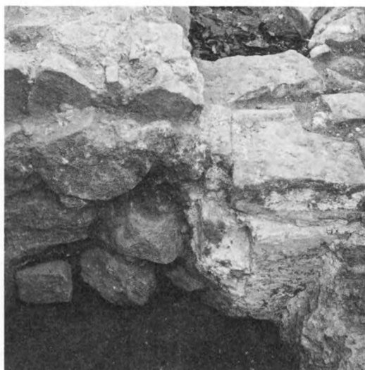
89. Två skilda grundmurskonstruktioner. Grund i kallmurskonstruktion till vänster, 1100-tal, och i kalkbruk till höger, 1000-tal (?). Murarna utgör lämningar av numera rivna västverk. Dalby kyrka, Skåne. Foto LUHM K Andersson 1966
