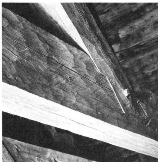
74. Bilat timmer i takstol. Takbjälkar och snedsträvor sammanfogade genom blandning med halv laxstjärt och dymling. 1200-tal. Arby kyrka, Småland.
