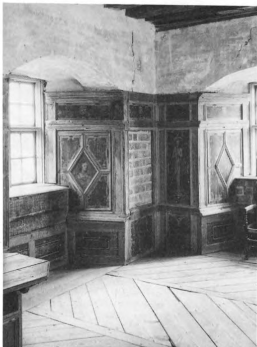
175. Hög furupanel målad i ljusgrönt med ramlistor i tegelrött och vitt. I de rombiska fälten bröstbilder av män och kvinnor. I fyllningarna rull- och beslagsornament. 1500-talets mitt. Det grova bjälktaket har varit underbonat. Vasatornet, Rydboholms slott, Uppland. Foto ATA I Anderson 1945
