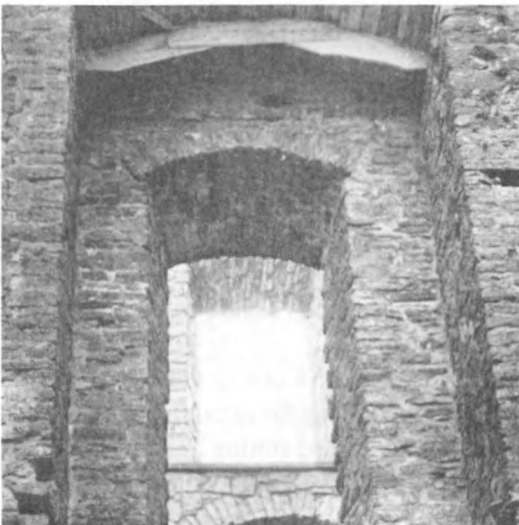
110. Valvbåge av trä och däckbräder. 1600-tal. Borgholms slottsruin, södra längan, Öland. Foto K Andersson 1974
