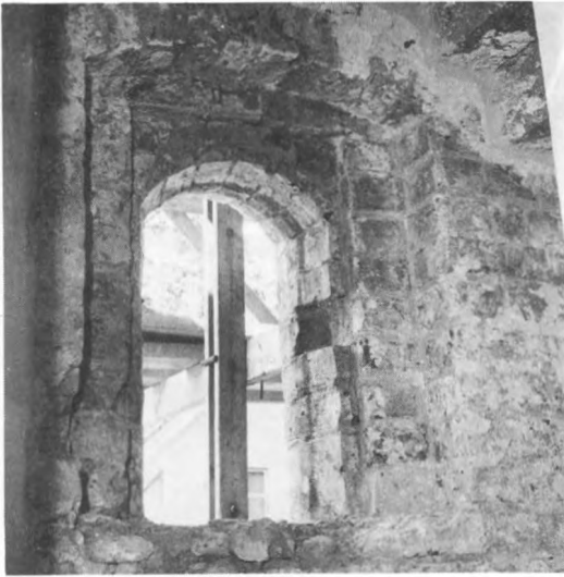
115. Stickbågig ensprångig fönsteröppning med glasfalstegel och grunt anlag för trälucka närmast glasfalsen. ca 1200. Västra längan, sydvästra utbyggnaden, Vadstena gård och kloster, Östergötland.
