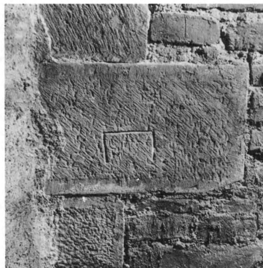
19. Stenhuggarmärke på kvader. 1200-tal. Norra transeptets västra mur, ovan valven, Lunds domkyrka, Skåne. Foto LUHM E Cinthio 1958
