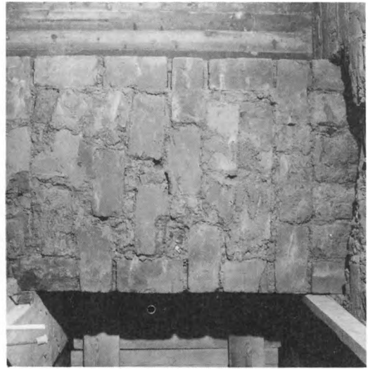
96. Fullmur i tegel, 3 1/2 stens bredd. Bilden sedd uppåt i murgenombrott. Omkr 1400. Södra tornet, Uppsala domkyrka, Uppland. Foto G Hildebrand 1974
