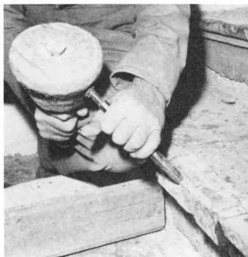
21. Stenhuggare Fride Nilsson nyhugger lagat plansteg i trappa. Kalmar slott, Småland. Foto G Hildebrand 1975
