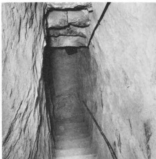
162. I muren inbyggd trappa med trappsteg av hela naturstenar och med överkragat valv. 1100-tal. Hagby kyrka, Småland. Foto ATA I Anderson
