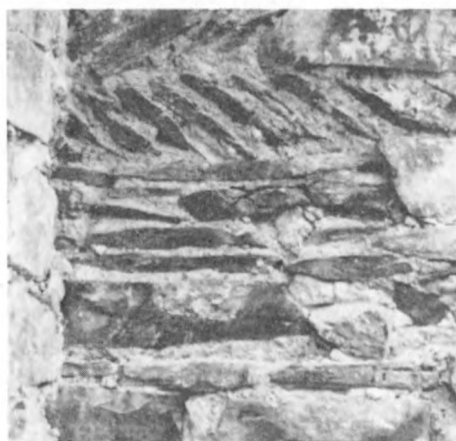
3. Gråstensmurverk med "opus spicatum", snedställda stenflis, troligen i hela murbredden. 1100-talets mitt. Eds kyrka, Uppland. Foto C F Mannerstråle 1970
