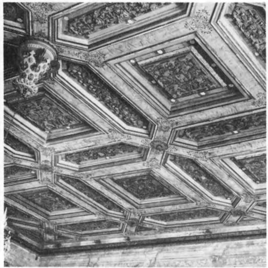
149. Kassettak med kvadratiska och sexsidiga ramverk. Fyllningarna (kassetterna) dekorerade med beslagsornamentik och rullverk. Ramverket marmorerat i grågult och prytt med moreskornament i svart. 1570-tal. Gyllne salen, Kalmar slott, Småland. Foto ATA J Fr Olsson 1896
