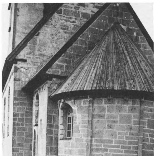
197. Absid täckt av träplankor med vattenrän- nor. Sk faltak. Fardhems kyrka, Gotland. Foto ATA A Roland
