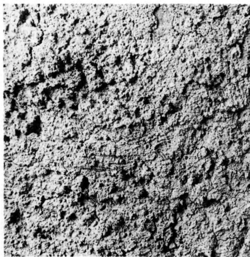
58. Utstockning på ofullbordat murverk. 1600-tal. Skoklosters slott, Uppland. Foto O Hidemark 1970
