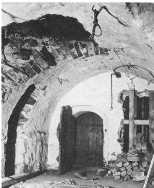
152. Sönderbrutet tunnvalv av sten och tegel. I valvsvicklarna fast fyllning av sten och kalkbruk. 1400-tal. Göksholm, Närke. Foto ATA I Anderson 1948
