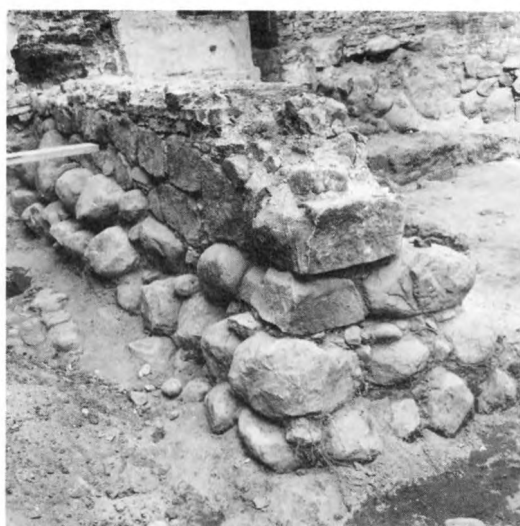
90. Grundläggning i kallmurskonstruktion, nedgrävd i svämsand. Konisk form med störst bredd i botten av grunden. 1400-tal. "Kalentehuset", Halmstad, Halland. Foto I Anderson
