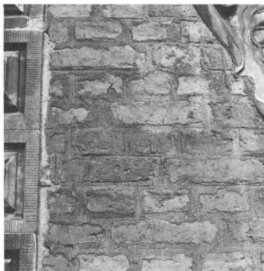
53. Tegelmurverk med ritsade planfogar (bredare rits än på bild 51) och rödfärgning av hela tegelytan. 1600-tal. Gustavianska gravkoret, Riddarholmskyrkan, Stockholm. Foto A Hildebrand 1976
