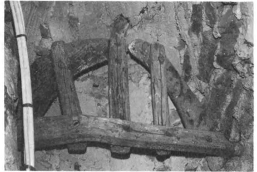
109. Valvbåge (formsättning) i trä, som burit däckbräder (skälbräder) för valvslagning i trappa. 1100-tal. Husaby kryka, västtornet, Västergötland. Foto O Hidemark 1975
