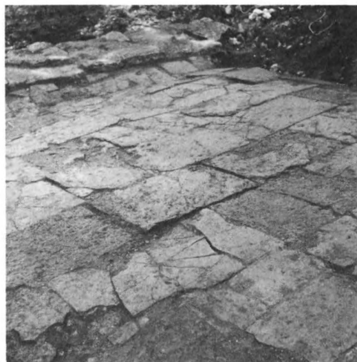
139. Golv av kalkstensplattor "anstrak". 1500-tal. Lusthuset på västra vällen, Kalmar slott, Småland. Foto ATA A Hildebrand 1971
