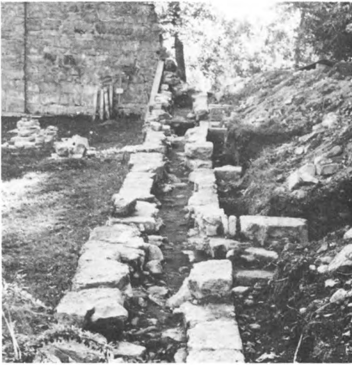
95. Skalmur av kalksten. 1200-tal. Riseberga klosterkyrka, norra muren. Närke. Foto K Andersson 1972
