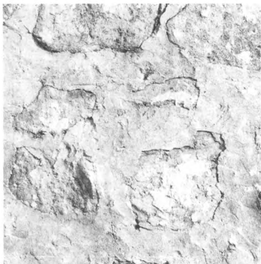
44. Gråstensmurverk med brett utstrukna fogar. Arbetssättet kännetecknas av en vilja att göra murverket så slätt som möjligt. 1400-tal. Vapenhuset, Munsö kyrka, Uppland. Foto K Andersson 1972
