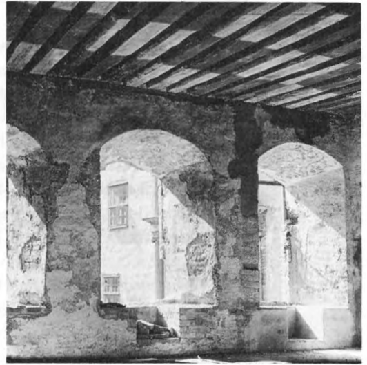
147. Bjälktak med tätt lagda kraftiga bjälkar, som vilar på en på murupplaget placerad plank. Målning i limfärg i rött—vitt. 1500-tal. Sven Månssons sal, Kalmar slott, Småland. Foto ATA H Åkerlund 1929
