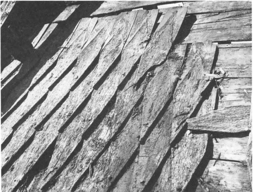
187. Spåntäckning på Garde kyrka. Spånen synligt spikade i spetsen och därför lätta att byta. 1100-tal. Foto ATA A Edle 1931
