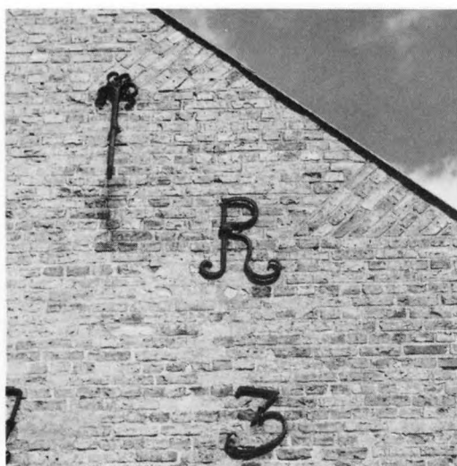
38. Strömskift i gavelröste. 1735. Araslövs loge, Skåne. Foto C F Mannerstråle 1977
