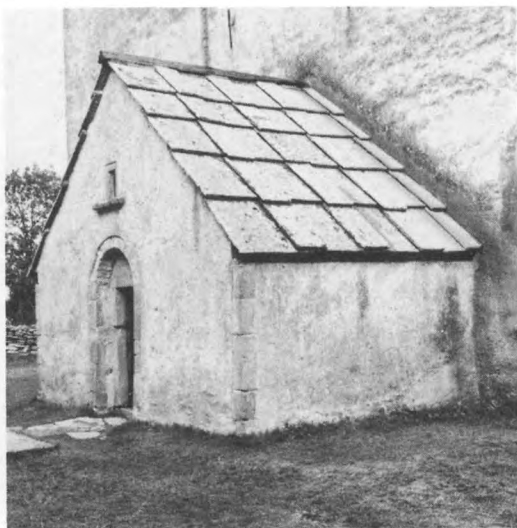
198. Åstak täckt av kalkstensflis. 1700-tal. Vapenhuset, Källa ödekyrka, Öland. Foto ATA R Boström
