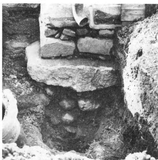
88. Grundmur av små kullerstenar (kallmur), stor stenplatta för bärning i hörn och enkelt fasad sockel. 1100-tal. Nätraby kyrka, Blekinge. Foto K Andersson 1972
