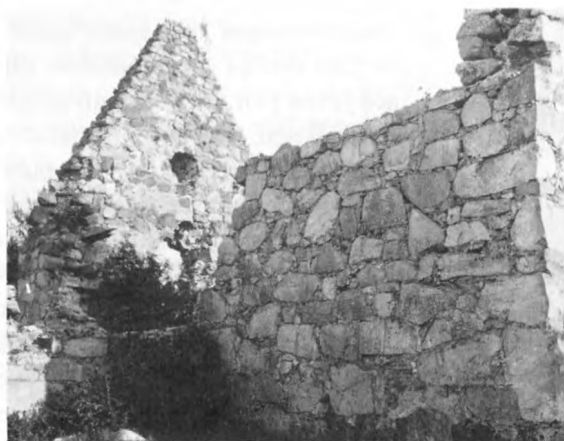
4. Gråstensmurverk med oregelbunden skiffläggning och skolning med småsten. Stenmaterialet utan speciell behandling. De stenytor, som är jämnast, bildar fogsidor. Fogning mestadels bortfallen. 1300-talet. Össeby kyrkoruin, Uppland. Foto ATA
