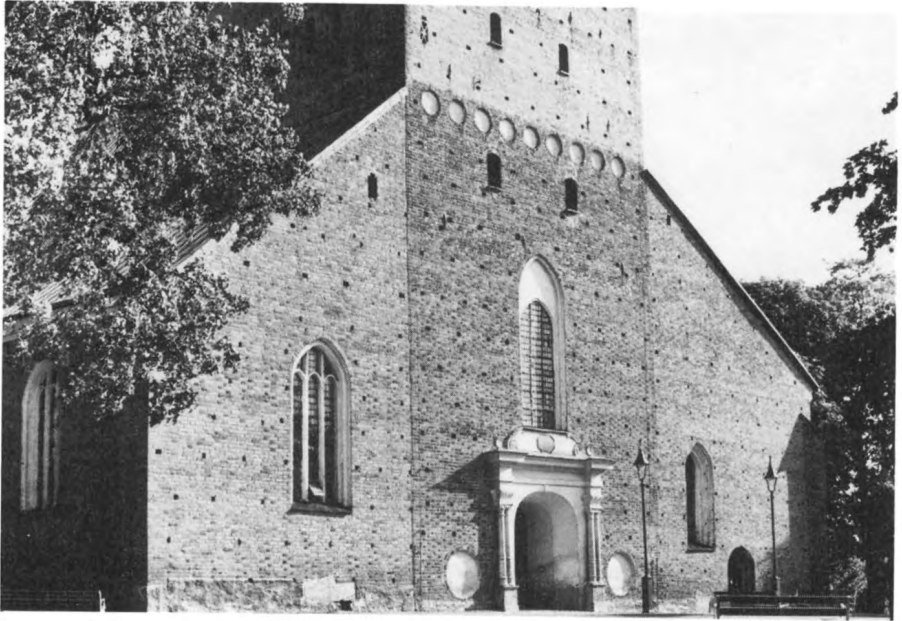
101. Klart urskiljbart system av bomhål för byggnadsställningar. Tidigt 1400-tal. Västtornet, Strängnäs domkyrka, Södermanland. Foto ATA M Bratt-Gustafsson
