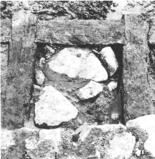
93. Detalj av föregående bild, som visar virkenas sammanfogning och stenpackningen. Foto K Andersson 1975
