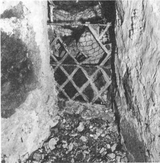
117. Invändig fönstersmyg med delvis bevarad glasning; stormjárn och blyinfattade rutor av brungrönt glas. Ovan valven, södra sidan av långhuset, Linderöds kyrka, Skåne.
