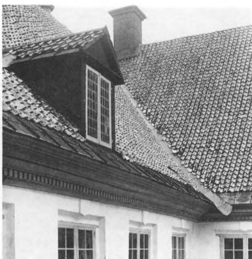
200. Takytor med täckning av svartglaserat vingtegel och svartmålad zinkplåt vid takfoten. Rännviden i vinkeln mellan takfallen klädd med kopparplåt. 1600-tal. Borggården, Skoklosters slott, Uppland. Foto Nord. mus. E Andrén 1939
