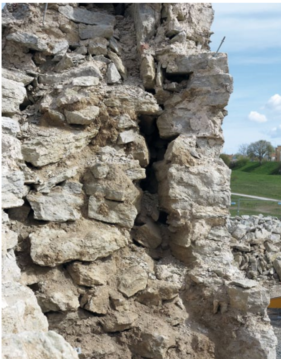
Figur 3.14. Profil vid den norra raskanten. Avsaknad av bindningar mellan kärna och skal har ökat trycket på murens yttre skal. Lägg märke till kärnan med lerbruk. Foto: Håkan Thoren.
