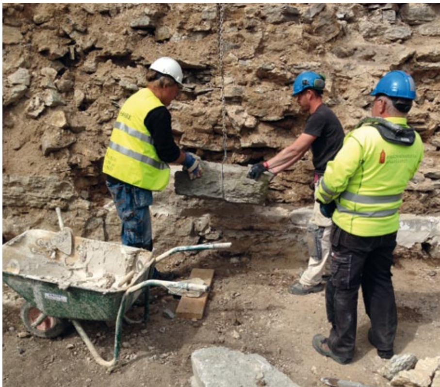
Figur 9.15. Med kranens hjälp lyfts de stora stenarna på plats. Här provar Erik och Daniel ut att det blir en lämplig storlek på stenen. Foto: Kristin Balksten.
