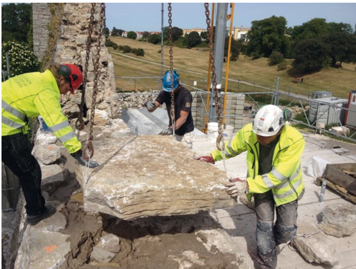
Figur 9.18. Bindstenar anno 2014 är stora och går långt in i muren. Det gäller att styra dem helt rätt eftersom kalkbruket suger fast dem när de väl läggs på plats. Foto: Curth Klasén.
