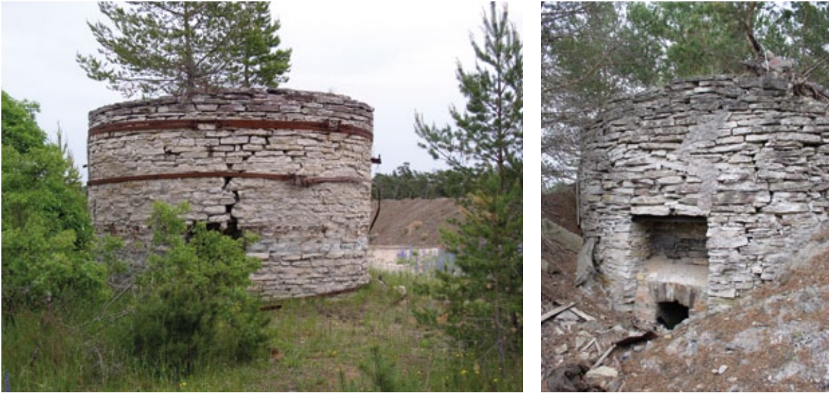
Figur 7.4. Kalkugnar vid Själso som brändes på 1940- till 60-talen. Foto: Kristin Balksten.
