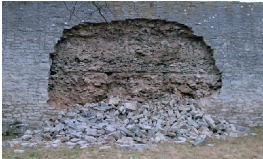
Figur 8.8. Rasmassorna framför muren fungerade som ett mothållande stöd. Foto: Ulrika Mebus.
