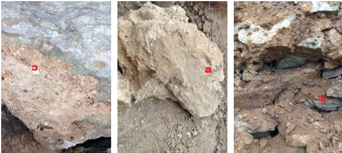
Figur 5.5 a–c. De tre typerna av murbruk; a. kalkbruk i gamla muren, b. lerbruk i kärnan och c. kalkbruk i påbyggda muren. Foto: Kristin Balksten.
