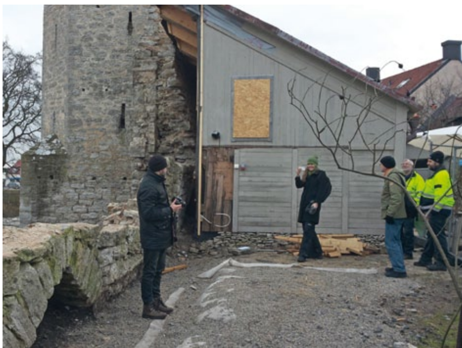
Figur 1.16. Projektmöte vid muren, denna gång på insidan. Många fotografier blev det, här förevisar Kristin Balksten forskningskollegan Carl Thelin medan fastighetsförvaltare Ulf Hofstedt, murare Mats Larsson och arbetsledare Kjell Jacobsson ser på. Observera marknivån på insidan, som ligger 2,5 meter över utsidans och där endast övre spetsen på arkadbågen är synlig. Här syns även tydligt hur nära muren verkstads huset befinner sig och att det blev nödvändigt att riva delar av det. Foto: Ulrika Mebus.
