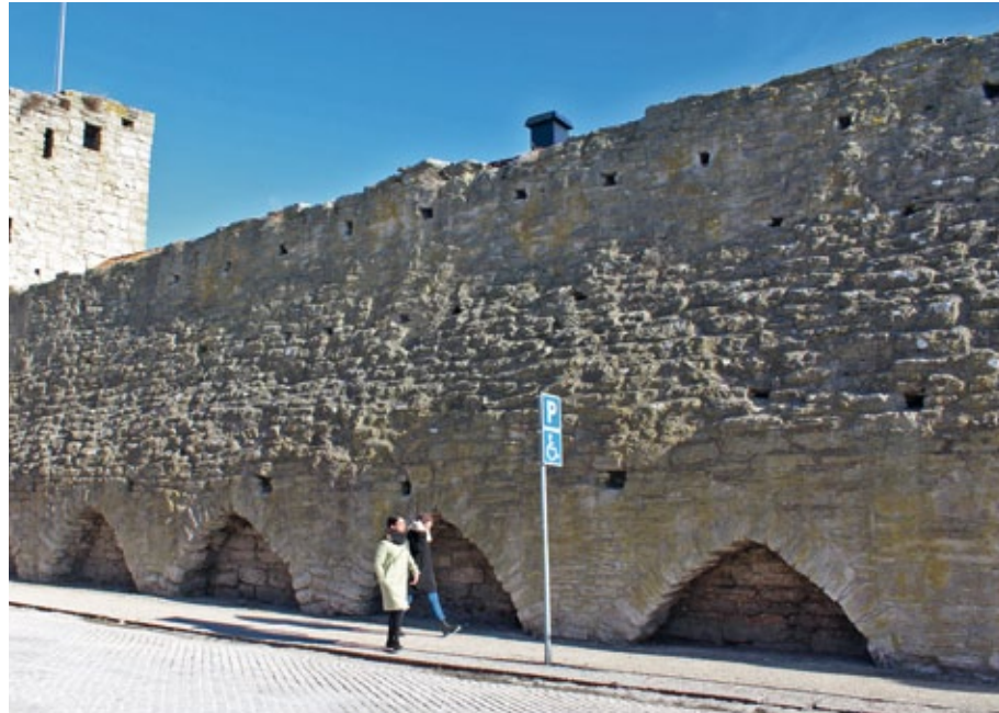
Figur 4.9. Murens insida strax söder om österport (mur 42). Ovanför arkadbågarna finns den så kallade flaskformiga påbyggnaden. Foto: Carl Thelin.
