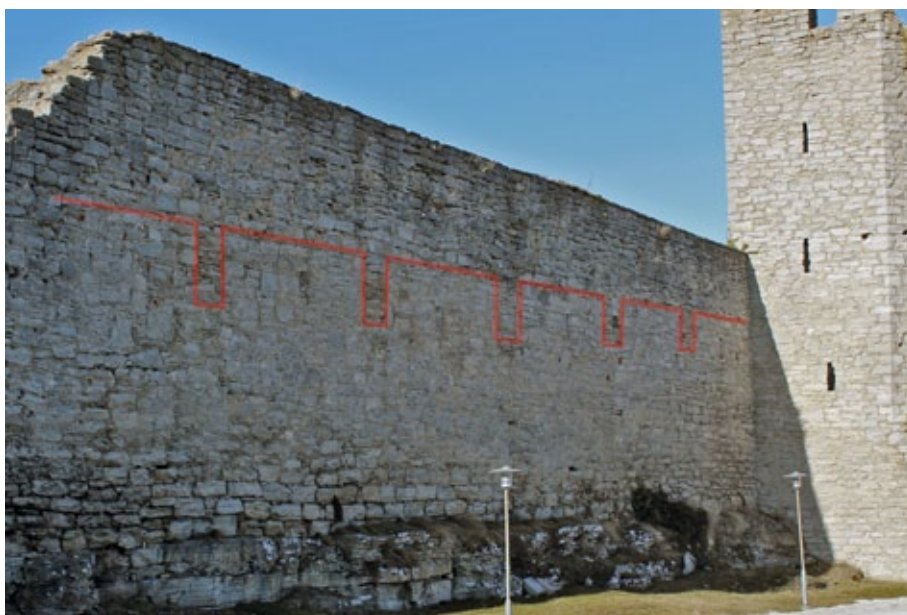
Figur 4.1. Exempel på område (mur 40) där konturerna av den första muren tydligt går att se i dagens mur. Konturen har fyllts i med ett rött streck. Foto: Carl Thelin.
