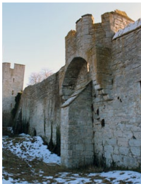
Figur 4.15. Del av mur 36 där det yttre skalet murats upp som kallmur. Foto: Carl Thelin.
