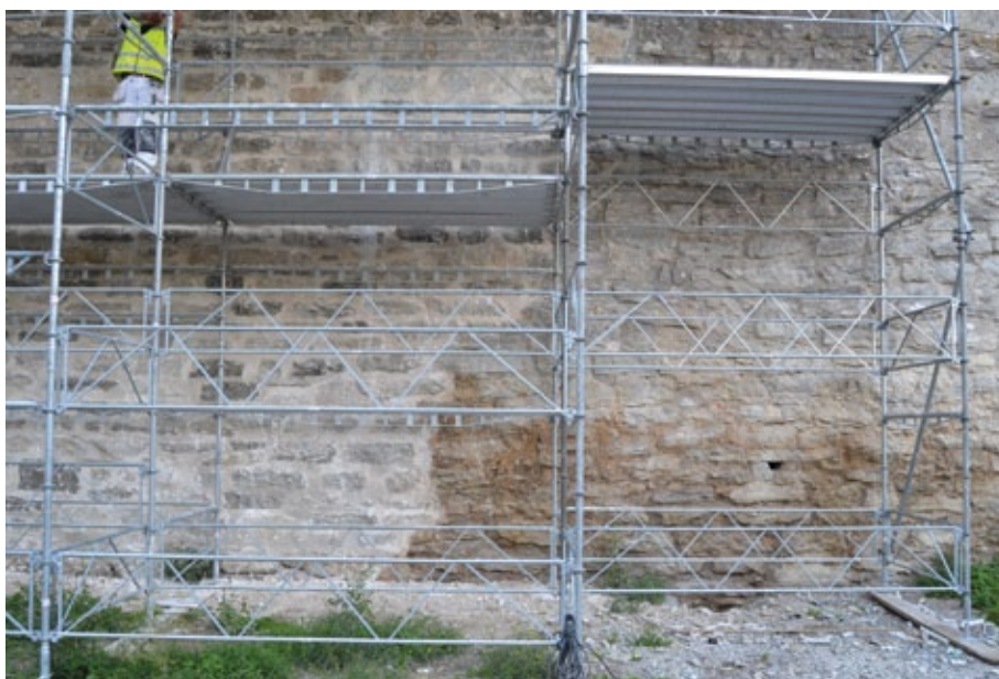
Figur 7.15. Jordsläckt kalkbruk till vertikala fogar. Foto: Kristin Balksten.
