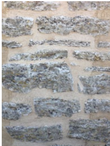
Figur 9.4. (överst t. v.) Provytorna är placerad intill tornet Stor-Christin och här syns gammal fog som överensstämmer med de nygjorda till form och kulör. Foto: Kristin Balksten.
