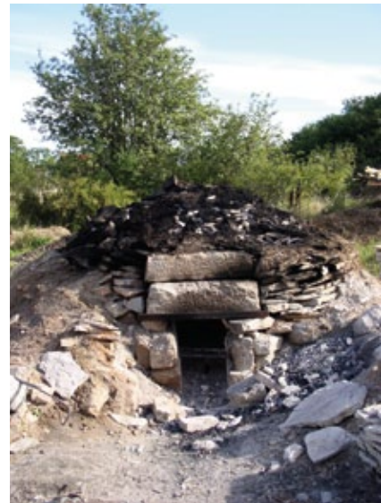
7.3. Bild på fältugnar visar en gammal fältugn från Jämtland (ovan t.v.) samt två milor som har bränns på senare år, den ena i utbildning vid Högskolan på Gotland i Ahr på norra Gotland (ovan t.h.) och den andra i Oviken Jämtland (t.v.).
