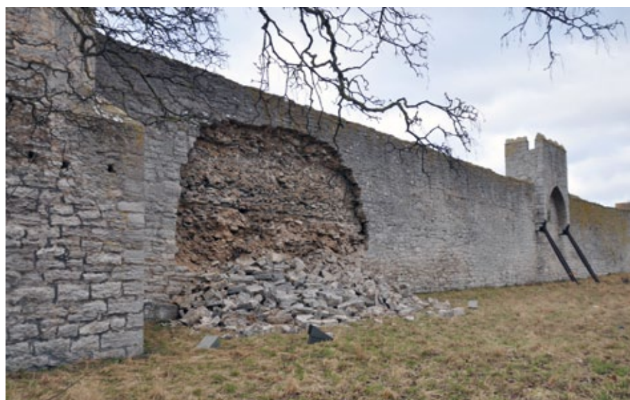
Figur 1.1. Den rasade muren två dagar efter kollapsen. Man ser tydligt den rösig kärnan och den horisontella linjen som utvisar nivån för den gamla skyttegången. Foto: Helen Simonsson/RAÄ.
