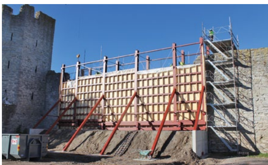
Figur 8.12. Nedplockning av muren har påbörjats efter färdig montering av stålkonstruktionen. Foto: Carl Thelin.
