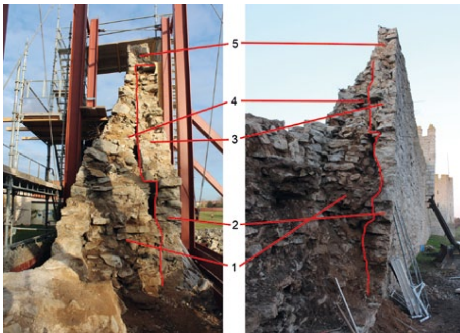
Figur 4.7. Två fotografier som visar samma del av muren fast i olika nivåer under nedplockningen av det raserade området. 1) Nedre kärnan med lerbruk och utan förband mellan stenarna. 2) Det tunna yttre murskalet i nedre delen. 3) Det tidigare bröstvärn som nu fungerar som yttre skal i murens mittersta del. 4) Den övre kärnan innanför bröstvärn. 5) Den översta delen murad som fullmur. Foto: Carl Thelin.
