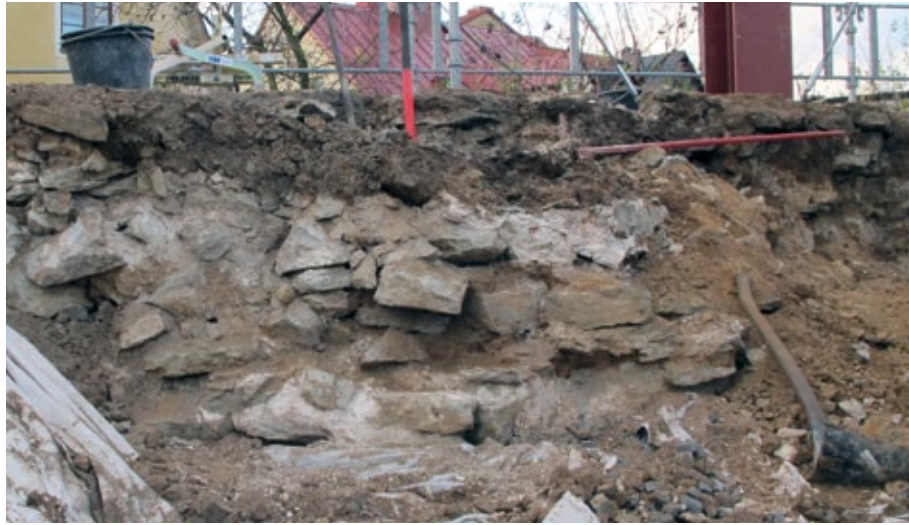
Figur 3.8. Kärnmuren med kalkbrukslager och lerbrukslager varvade. Minst två "lager" med sten hade lagts i kalkbruk. Foto: Mats Anglert.
