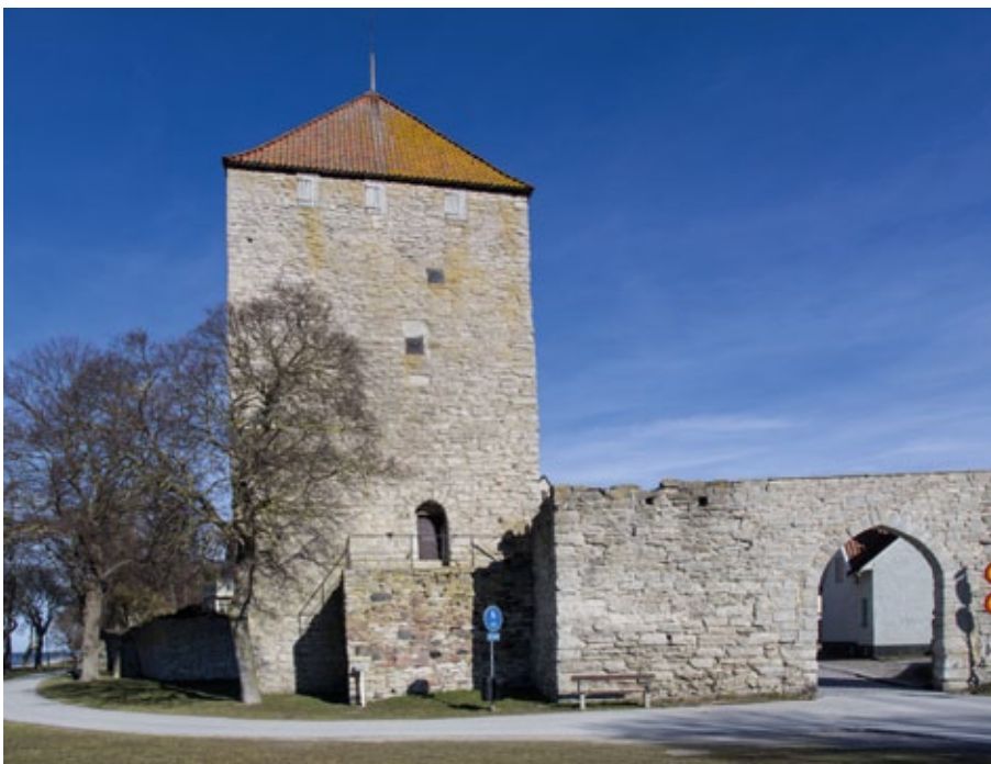
Figur 1.4. Kruttornet (namnet härstammar från 1700-talet) i Almedalen var ursprungligen ett fristående försvarstorn; en kastal. I mitten av 1200-talet byggdes den då nya sjömuren ihop med kastalen så att denna kom att bli ett element i ringmuren.
