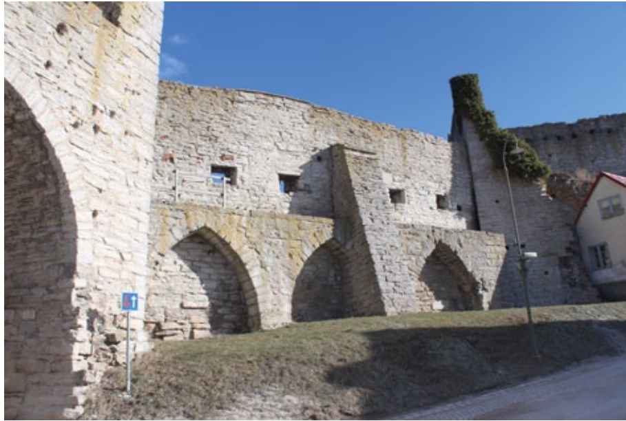
Figur 4.4. Mur 22 strax öster om norderport, sedd från insidan, där väktargången ovanför arkadbågarna har återskapats. I mitten finns också en förstärkning i form av en strävpelare. Foto: Carl Thelin.
