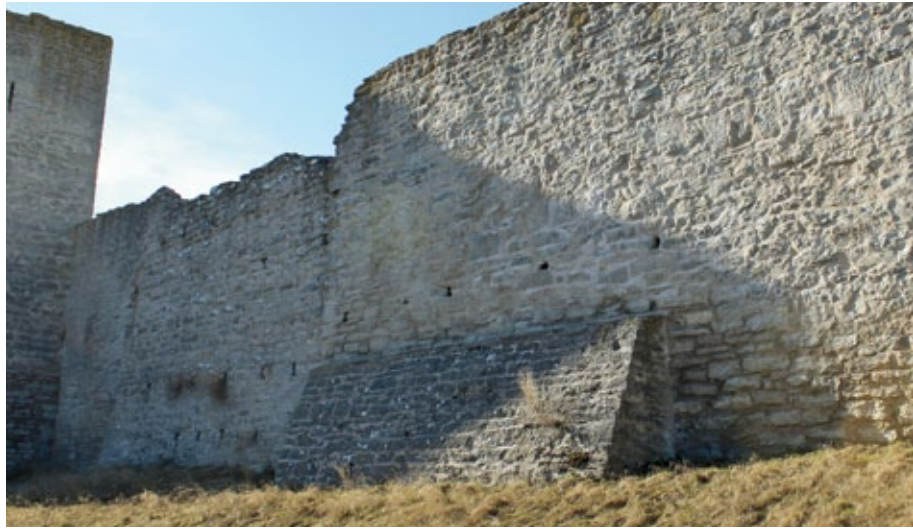
Figur 4.12. Förstärkning med försträvande mur på mur 44. Foto: Carl Thelin.
