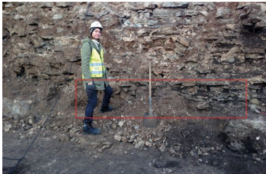
Figur 6.5 a–c. När rasmassorna är undanröjda och nedre murskalet bortrensat så framträder ett parti där murskalet varit cirka en fot i djup vilket syns i det rödmarkerade området. Som tunnast var murskalet bara 20 centimeter och bindstenar förekom inte. Foto: Ulrika Mebus (a) och Kristin Balksten (b och c).
