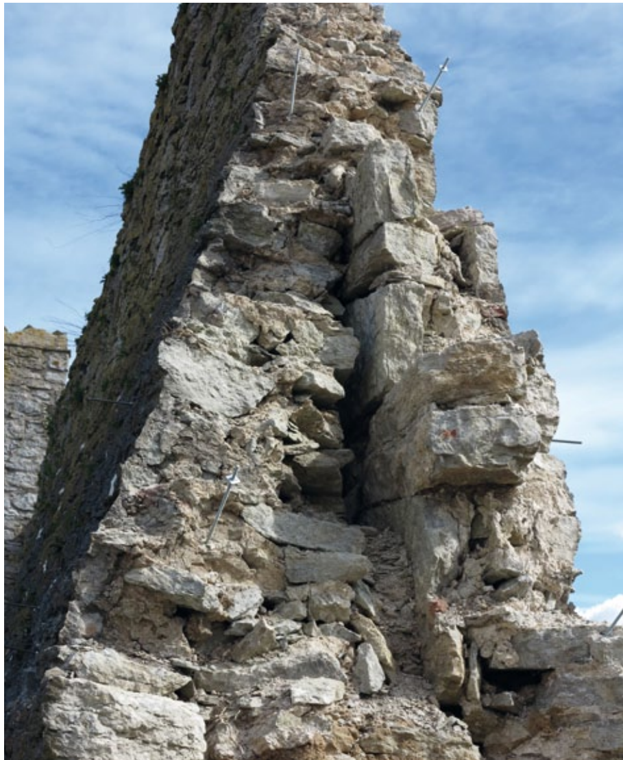
Figur 3.9. Murprofil med kärnmur med lerbruk och påbyggnad med kalkbruk. Längst ner syns toppen av kärnan med lerbruk och till höger framträder bröstvärnets insida tydligt. Foto: Håkan Thorén, minihelikopter.
