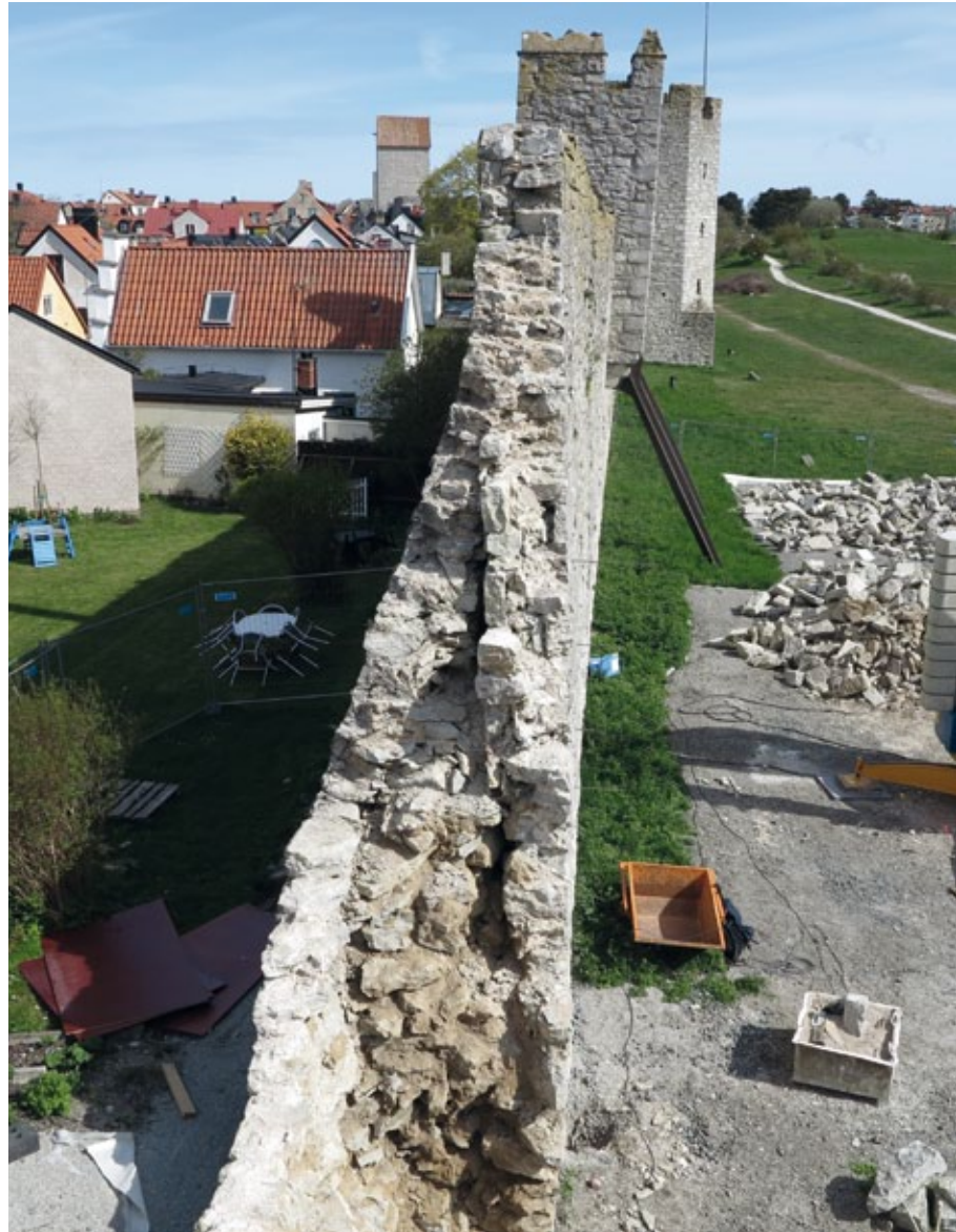
Figur 3.4. Den norra profilen efter nerplockningen visade tydligt på murens uppbyggnad och olika delar. Längst ner ses den äldre murens kärna lagd i lerbruk med omgivande murskal med kalkbruk. Skyttegången till den äldre muren har legat ovan lerbrukskärnan i anslutning till att bröstvärmnet ovan det yttre skalet. Foto: Håkan Thorén, minihelikopter.
