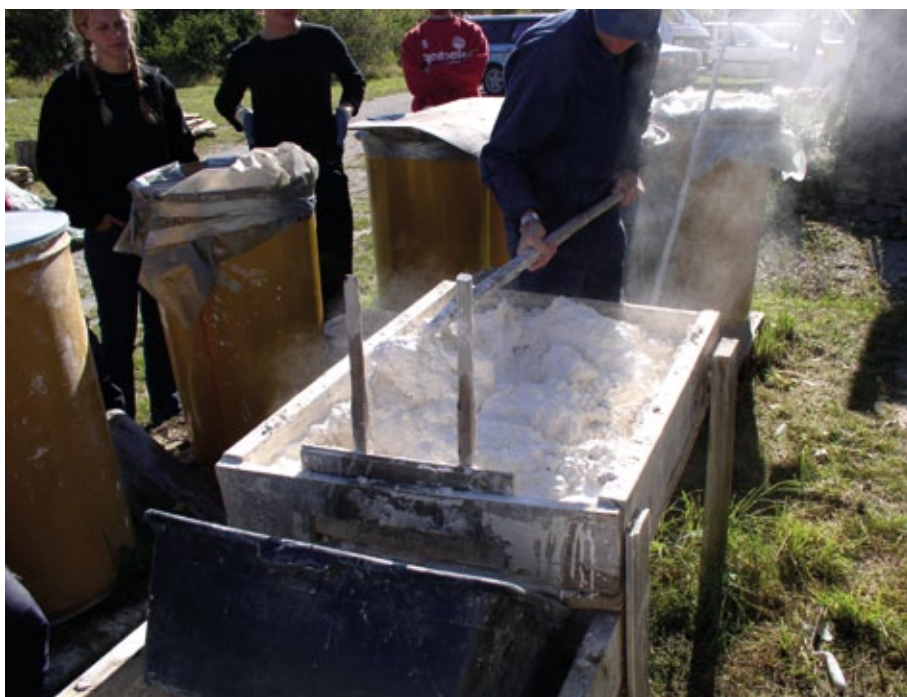
Figur 7.10. Våtsläckning av kalk i lave är kunskap som bevarats sedan gammalt på Gotland. Här visar murare Sivert Cederlund hur man gör. Foto: Kristin Balksten.
