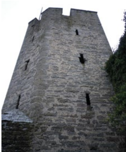
Figur 9.8. Fogning av de vertikala murpartierna sker med jordsläckt gotlandskalk och mursand 1:1,5. Foto: Kristin Balksten.
