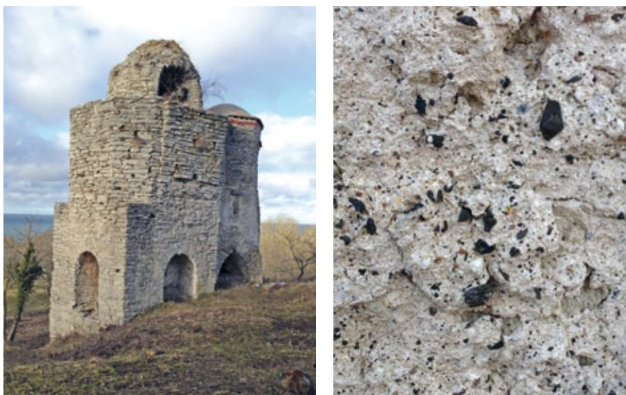
Figur 7.6. Wisbybergs kalkugn som uppfördes nära Galgberget i Visby. I putsen på ugnen syns kolbitar. Dessa var en problematisk förorening vid den här typen av kalkbränning. Foto: Kristin Balksten.
