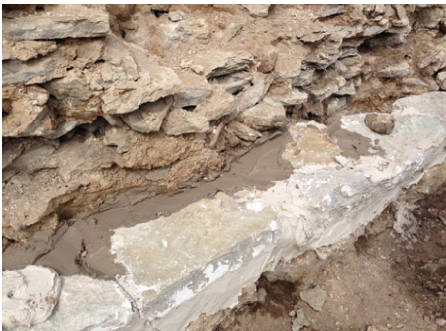
Figur 9.11. Lerbruket fyller upp bakom yttre skalet och möter kalkbruket. Det har tydlig skillnad i såväl kulör som klistrighet. Stenar och stövlar sugs väl fast i lerbruket. Foto: Kristin Balksten.
