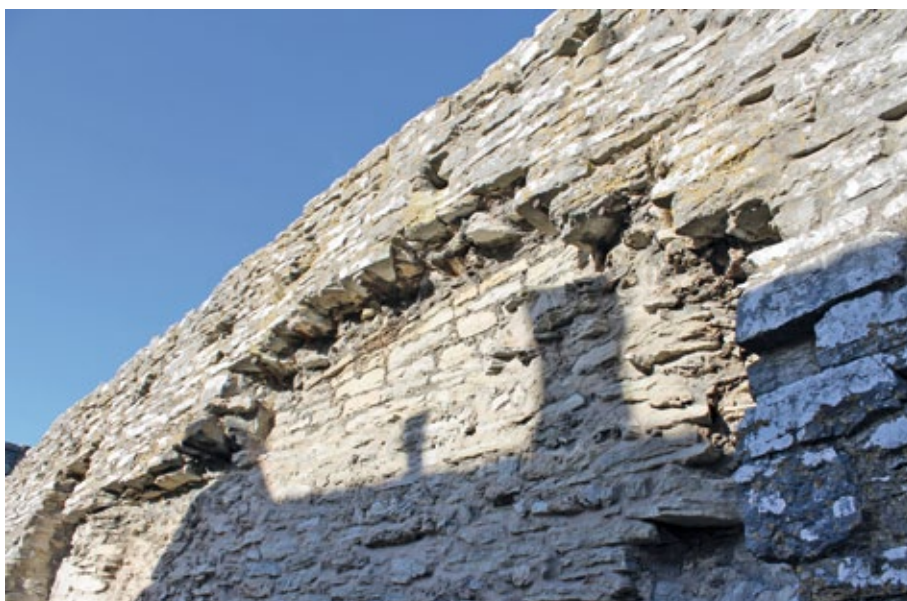
Figur 4.16. Järnstag som stöttar upp övre delen av muren på insidan av mur 14. På utsidan har muren förstärkts. Foto: Carl Thelin.
