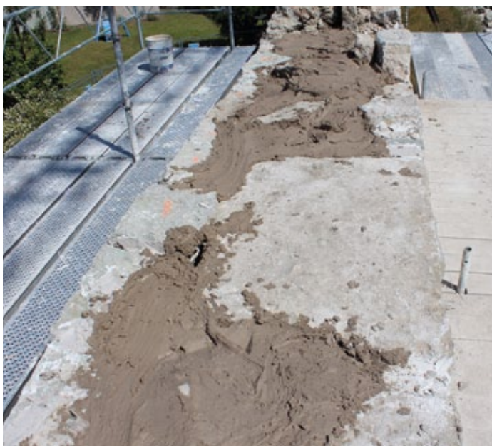
Figur 8.17. (t. h.) Den färdiga krön-avtäckningen. Foto: Ulrika Mebus.
