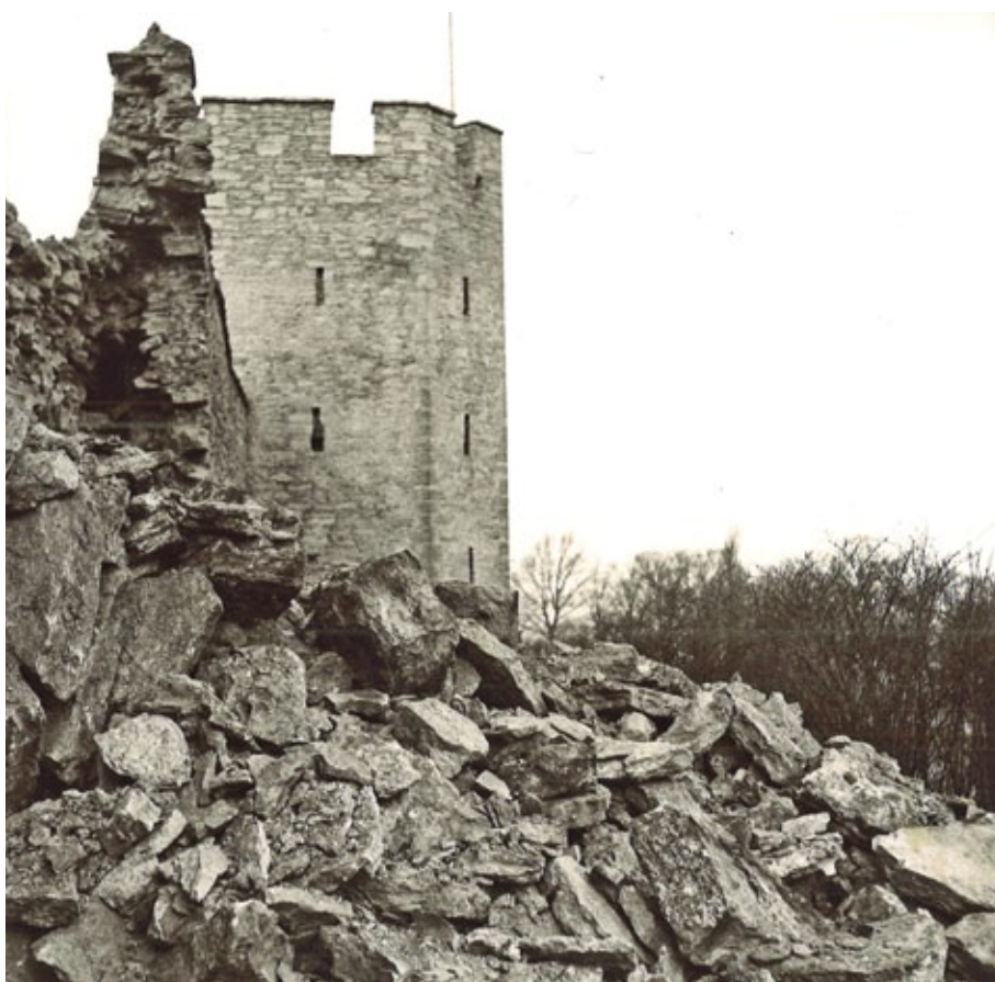
Figur 2.7. Raset vid St Göransporten 1962 kom, liksom raset vid mur 38 år 2012, utan förvarning för de antikvariska myndigheterna. Orsaken vid de båda rasen är delvis desamma. En urlakad försvagad kärna utan bindning till skalmurarna, samt en medeltida påbyggnad utan åtgärder för att förstärka den underliggande muren, gjorde muren instabil. Foto: Gotlands Museums arkiv.
