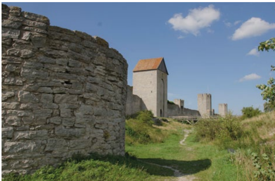
Östermur med kaponniären Sparbössan i förgrunden. Bakom den ses Dalmans-tornet med takresning från 1700-talet. Foto: Helena Duveborg.
