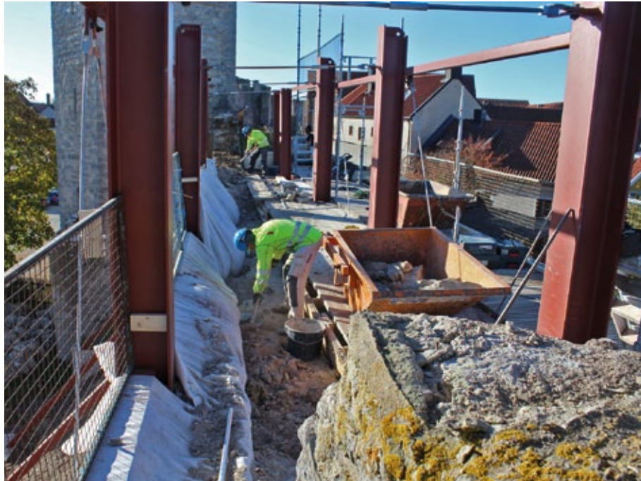
Figur 8.13. Nedplockning pågår efter att arbetsplatsen gjorts säker med den tillfälliga stålkonstruktionen. Foto: Carl Thelin.
