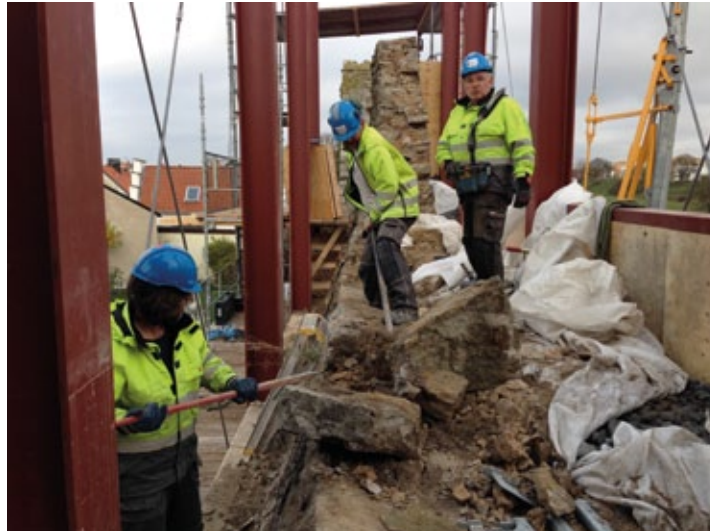
Figur 9.12. Nedplockningen sker med spett och kran. Här håller Mats och Urban i spetten medan Inge sköter kranen.
