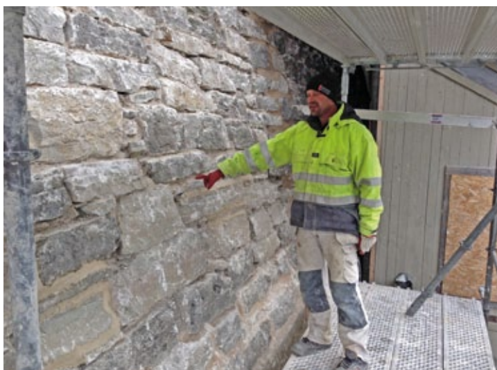
Figur 9.7 a–c. Fog på svagt hydraulisk gotländskalk som Daniel Sjöberg provat ut; 1:1 samt 1:1,5. Nertill syns jämförande prov med öländskalk 1,5:1. Den gotländska hydrauliska kalkens kulör stämmer bättre överens med de gamla bruken som finns på muren. Foto: Kristin Balksten.
