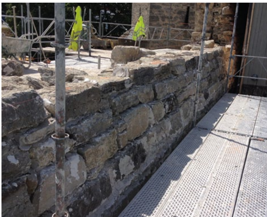
Figur 9.18. Bindstenar anno 2014 är stora och går långt in i muren. Det gäller att styra dem helt rätt eftersom kalkbruket suger fast dem när de väl läggs på plats. Foto: Curth Klasén.
