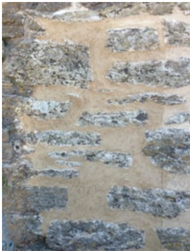
Figur 9.4. (överst t. v.) Provytorna är placerad intill tornet Stor-Christin och här syns gammal fog som överensstämmer med de nygjorda till form och kulör. Foto: Kristin Balksten.
