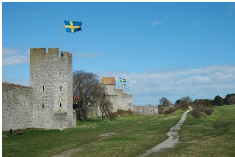
Figur 1.8. Mur 36 strax norr om murraset 2012. I det här partiet skedde 1871 ett av de större rasen. Partiet återuppsyggs som kallmur utan fog och är tydligt urskiljbart både på grund av annan murningsmetod och för att det inte är uppmurat i fullhöjd. Sadeltonet närmast bortom raset stöttades under 1800-talet med två gjutjärnsstötter. Foto: Helen Simonsson/RAÄ.
