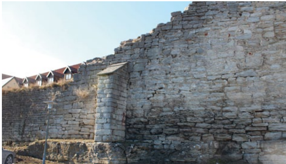
Figur 4.13. Strävpelare på mur 40. Foto: Carl Thelin.
