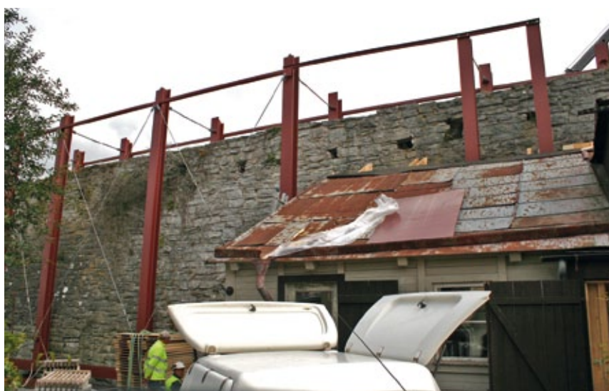
Figur 8.10. På insidan fick den stabiliserande stålkonstruktionen anpassas för att kunna monteras innanför huset som stod mot muren utan att huset skulle behöva rivas. Foto: Carl Thelin.
