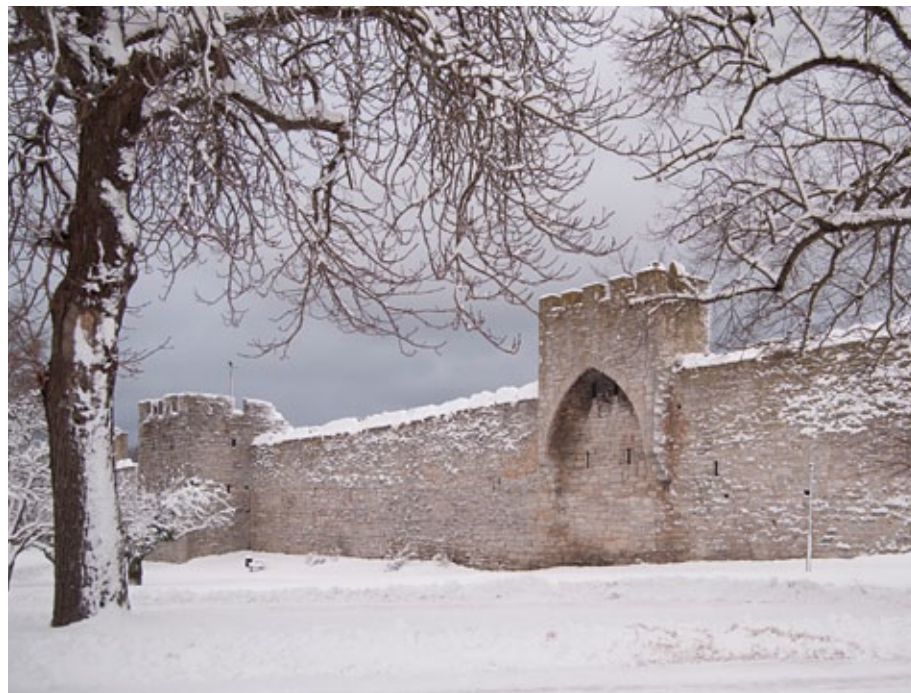
Figur 1.3. Södermur i snö. Ett av de nio kvarvarande sadeltornen syns här intill ett marktorn av en mera ålderdomlig typ än tornen med avfasade hörn som uppträder i Östermur. Foto: Helen Simonsson/RAÄ.
