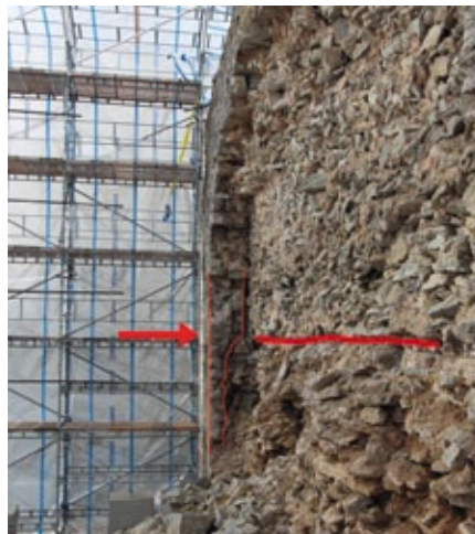
Figur 4.8. Fotografi från raset som visar hur murens ytterskal blir tjockare i bröstningsmuren ovanför skyttgången (nivå markerat med pilen). Foto: Carl Thelin.
