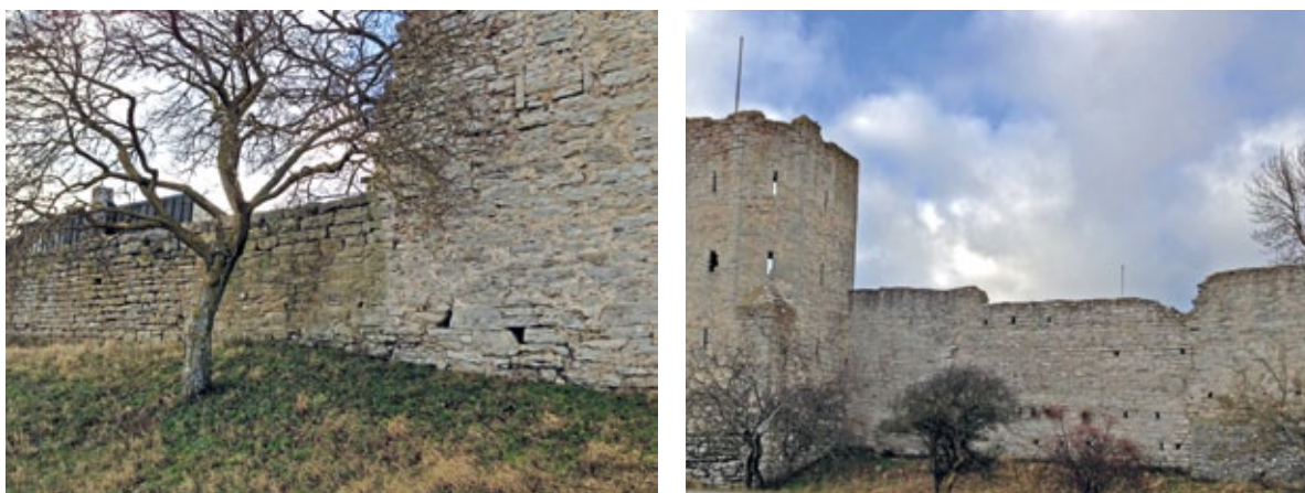
Figur 7.1. Här syns exempel på ett par tidigare ras där återuppbyggnaden har skett på olika sätt. Foto: Kristin Balksten.
