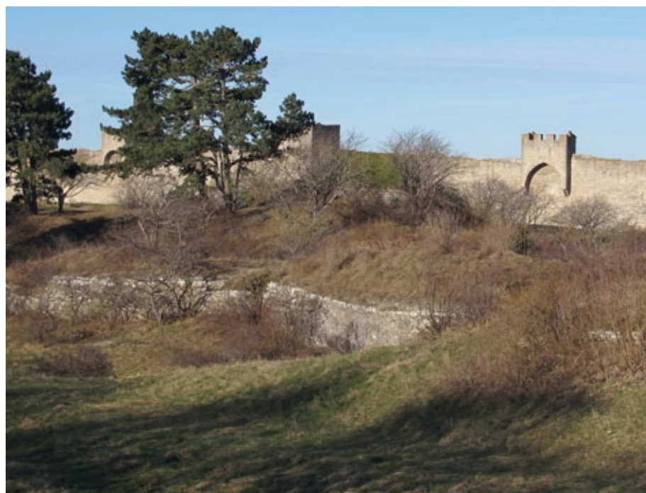
Figur 1.5. Gammalt stenbrott i Östergravar. En ansenlig del av byggnadsstenen till Visbys kyrkor, stenhus och stadsmur bröts i området närmast ringmuren, uppe på klinten. På så vis skapades även ringen av trenne vallgravar som på medeltiden omgav Visby. Under århundradenas lopp har vallgravarna fyllts igen avsiktligt eller på grund av kulturlager. Bäst bevarade är de i Nordergravar. Foto: Ulrika Mebus.
