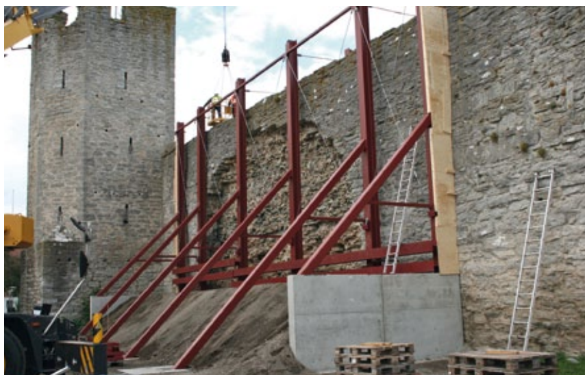
Figur 8.9. På murens framsida behövde marknivån fyllas upp till över rasmasorna för att möjliggöra placering av den stabiliserande stålkonstruktionen. Stålkonstruktionen har börjat monteras på plats. Foto: Carl Thelin.
