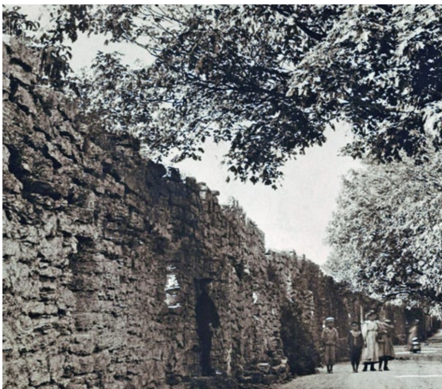
Figur 2.2. Muren längs Studentallén tillhör de partier av muren där krönstenen tidigt jämnades till och lades om i KC-bruk. Fotot, av okänt datum, visar muren innan den första restaureringsinsatsen.
