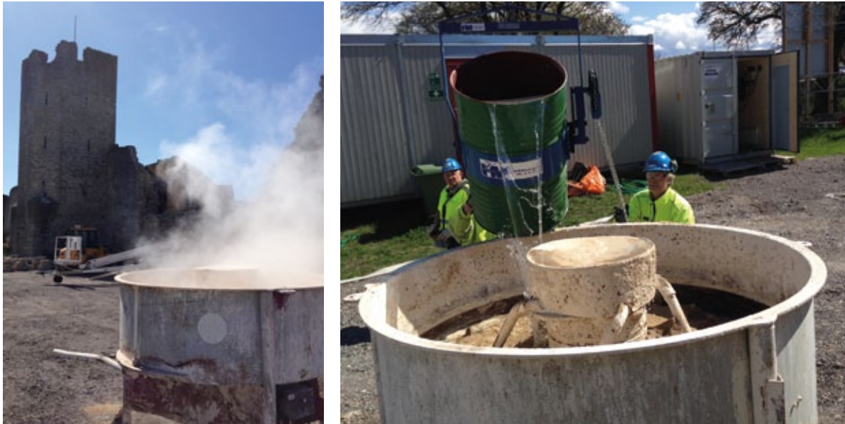
Figur 9.14. Stukasläckning i stor planbländare som fylls på med hela tunnor av kalk, sand och vatten.
