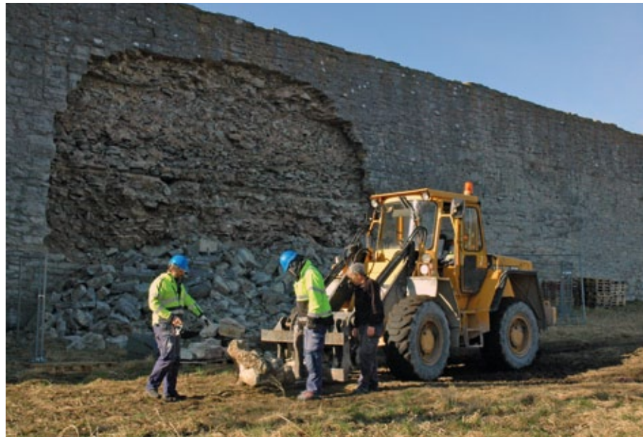
Figur 1.11. Byggnadshyttan röjer och sorterar den sten som rasat längre ut från raset. Rashögen som låg direkt mot muren under raset lämnades av säkerhetsskäl kvar. Foto: Ulrika Mebus.
