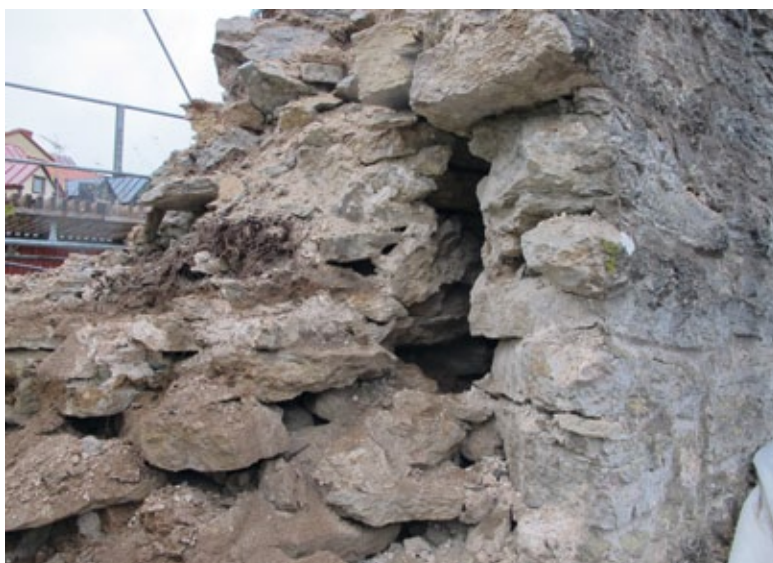
Figur 3.6. Nivån för skyttegången i den luftiga muren vid raskanten i norr. Centralt i fotot syns kalkbrukslagret och ovanliggande jordlager som sträckte sig längs hela rasytan. Träet som syns ovan lagren är resterna efter en förmodad bjälke. Den översta stenen till höger är första stenen i bröstvärnet. Foto: Per Widerström.
