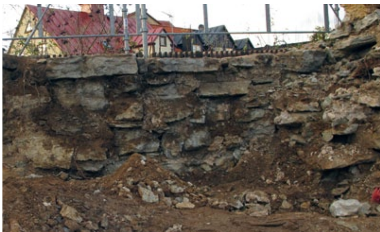
Figur 3.7. Skalmuren mot staden saknade bindstenar mot kärnan. Lägga även märke till all jord som fanns i muren. Foto: Per Widerström.
