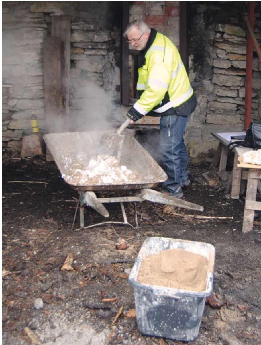
Figur 1.19. Kjell Jacobsson förevisar stukasläckning av packsten i liten skala vid kalkugnen vid Rings i Hejnum, där kalken till ringmursupbyggnaden brändes. Stukasläckning kom att bli den metod som valdes för återuppbyggnaden av ringmuren. Foto: Helen Simonsson/RAÄ.
