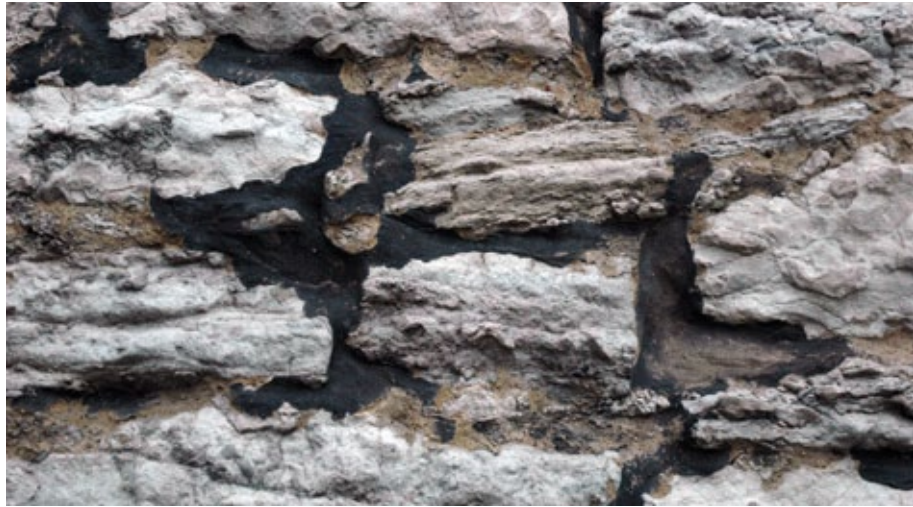
Figur 2.3. Svartcement i fogar på torn 39. Detta fogbruk användes flitigt i första hand på kyrkoruinerna från 1880-talet. Brukets sammansättning och materialinnehåll finns det ingen kunskap om idag. Foto: Jörgen Renström.
