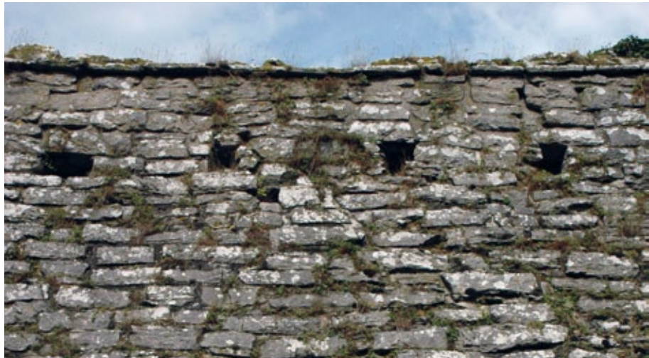
Figur 2.4. Metoden under 1930-talets restaureringar av krön gick ut på att plocka ner de tre övre stenskiften för att återuppmura dessa med originalsten lagt i "gott kalkbruk" med iblandning av 10 procent cement. Foto: Jörgen Renström.
