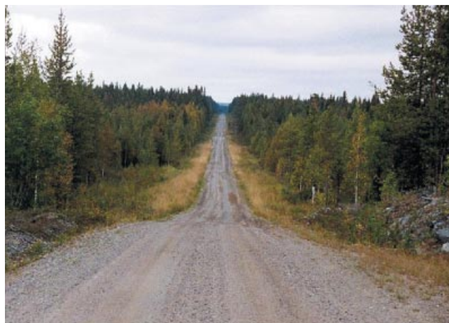
AK-väg i Överkalix kommun. Dessa vägar är ofta dåligt anpassade till terrängen med sina raka sträckningar, tvära kurvor och ständigt återkommande nivåskillnader. Foto: Länsstyrelsen i Norrbottens län.
