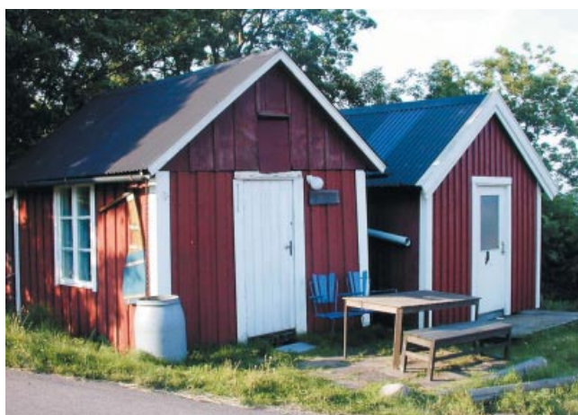
Sjöbodarna har som regel rödmålade träfasader och tak av antingen plåt eller papp.
