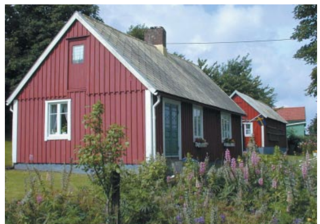
Gatehus med träfasad på Bjärehalvön.
