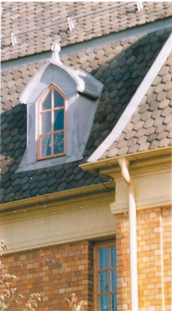
T. v.: Plåtintäckt takkupa som smälter naturligt in i takytan. 1994.
