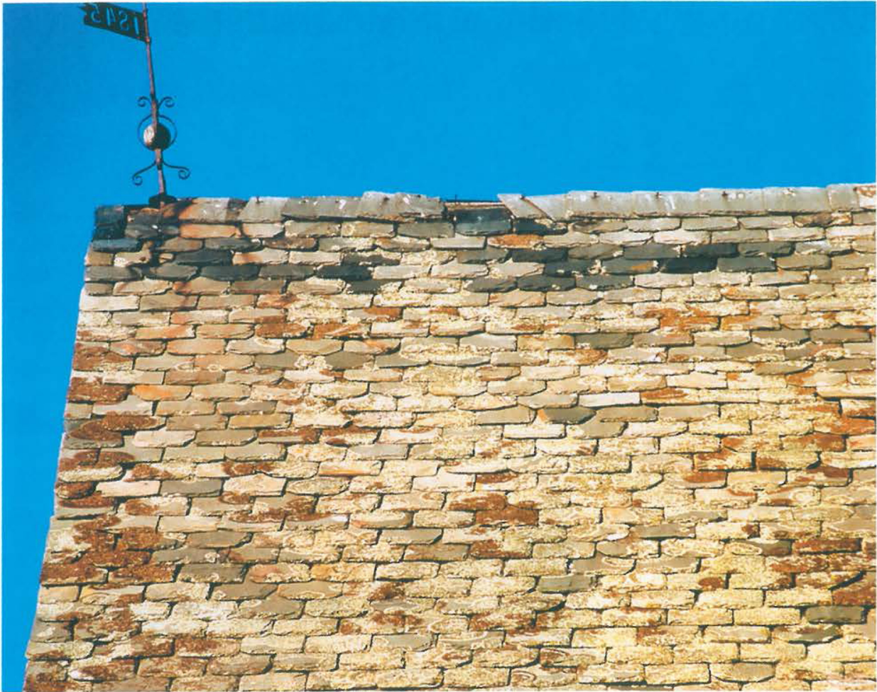
T. v.: Gavelsprång och lutande nock utförda i skiffer. 1994.
