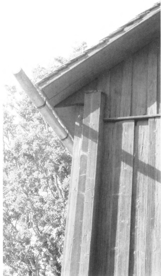
Nastugan i Skasås ligger på en höjd ovanför Byälven. Skiffertaket ger ett lätt och gracilt intryck, alla kanter är avslutade med skiffer. Takets anslutning mot skorstenen har i senare tid avtäckts med plåt. 1994.
