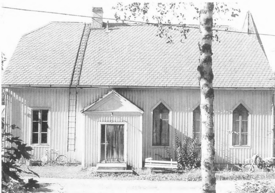
Kvadratiske plattor som läggs diagonalt, fyrkantsskiffer. Över spik och hak ligger plattorna i två lager.
