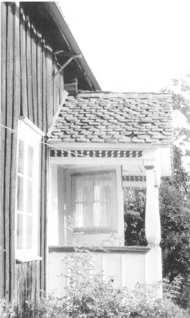
Nastugan i Skasås ligger på en höjd ovanför Byälven. Skiffertaket ger ett lätt och gracilt intryck, alla kanter är avslutade med skiffer. Takets anslutning mot skorstenen har i senare tid avtäckts med plåt. 1994.
