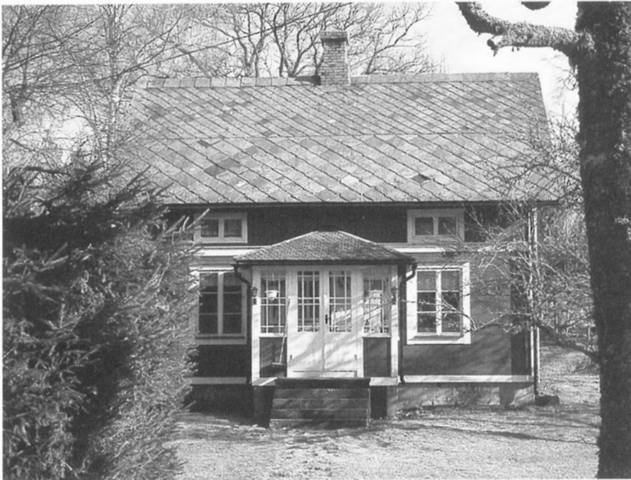
"Solhem" i Källsviken 1993, egnahem uppfört 1917. Taket är täckt med Dalslandsskiffer i diagonaltäckning med kvadratiska skifferplattor. Mitt på takfallet byts plattstorlek.
