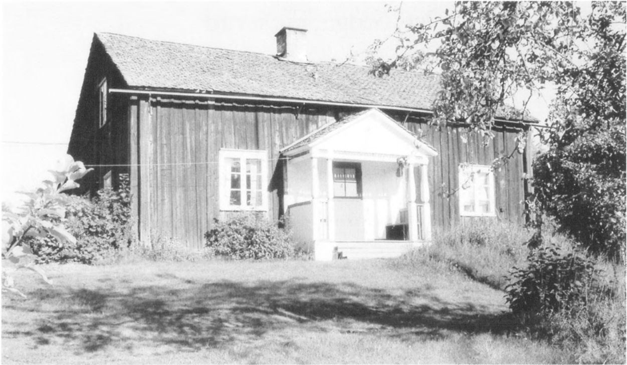
Nastugan i Skasås ligger på en höjd ovanför Byälven. Skiffertaket ger ett lätt och gracilt intryck, alla kanter är avslutade med skiffer. Takets anslutning mot skorstenen har i senare tid avtäckts med plåt. 1994.
