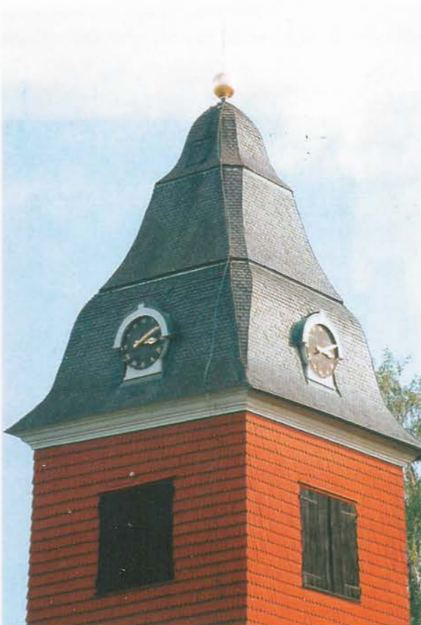
Grythyttans kyrka från tidigt 1900-tal då skiffern var nylagd. Jämför rännal och takfot med fotot på motstående sida.
