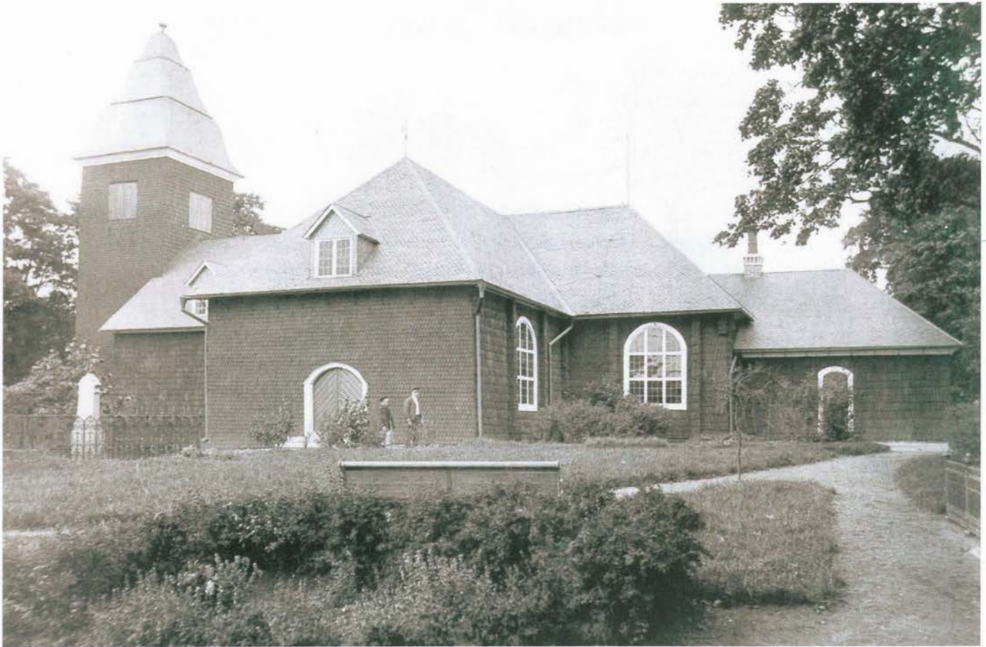
Grythyttans kyrka från tidigt 1900-tal då skiffern var nylagd. Jämför rännal och takfot med fotot på motstående sida.
