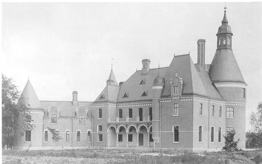
Lejonslödet i Uppland med tak av Grythytteskiffer och avtäckningar i plåt, byggt 1889–1891.
