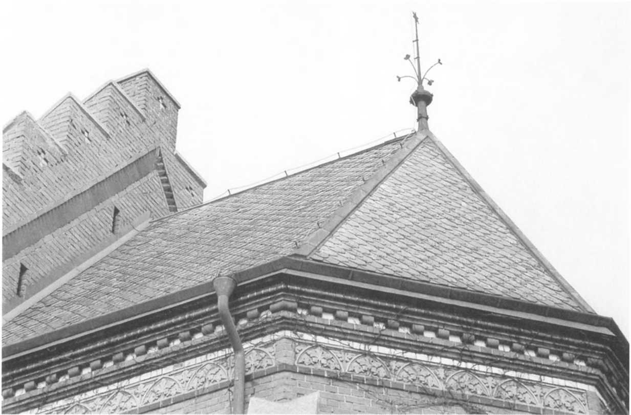
Ovan: Fuglie kyrka från 1904 har takfotsplåt med ståndränna och plåtbeslag på de lutande nockarna. Den galvaniserade plåten är målad i en kraftigt röd färg, nära murverkets tegelröda.
