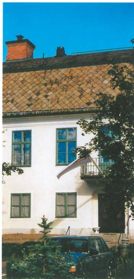
T. h.: De mörka plattorna finns kvar slumpmässigt utspridda på takfallen. 1994.
