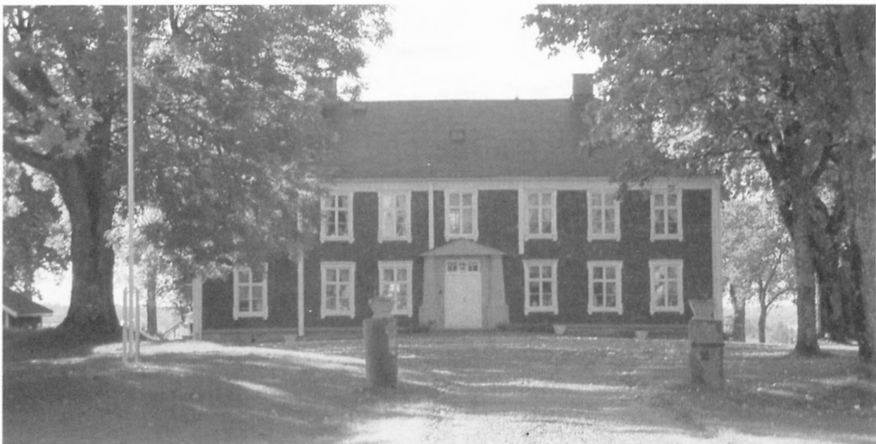
Ekholmens säteri 1994, huvud- byggnaden uppförd 1799. Skiffer på det valmade taket och helt skifferklädd fasad från tidigt 1800-tal.
