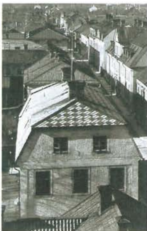
Foto från Kristine kyrktorn, 1920-tal, som visar de mönsterlagda övre takfallen. Till detta mörkt målade plåtarbeten.
