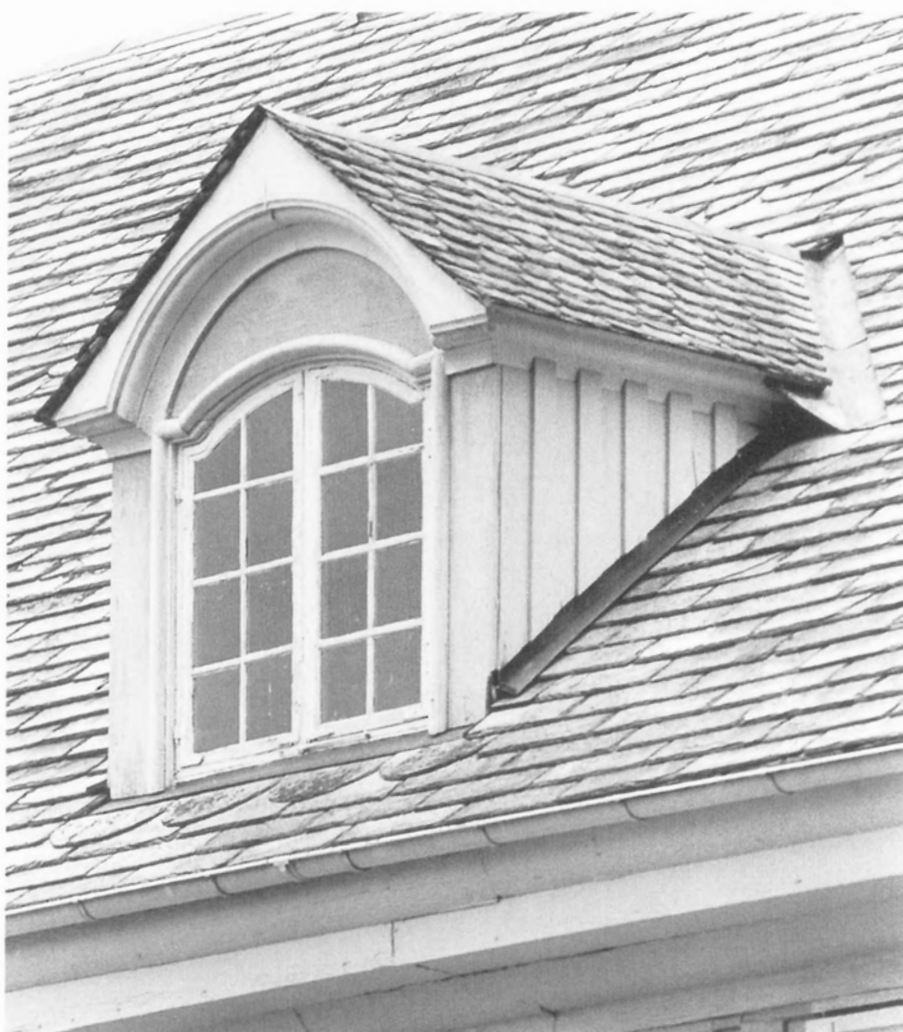
Skiffertaket på Dahlgrens- gården i Åmål. Gården är byggd 1788. Glavaskifferns i övrigt raka plattor har fått en rundad dekorkant under takkupan. 1994.
