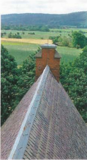
Utsikt från tornet över den plåtklädda nocken.
