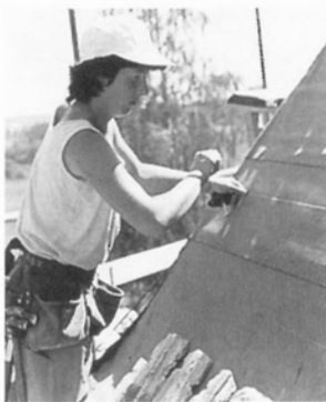
Omläggning av taket på Frykeruds kyrka i Värmland. Skiffern staplas först på taket och på ställningen. Skifferraderna linjeras upp med snörslagning och plattorna läggs i rak trelagstäckning. Skiffern spikas i bak. 1993.
