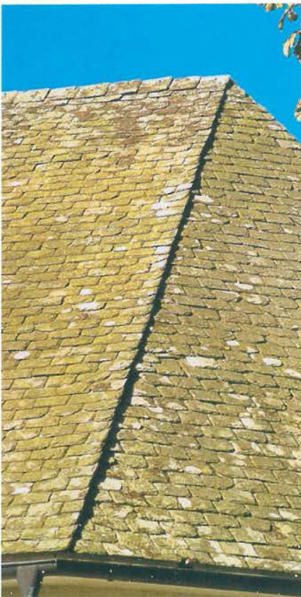
T. v.: Gavelsprång och lutande nock utförda i skiffer. 1994.
