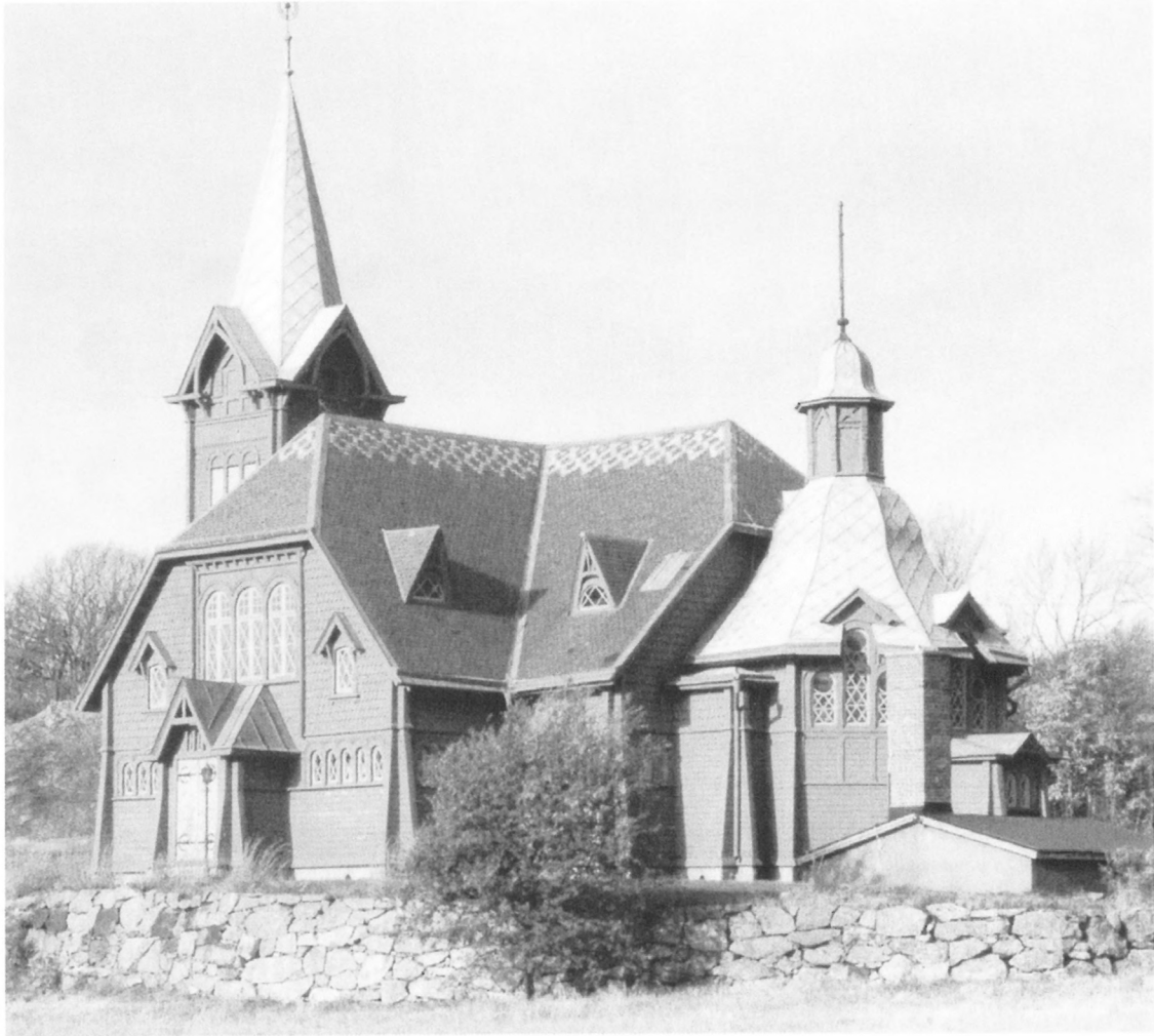
Hällevikstrands kyrka från 1904 har skiffer från Grythyttan med ljusare mönsterläggning utförd i Glavaskiffer. Torn och avtäckningar är utförda i omålad zinkplåt. 1993.
