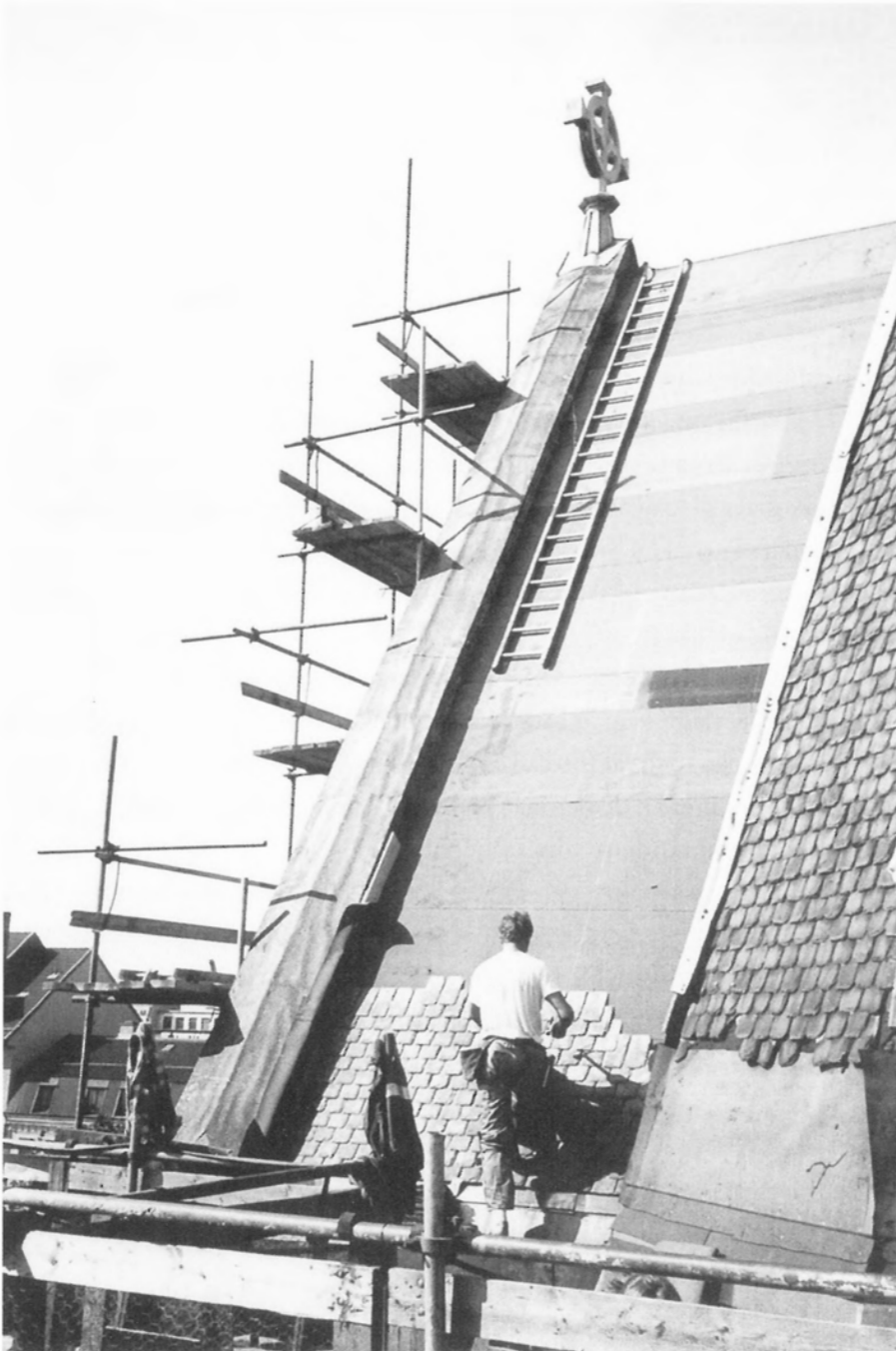
Gustav Adolfs-kyrkan i Helsingborg, invigd 1897. Taket under omläggning 1989.
