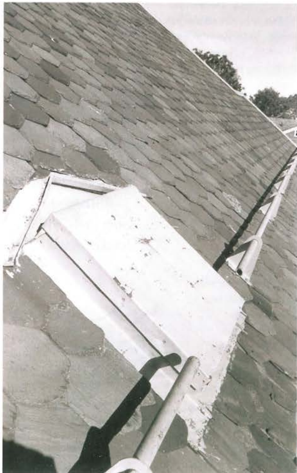
Taklucka av plåt med föredömliga avtäckningar mot skiffer-taket. Lägg märke till att skifferplattorna har specialbuggits på bägge sidor om luckan. Foto och uppmätning 1994.
