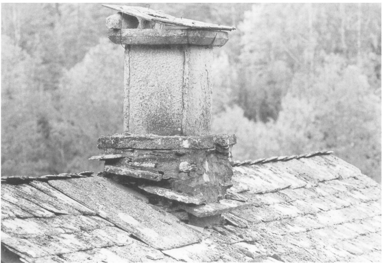
Skorsten och taklucka av skiffer, Dalsland. En något ljusare skiffer kallad Lianeskiffer eller Dalskogssten användes till bl. a. skorstenar och kvarnstenar. 1994.
