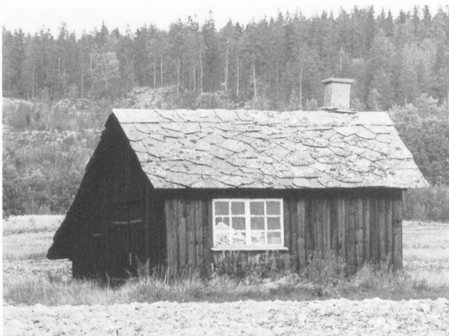
Smedja med oregelbundna skifferplattor, skråskiffer, nära byn Tegen i Dalsland. Skiffern är lagd ovanpå en spåntäckning. 1994.
