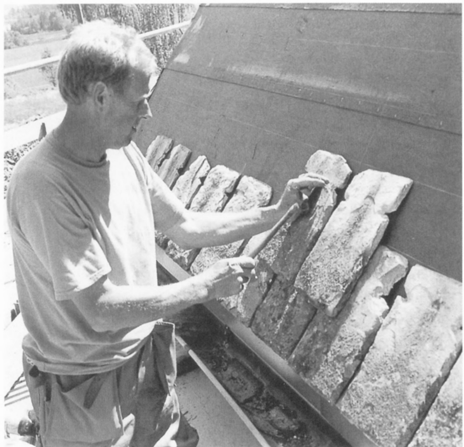
Omläggning av taket på Frykeruds kyrka i Värmland. Skiffern staplas först på taket och på ställningen. Skifferraderna linjeras upp med snörslagning och plattorna läggs i rak trelagstäckning. Skiffern spikas i bak. 1993.
