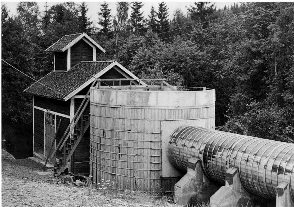
Kopparhyttans kraftverk med tub, kombinerad svallbassäng och turbinsump samt det enkla maskinhuset med utledningstorn. Tub och svallbassäng är nybyggda sedan de förstörts vid 1977 års svåra vårflood. BS 1977.
