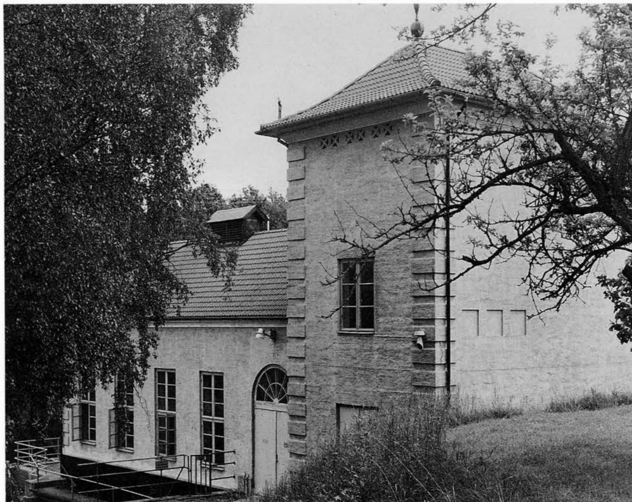
Vågforsen I:s kraftstation från nedströmssidan. BS 1989.
