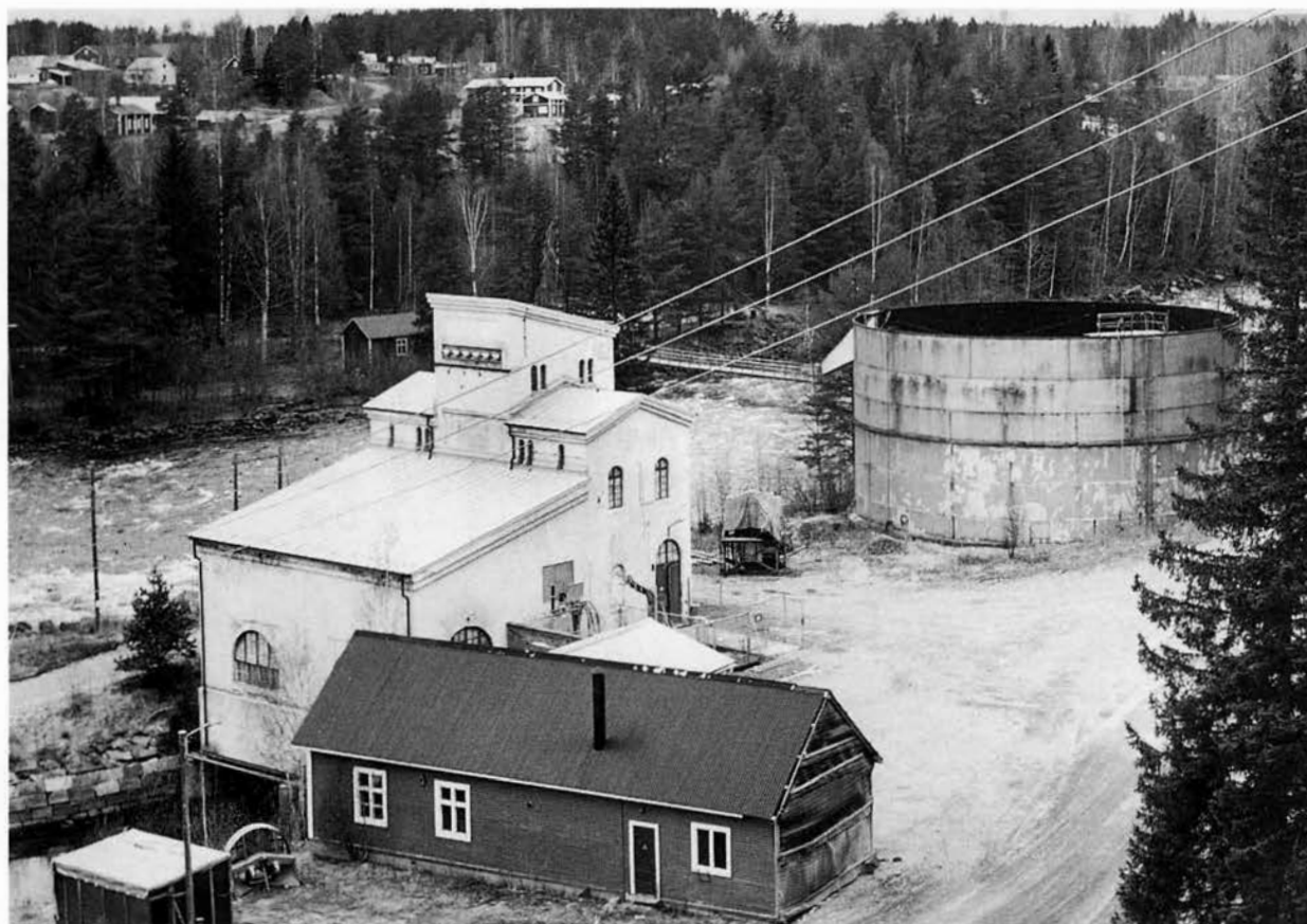
Sikfors kraftverk med maskinhuset till vänster och det stora svalltornet till höger. Tuberna mellan svalltornet och kraftstationen ligger under mark. BS 1992.
