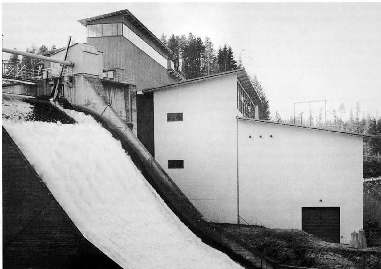
Krångfors kraftverk med frivattentappning över sektorluckan. Kraftstationens tre byggnadskroppar med de eleganta pulpettaken framgår tydligt med luckhuset överst, därefter ställverksbyggnaden och längst ner maskinhuset. Jämför med Hammarforsens kraftverk. BS 1992.
