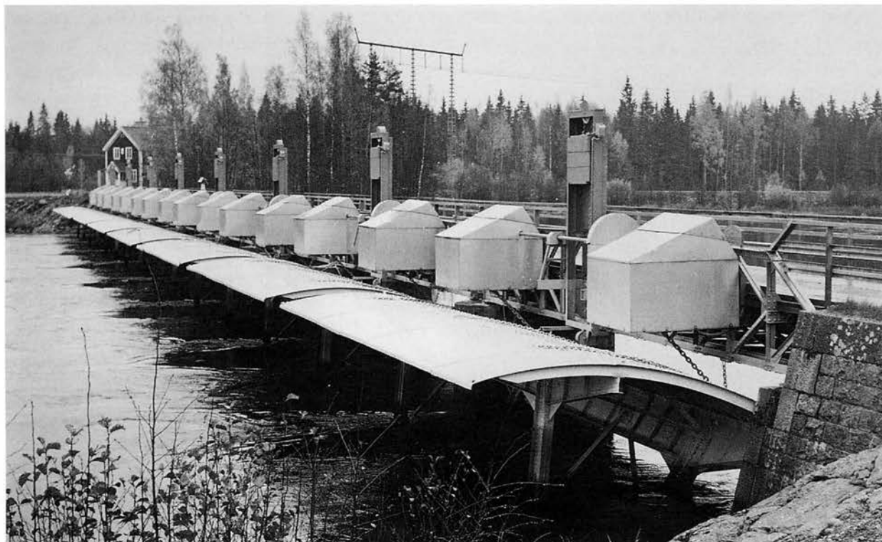
Avstängningsluckor av segmenttyp i intagskanalen till Untra kraftverk. Luckorna är sannolikt landets f.n. äldsta segmentluckor. BS 1992.
