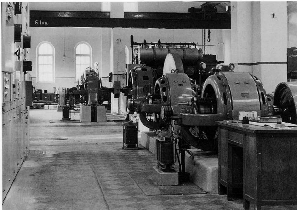
Interiör från Fritsla kraftstation. I fonden den stora fyrcylindriga dieselmotorn med generator. BS 1979.
