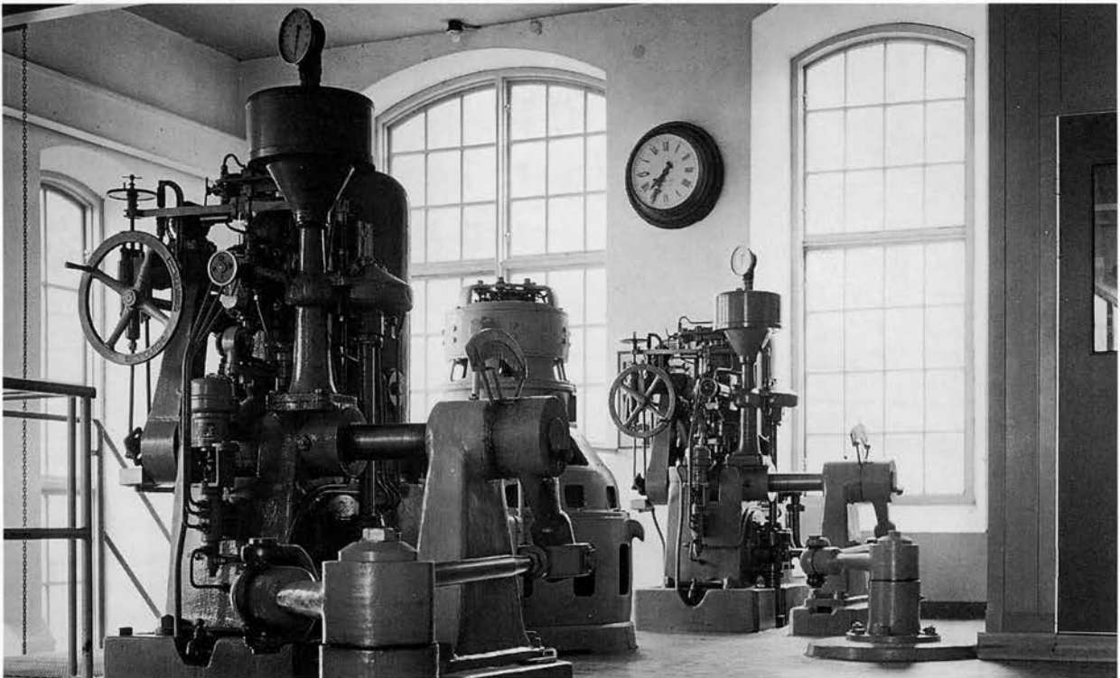
Generatorbalkongen i Lennartsfors I:s kraftstation med en av de fyra vertikallaxlade generatorerna mellan två turbinregulatorer. BS 1991.
