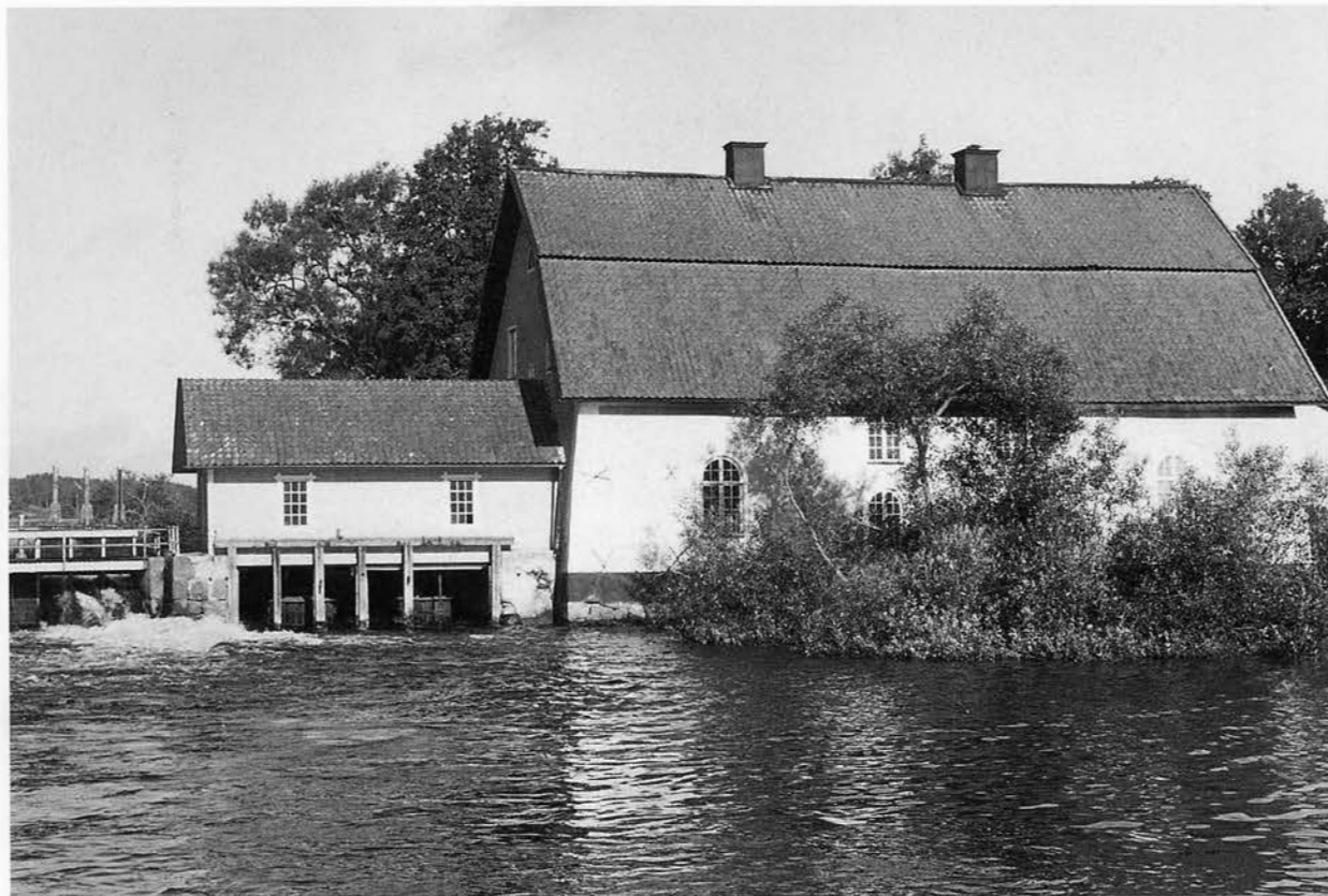
Djulfors kraftstation och kvarn från nedströmssidan. Turbinsumpens vägg är bortriven och de två turbinerna frilagda. BS 1993.
