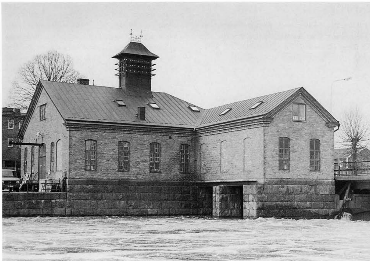
Arboga kraftstation. Ångmaskiner och generatorer fanns i den vänstra byggnadsdelen med det ståtliga utledningstornet. Den högra delen är turbinhuset och till höger om detta skyntar den kombinerade dammen och gatubron. BS 1989.
