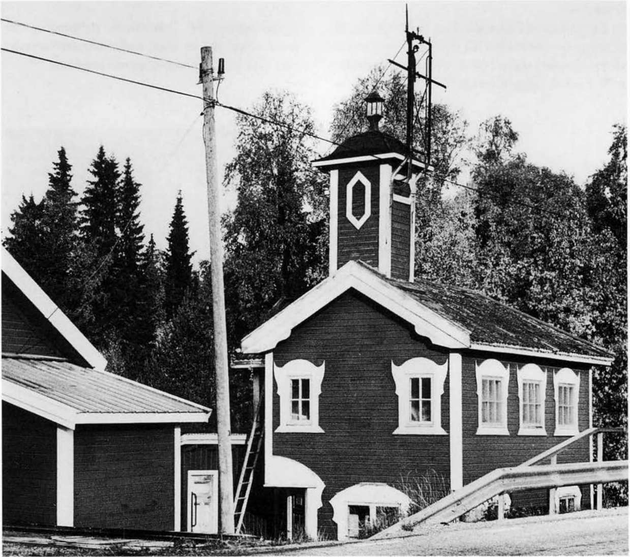
Det fantasifullt utformade maskinhuset vid Hovermo övre kraftverk. Lanternan uppe på utledningstornet informerar den närboende ägaren om drifttillståndet. BS 1992.
