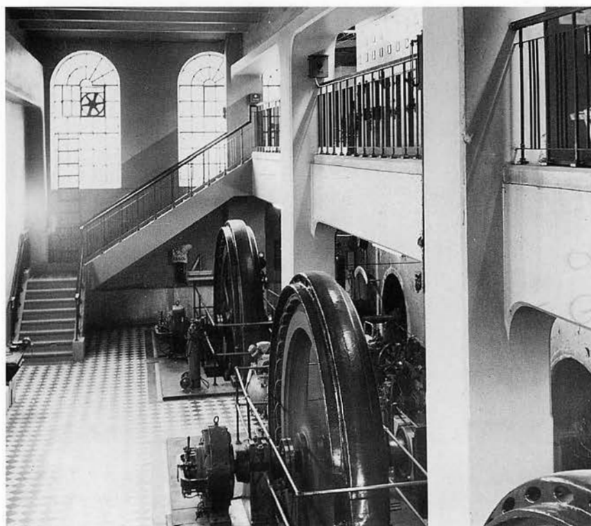
Maskinhallen i Drags kraftstation med tre stora, långsamgående generatorer samt manöverbalkong. BS 1989.
