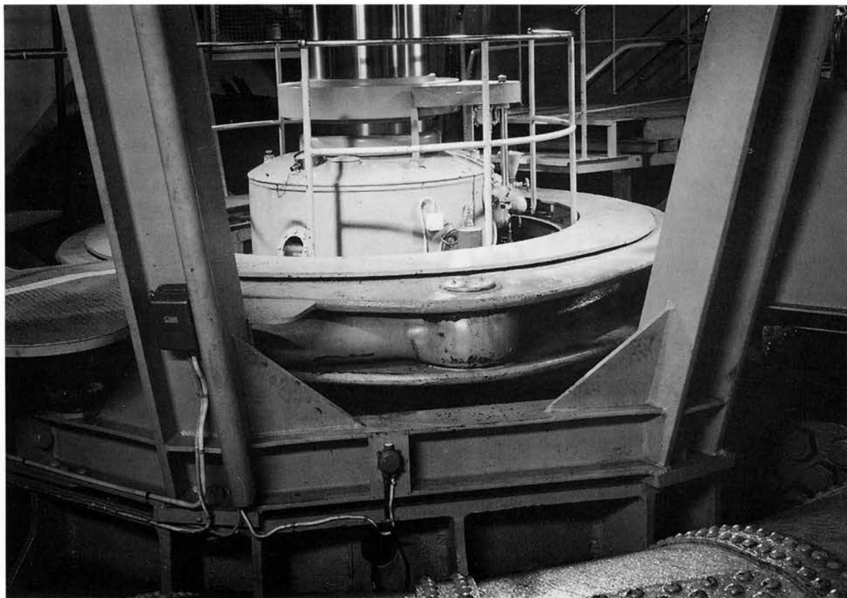
Axelbrunn i Krångede II:s kraftstation med nitad turbinspiral av stål, snedställda stöttor för överföring av aggregat- och vattenlast mot turbinfundamentet, reglerring samt turbinaxel. BS 1992.
