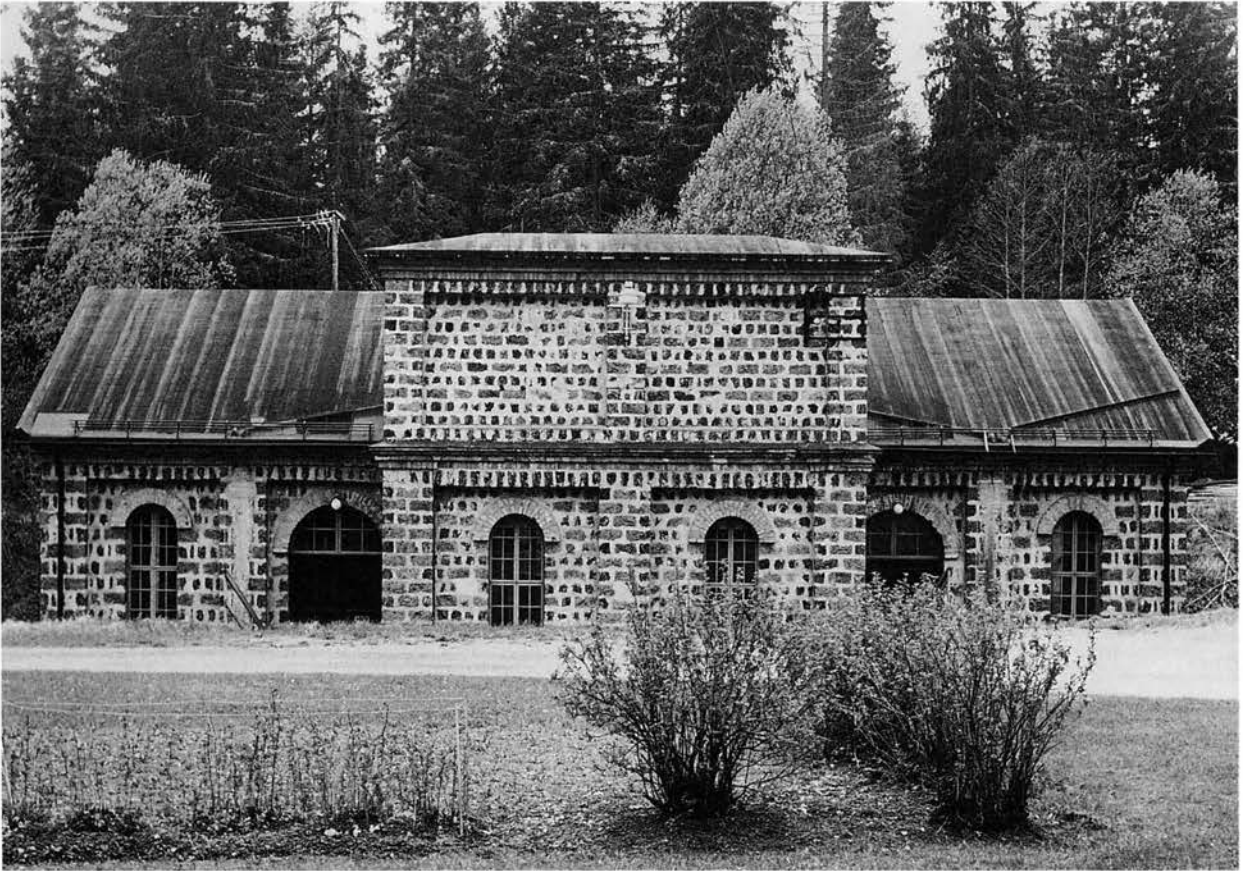
Dammfallets kraftstation. Tubingång vid högra gaveln och drivvattenutlopp vid vänstra. Mittutbyggnaden tillkom 1916 vid ombyggnad av ställverket. BS 1993.
