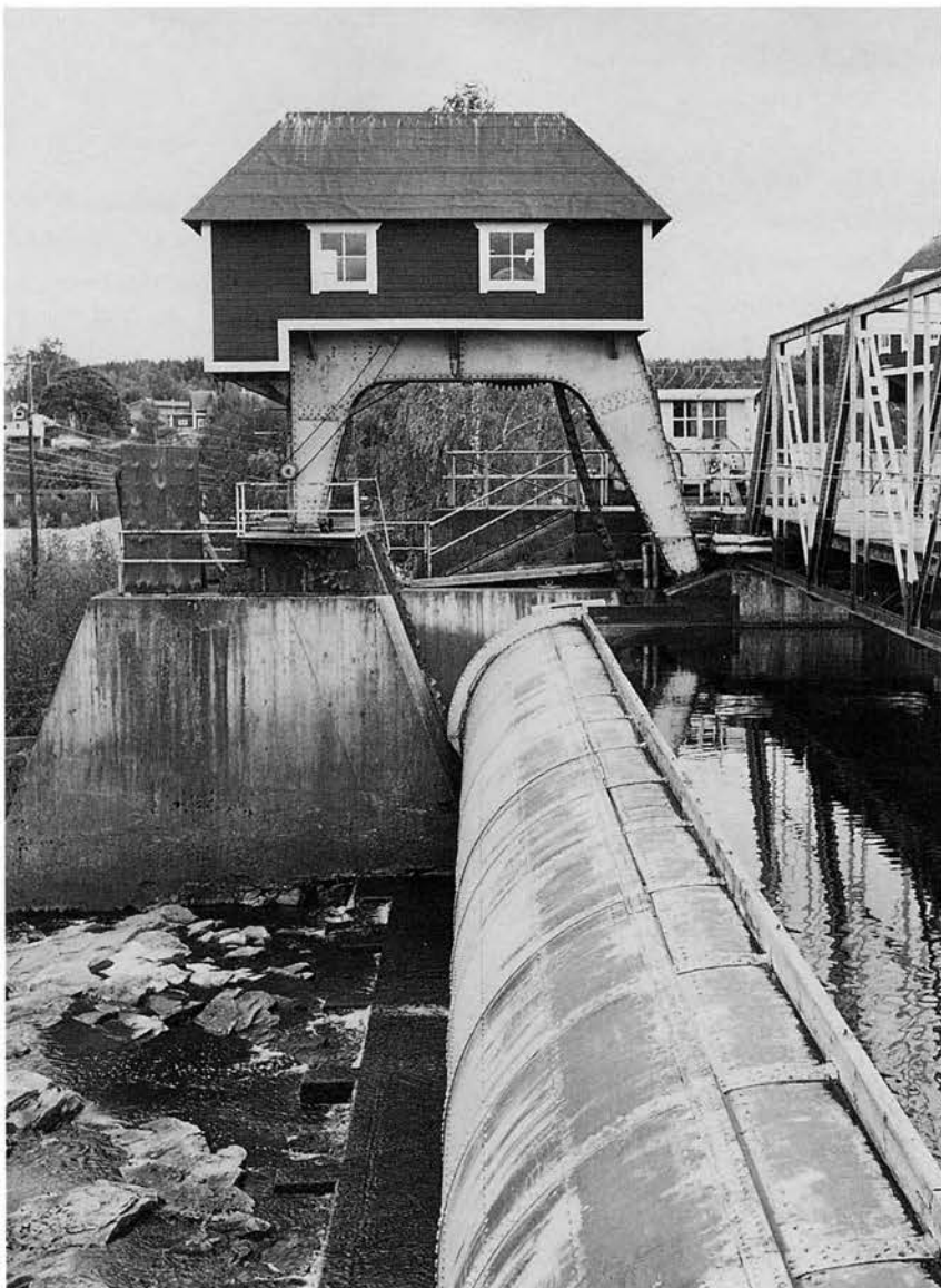
Den ena av de två stora sköldvalsarna i kraftverksdammen vid Dejefors. Valsarna manövreras med grova kedjor från spelbocken med dess karaktäristiska spelhus. BS 1991.
