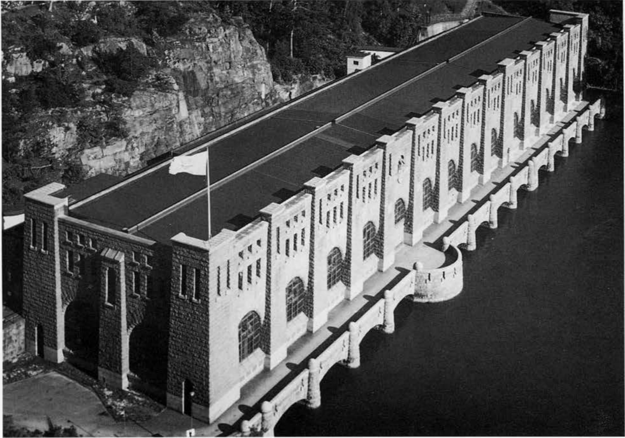
Olidans kraftstation i Trollhättan fotograferad från Kopparklinten. På taket syns skarvar efter 5:e och 9:e fasadsektionerna, vilka markerar de tre byggnadsetapperna. BS 1993.
