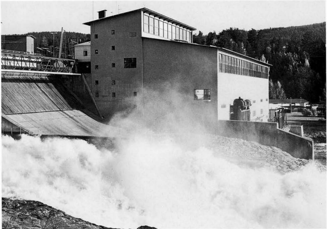
Hammarforsen I:s kraftverk med frivattentappning. I kraftstationens högre uppströmsdel finns ställverket medan maskinhallen inryms i den lägre nedströmsdelen. Observera maskinhallsgavelns utsiktsbalkong mot dammen. BS 1992.
