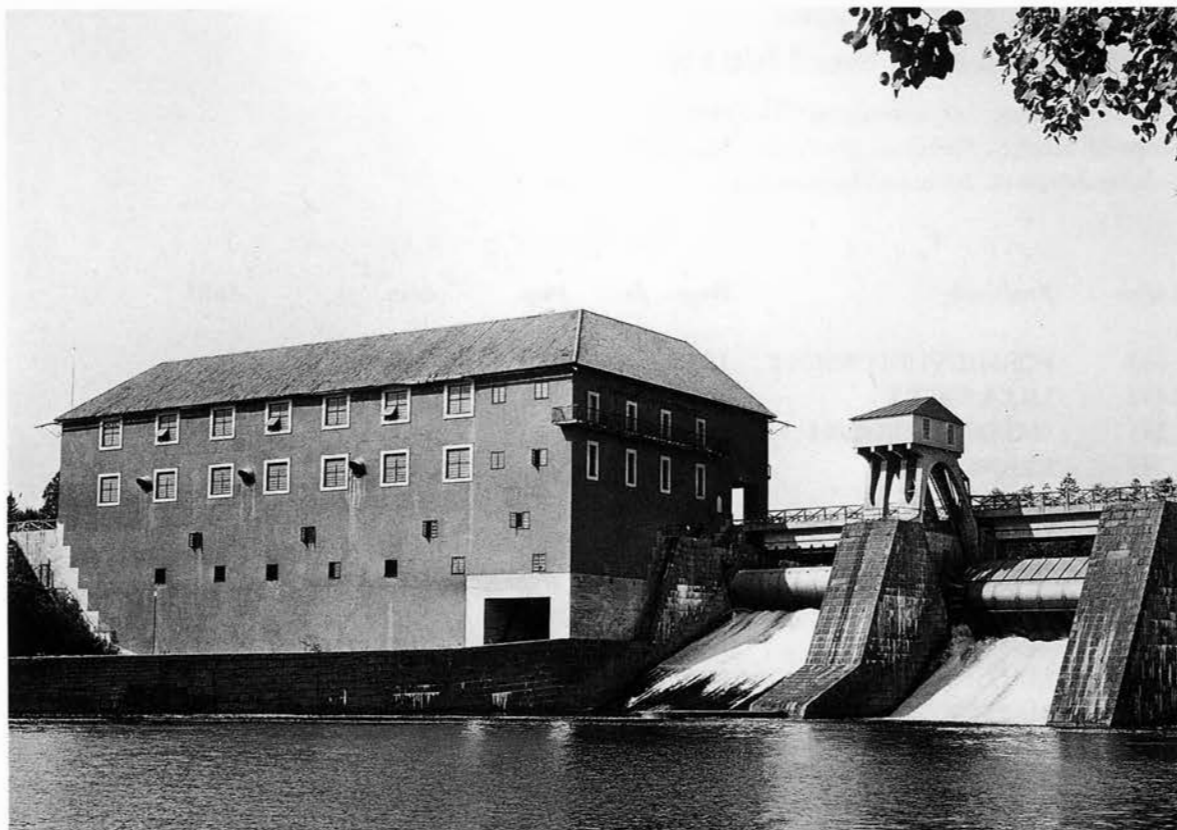
Nedströmsvy över Forshuvudforsen I:s kraftverk. Dammöppningarna stängs med valsar, på bilden syns två av dessa med tillhörande spelhus. BS 1978.
