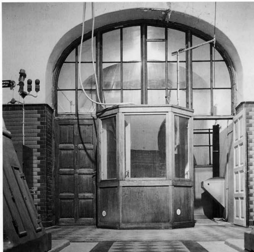
Entrépartiet i maskinhallen från den lutande nedfartsbanan i Mockfjärds kraftstation. BS 1992.
