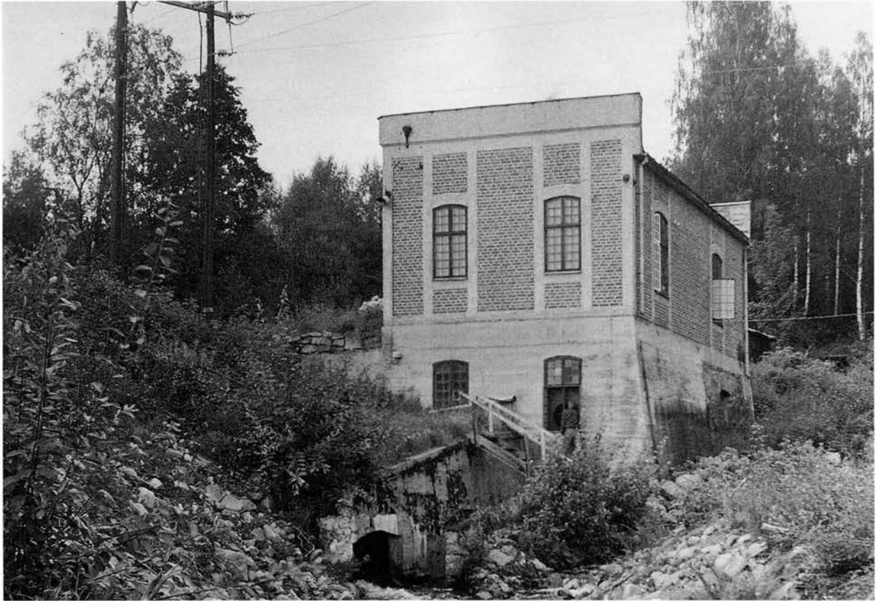
Perseruds kraftstation från nedströmssidan. BS 1980.
