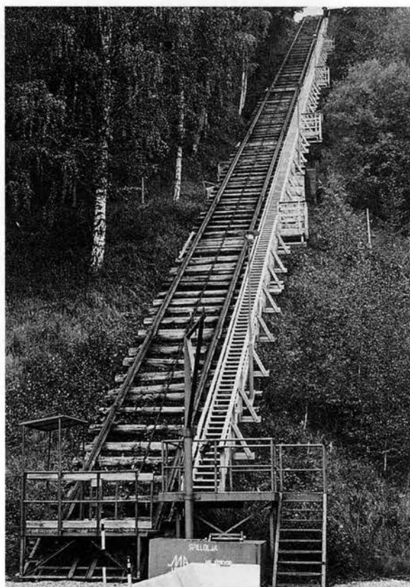
Transportbanan i älvbrinken vid Sillre var den enda tillträdesvägen till kraftstationen innan en väg byggdes vid mitten av 1980-talet. BS 1992.
