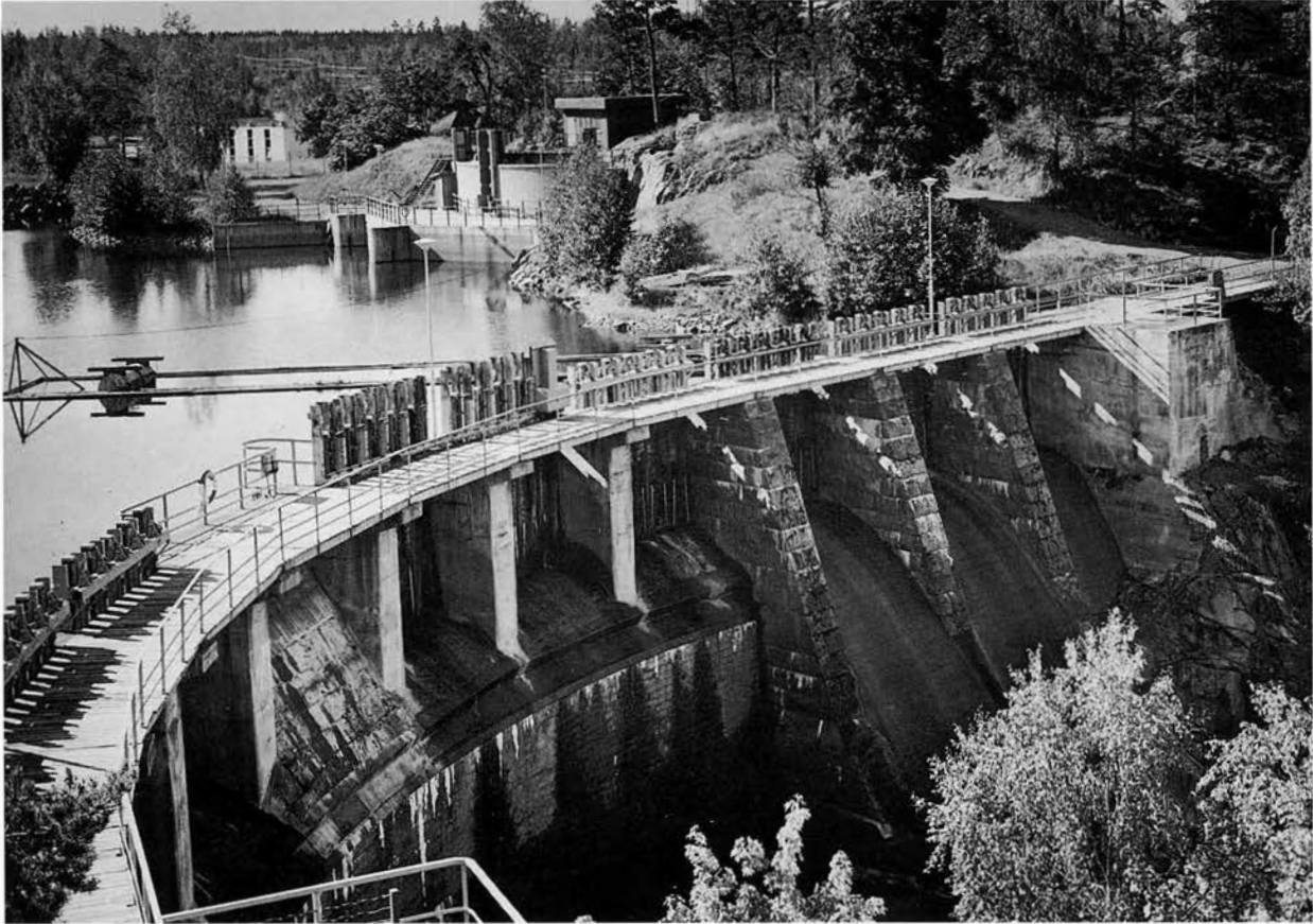
Gullspångs kraftverks valvdamm med mängder av små spetluckor. BS 1978.
