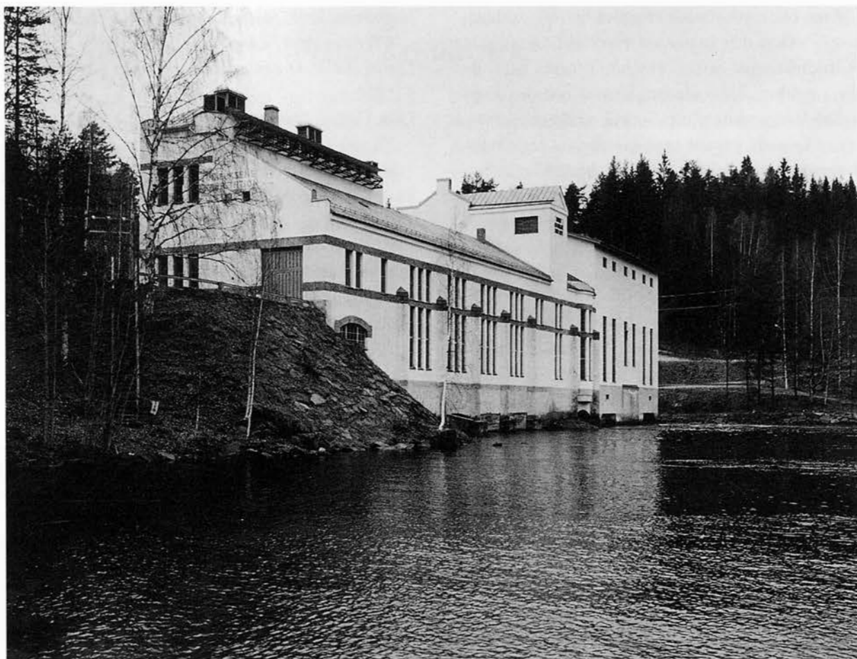
Den mångfacetterade kraftstationen Finnfors I i förgrunden och den enklare Finnfors II i fonden; en ståtlig och välbevarad kraftverkssensemble med få motsvarigheter i landet. LB 1992.
