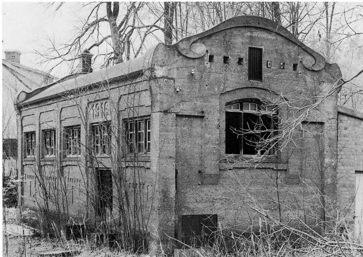
Överums nedre kraftverks maskinhus, helt av betong. BS 1979.
