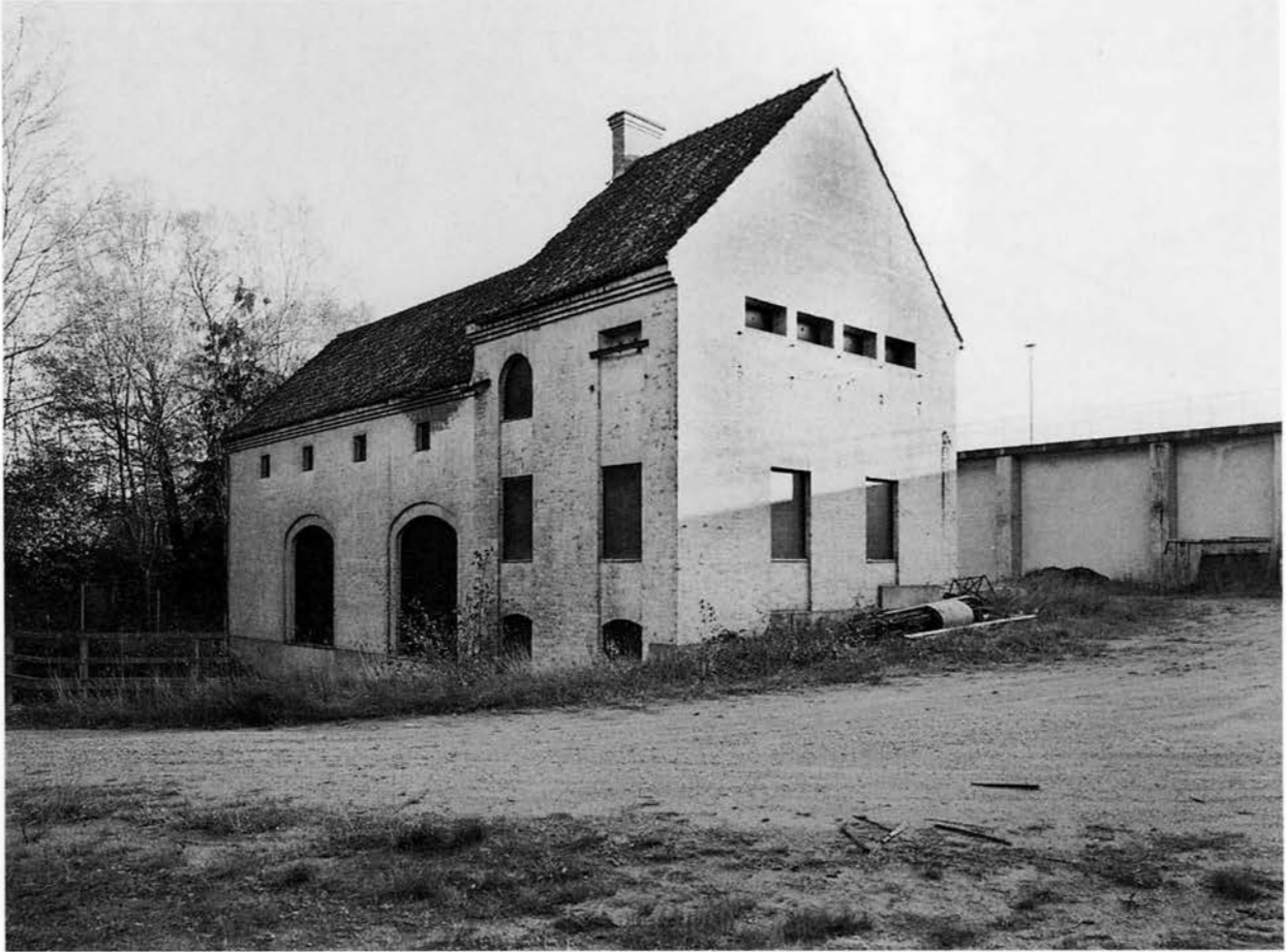
Den övergivna Knutsbro II:s kraftstation med ställverket närmast och maskinhallen i fonden. LB 1991.
