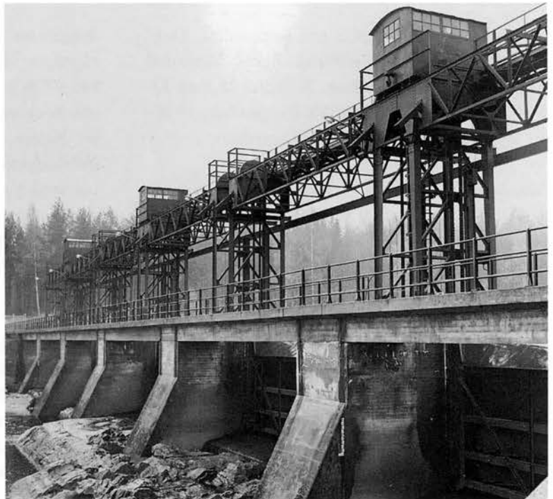
Mängder av Stoneyluckor vid den ena av Lanforsens kraftverks bägge regleringsdammar. BS 1992.
