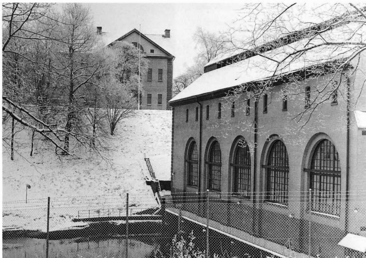
Motala kraftverks ställverksbyggnad och maskinhus. BS 1979.
