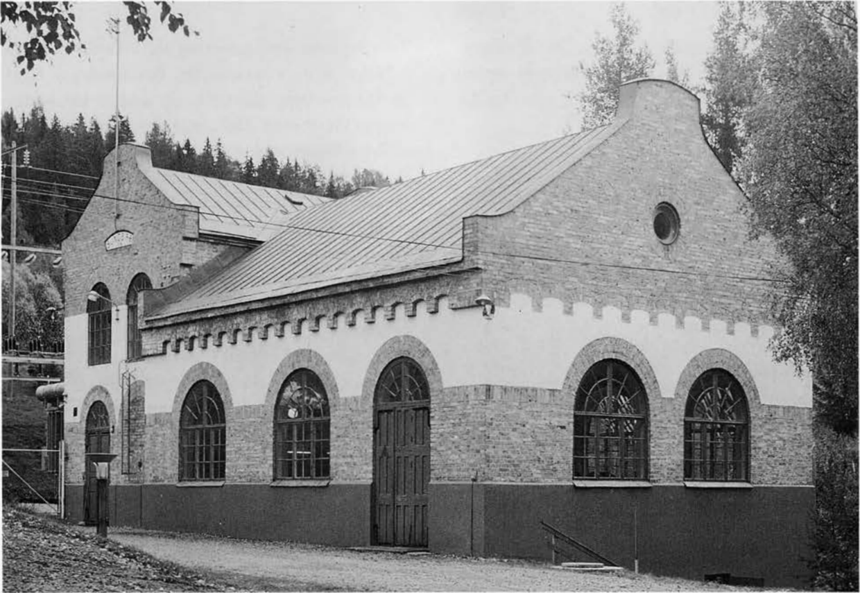
Maskinhuset vid Rundbackens kraftverk har inte förändrats mycket sedan det byggdes. Byggherrens namn kan fortfarande avläsas uppe på ställverkstornets gavel. BS 1992.
