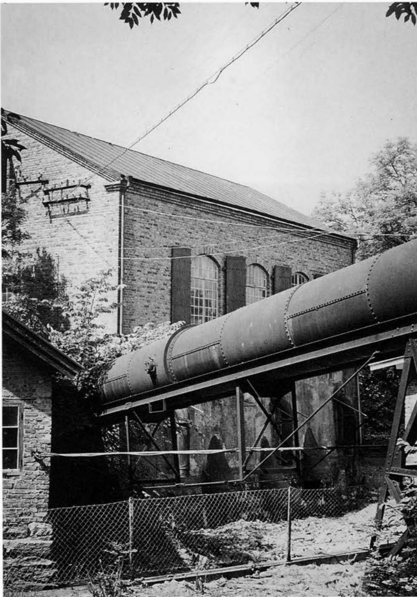
Tollereds övre kraftstation ligger inne bland den övriga industribebyggelsen. I förgrunden ståltuben upplagd på en vagg. I maskinhusets sockel mynnar de tre snedställda sugrören i den numera tömda utloppsässängen. BS 1982.
