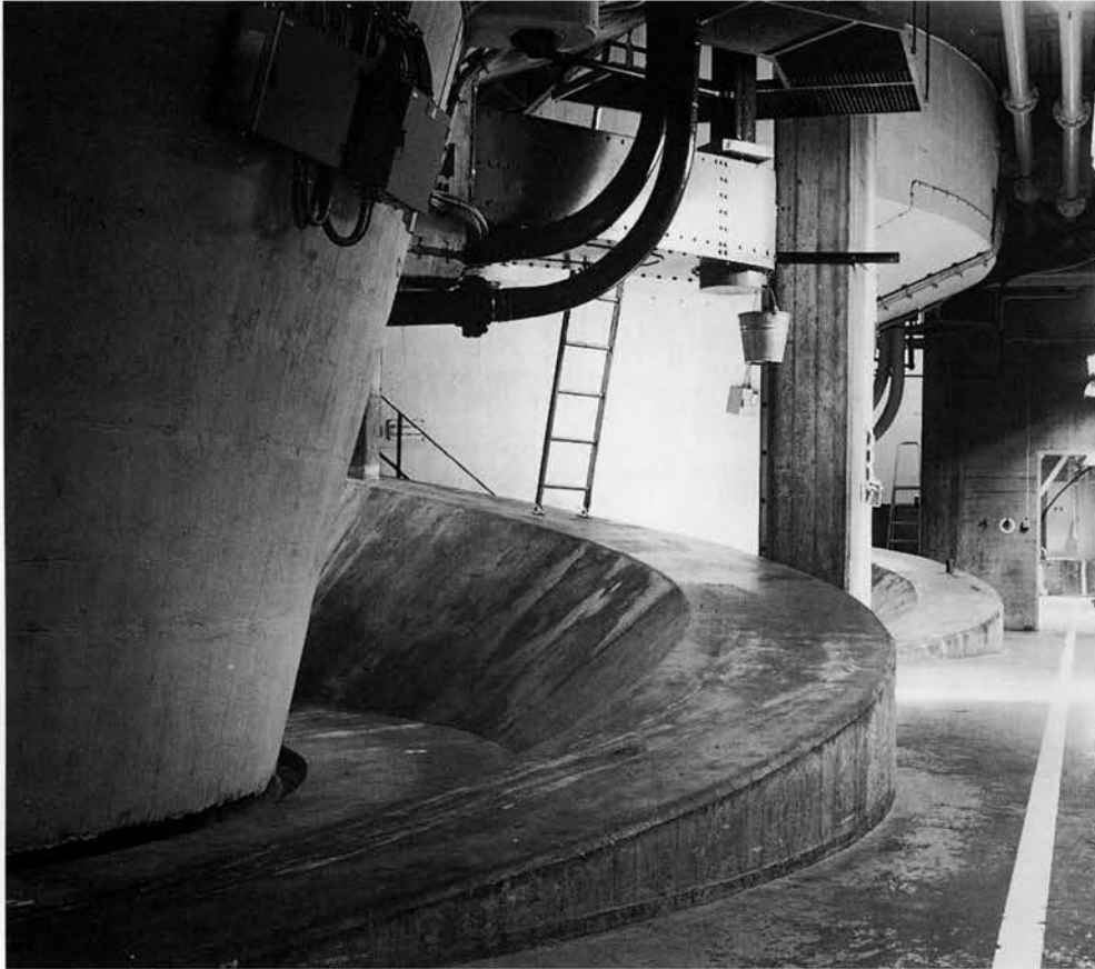
Överdelen av de betonggjutna och spiralformade vattentilloppen till en av turbinerna i Hammarforsen I:s kraftstation. Betongkonen ovanför spiralen omsluter axelbrunnen mellan turbin och generator. BS 1992.
