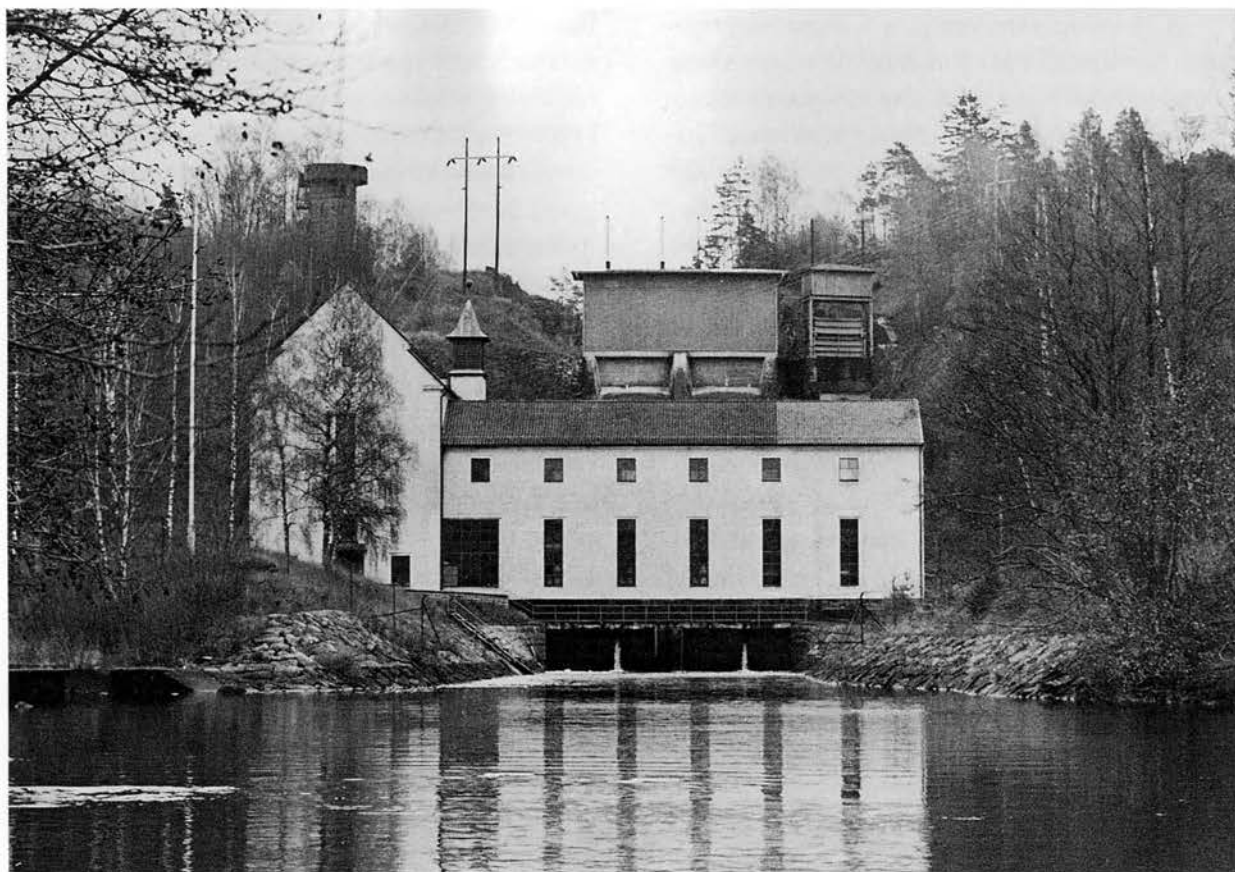
Ätrafors II:s kraftstation från nedströmssidan. Byggnaderna uppe i slänten bakom maskinhallen är tubintagen. Av bilden framgår omfattningen av 1947 års tillbyggnad (högra tubintaget och högra delen av maskinhallen). BS 1976.
