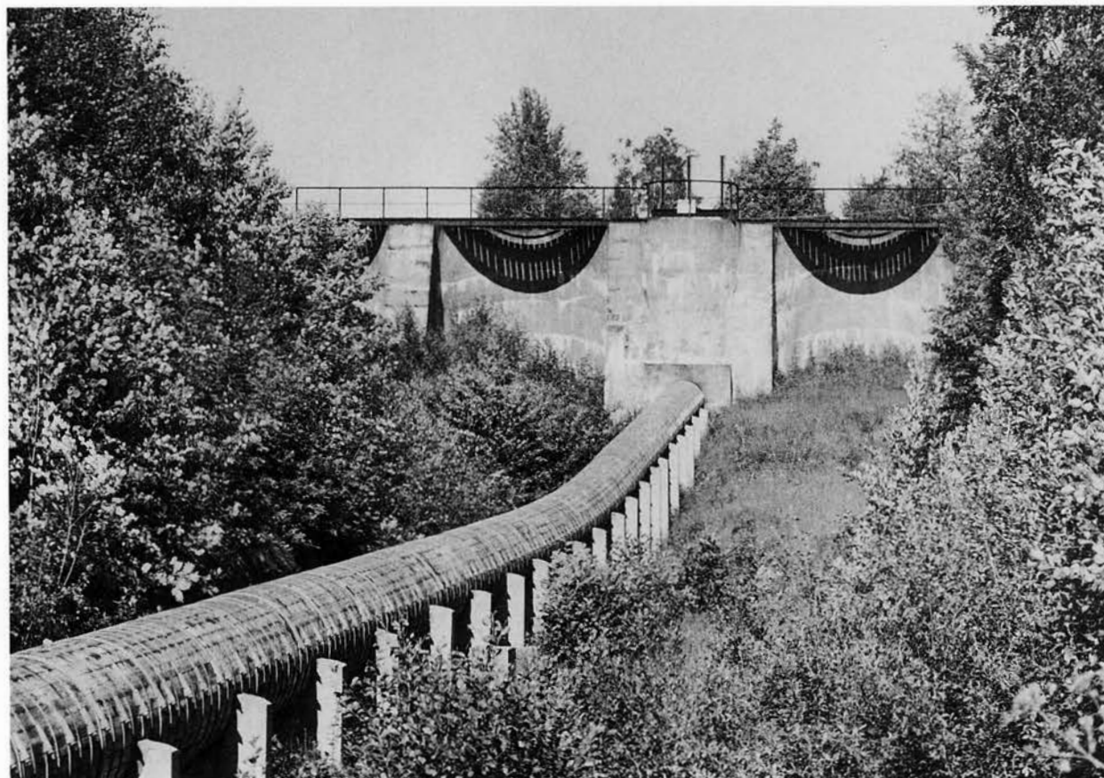
Serievalvdamm och trätub vid Melby kraftverk. Två av de små valven syns på ömse sidor om tubintaget. BS 1979.
