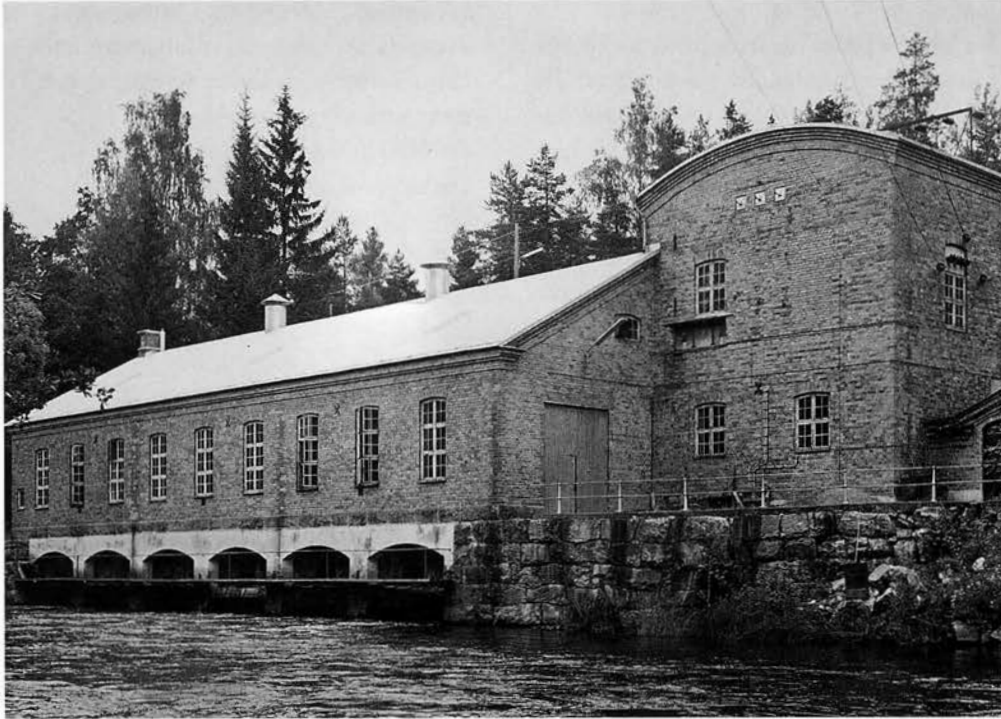
Trångfors kraftstation från nedströmssidan. Ställverkstornet till höger uppfördes vid ombyggnaden 1912. BS 1980.
