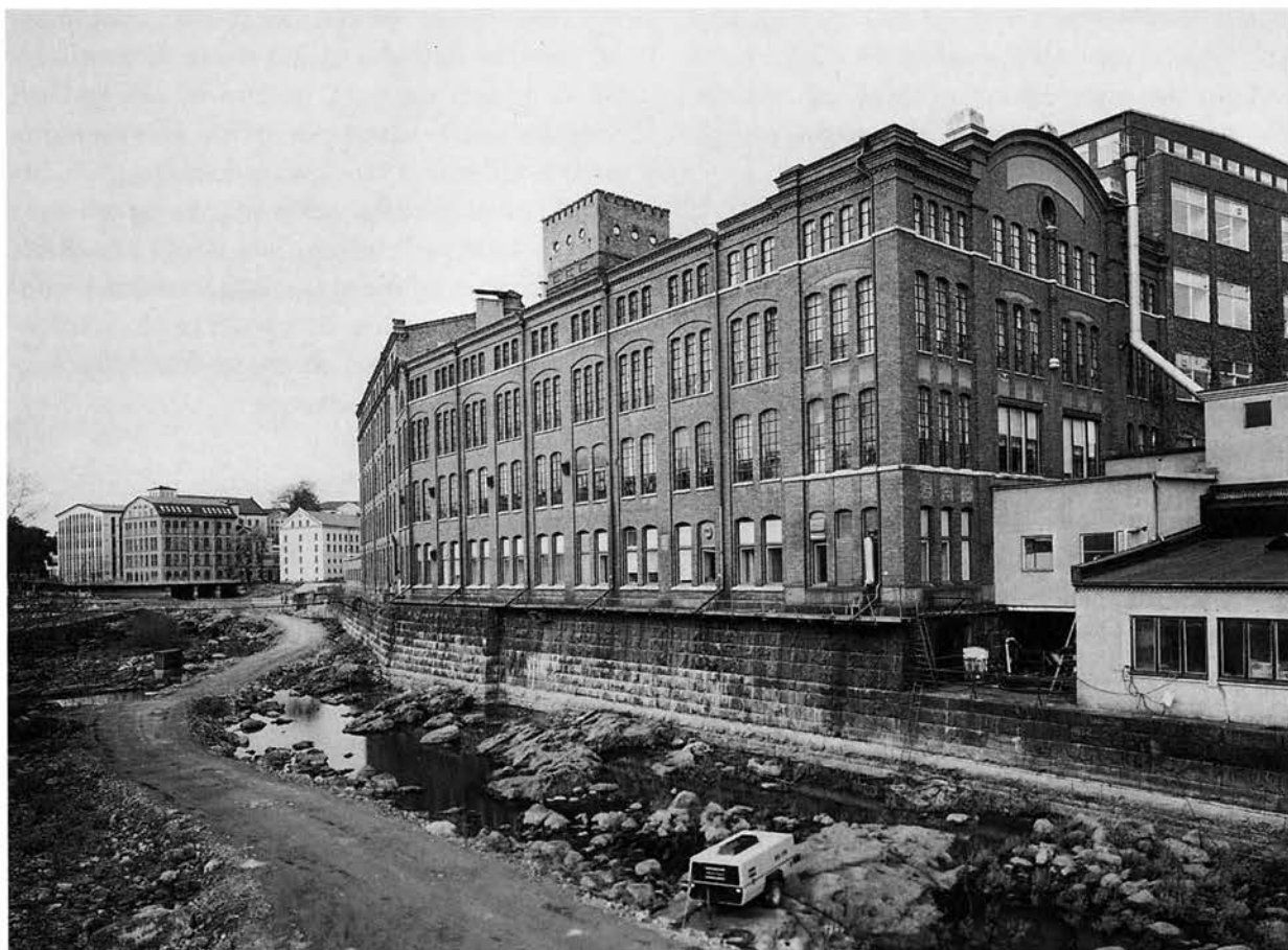
F.d. Bergsbro yllefabrik och kraftstation vid den för tillfället torrlagda Strömmen i Norrköping. Byggnaden grundlades på en mäktig granitmur som inrymde själva kraftstationen. I fonden f.d. Drags fabriker. LB 1991.
