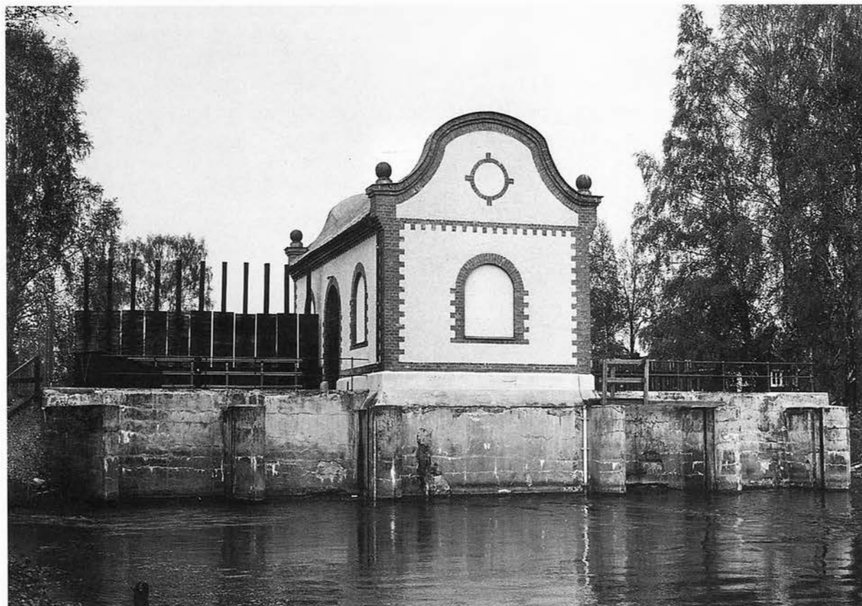
Korsnäs kraftstation från nedströmssidan med turbinsumpar på båda sidor om maskinhuset. BS 1993.
