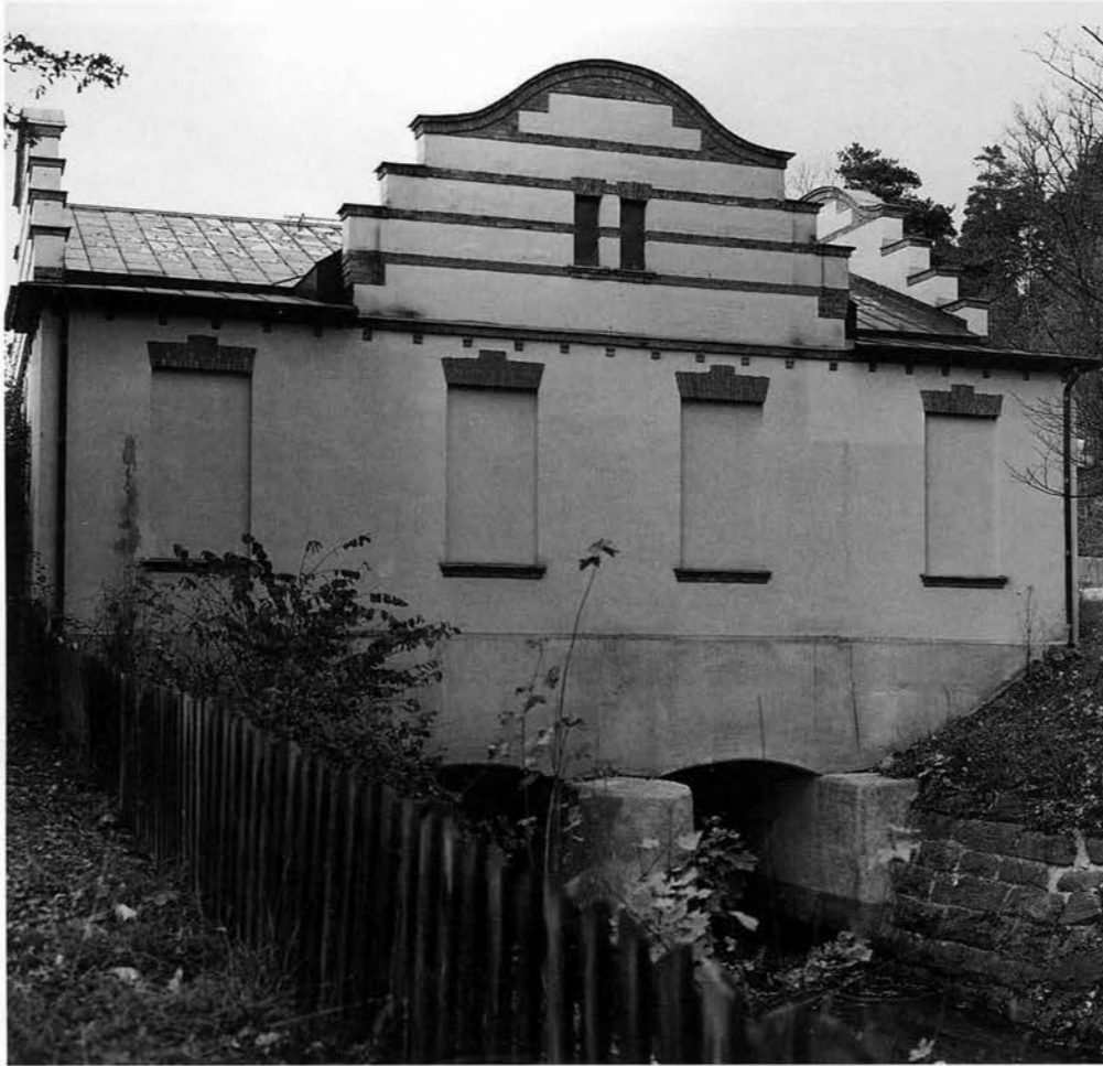
Nedströmsfasaden till Finspångs kraftstation med de magnifika trappstegsgavlarna. De igenmurade fönstren kommer förhoppningsvis snart åter att öppnas. LB 1991.
