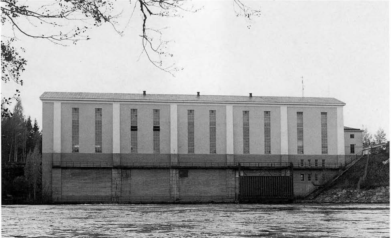
Lanforsens kraftstations ståtliga nedströmsfasad. BS 1992.
