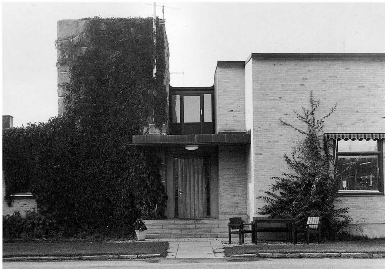
Entrépartiet till Hjälta kraftstation. BS 1992.
