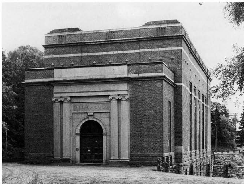
Det storslagna entrépartiet till Karsefors kraftstation. BS 1989.
