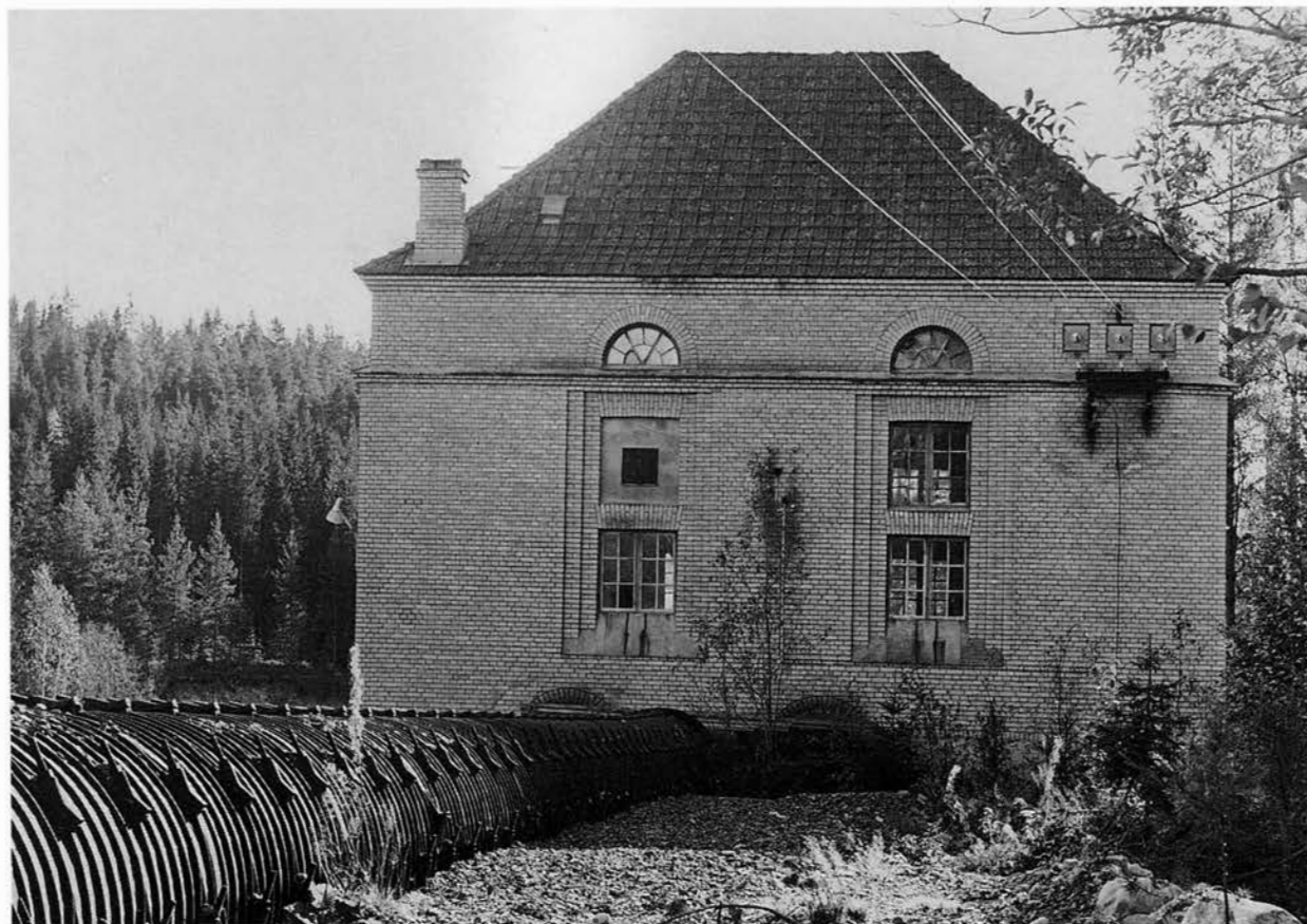
Högborgsforsens kraftstation från uppströmssidan. BS 1979.
