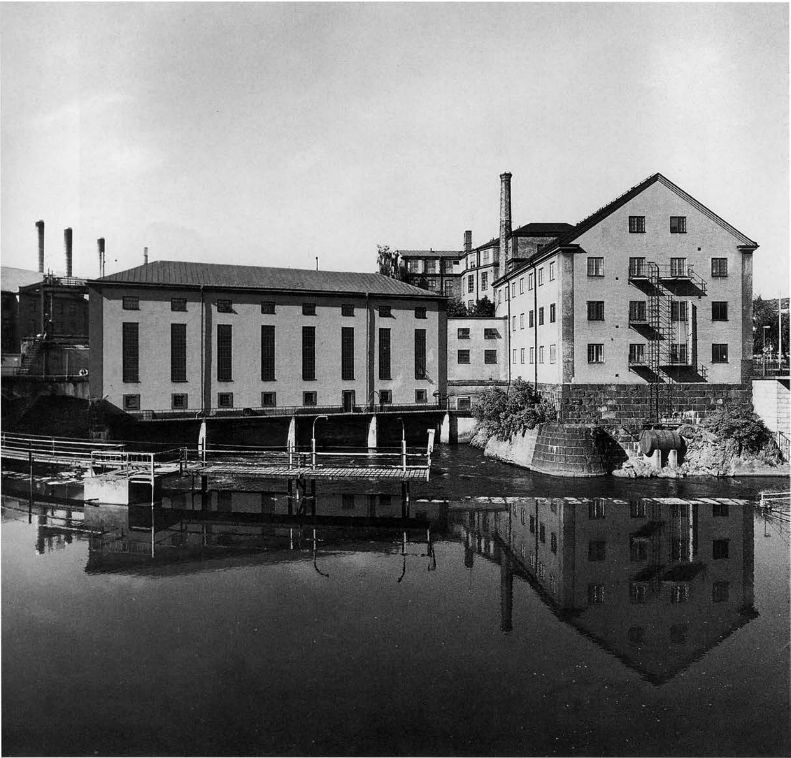
Bergsbron-Havets kraftstation från nedströmssidan med ställverksbyggnaden till höger; en sällsynt vacker ensemble i Norrköpings stadsbild. Fasaderna är putsade i lejongult med omsvängda kornischer och lisener i en kontrasterande mörk grågrön ton. LB 1988.
