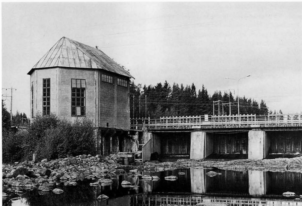
Silvergruvans kraftverk från nedströmssidan med det i kraftverkssammanhang ovanliga, strömlinjeformade maskinhuset. BS 1991.
