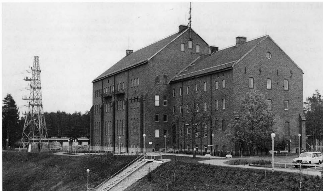
Det stora ställverkshuset vid Älvkarleby I:s kraftverk. I byggnadens hitre del finns kontrollrum och kontorsutrymmen. BS 1992.
