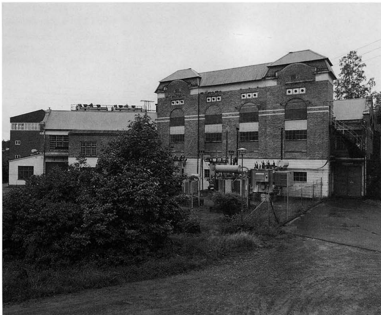
Dejefors kraftverk bildar ett konglomerat av byggnader från olika tidsepoker. I förgrunden det högsträckta inomhusställverket som delvis skymmer de långa, vinklade maskinhallarna. Notera skiffertaket som skymtar fram under det okänsligt lagda, skarpkantade trapetskorrugerade plåttaket. LB 1988.
