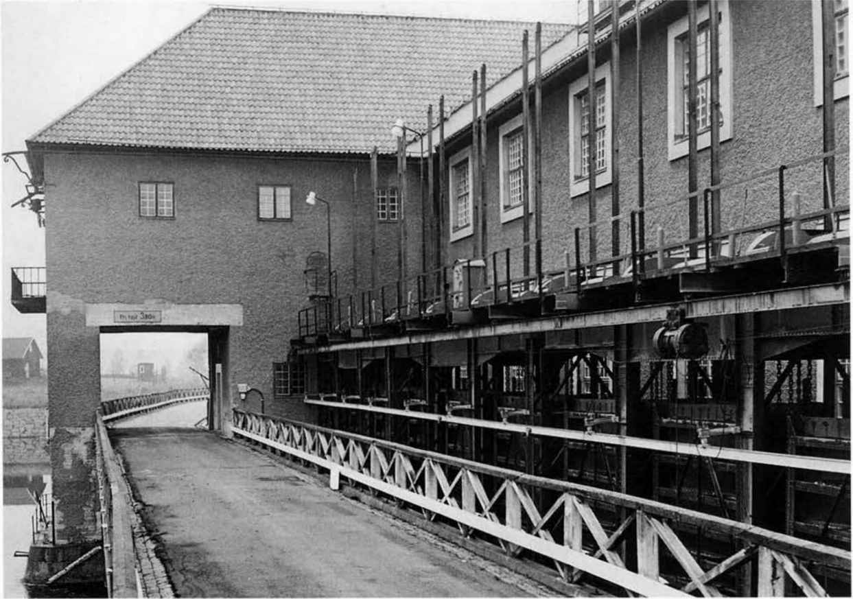
Uppströmsvy över Forshuvudforsen I med intagsluckor och dammbro. Varje turbinintag stängs med tre övre och tre nedre luckor. BS 1981.
