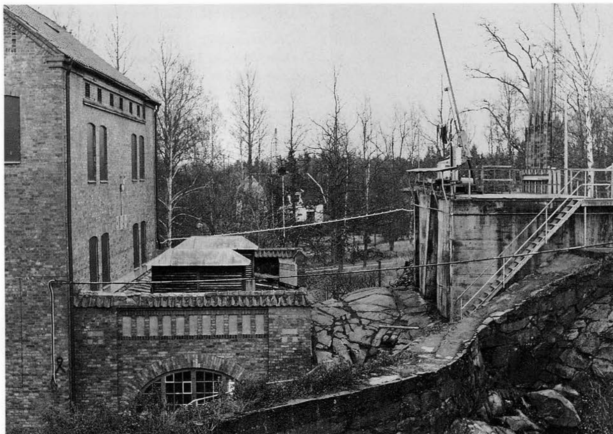
Kraftverket vid Hornsö. Till höger damm med intag och turbinschakt. I den lägre byggnadsdelen med ventilationshuvarna står generatorn och i den högre finns ställverket. BS 1990.
