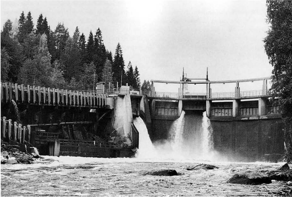
Valvdamm och fisktrappa vid Gideåbacka kraftverk. BS 1992.
