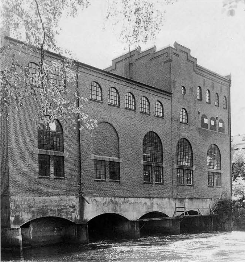
Bassalts kraftstation från nedströmssidan. Ställverket har tidigare funnits i den förhöjda byggnadsdelen. BS 1989.
