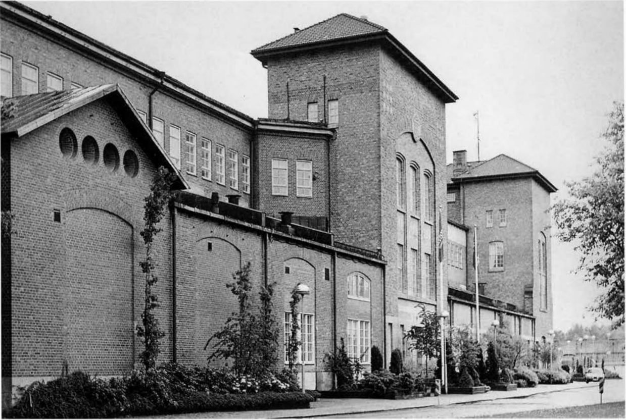
Olidans kraftstations ställverksbyggnad i Trollhättan. Sedan bilden togs har ett utvändigt hisschakt tillkommit vid det hitre tornet. BS 1991.
