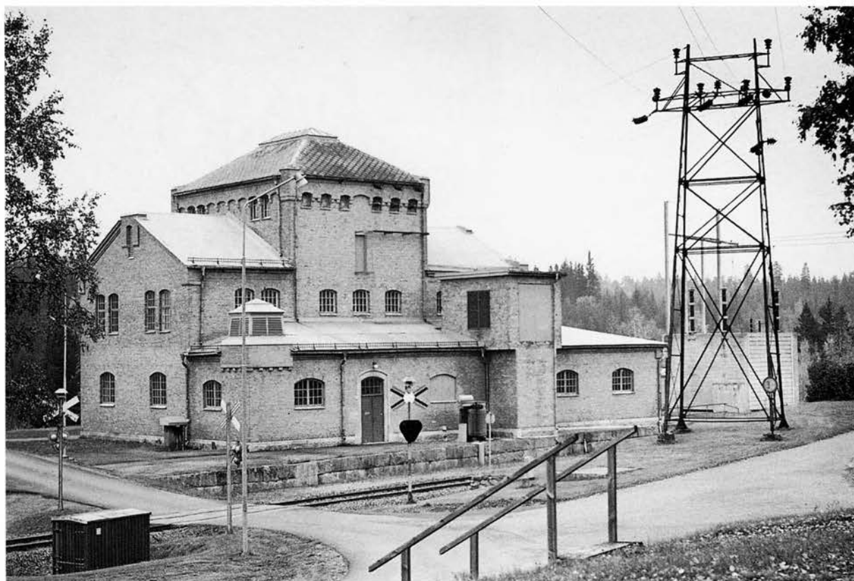
Ovanjordsbyggnaden vid Mockfjärds kraftverk. Nedfart till maskinsalen sker på en lutande bana från den närmast belägna lägre delen av byggnaden. BS 1981.
