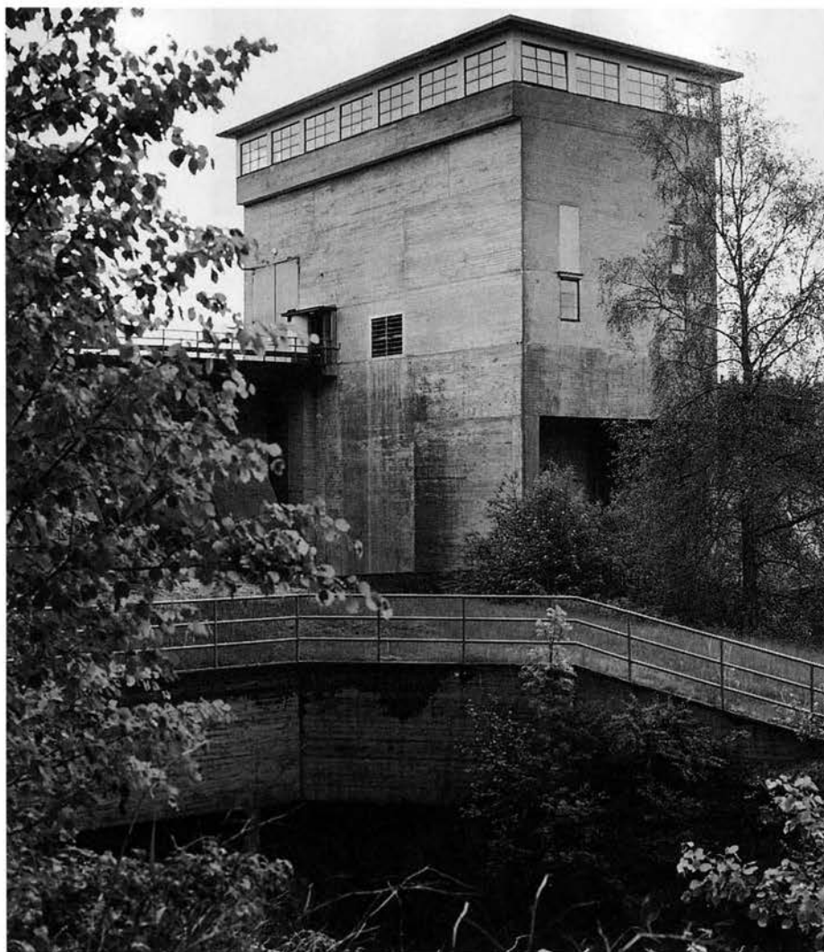
Kraftstationen för Skogsforsen I i gjuten råbetong reser sig majestätiskt, liksom blickande ut över omgivningarna. I förgrunden syns schakt för Skogsforsen II. LB 1989.
