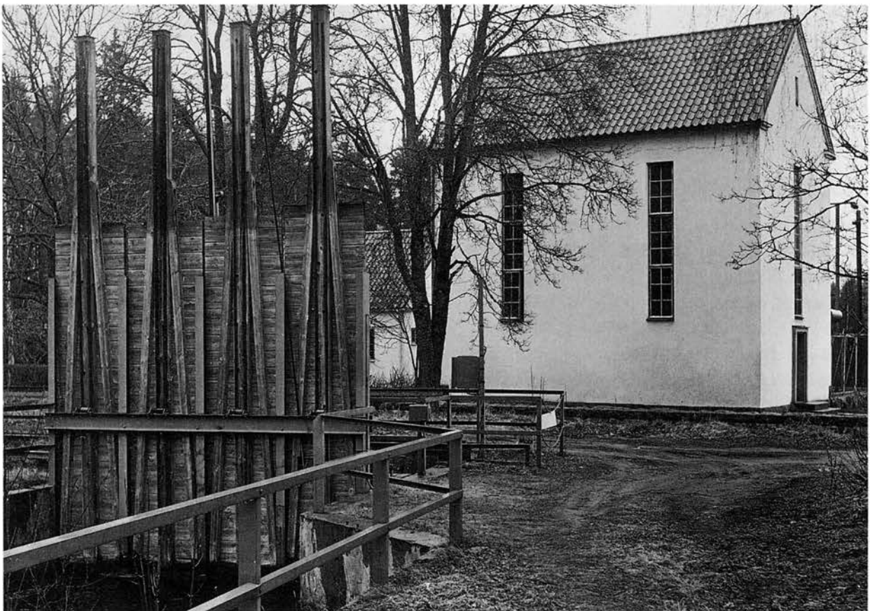
Turefors kraftverk med vattenintagets avstängningsluckor och maskinhuset. Till vänster skimtar den numera rivna personalbostaden. BS 1980.
