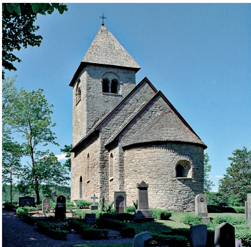
Fig. 71. De romanska stenkyrkornas kor är lägre och smalare än långhuset. Ungefär hälften av kyrkorna med smalare kor har haft absid i öster, som den lilla 1100-talskyrkan i Våmb i Västergötland. Ungefär lika vanligt har varit att de försetts med torn. Foto Bengt A. Lundberg 2002, ATA.
