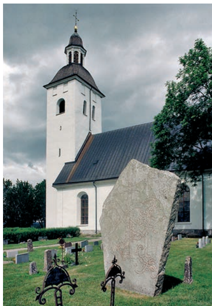
Fig. 80. I Norrland har torn inte varit vanliga i de medeltida kyrkorna. Ett undantag finns i Hälsingtuna i Hälsingland, där det höga romanska tornet varit ett riktmärke. Nischerna i den översta delen är i själva verket igensatta öppningar. Kyrkan har under en period varit försedd med ett torn också över sitt absidkor, men detta revs redan under senmedeltiden. Den nuvarande tornhuven är från 1700-talet. Foto Bengt A. Lundberg 2002, RAÄ.
