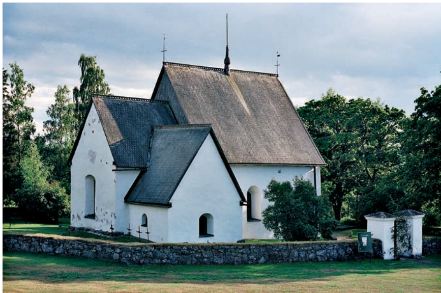
Fig. 73. Alnö gamla kyrka i Medelpad är ett troligen ganska sent exempel på en romansk kyrka med smalare, rakslutet kor och en av få som bevarats i Norrland. Sakristian tillhör sannolikt en senare byggnadsperiod. Taken är prydda av genombrutna takkammar, något som varit typiskt för Norrlands-kyrkorna och kan vara en medeltida tradition. Foto Bengt A. Lundberg 2002, RAÄ.
