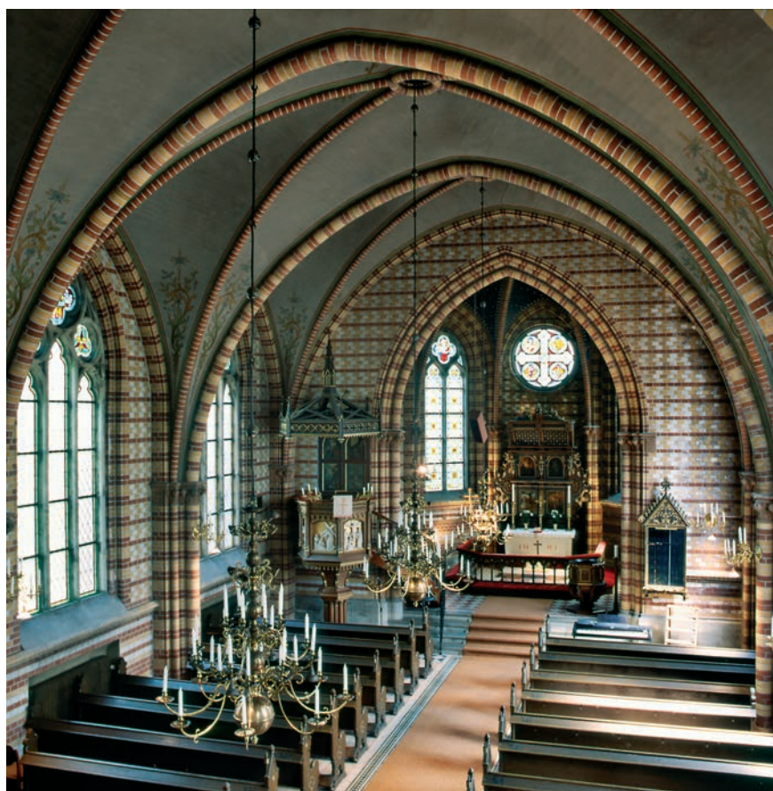
Fig. 165. Fuglie kyrka, Skåne, byggd 1902–04 som ersättning för en äldre kyrka som revs. Arkitekt var A. W. Lundberg. Kyrkans byggnadsmaterial, som maskinslaget tegel, cement, gjutjärn och fabriksnickrier avspeglar landskapets industrialisering. Altarrummets särställning är tydligt markerad. Stämningen som skapas genom den rika färgsättningen och dekoren ska ge en vision av kyrkorummet som förgård till himmelriket. Foto Göran Lindahl 2003.
