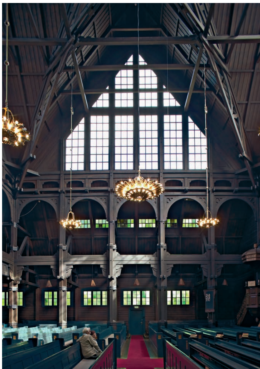
Fig. 159. Kiruna kyrka byggdes av gruvbolaget LKAB 1909–12 för det gruvsamhälle som växt upp i Jukkasjärvi socken i norra Lappland. Arkitekten Gustaf Wickman skapade på en kvadratisk grundplan (se fig. 162) ett kyrkorum som rikt utnyttjat träets konstruktiva möjligheter. Kyrkan är inspirerad av samiska kåtor och norska stavkyrkor. De sakrala och traditionella kyrkliga symbolerna är få men stämningsvärdena höga. Foto Bengt A. Lundberg 2006, RAÄ.
