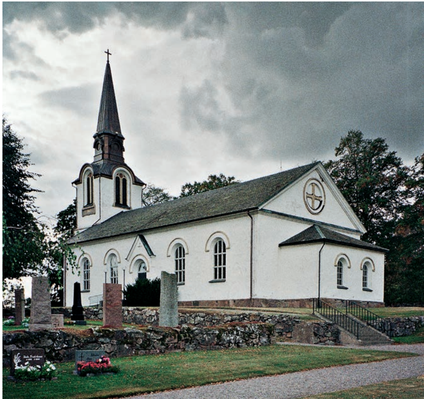
Fig. 163. Kvänums kyrka, Västergötland, byggd 1867 en kilometer från den gamla kyrkan som revs. Likt många kyrkor från 1800-talets andra hälft kan den beskrivas som en till grundformen nyklassicistisk kyrkotyp med rikare och delvis medeltidsinspirerade arkitekturdetaljer. De senare tillade Axel Nyström vid Överintendentsämbetet till den ritning kyrkobyggmästaren Fredrik Bergström uppgjort åt församlingen. Kyrkan byggdes av en annan ofta anlitad kyrkobyggmästare från Västergötland, Anders Pettersson i Vårsås. Foto Jakob Lindblad 2002, SvK:s arkiv, RAÅ.
