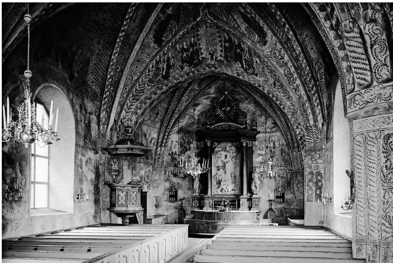
Fig. 89. Många senmedeltida kyrkor fick sin prägel av nyinslagna tegelvalv. Typiskt för den senare delen av 1400-talet är olika varianter av stjärnvalv, som här i Edebo kyrka i Uppland. Ofta dekorerades kyrkan samtidigt med kalkmålningar på väggar och valv. Kyrkan i Edebo fick sina målningar vid 1500-talets början. Predikstolen och altaruppsatsen är från 1700-talet. Foto Nils Lagergren 1954, ATA.
