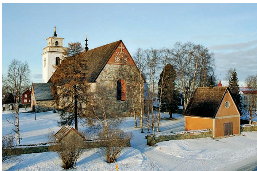
Fig. 86. De sena salkyrkorna från 1400-talet och det tidiga 1500-talet har vanligen gavlar utsmyckade av tegelblinderingar. Den ovanligt stora kyrkan i Nederluleå i Norrbotten är ett av flera norrländska exempel på detta. Typiskt för den sena medeltiden är också ett vapenhus framför sydportalen. I bakgrunden står ett murat klocktorn från 1800-talets mitt. Foto Gabriel Hildebrand 1996, ATA.
