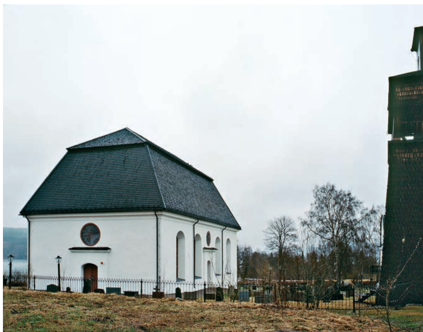
Fig. 133. Attmars kyrka i Medelpad uppfördes 1760–62, delvis med återbruk av den medeltida föregångarens murar. Den som utförde ritningarna var Daniel Hagman, som likaså var byggmästare. Till sin hjälp hade han gesällerna Pehr Hagmansson och Simon Geting. Söder om kyrkan står en klockstapel som i sin nuvarande utformning härrör från 1811. Foto Göran Lindahl 1997.
