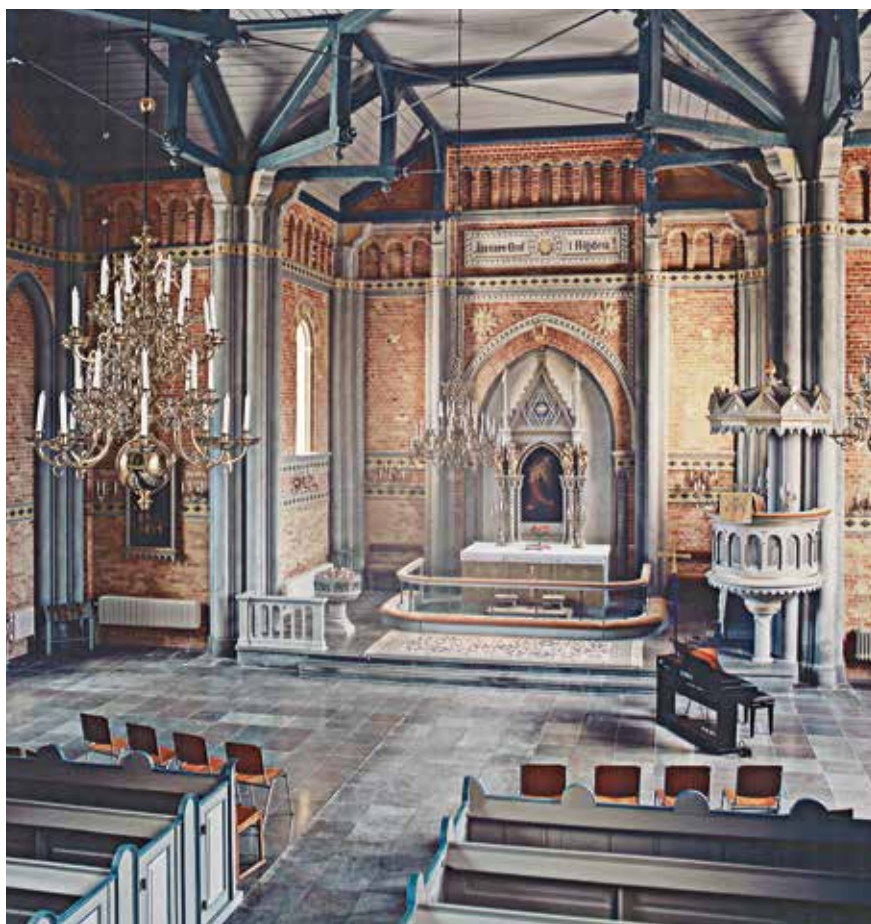
Fig. 124. Borlunda kyrkas interiör är lika nydanande och unik som exteriören. Taket bärs av träpelare med synlig takstol i ett intrikat mönster. Altaruppsats och predikstol i nygotik. Foto Göran Lindahl 2003.
