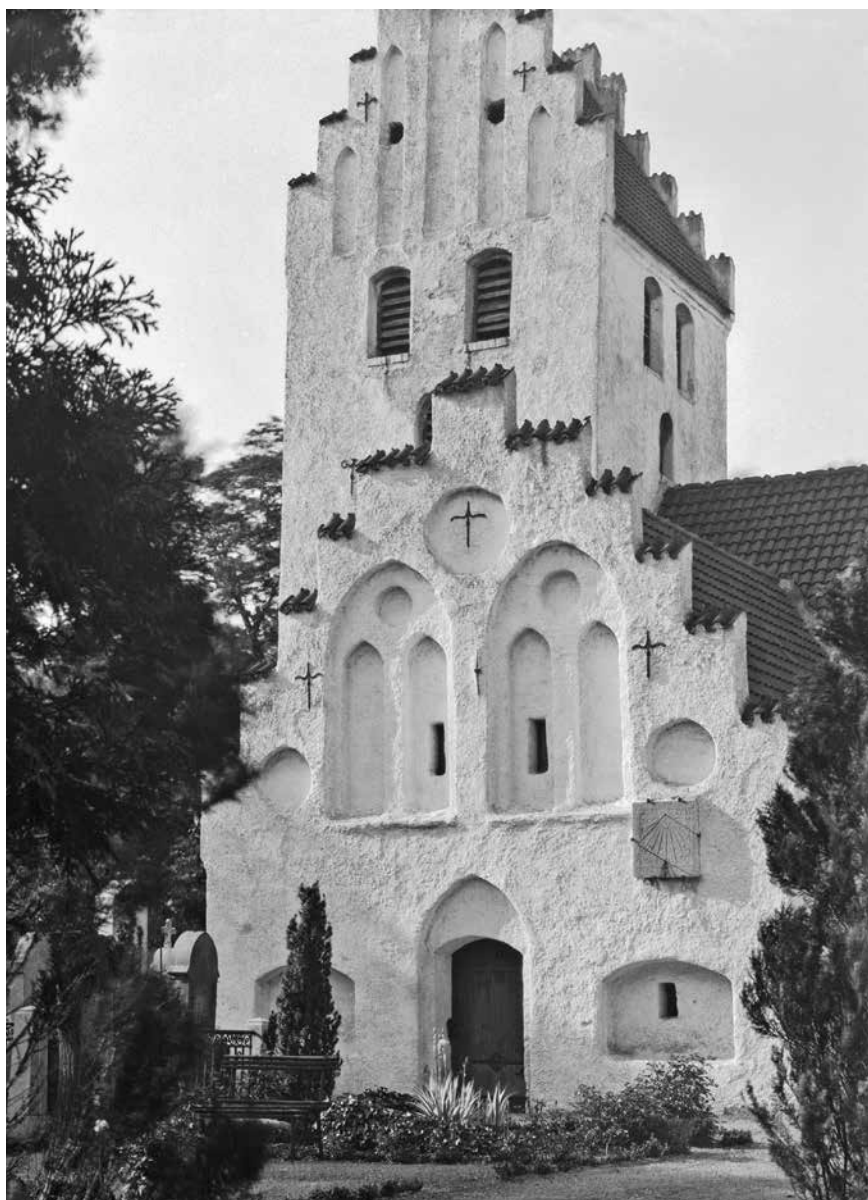
Fig. 70. Vapenhuset framför sydportalen i Burlövs kyrka har trappgavel och rikt utformade blinderingar i flera nivåer. I sin nuvarande utformning härrör vapenhuset från medeltidens senare del, men i murarna ingår delar av ett mindre vapenhus troligen från 1200-talet eller 1300-talets första hälft. Äldre foto i ATA.
