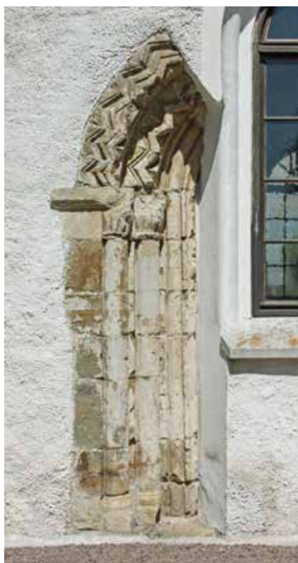
Fig. 37. Sydportalen i Saxtorps kyrka. På den kraftigt ombyggda kyrkans sydsida finns rester kvar av den skulpturalt utsmyckade romanska portalen. I portalens två yttersta språng bär kolonnetter sicksackformade arki-volter av en utformning som tyder på anglo-saxiska eller anglo-normandiska influenser. Foto Mattias Karlsson 2011.
