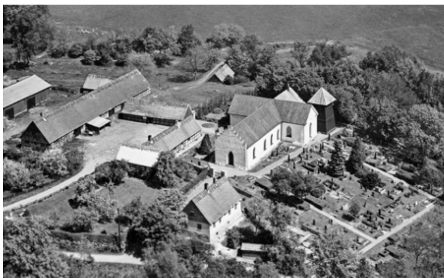
Fig. 3. Raus kyrka i Nordvästskåne, söder om Helsingborg. Kyrkan ligger avsides, ett stycke utanför övrig bebyggelse och i en sluttning ner mot Råån. I kyrkans närhet finns ett flertal välhållna äldre byggnader, däribland klockstapel och skola. Av den ursprungligen absidförsedda romanska kyrkan återstår långhuset i väster. Kyrkan förlängdes i väster under senmedeltiden och ombyggdes till korskyrka 1840. Kyrkan ingår i riksintresseområdet Rååns dalgång. Foto RAÄ.
