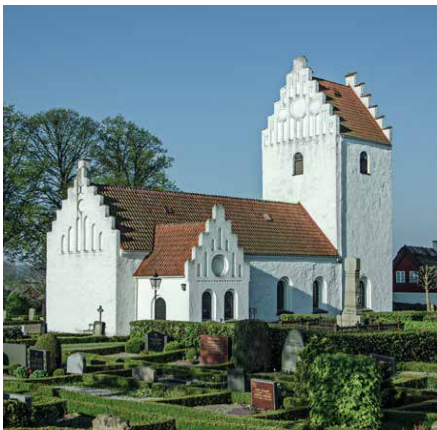
Fig. 67. Gödelövs kyrka från nordost. Från den romanska kyrkan återstår långhuset. Det ursprungliga koret revs vid en ombyggnad under medeltidens senare del, då kyrkan förlängdes österut och fick ett rakslutet korparti av långhusets bredd. Foto Per Blomberg 2008.
