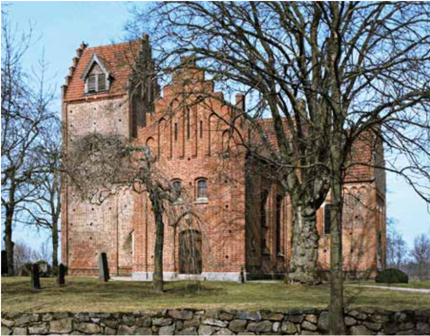
Fig. 27. Gumlösa kyrka från söder. Kyrkan invigdes enligt ett nu förlorat dokument 1191 eller 1192 och bestod då av långhus, rakslutet kor i öster och torn i väster. Kyrkan uppfördes av tegel i alla delar, men med inslag av natursten i vissa arkitektoniska detaljer. Såväl kyrkorum som torn försågs med samtida tegelvalv. Korsarmen på långhusets sydsida tillbyggdes 1904–05. Foto John-Eric Gustafsson 1978, RAÄ.
