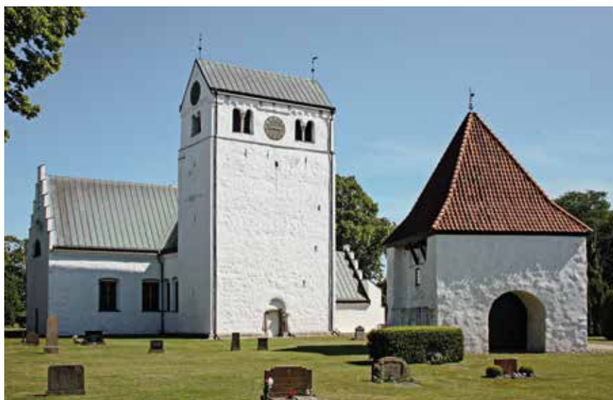
Fig. 47. Fjälkinge absidkyrka uppfördes under 1100-talet med ett samtida torn i väster, bredare än långhuset. Såväl västportal som ljudöppningar är ännu bevarade. De sentida tilläggen består av ett senmedeltida vapenhus på långhusets sydsida och en korsarm i norr från 1763. Väster om kyrkan finns en större stenbyggnad med oklar funktion och datering. Foto Mattias Karlsson 2011.
