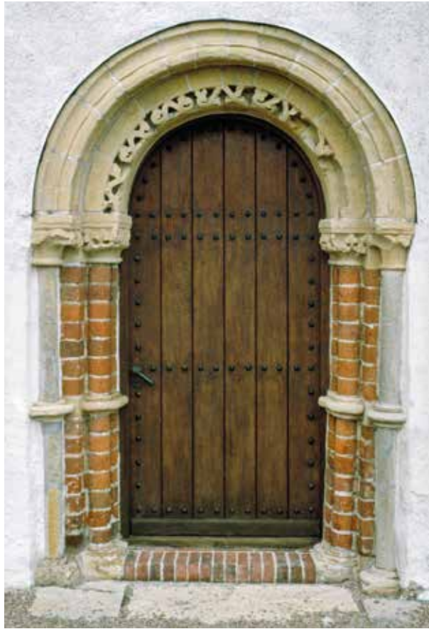
Fig. 55. Gislövs kyrka, sydportalen. Kyrkan i Gislöv uppfördes sannolikt under 1200-talets första hälft. Såväl absidkyrka som västtorn byggdes helt av tegel. I sydportalen har tegel använts för kolonnskäften, medan sand- och kalksten använts till avtäckningsbåge, kapitäl och baser. Foto Lars Kennerstedt 1992, RAÄ.
