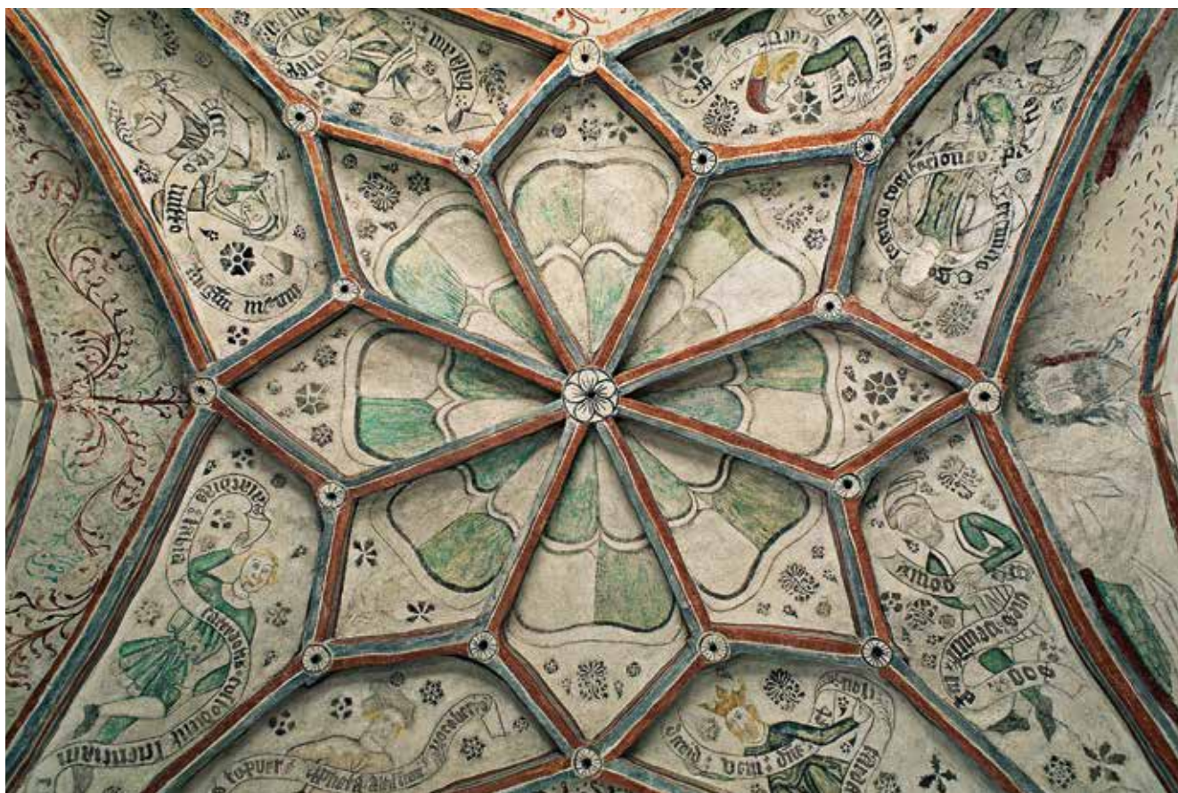
Fig. 81. Korvalvet i Brunby från 1400-talets mitt har rik utformning med firsidig ribbprofil och mittpartiet utformat som en åttauddig stjärna. Målningarna är utförda av den s.k. Helsingborgsmästaren omkring 1500. Foto Lennart Karlsson 1995, SHM.
