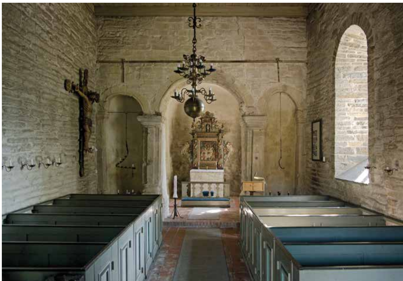
Fig. 35. Interiören av Borrie medeltidskyrka sattes åter i stånd vid en genomgripande restaurering 1927–28 (jfr fig. 25). Långhusets östmur är återskapad utifrån bevarade byggnadsdelar. Den rundvålvda triumfbågen öppnar sig mot koret och flankeras av halvrunda absidnischer, framför vilka sidoaltare stått. Vålvningarna vilar på lejonkrönta pilastrar. Foto Per Blomberg 2009.
