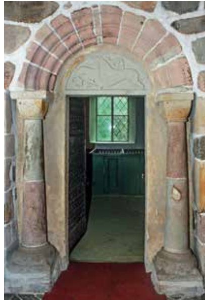
Fig. 51. Den romanska södra baldakinportalen vid Färlövs kyrka. Fristående granitkolonner bär upp ett eget takfall som ger skydd till den innanförliggande portalen. Baldakinen stöter i väster emot ett samtida, brett västtorn. I öster har baldakinen avkortats genom tillbyggnaden av en korsarm 1882–83. Foto Mattias Karlsson 2011.
