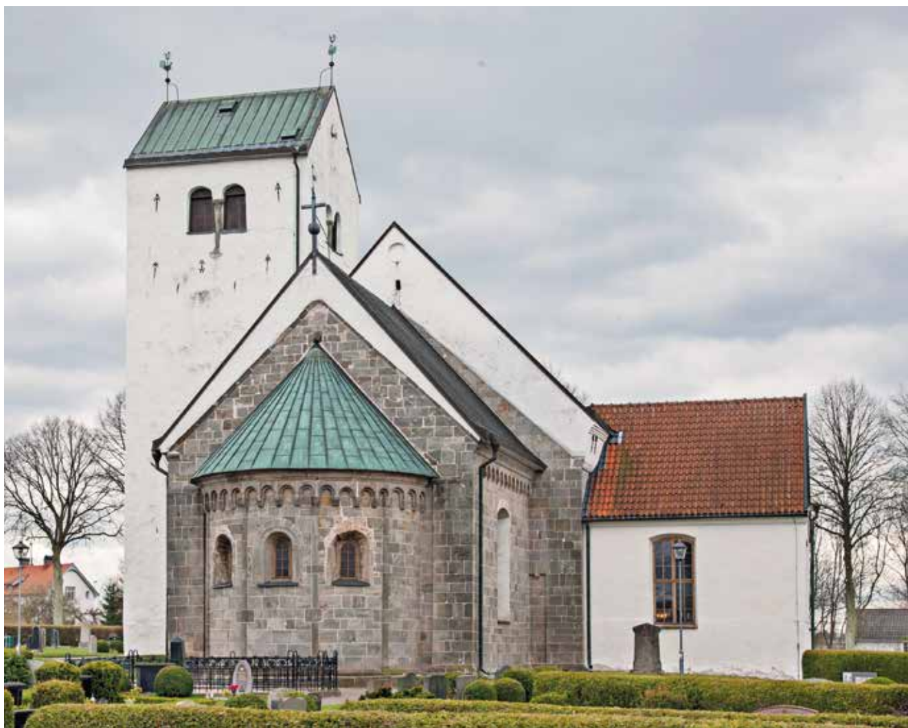
Fig. 32. S:ta Maria kyrka i Vä från nordväst. Kyrkan uppfördes på kungligt initiativ under 1100-talets första hälft. Under 1160-talet övertogs kyrkan av premonstratenserna. Kyrkan uppfördes av kvaderhuggen sandsten och med rik skulpturutsmyckning. Sannolikt vid uppförandet eller strax därefter försågs kyrkan med en av landets förnämsta målningutsmyckningar från romansk tid (fig. 50). Foto Malin Gezelius/Medströms Bokförlag, 2008.
