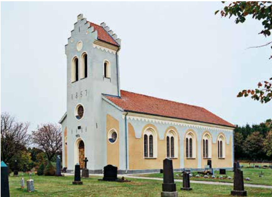
Fig. 145 a–b. Hörröds kyrka uppfördes 1856–58 i nyromansk stil efter ritningar av Albert Törnqvist vid Överintendentsämbetet. Kyrkan blev dock enklare än ritningens förslag, med ett typiskt skånskt trappgaveltorn istället för spira. Vid renoveringar kring 1950 vitkalkades kyrkan utvändigt. Den ursprungliga färgsättningen av exteriören togs fram vid en restaurering 1997–98 under ledning av arkitekt Hans Ponnert. Foto före och efter restaurering: Agne Klarinder.
