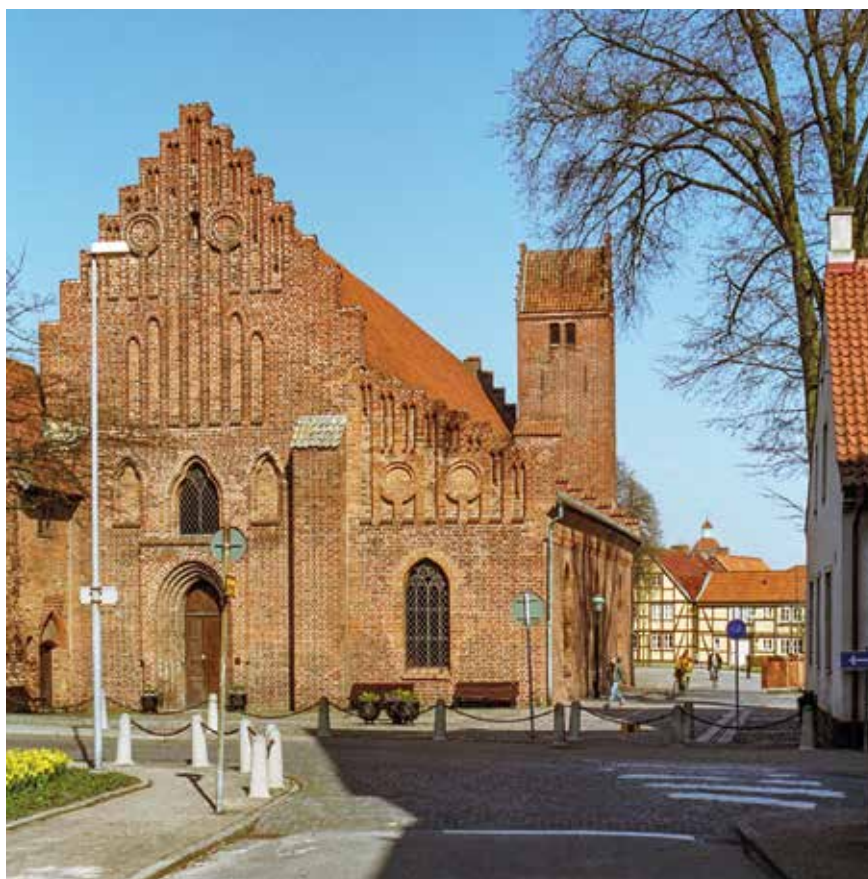
Fig. 33. S:t Petri i Ystad uppfördes för det 1267 etablerade franciskankonventet. Västfasaden utformning här rör från kyrkans äldsta byggnadsfas, färdigställd omkring 1290. Under 1300-talets första hälft utvidgades kyrkan i öster och fick ett tresidigt avslutat korparti. Ett under 1300-talet tillfogat kapell på sydsidan kom ca 1430 att inlemmas i ett då uppfört sidoskepp. Klocktornet på kyrkans sydsida tillfogades omkring 1500. Efter reformationen har klosterkyrkan använts som församlingskyrka. Foto Bengt A. Lundberg 1998, RAÅ.
