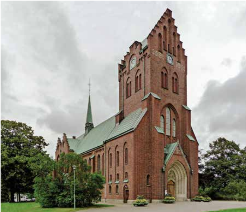
Fig. 133. Hässleholms kyrka från 1913–14 är den sista kyrkan i Skåne som fick ett nygotiskt formspråk. Exteriören i rött tegel har strävsystem och trappgavlar med blindingar i vitt. Ritningarna gjordes 1911 av stadsarkitekten i Landskrona Fredrik Sundbärg. Interiören har kraftigt förändrats vid restaureringar 1937 och 1964. Foto Joakim Andersen 2012.
