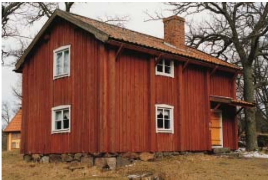
Enkelstugan. Den välventilerade grunden och det höglänta läget bidrar till de goda klimatförhållandena inomhus.
