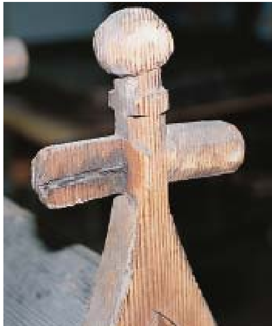
Hög relativ fuktighet har gjort att spiken har rostat och spräckt träet.
