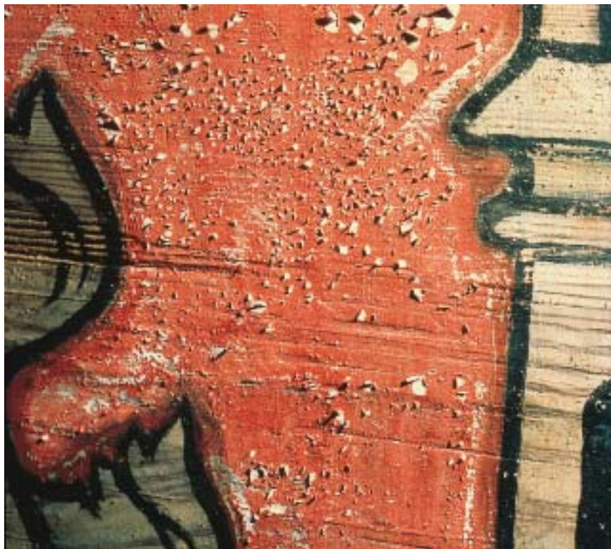
Konserveringsskada orsakad av spänningsskapande, animaliskt lim, troligen gelatin, som sprayats på måleriet. Limmet har samlats i droppar på ytan som sedan sprängt bort måleriskiktet. Södra Råda gamla kyrka, Värmland.
