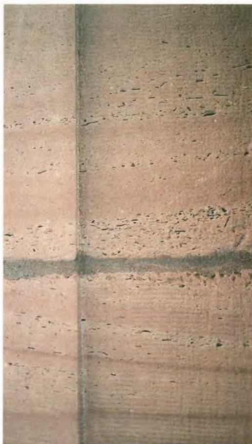
Figur 78. Orsasandsten med linsformade håligheter efter urvittrade lerfragment. Handelsbanken vid Gustav Adolfs torg 16 i Stockholm. Foto R. Löfvendahl 1996.
