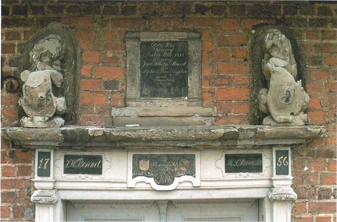
Figur 101. Överstycket på portalen, Rosendals slott i Skåne från 1756, med bemålad och starkt vittrad gotländsk sandsten. Foto B.A. Lundberg 1992.
