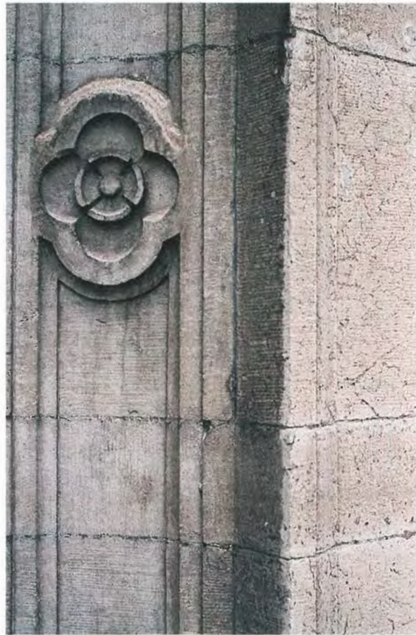
Figur 95. Riksbanken i Vänersborg från sekelskiftet i oskadad Yxhultskalksten med svag patina. Foto L. Kennerstedt 1992.
