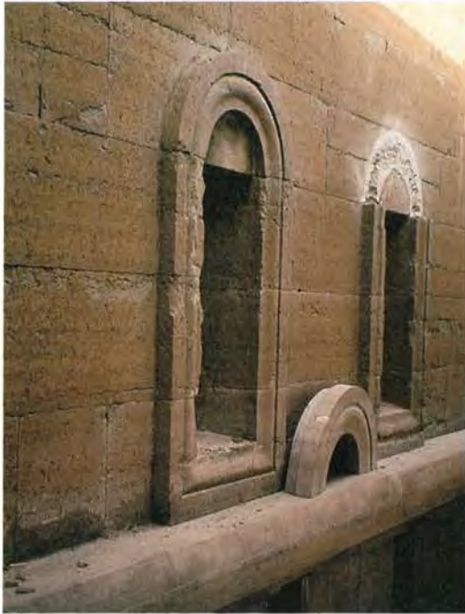
Figur 43. Karlsborgs fästning vid Vätterns västra strand i Västergötland, byggd 1832–1845 av bl.a. armékapten Johan af Kleen. Byggnaden är uppförd av Borghamnskalksten, som bröts i stora mängder på andra sidan Vättern. Notera den nyhuggna fönsterbågen. Foto M. Johnson 1995.
