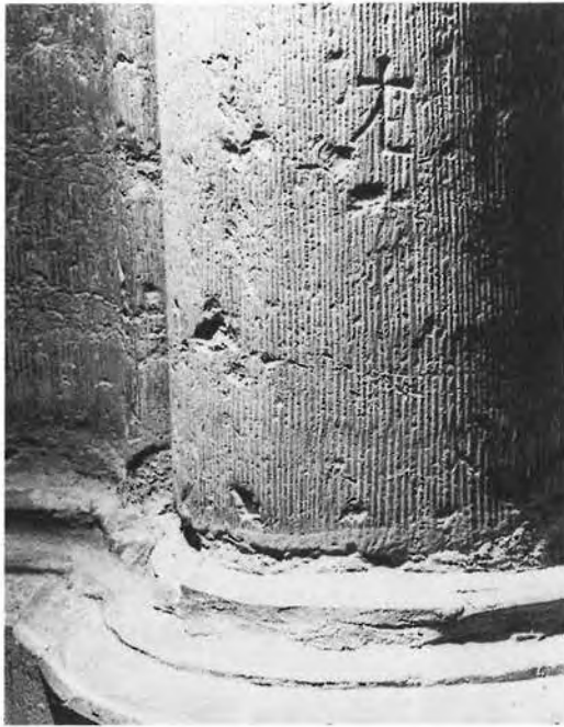
Figur 21. Bredmejselbehugning från 1400-talets slut med stenhuggarmärke. Lokal kalksten. Linköpings domkyrka. Foto R. Hintze, Sveriges Kyrkor 1986.
