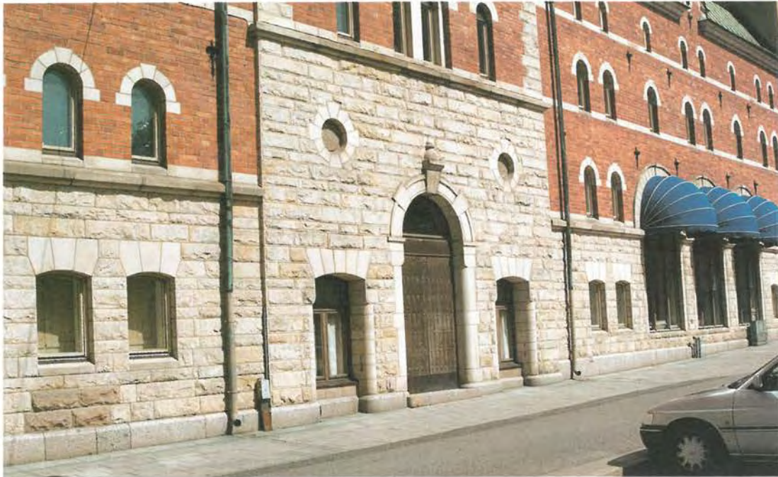
Figur 57. Gas- och elektricitetsverket i Örebro från 1911. Bottenvåningen och omfattningar av Yxhultskalksten. Foto M. Modin Örebro Länsmuseum 1992. The gas and electricity works in Örebro from 1911, partly built of Yxhult limestone.
