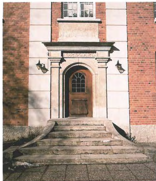
Figur 58. Torsgården i Skara, ritad av Ingvar Lindberg med portal från 1911 av Kinnekullekalksten. Foto Ulf Nordh Skaraborgs Länsmuseum 1996. Torsgården, Skara, designed by Ingvar Lindberg with portal from 1911 of Kinnekulle limestone.
