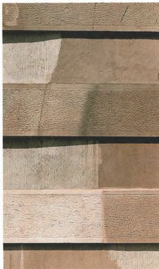
Figur 77. Övedskloster, Skåne; detalj i slottets loggia i Övedssandsten med ilusade och omhuggna ytor. De utskjutande partierna har kantslag och är gradhuggna, de infällda är lågerhuggna. Notera att den ursprungliga stenytan mörknat betydligt efter över 200 års exponering i luft. Foto B.A. Lundberg 1992.
