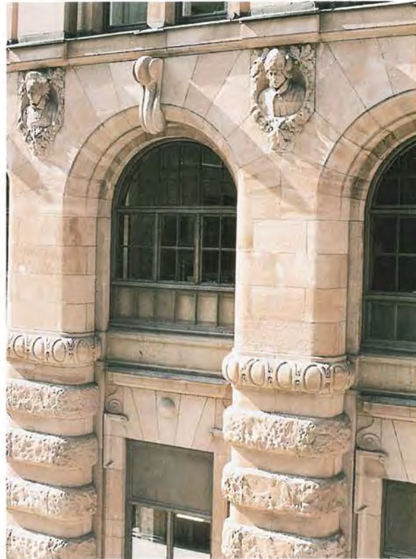
Figur 50. Skånebanken i Stockholm uppförd 1897–1900 av Övedssandsten, ritad av arkitekt G. Wickman. Observera figurer med häradsdräkter, skulpterade av Christian Ericsson. Ytan på de grovt huggna kvadrarna är delvis bortvittrad. Foto B. A. Lundberg 1996. Skånebanken in Stockholm of Öved sandstone, built in 1897–1900 and designed by the architect G. Wickman. Notice the figures in local attire, sculpted by Christian Ericsson. The surface of the coarsely cut ashlars is partly delaminated.
