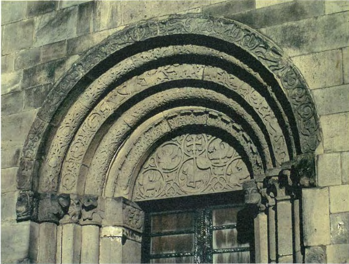
Figur 8. Portal och kvadermurverk av Höörsandsten, 1100-tal. Lunds domkyrka. Foto B. Sundnér 1995. Portal and ashlars of Höör sandstone, 12th century. Lund Cathedral.
