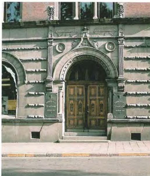
Figur 49. Sundsvalls sparbank, Sundsvall, byggd 1891–92. Fasad och portal av Yxhultskalksten från Närke samt mindre detaljer av gotländsk sandsten. Foto 1966 av P. Lindgren, Sundsvalls museum.
