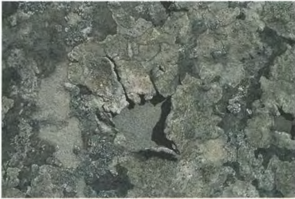
Figur 98. Gotländsk sandsten på kyrkogårdsmuren vid Sunde kyrka på Gotland. Döende avflagnande lavar (arten Dirina massiliensis ) lämnar en sandande naken yta efter sig. Foto B.A. Lundberg 1991.
