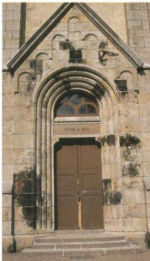
Figur 82. Sydportalen på Österplana kyrka, Kinnekulle, Västergötland i Lingulidsandsten med spridd fläckig svart missfärgning. Foto R. Löfvendahl 1996.
