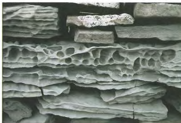
Figur 76. Alveolvittring av gotländsk sandsten. Sten-gårdsgård vid Kättelviken på södra Gotland. Foto R. Löfvendahl 1992.
