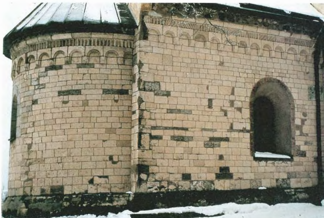
Figur 84. Bjäresjöes 1100-talskyrka i Skåne med gulaktig Köpingsandsten och spridda kvadrar av mörkgrå kalktuff. Foto B. Sundnér 1988.
