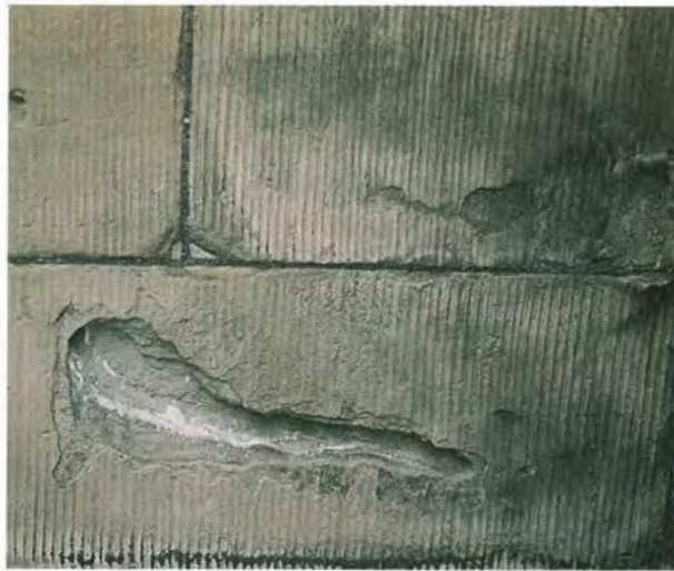
Figur 97. Lågerhuggen gotländsk sandsten på Tyska kyrkan i Gamla Stan, Stockholm med en urvittrad hålighet orsakad av saltutfällningar. Vit natriumsulfat syns inne i håligheten. Foto R. Löfvendahl 1994.
