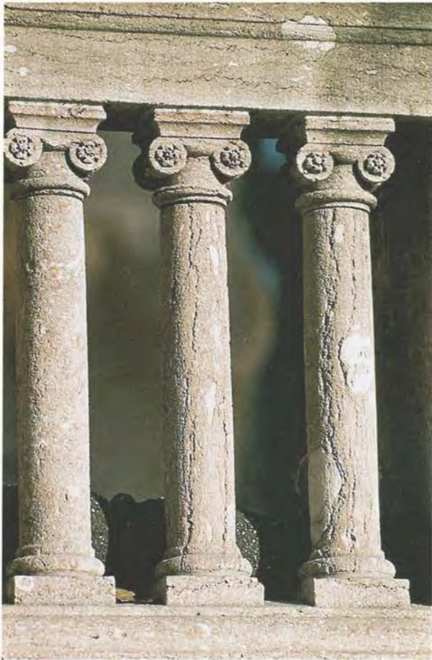
Figur 89. Kolonner av röd gotländsk kalksten, s.k. Hoburgsmarmor, Konstakademien i Stockholm. Tydlig urvittring efter leriga lagringsplan samt vittringsbeständiga vita fossilavtryck. Foto B.A. Lundberg 1991.
