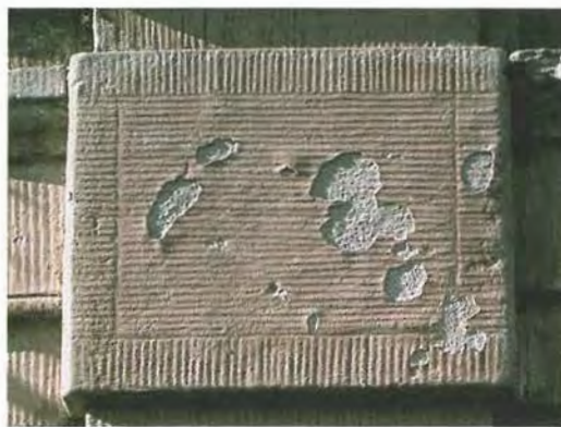
Figur 31. Detalj av portal på Wiks slott, Uppsala län. Lågerhuggen gotländsk sandsten troligen utformad av stensemästare Christian Pfundt, vars gesäll Simon Larsson var verksam vid Wiks slott 1659–77. Notera de kraftiga exfolieringsskadorna. Foto L. Kennerstedt 1990.
