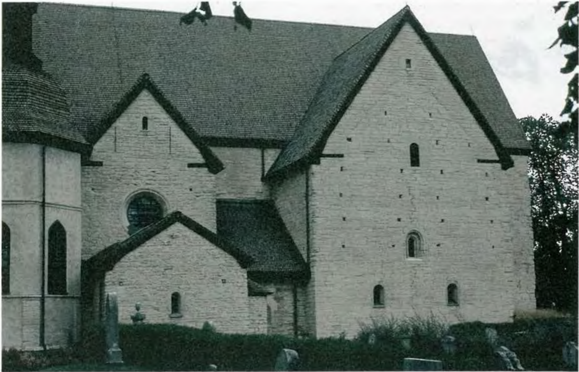
Figur 12. Vreta klosterkyrka, Östergötland, byggd av lokal kalksten under olika perioder. De äldsta murarna från tidigt 1100-tal är av grovhuggen kalksten. På 1160-talet byggde cistercienserna ett nytt kor med tvärskepp av finhuggna kvaderstenar. Från 1600-talet härrör det åttkantiga gravkoret. Foto B. Sundnér 1994. The abbey of Vreta, Östergötland, built of local limestone during different periods. The oldest walls from the early 12th century are built of roughly dressed stones, while the chancel and transepts of well dressed ashlar were added in the 1160s by the Cistercians.
