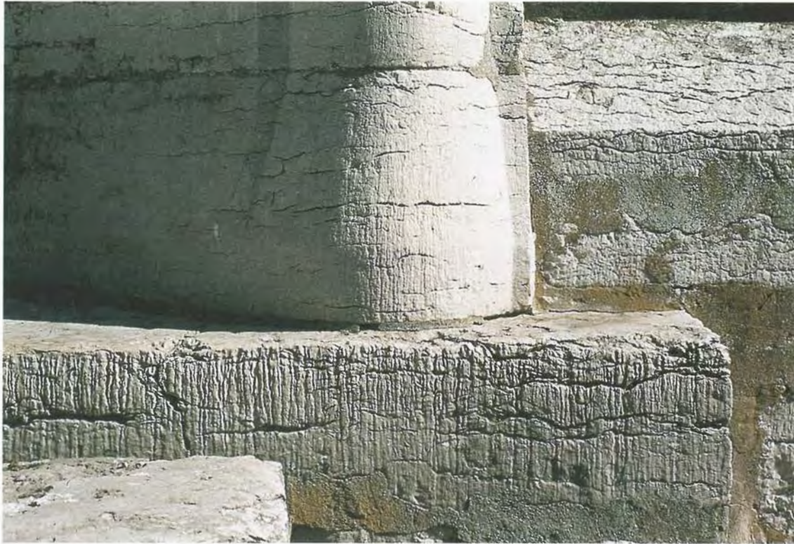
Figur 90. Sockel i grå gotländsk kalksten på Väskinde kyrka, Gotland. Tydligt urvittrade sprickor efter de horisontellt lagda lagringsplanen samt vertikala rinnådror orsakade av regnvatten från taket. Foto B.A. Lundberg 1991.
