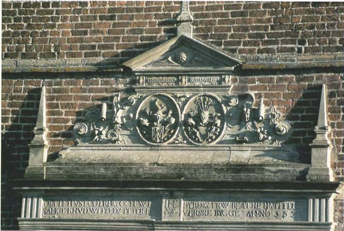
Figur 25. Svenstorps slott, Skåne. Detalj av portal från 1596 av gotländsk sandsten. Tillverkad av Hans von Steenwinkel. Riklig kolonisering av grönalger och lavar. Foto B. Sundnér 1995. Svenstorp Castle, Skåne. Detail of portal of Gotland sandstone from 1596. Cut by Hans von Steenwinkel.
