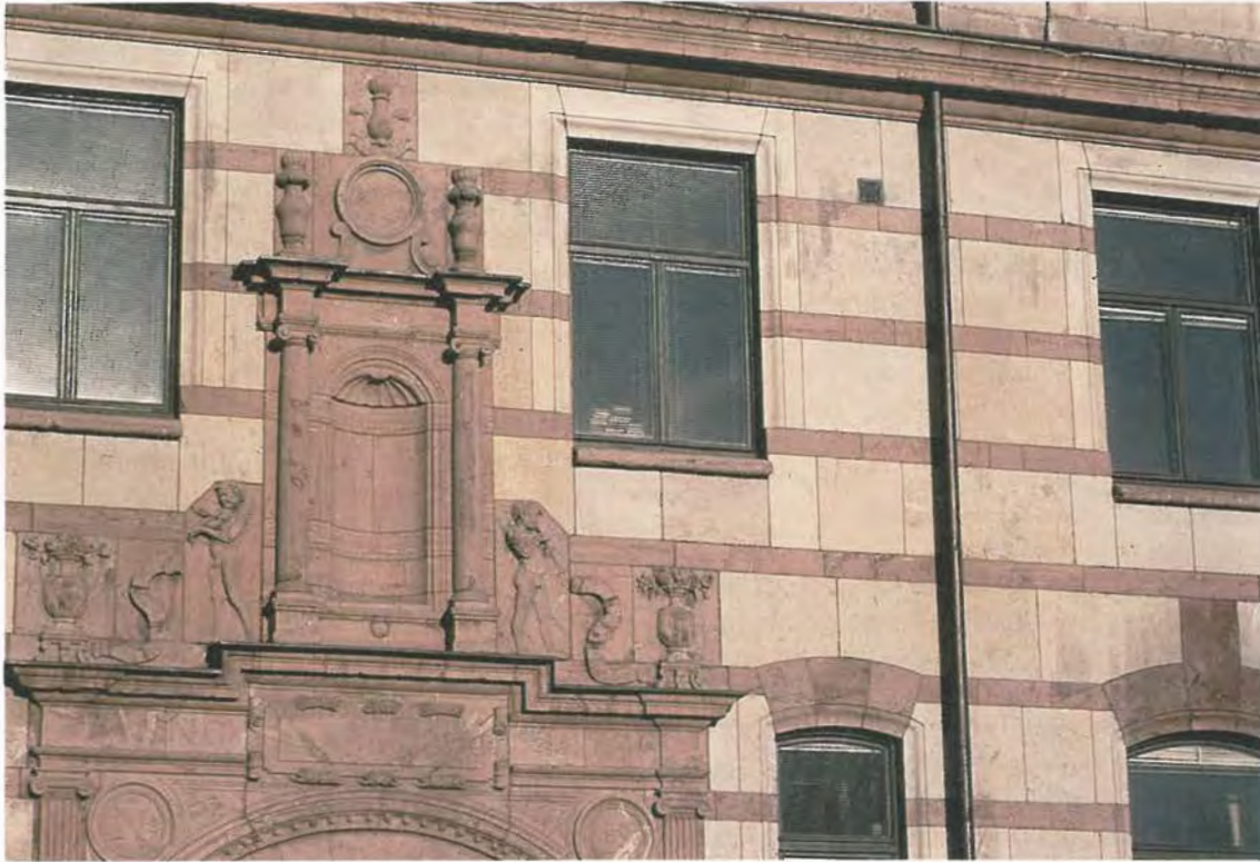
Figur 88. Naturlig polykromi med grå och röd ortocerkalksten från Österplana, Kinnekulle på Strandvägen 11 i Stockholm. Byggnaden uppfördes 1894-97 efter ritningar av G. Lindgren och K. Sahlin. Foto B.A. Lundberg 1991.
