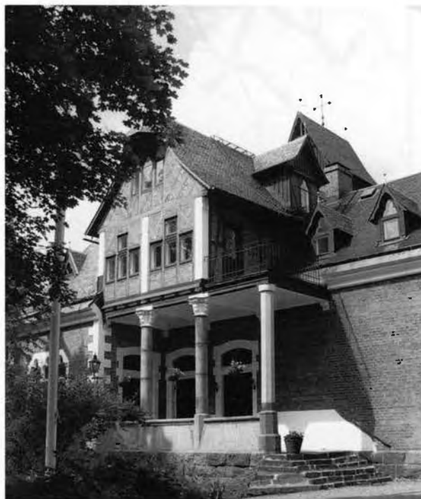
Figur 8. Österviks kapell uppförd av tegel med naturstensdetaljer av granit 1869–71 efter ritningar av A. Forsell. Foto E. Backman 1996, Länsstyrelsen Värmland.
