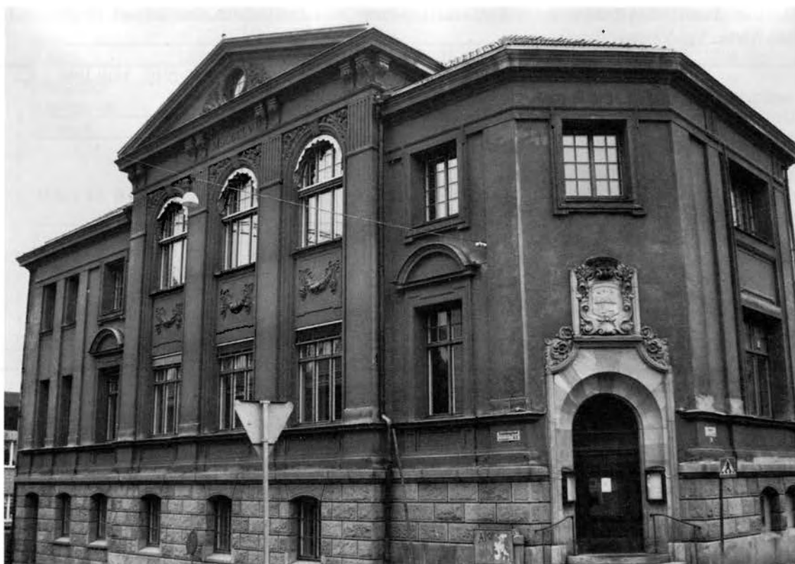
Figur 28. Sparbanken i Falun från 1906, ritad av Klas Boman. Bottenvåningens fasad, portal och lister är utförda av Orsasandsten medan sockel och andra detaljer är av urberg. Foto K. Sundström 1974, Dalarnas museum.
