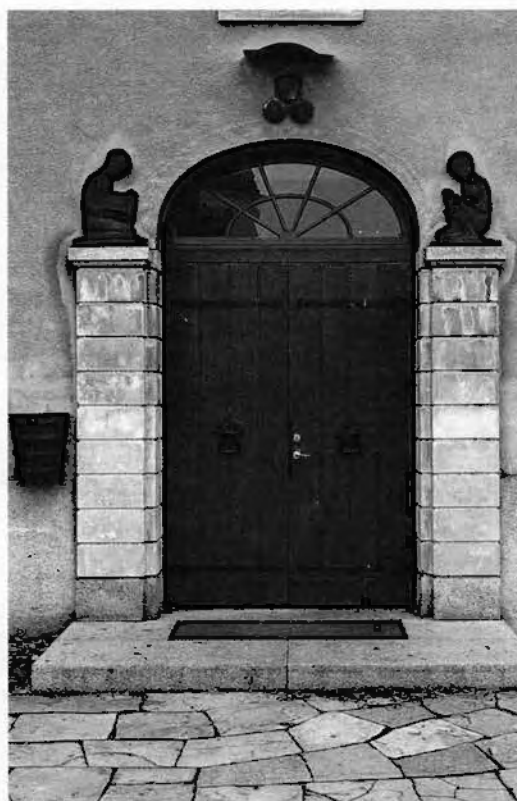
Figur 33. Kungsgårdsskolan i Säter från 1935. Portalomfattningen är av Yxhultskalksten medan sockelparitet är av urberg. Foto O. Norling 1996, Falun.
