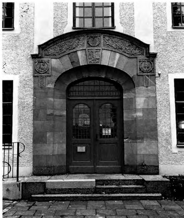
Figur 31. Portal av Orsasandsten i Ludvikas tingshus, uppfört 1906 efter ritningar av G. Améen. Foto O. Norling 1996, Falun.
