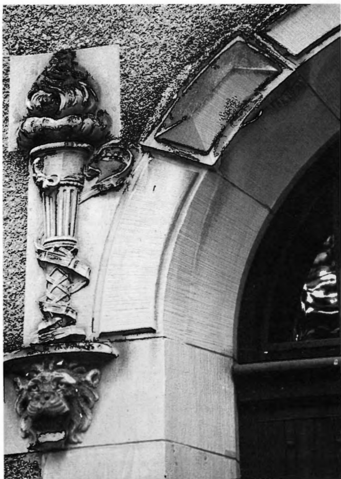
Figur 12. Brogårdsskolan i Kristinehamn ritad av Bror Almquist. Detalj av portal av gotländsk sandsten från 1915. Foto B. Ludvigsson 1996, Värmlands museum.
