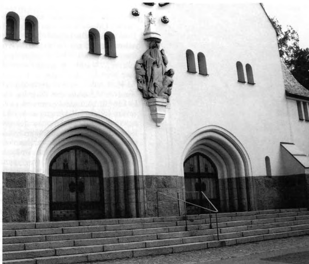
Figur 13. Trifaldighetskyrkan i Arvika, ritad av Ivar Tengbom 1911. Sockelpartiet med portalomfattningar samt skulpturen är av granit medan pilastrar och täckplattor är av Glavaskiffer. Foto E. Backman 1996, Länsstyrelsen Värmland.
