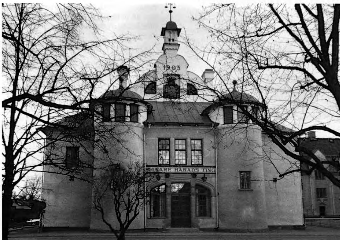
Figur 27. Tingshuset i Krylbo från 1903 med portal av Orsasandsten, arkitekt Folke Zettervall. Foto S. Olsson 1975, Dalarnas museum.
