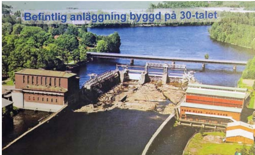
Avestaforsen före den senaste ombyggnaden. Kraftverken vid Storforsen, till vänster Avesta Storfors, till höger Månsbo. I centrum den torrlagda forsknacken. Källa: Utskrift av powerpointpresentation från Fortum, Miljödepartementet M2003-1713-F-Mo.
