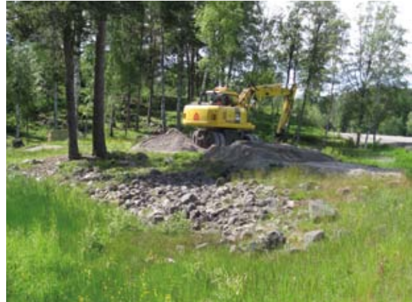
Underhållsarbete. Vården av dammsystemet kräver kontinuerligt underhållsarbete, här vid Önsbäcksdammen. Foto: Jan af Geijerstam 2010.
