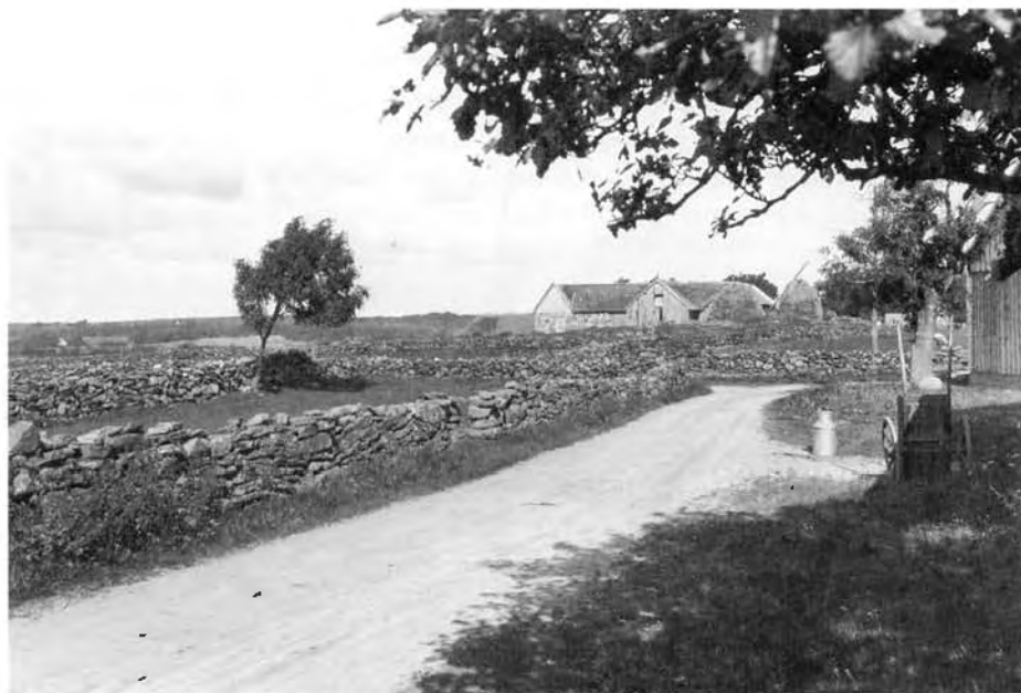
Fig. 53 Anläggandet av hägnader avspeglar till stor del de naturgeografiska förutsättningarna. Inte minst i vedfattiga bygder fick man övergå till stenmurar, särskilt under 1700- och 1800-talet. Därtill fick man användning för all odlingssten. Detta hindrar inte att välanlagda stenmurar kunde bli ett slags prestigeföremål med symbolvärden kring landskapets ägomässiga beständighet. Värö socken, Halland. Foto M. Sjöbeck, troligen omkr. 1930. ATA, neg. 1502.
