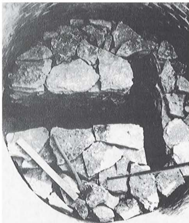
Foto 5. Stapling av kalksten i nedre delen av kalkugnen vid Hejnum, Gotland. Foto 1984, Mille Törnblom.
