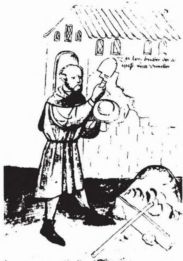
Figur 24. Bild från medeltiden som visar en munk i arbete. Bruket har han på en bricka i ena handen och mursleven i den andra. Ur "Das Hausbusch der Mendelschen Zwölfbrüderstiftung zu Nürnberg", München 1965.
