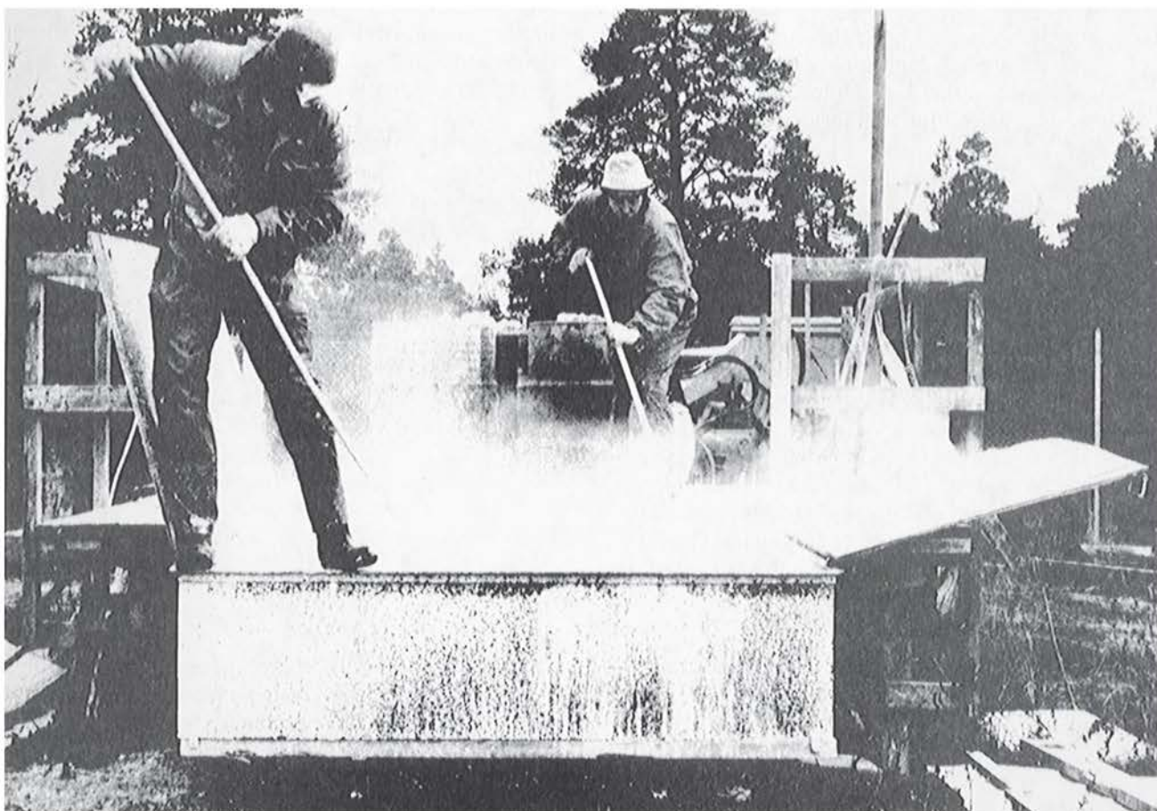
Foto 20. Släckning av bränd kalksten som tippats i ett stort plåtkar med vatten. AMS arbetsplats vid Visby. Foto 1983, Jan Lisinski.
