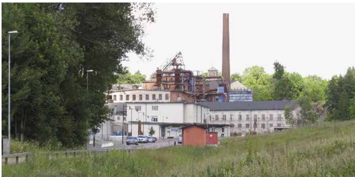
Gjuteriområdet i Hälleforsnäs efter saneringen. Till höger den nedersta delen av den forna slaggtippen, nu deponi för förorenade massor. Foto: Jan af Geijerstam, 2010.
