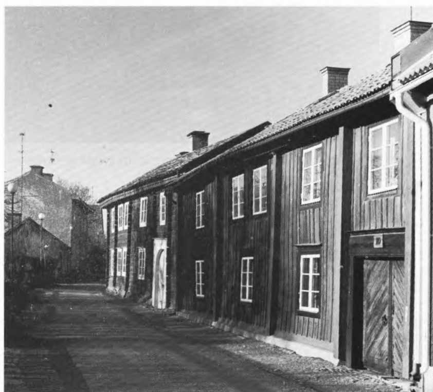
Bilden till höger: Småstads-gata med inpanelade timmerhus. Mot gårdssidan kan ofta sådana här hus ha kvar timret i fasad. Timmerarkitekturen präglar fortfarande många av våra äldre stadskärnor. Foto Peter Gavel, SFF.
