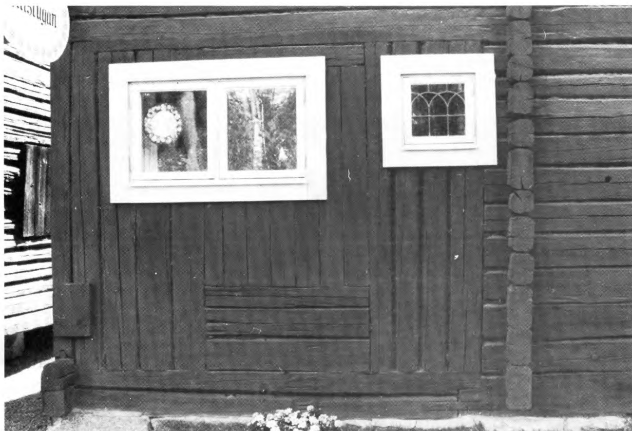
Exempel på blandkonstruktion. Ett liggtimmerhus har byggts till med användande av resvirkeskonstruktion. Blandkonstruktioner är ofta dolda bakom en fasadpanel. Foto Uno Söderberg.
