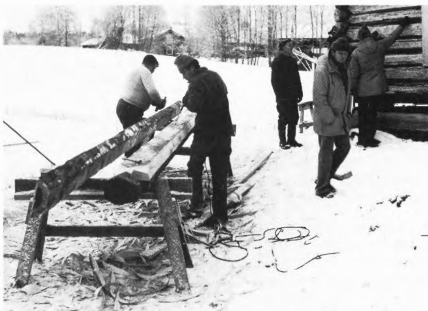
Bilderna ovan: Halvsulningen utförs. Det skadade virket huggs bort och den nya utsidan fästs med skruv, som täcks med träplugg med fibrerna i samma riktning som stocken. I detta fall halvsulades stocken till hela sin längd. Foto RAÄ.
