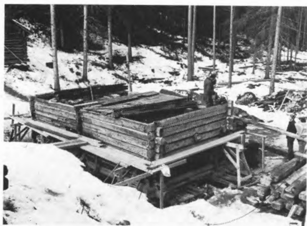
Byggnaden uppförs på nytt på sin grundkonstruktion, som reparerats medan huset var nedplockat. Foto RAA.
