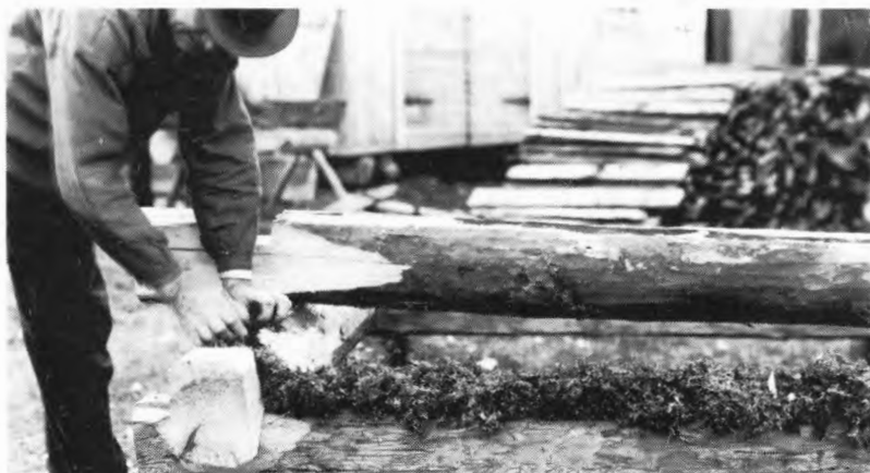
Husmossa läggs i den blivande fogen innan nästa stock lyfts på. Foto i Nordiska Museets arkiv, Etnologiska undersökningar 1929.
