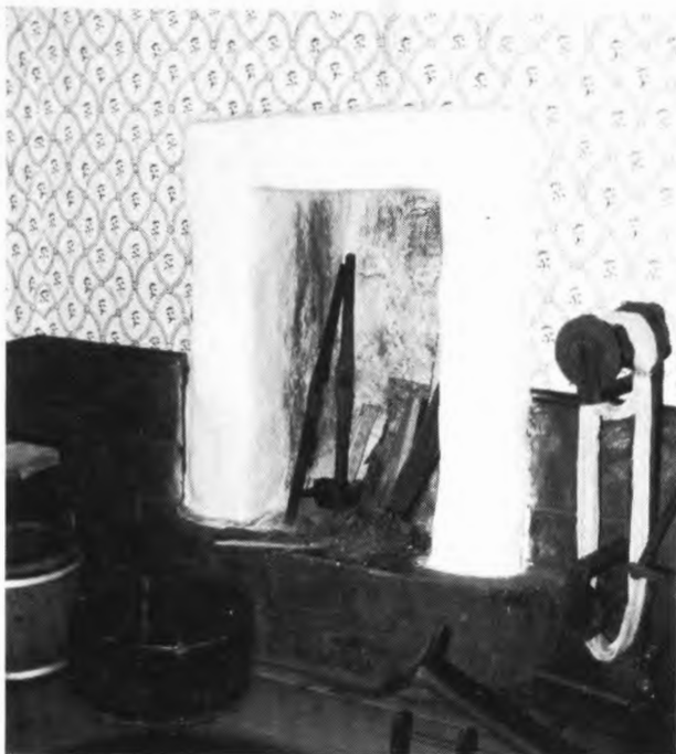
Spis vars skorstensstock ligger på andra sidan om väggen. Observera att det måste vara ett spelrum mellan spisens överdel och närmast ovanförliggande stock. Foto Uno Söderberg.
