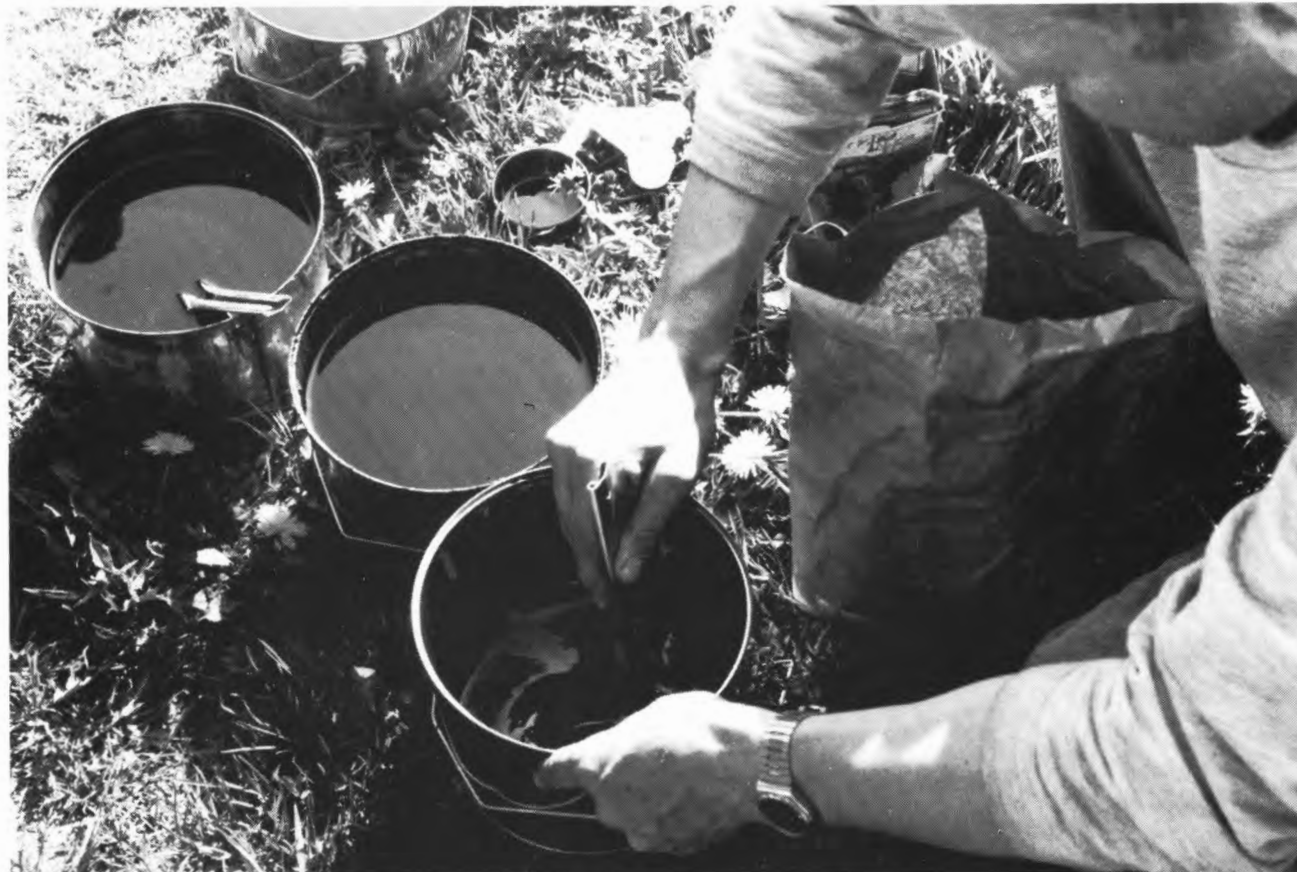
Trätjära skyddar träet mot yterrosion. Den skall strykas under sommarhalvåret på väl uttorkat underlag. Vid rödtjarning tillsätter man järnoxidrött, exempelvis "Falurött". En vanlig blandning är en viktsdel järnoxid till åtta viktsdelar tjära. Foto Uno Söderberg.
