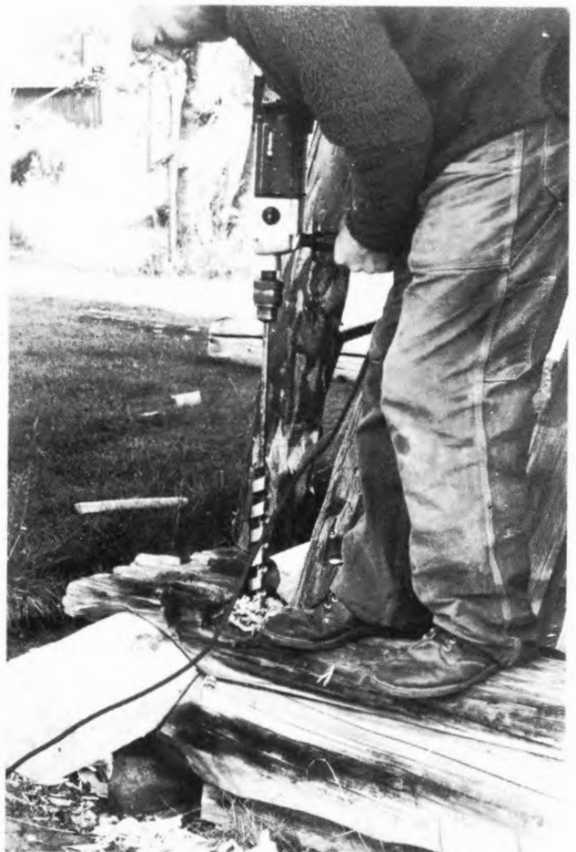
Numera används vanligen spiralborr i elektrisk bormaskin. Foto Uno Söderberg.
