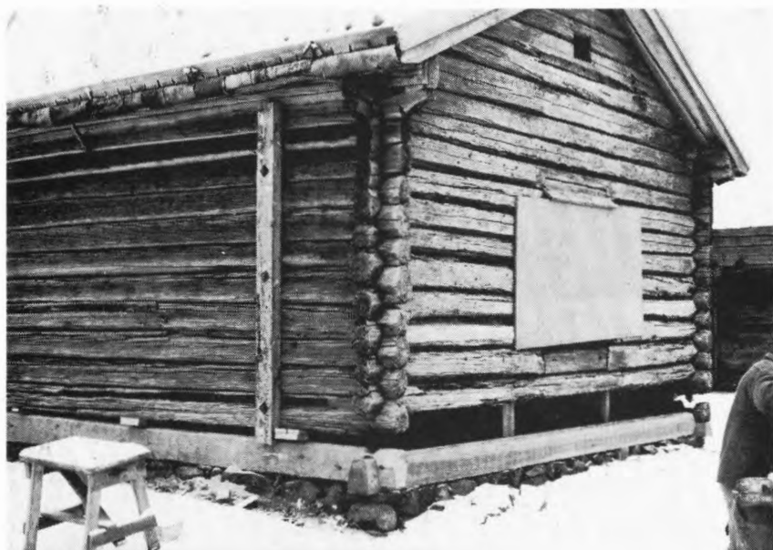
Timmerstommen har lyfts upp från syllvarvet. Gavel-syllen är ersatt med nytt virke. Andra stocken är loss-tagen för att halvsulas på utsidan med nytt ytskikt. Foto RAÄ.
