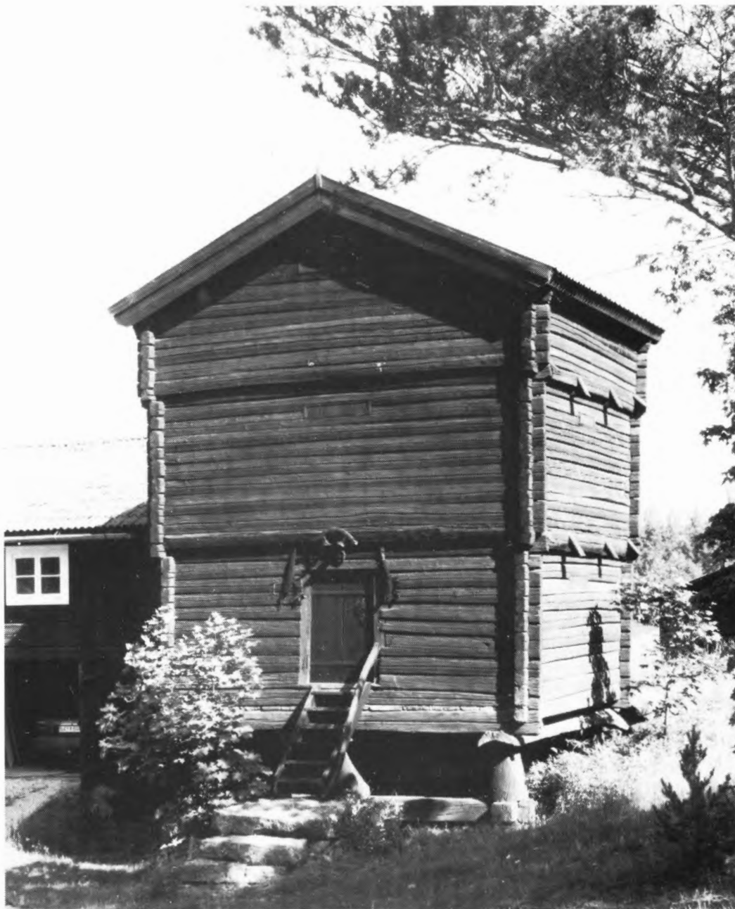
Härbre från Hälsingland i avancerad liggtimmerkonstruktion. Foto Uno Söderberg.
