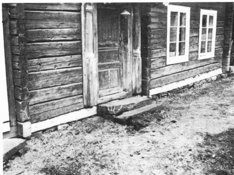
Stocken är utbytt och grundstenarna tillrättalagda. Foto Jämtlands läns museum.
