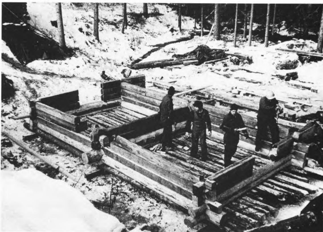
En gammal kvarnbyggnad har plockats ned. Delarna har märkts upp varefter byggnaden återuppförts på en bädd av timmerstockar vid sidan om byggplatsen. Samtidigt byts skadade delar ut mot nya och andra justeringar görs. Foto RAA.
