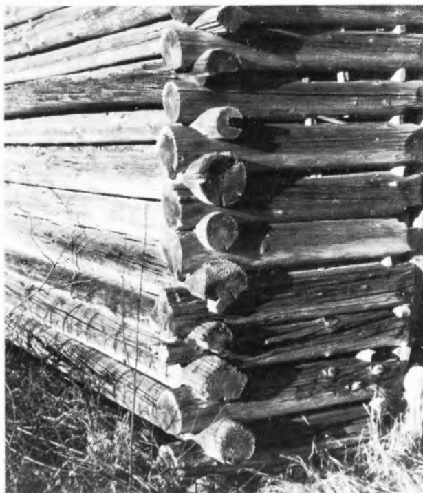
Torklador och liknande förråd måste vara luftade. Då anpassas stockarna inte till varandra utan timras ihop i hörnen så att en springa lämnas öppen mellan stockarna. Dymlingar används för att styva upp väggen. De syns i springorna. Foto Uno Söderberg.
