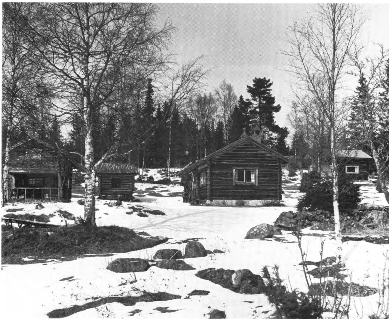
Timmerhus flyttas - idag liksom förr. Huset i bildens mitt har stått länge på sätern och är nyligen upprustat. De övriga har flyttats hit under de senaste 25 åren och placerats så att gruppen som helhet anknyter till byggnadstraditionen på platsen. Alla husen har gamla stommar. Foto Peter Gavel, SFF.
