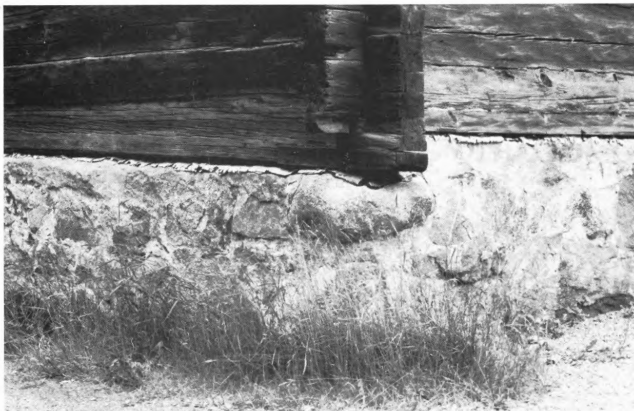
Stabil husgrund uppmurad av gråsten. Märk isoleringen av näver mellan stenmur och syllstock. Foto Uno Söderberg.
