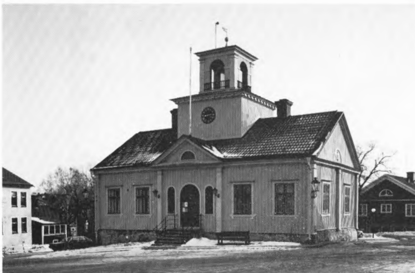
Bilden ovan: Torshälla rådhus. Timmerbyggnader som skulle uppfylla krav på viss status kläddes ofta in med panel som efterliknade puts. Foto Peter Gavel, SFF.
