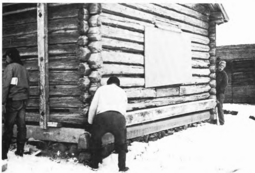
Bilderna ovan: Halvsulningen utförs. Det skadade virket huggs bort och den nya utsidan fästs med skruv, som täcks med träplugg med fibrerna i samma riktning som stocken. I detta fall halvsulades stocken till hela sin längd. Foto RAÄ.
