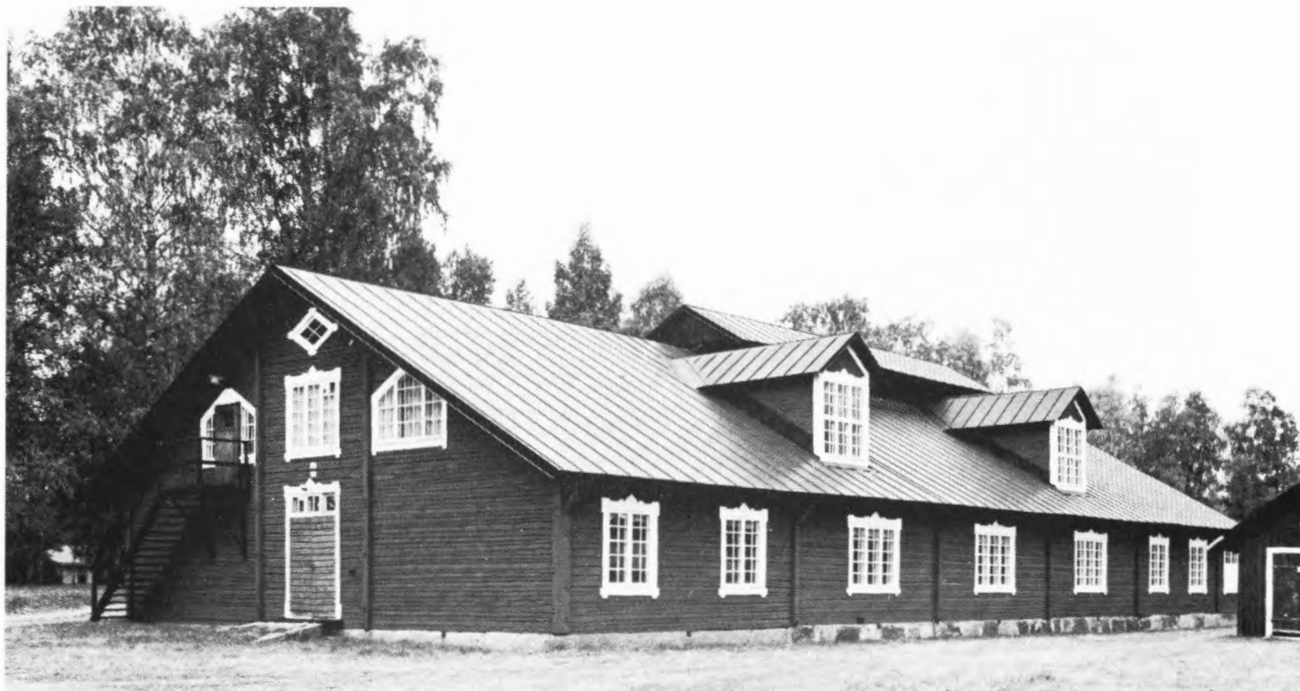
Bilden ovan: Bevärringsbarack. Liggtimmerkonstruktionen kom till användning inom de flesta områden, bland annat i den militära byggnationen. Här byggdes ofta hus i serie enligt typritningar. Det förekom att baracker och andra timmerbyggnader vid behov flyttades. Foto Peter Gavel, SFF.
