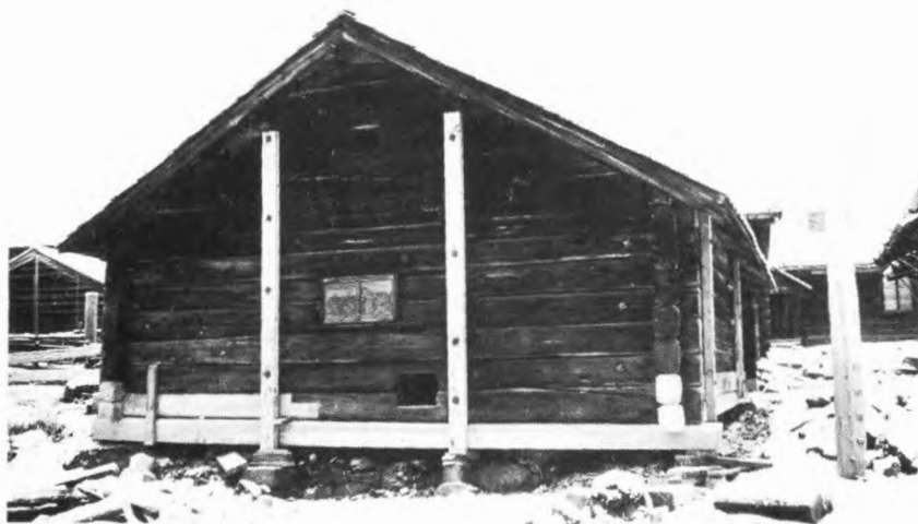
Bilden till höger: Samma stall med utbytt timmer och gavelväggen uppstyvad med spännbjälkar. Foto RAÄ.
