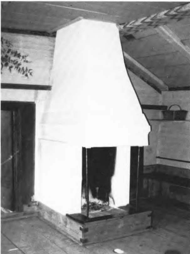
Spismur som står fri från väggar, bjälklag och takkonstruktioner. Foto Uno Söderberg.
