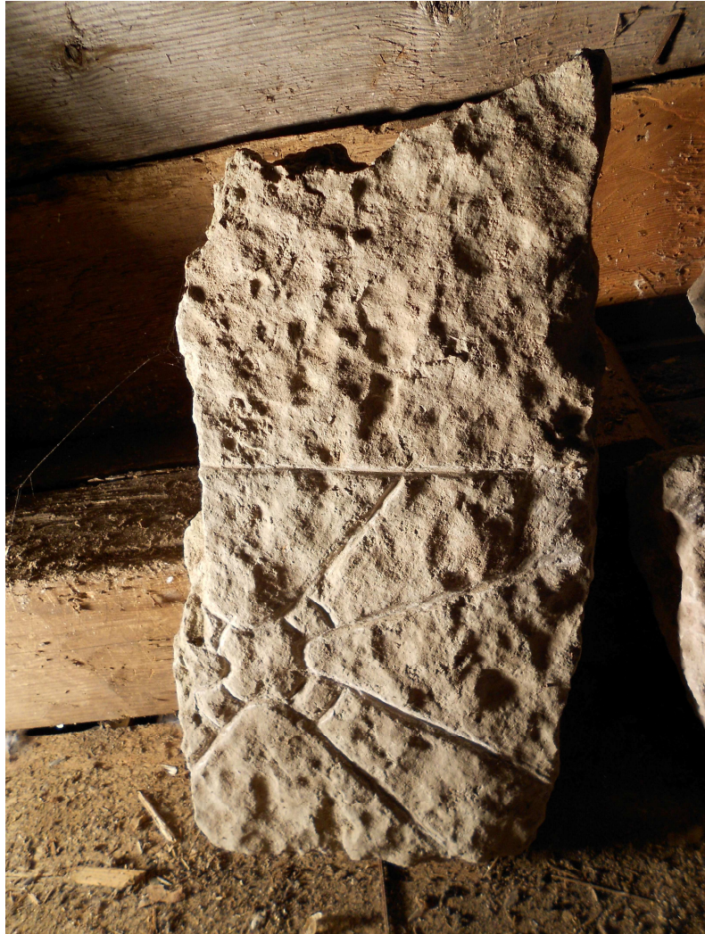
Fig. 4. Det korsristade fragmentet nr 13 på tornvinden. Foto Magnus Källström
