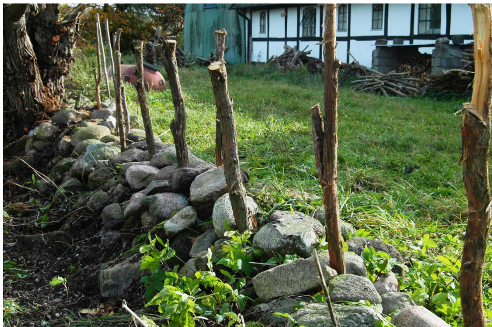
Gäre under renovering med enestakar nedslagna, Hörjelgården 2014.
