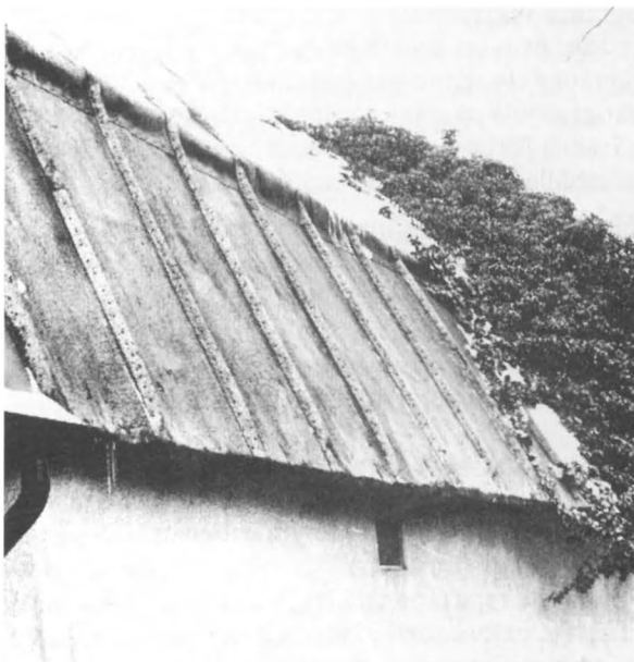
Listtäckning, förr utfördes den med täckremorna fastspikade, numera kan dessa klistras varvid man undgår perforering av pappen. Foto 1981, Disa Eklund.
