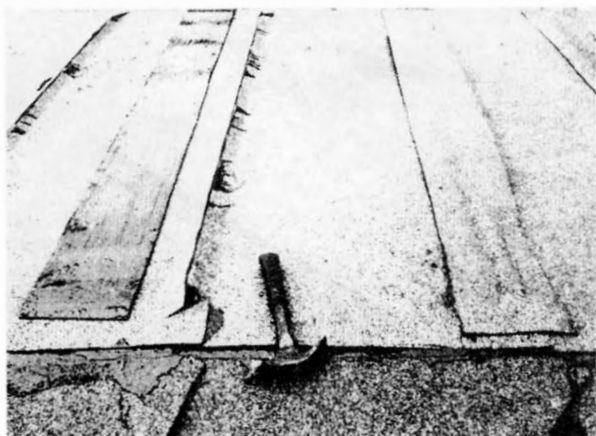
Listtäckning under utförande. Foto 1984, Kent Holgersson.
