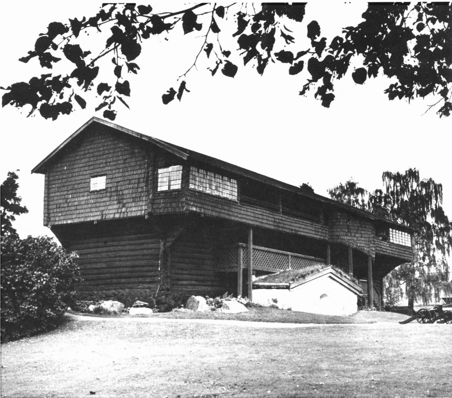
Ornässtugan, uppförd omkring år 1500, är kanske vår mest kända äldre träbyggnad. Foto: Ulf Palm, 1985
