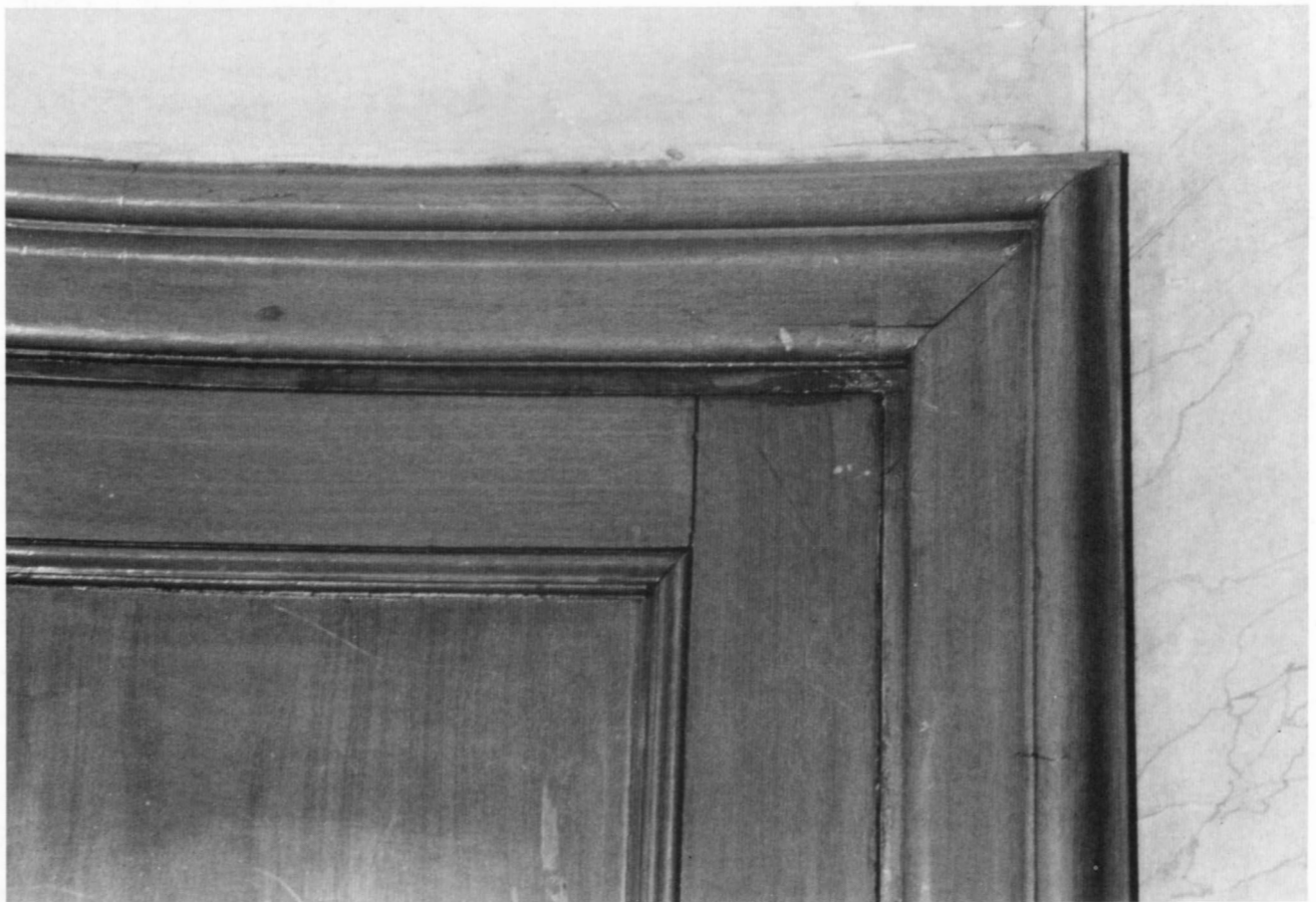
För en profilerad invändig list kan det vara helt andra virkessegenskaper som är av intresse. Om geringen skall förbli tät är det viktigt att rörelserna i fodrets breddled är så små som möjligt. Foto: Jan Cassel, 1988
