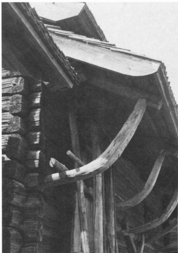
Exempel på hur man förr valde ut vissa byggnadsdetaljer redan i skogen. Bilden visar takfotskonsoler tillverkade av krokvuxna virken. Foto: Peter Grödinge, 1980
