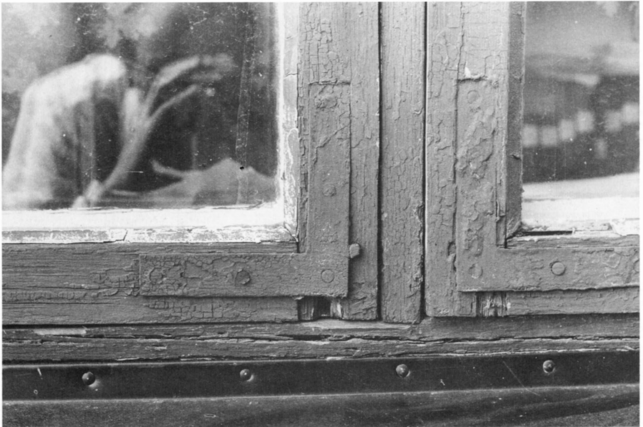
Till fönster måste väljas ett virke som är särskilt motståndskraftigt mot röta och väderförslitning. Tungt, tätvuxet och hartsrikt virke är lämpligt. Foto: Jan Cassel, 1980
