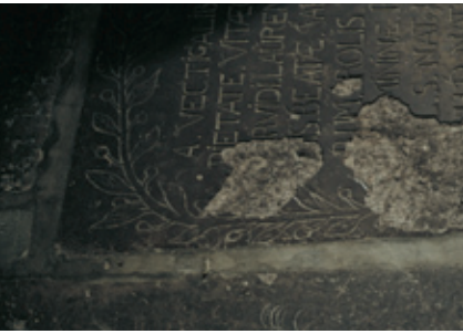
Vittrande stenhäll i golv. Med varsam städning skyddar man den betydelsebärande text som fortfarande finns kvar.
