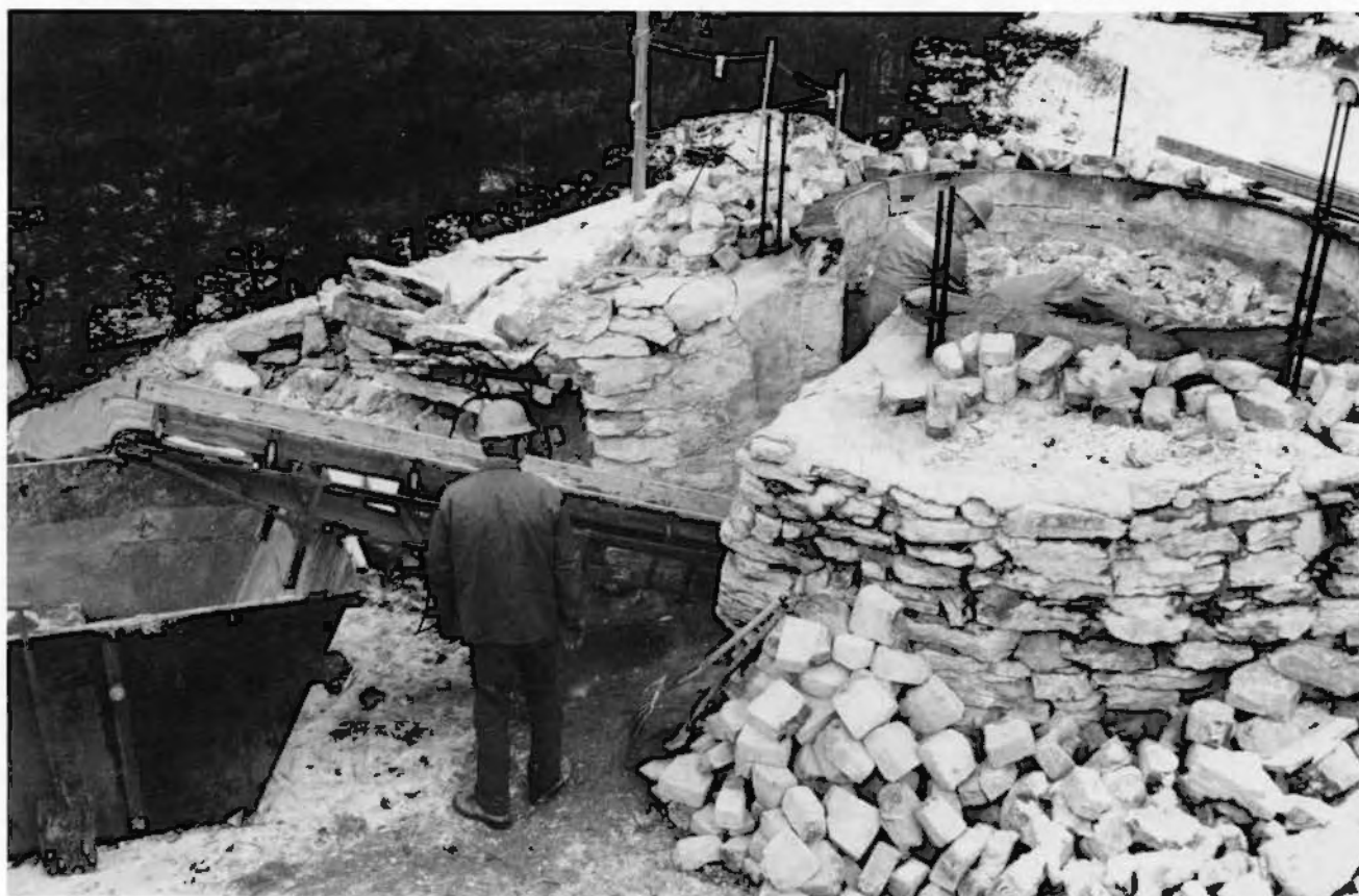
Intagsöppningens igenmurnning rivs. Stenen läggs på ett rullband som mynnar i en container. När denna är fylld täcks den med presenning i väntan på transport till släckningsplatsen i Djupqvior.
