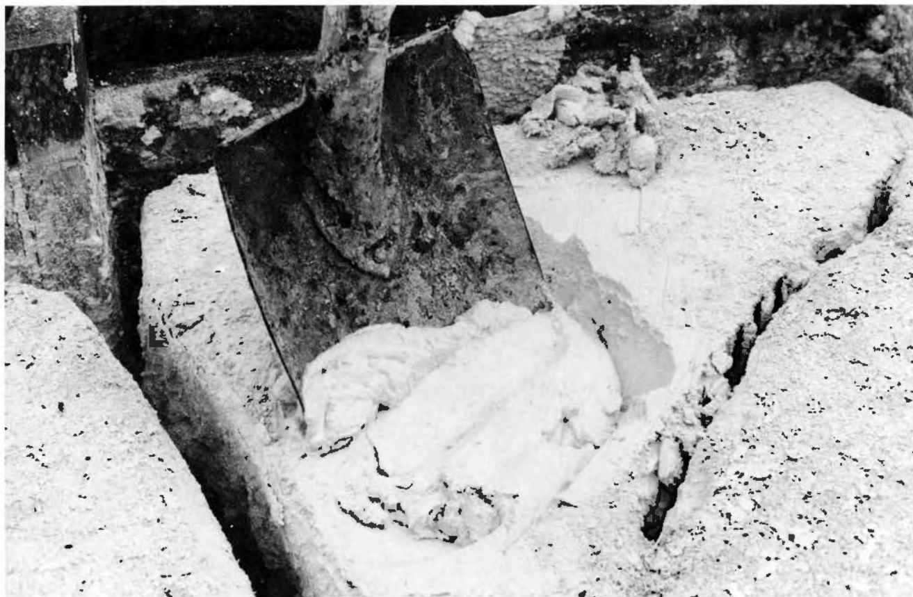
Under den torra ytan har den våtsläckta kalken en krämig konsistens.
