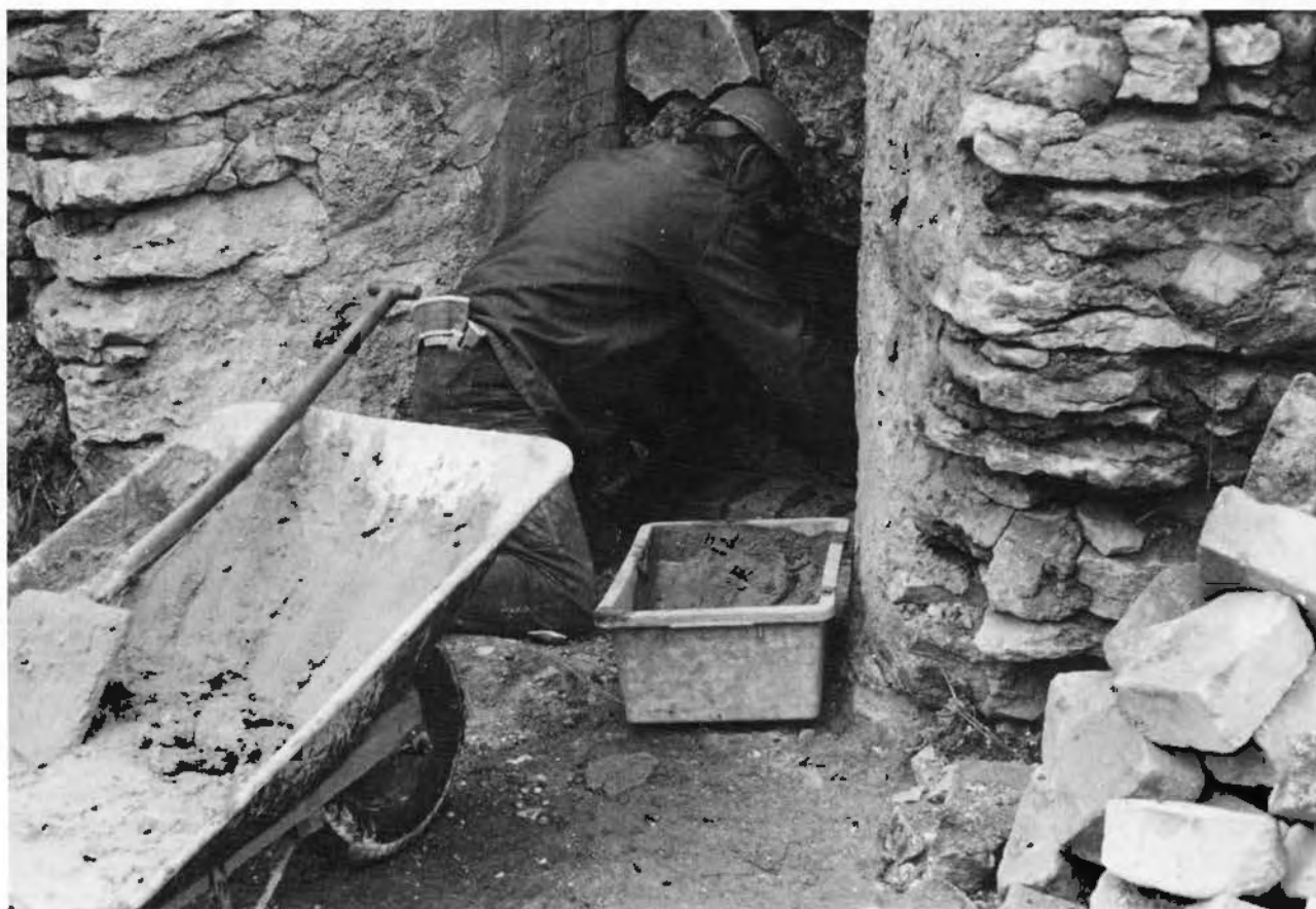
Slutligen muras intagningsöppningen igen. Ugnen är därmed klar att elda.
