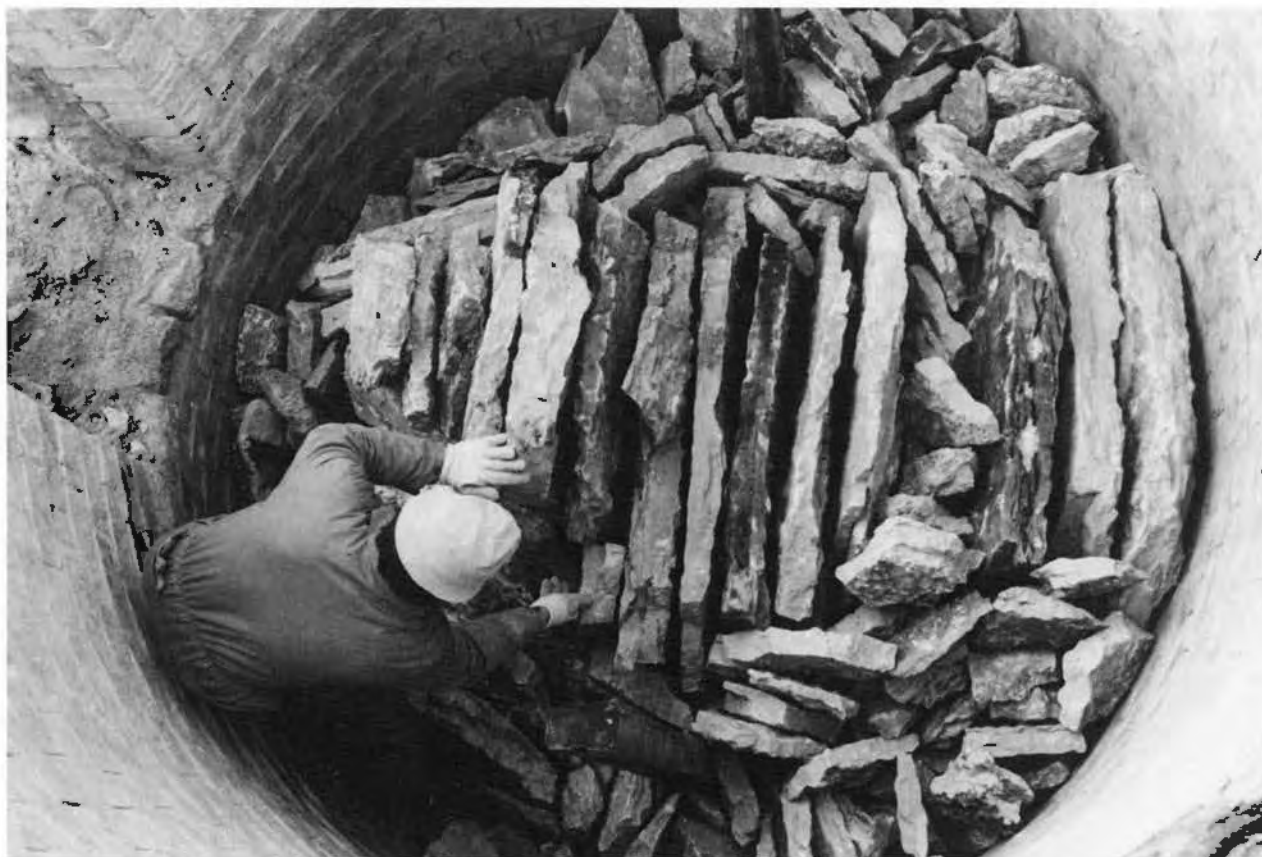
Kalkstenen staplas så att ugnsmunnens eldningskanal får en T-formad fortsättning in i botten av ugnspipan. Denna kanal täcks med stora kalkstensskivor ställda på högkant.
