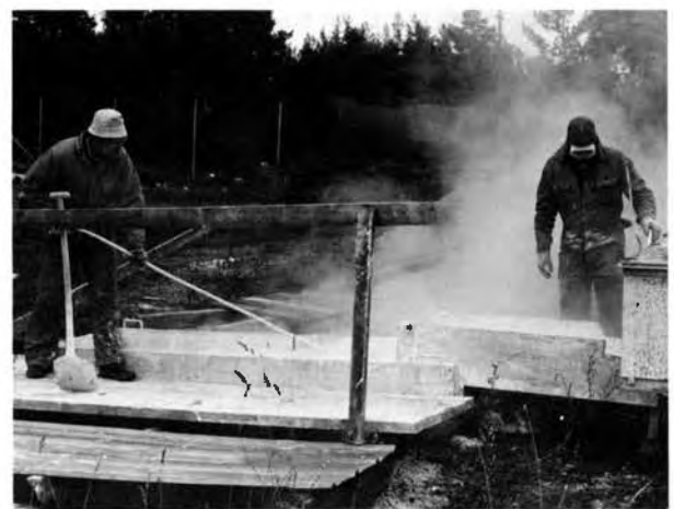
En arbetsplattform läggs parallellt med träkaret tvärs över den kalkgrav som skall fyllas.
