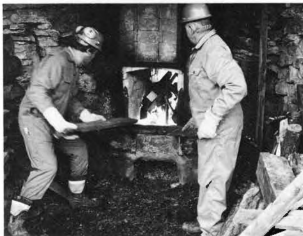
Eldningen sker kontinuerligt under de tre dygn som bränningen normalt varar. Två man arbetar tillsammans i 12-timmarspass. Veden stoppas in i ugnsmunnens eldgång.
