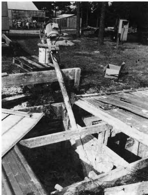
Från kalkgravarna fylls kalken på plåtburkar med hjälp av en skruvledning.
