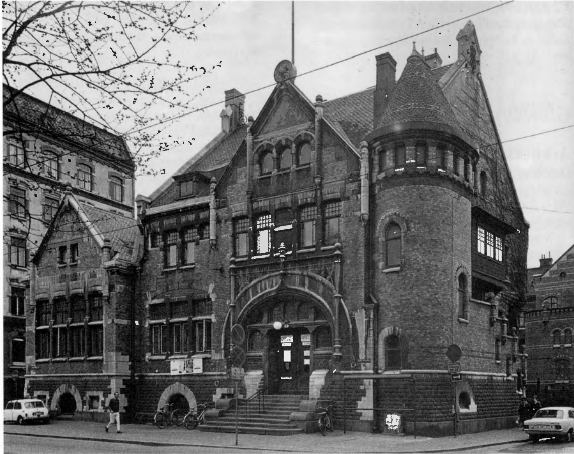
Figur 10. F.d. Dicksonska Folkbiblioteket i Haga, Södra Allégatan 4 i Göteborg. Byggt 1895 efter ritningar av H. Hedlund. Portal och andra fasaddetaljer av kalksten från Yxhult. Foto S. Westergren 1972, Göteborgs Historiska museum.
