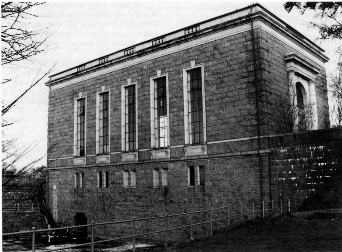
Figur 32. Lagaholms kraftstation från 1932 efter ritningar av S. och S.A. Sörensen. Foto H. Bergfast 1992, Hallands läns museer, Halmstad.
