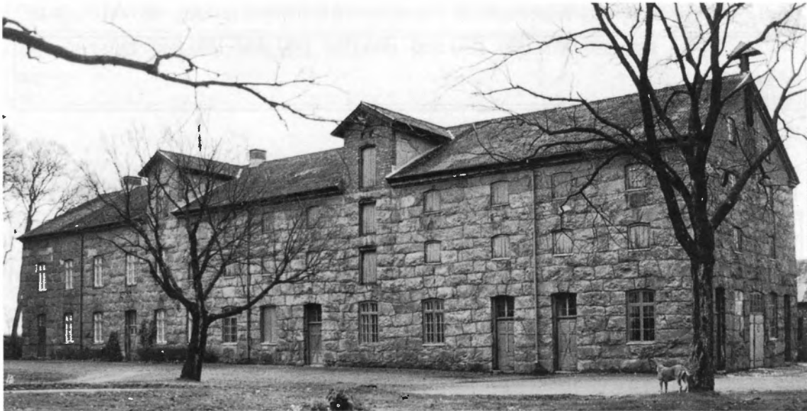
Figur 28. Magasin- och bostadshus på Heagård uppfört i rusticerad granit 1882. Foto H. Bergfast 1992, Hallands läns museer, Halmstad.
