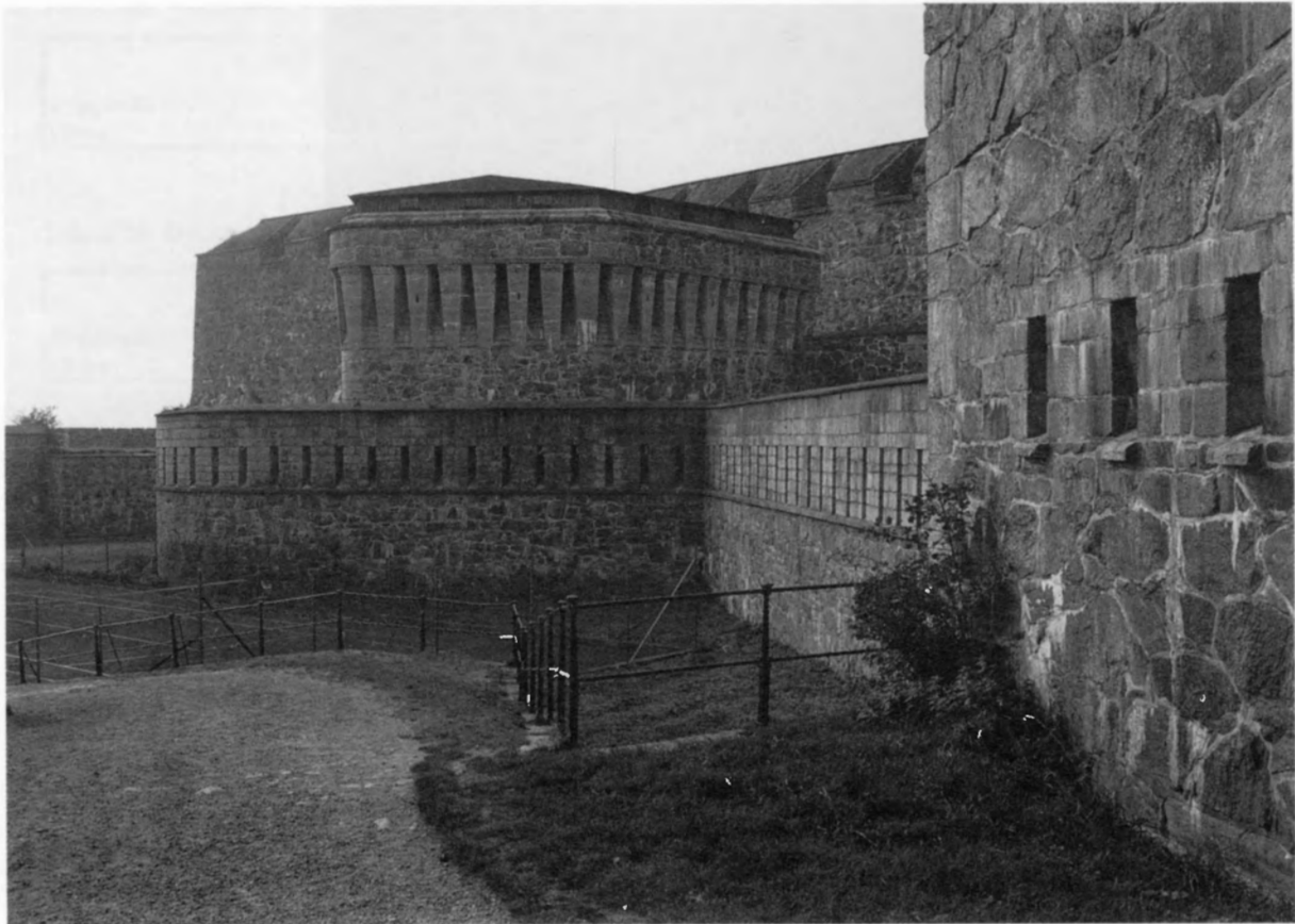
Figur 15. Carlstens fästning, påbörjad vid 1600-talets slut. Det säregna kruthuset från 1830-talet har en överbyggnad av Kinnekullekalksten. Fästningen är byggd av gråsten (urberg), men har Kinnekullekalksten i skyttegluggarnas solbänkar och på kärnavtäckningarna. Foto T. Brandt 1992, Bohusläns museum.
