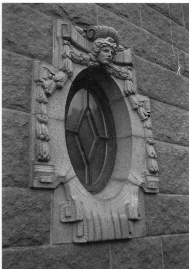
Figur 14. Fönsteromfattning av granit i Laurinska villan i Lysekil, från 1918-19. Foto T. Brandt 1992, Bohusläns museum.
