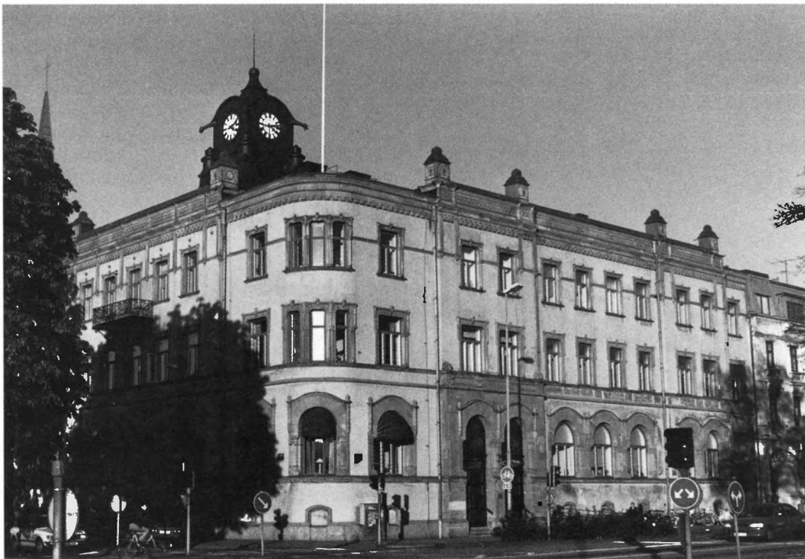
Figur 29. F. d. Riksbanken i Halmstad, uppförd 1900 med detaljer av Övedsandsten efter ritningar av Martin Borgstedt. Foto C. Gustafsson 1995, Hallands läns museer, Halmstad.
