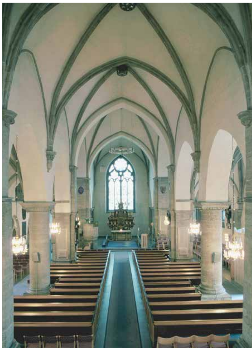
Fig. 23. Örebro S:t Nicolai, interiör mot öster. Stadskyrkan vid Stortorget stod färdig vid 1300-talets mitt. Det monumentala kyrkorummet är treskeppigt, väggar och valvkappor är putsade medan ribbor och pelare blottar finhuggen kalksten. Byggnadsskulpturen är koncentrerad till portalerna, men finns också på kapitäl och pelarbaser i kyrkans inre. Restaureringar har bl.a. skett 1936 under ledning av arkitekt Erik Fant, då den nuvarande slutna bänkinredningen tillkom, och 1962–64 efter ritningar av arkitekt Kurt von Schmalensee. Foto Per Torgén 2000, ÖLM.
