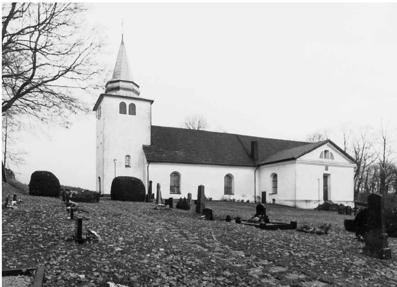
Fig. 32. På initiativ av patronus Carl Otto Wolffradt omdanades medeltidskyrkan i Rolfstorp 1816–17. Kyrkans ursprungliga absidkor ersattes av ett korparti av långhusets bredd, samt korsarmar tillbyggdes. Ritningarna uppgjordes av Olof Tempelman, vilka bearbetades av Per Vilhelm Palmroth. Det befintliga tornet i väster uppfördes 1926 efter ritningar av Anders Roland, men ersatte då ett äldre. Foto Ingvar Rohr 1980.
