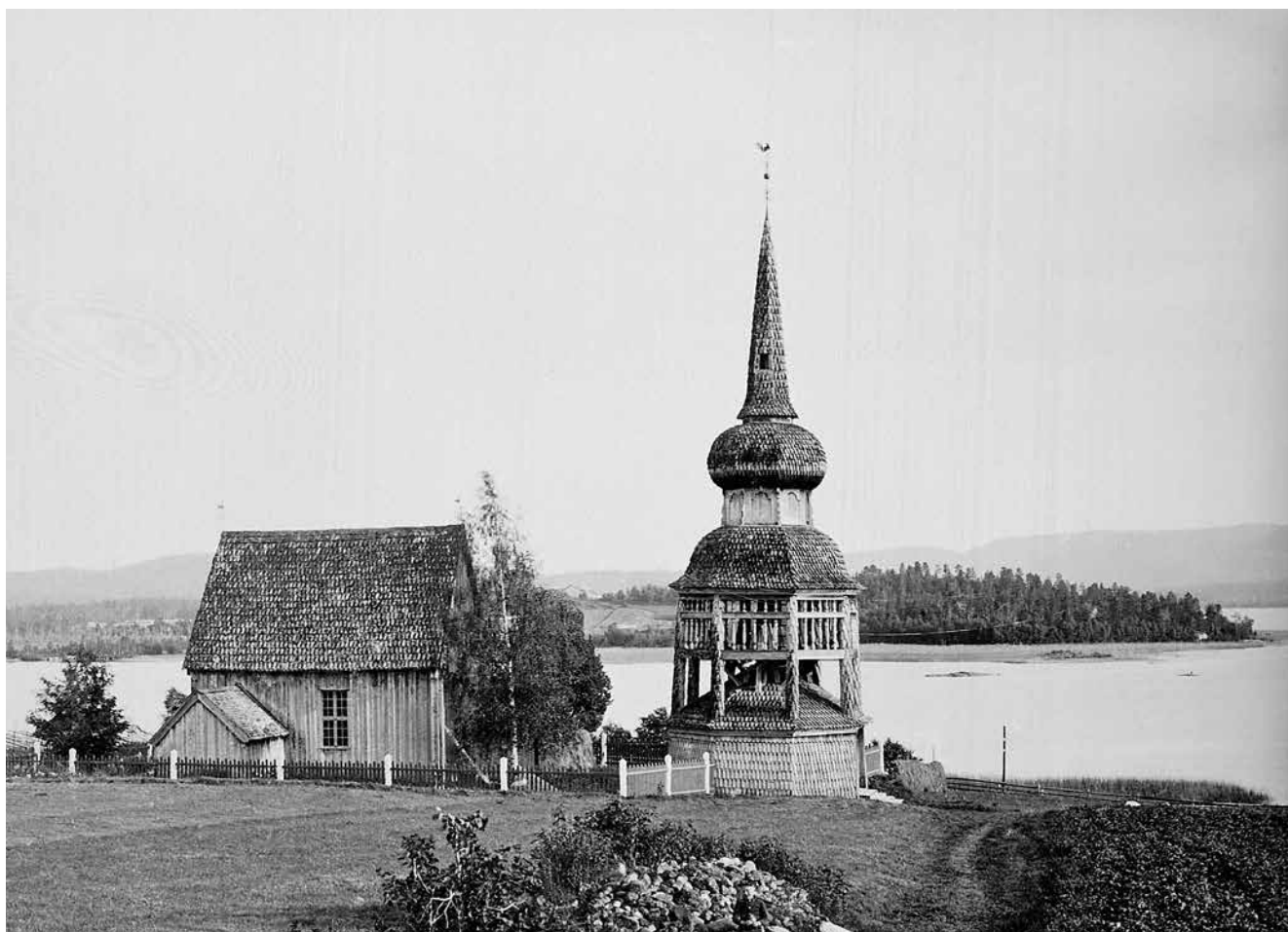
Fig. 25. Håsjö gamla kyrka och klockstapel från norr. Kyrkan uppförd 1684, klockstapeln år 1779 av byggmästaren Pål Pehrsson i Stugun. Äldre foto av Nils-Gustaf Nilsson, ATA.
