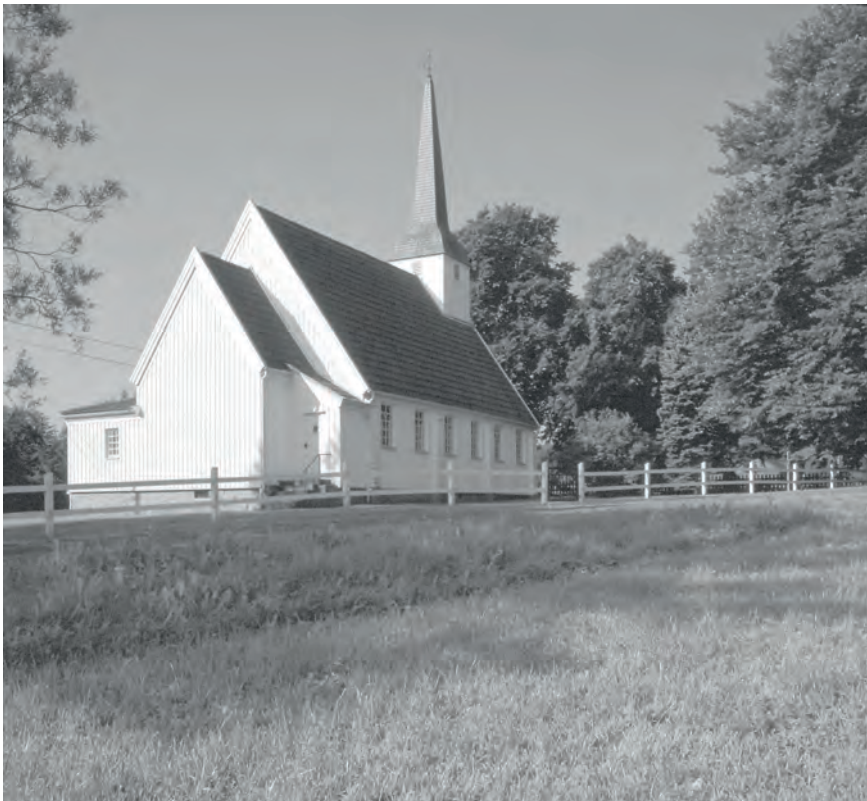
Fig. 75. Trogareds kapell, uppfört 1921. Ett av flera träkapell som byggdes under mellankrigstiden i landskapet. Trogareds kapell byggdes efter egna ritningar av byggmästarna och bröderna Albin och Carl-Wilhelm Gustafsson i Borås. Vissa förändringar ägde rum 1948 efter Axel Forsséns ritningar. Foto Göran Lindabl 1997, SvK.
