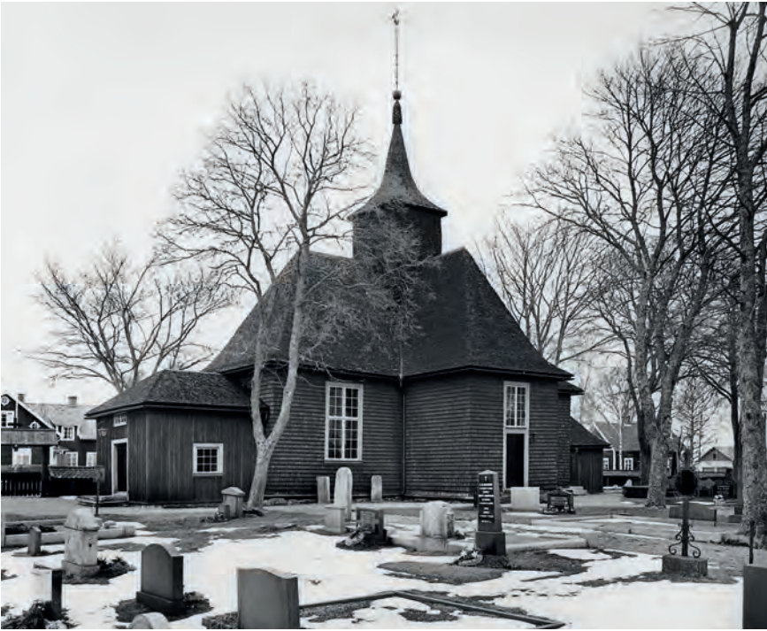
Fig. 45. Brandstorps kyrka uppfördes 1697 och är ett vackert prov på tidens träbyggnadskonst i sydvästra Sverige. Korskyrkans timmerväggar är spånklädda och de valmade sadeltaken kröns av ett centraltorn med spira. Kyrkogården omsluts av timrade kyrkbalkar. Foto Sören Hallgren 1975, ATA.
