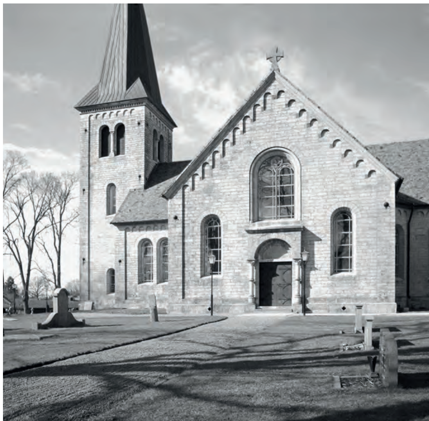
Fig. 68. Saleby kyrka, uppförd 1893-94. Den stora kyrkan uppfördes som ersättning för en medeltida kyrka, som revs i sin helhet eftersom den upplevdes som trång, bl.a. för att församlingens komminister lockade många kyrkbesökare. Kyrkan nyuppfördes från grunden med återanvändande av den gamlas mursten och gavs en arkitektur som associerade till den rivna romanska kyrkan. Foto Göran Lindahl 1997, SvK.
