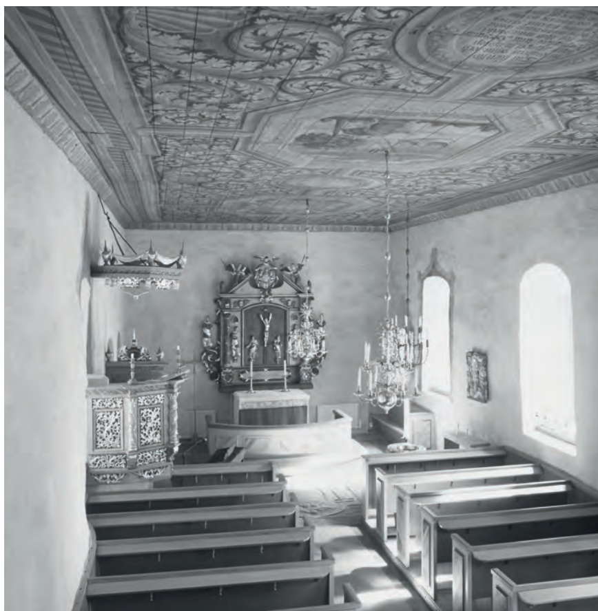
Fig. 41. Norra Kedums kyrka är ett karakteristiskt exempel på den västsvenska barockens kyrkorum i Västergötland. Medeltidskyrkan hade ursprungligen ett smalare, rakt avslutad kor. Det revs 1687 och ersattes med ett korparti av långhusets bredd. Därefter uppsattes ny predikstol och altarpjäs. På 1740-talet fullbordades interiören genom ett platt trätak med målningar i den yngre Läcköskolans art. Lidköpingsmästaren Lars Hasselbom målade medaljonger med figurscener och sentenser, omramade av frodiga akantusslingor. Foto Göran Lindahl 1997, SvK.
