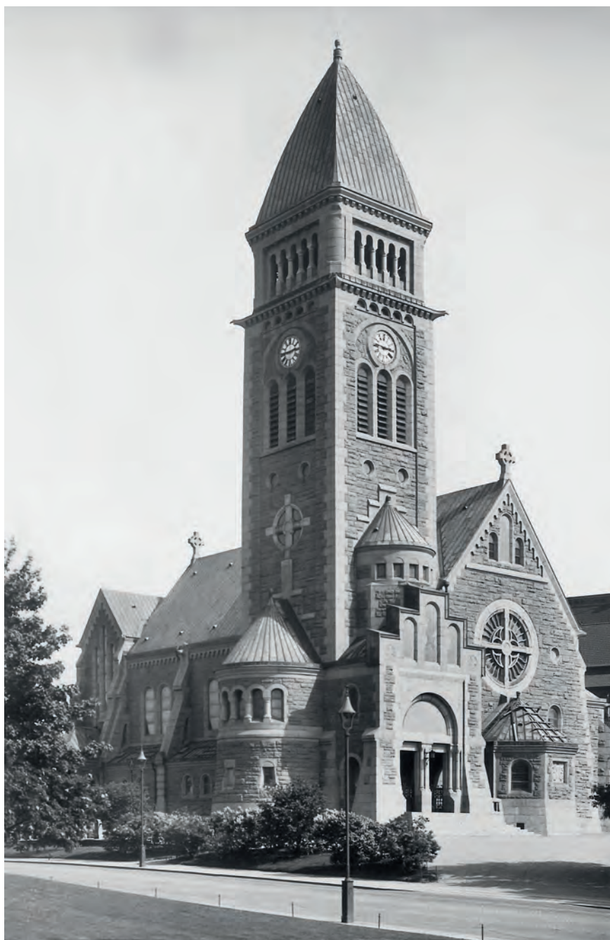
Fig. 66. Vasakyrkan i Göteborg. En av flera församlingskyrkor som uppfördes i det expanderande Göteborgs nya stadsdelar. Äldre foto av Sam Lindskog, ATA.
