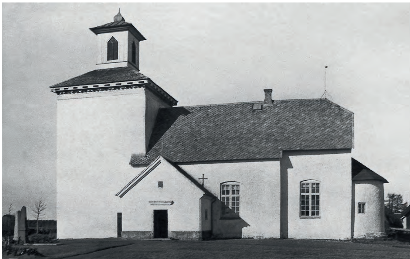
Fig. 60. Skeby kyrka är en romansk kyrka i klassicerande dräkt från 1796. Koret höjdes i nivå med långhuset för att rymma en ännu bevarad altarpredikstol. Tornöverbyggnaden härrör från 1800-talet. Foto Ärland Noreen 1927, ATA.
