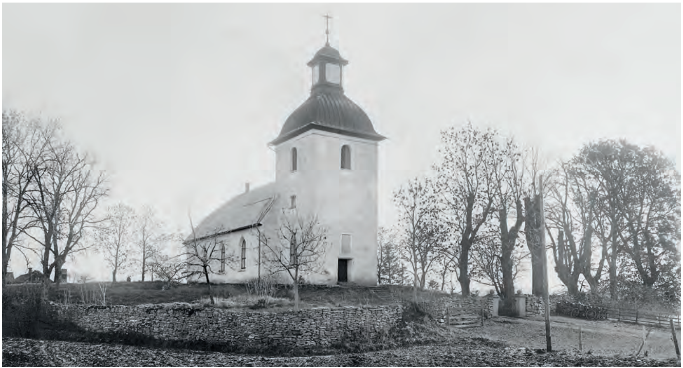
Fig. 52. Skärvs kyrka från 1780-talet är ett belysande exempel på Västergötlands gustavianska landskyrkor. Kyrkan uppfördes av Sven Westman, bosatt i samma socken och epokens ledande byggmästare i norra Västergötland. Här var byggnadsverksamheten livligast vid denna tid. Karakteristiska drag är det rundade koret, det höga valmtaket och tornets svängda huv med slutna lanternin. Westmans ritning för Skärv bearbetades i Överintendentsämbetet, främst beträffande tornutformningen. Foto Axel Forssén 1922, ATA.
