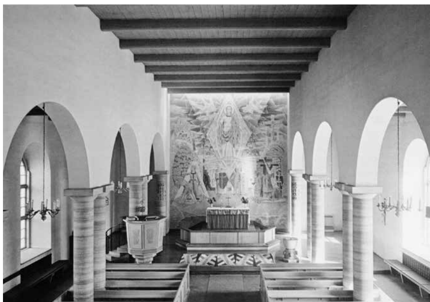
Fig. 46. Interiör av Kastlösa kyrka efter den genomgripande restaureringen 1953–54, då salkyrkan omvandlades till ett treskeppigt kyrkorum med trätak med synliga bjälkar. Mittskeppet domineras av en alfresco-målning av Waldemar Lorentzon. Foto Nilsson-Foto, Borgholm, 1979.
