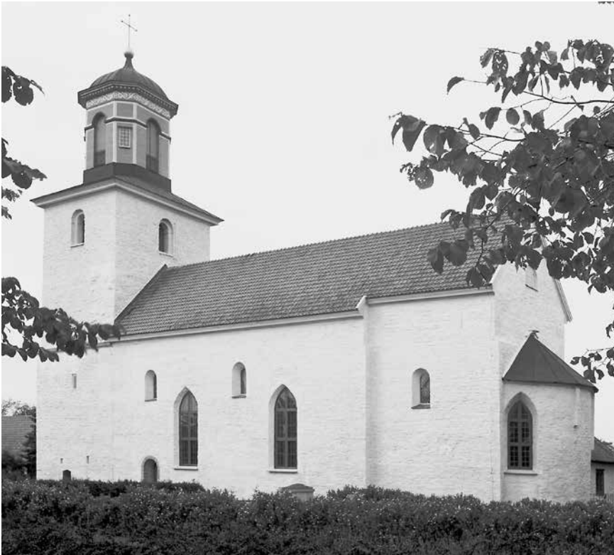
Fig. 12. Resmo romanska kyrka från söder. De stora spetsbågiga fönstren tillkom 1785, västtornets lanternin 1826, då även östtornet över koret revs. Kyrkan hade ursprungligen fyra högt sittande fönster i norra och södra långhusmuren. Av dessa kunde två på vardera sidan samt korets fönster åter öppnas vid restaureringen 1924. 1965 öppnades långhusets medeltida sydportal. Foto Ragnhild Boström 1967, SvK:s arkiv, RAÄ.
