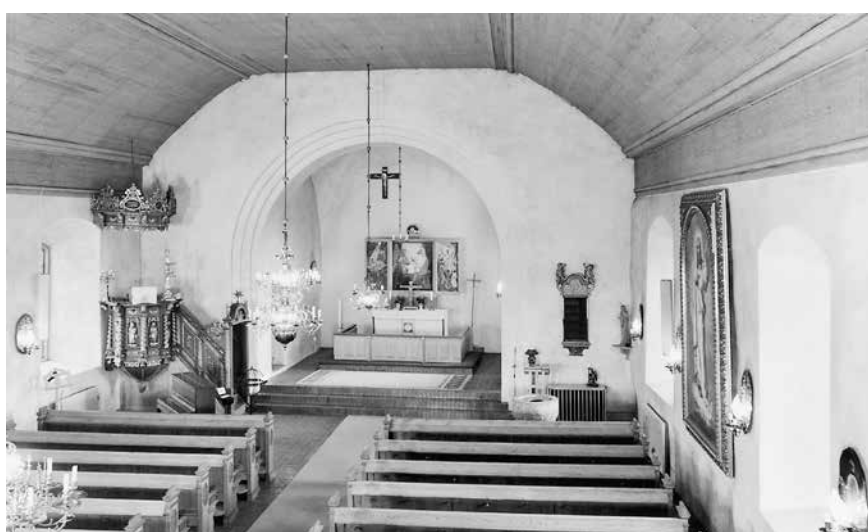
Fig. 45. Helgesta kyrka, interiör mot koret efter 1951 års restaurering. Restaureringens arkitekt, Karl Martin Westerberg, satte igen östfönstret och ritade ett nytt altarskåp med målningar av Gunnar Torhamn. All målad dekor avlägsnades och takmålningarna doldes bakom en ny panel. Foto Bengt A. Lundberg 1999, ATA.
