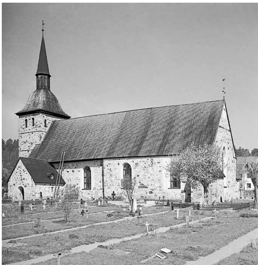
Fig. 17. Den romanska kyrkan i Botkyrka förlängdes åt öster under 1300-talets första hälft till nära sin dubbla längd. Vapenhuset i sydväst tillkom möjligen under samma period. Foto Ivar Schnell, 1940-talet, ATA.
