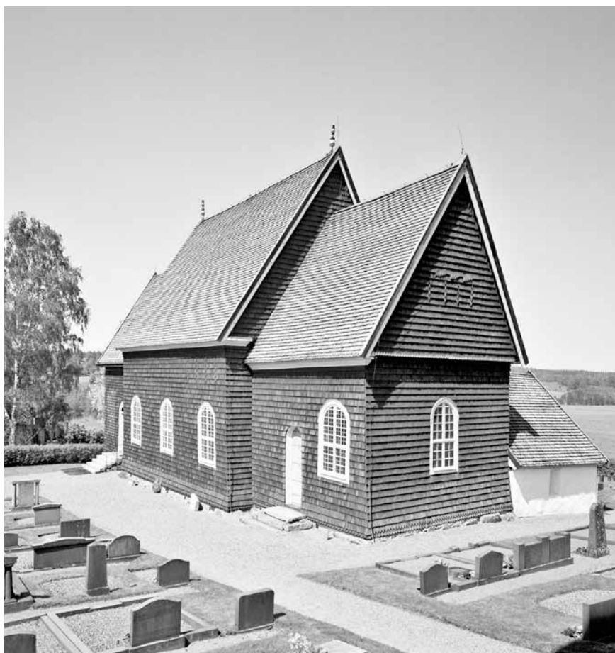
Fig. 14. Tidervals kyrka. Kyrkan är den enda medeltida träkyrka som bevarats i Östergötland och innehåller timmer som dendrodaterats till 1264. Sakristian av sten är en senare medeltida tillbyggnad. Foto Bengt A. Lundberg 2002, RAÄ.
