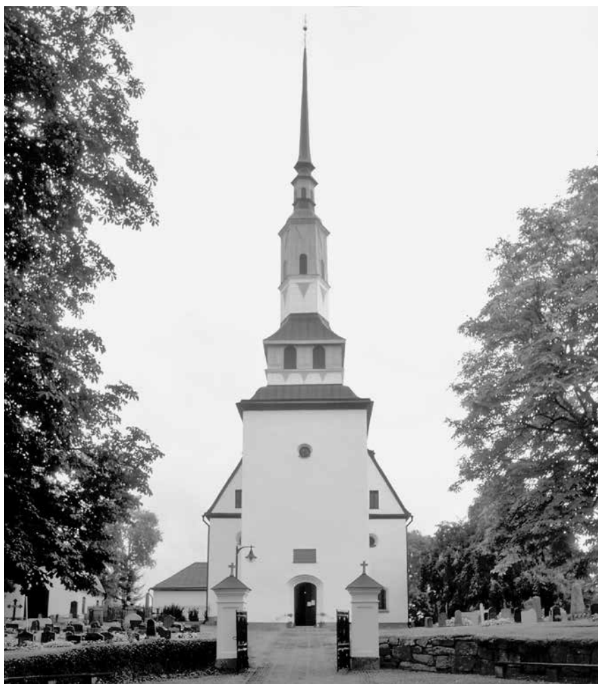
Fig. 39. Horns kyrka, byggd 1753, fick formen av en enkel salkyrka. Sakristian dimensionerades för skriftermål med många deltagare, som därefter gemensamt deltog i nattvardsfirandet. Den rationella planen kontrasterar mot byggmästaren Petter Frimodigs extravaganta spira. Foto Göran Lindahl 2003.
