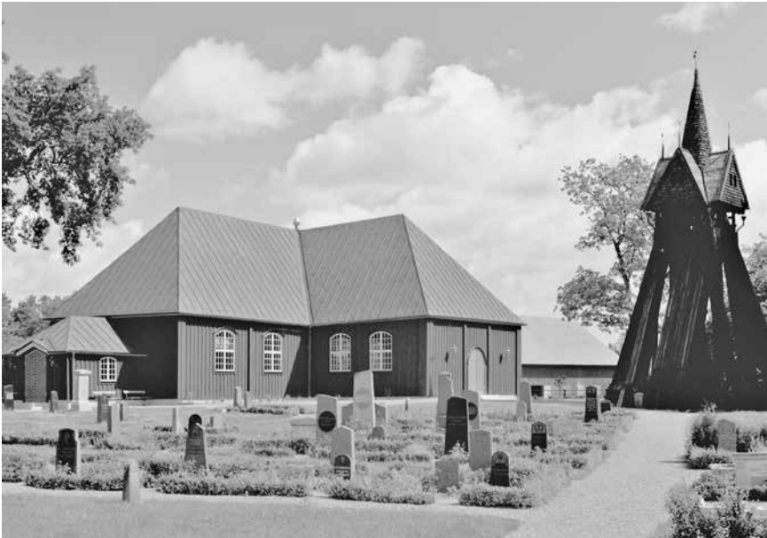
Fig 34. Jonsbergs kyrka byggdes 1726 av timmer, som sedan panelades. Den fick korsformad plan, en typ som under 1600-talet blivit vanlig i landskap där timmer utgjorde det naturliga byggnadsmaterialet. Klockstapeln är äldre, byggd 1692 och då tillhörig den träkyrka från 1609, som revs i samband med nybygget. Det missprydande koppartaket tillkom vid en restaurering avslutad 1961. Foto Carl Fredrik Mannerstråle 1961, ATA.
