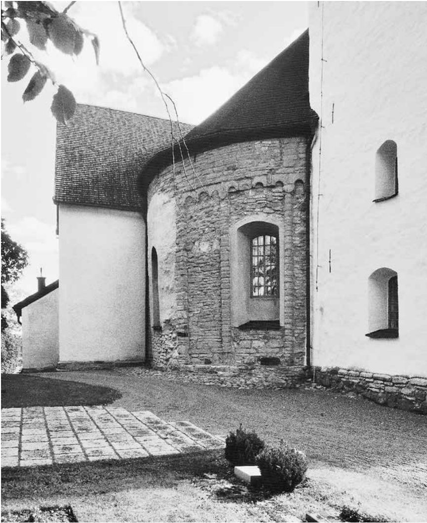
Fig. 20. Av rundkyrkan i Vårdsberg återstår ännu det romanska rundhuset, som här ses från norr. Till vänster i bild syns den norra korsarmen i det under 1200-talet byggda koret. Tornet till höger byggdes 1753–54. Foto Britt-Inger Johansson 1999.
