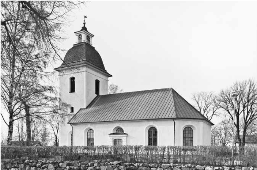
Fig. 49. Herrberga kyrka sydöst om Skänninge byggdes 1795–97 av byggmästaren Petter Lindstrand, som gjort ritningen, eventuellt med hjälp av Casper Seurling. Den klockformade huven är tidstypisk. Foto Albin Dahlström 1994, SvK:s arkiv, RAÄ.
