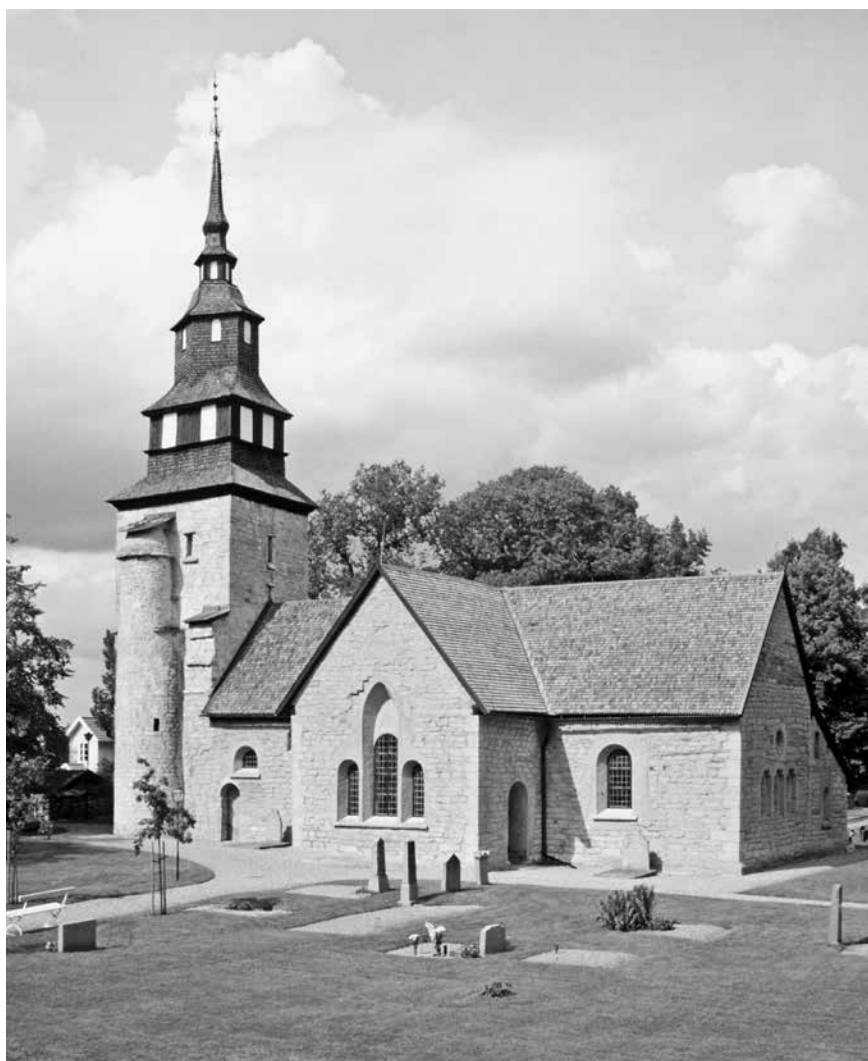
Fig. 21. Örberga kyrkas äldsta del är långhuset samt tornet med sina båda trapporn, vilka innehåller virke avverkad vintern 1117–18. Under tornet har påträffats tidiga s.k. patronusgravar. Det stora korsformade koret ersatte under 1200-talet det ursprungliga. De tre korfönstren med sitt krönande rundfönster är ursprungliga, medan den södra korsarmens fönster tagits upp under 1800-talet. Tornspiran uppfördes efter en brand 1750 av Peter Frimodig. Foto Gabriel Hildebrand 1986, RAÄ.
