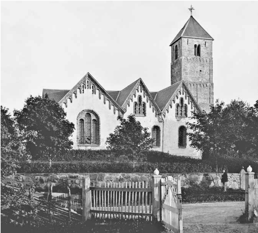
Fig. 69. Heda kyrka, exteriör från nordväst. Den medeltida kyrkan, belägen inte långt från Alvastra, söder om Tåkern, ombyggdes i flera etapper under 1600- och 1700-talen och hotades av rivning kring 1850. Lundaprofessorn Carl Georg Brunius insåg kyrkans stora värde och gjorde en ombyggnadsplan som genomfördes 1858. Då tillkom bl.a. gavlarna med rundbågsfriser. Foto Carl Fredrick Lindberg 1877, ATA.
