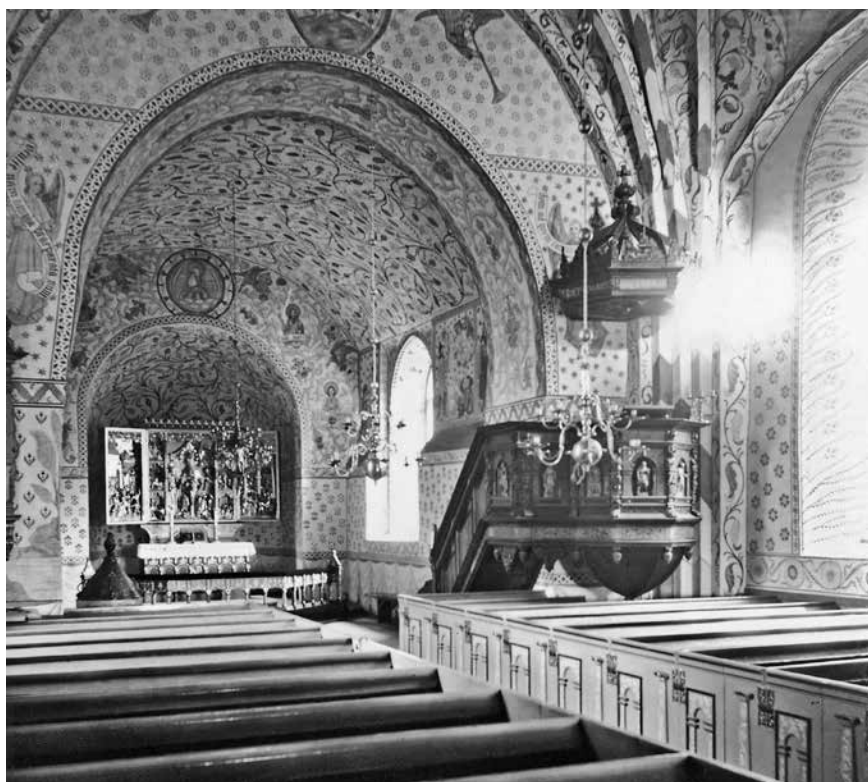
Fig. 71. Funbo kyrkas interiör efter Fredrik Falkenbergs restaurering 1896. Medeltida målningar har framtagits och kompletterats, så att de nästan täcker väggar och valv. Predikstolen från 1629 har återuppsatts, liksom det senmedeltida altarskåpet som fått ny förgyllning. Foto Fredrik Falkenberg ca 1896, ATA.
