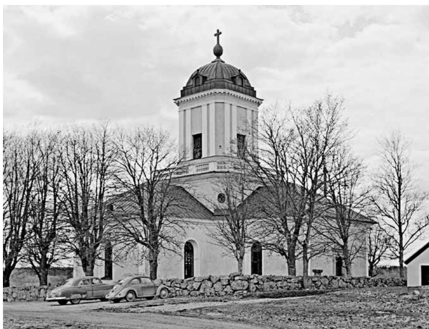
Fig. 52. Fasterna kyrka uppfördes 1797–1807, delvis på grunden av Esterna gamla kyrka. Den nya kyrkan blev gemensam för Fasta och Esterna socknar. Initiativtagare var bergsrådet Jean Le Febure, ägare till Rånäs bruk. Kyrkans korsform och mittorn återgår på Adolf Fredriks kyrka i Stockholm men formerna är enklare och stramare. Ritningarna utfördes av Olof Tempelman i Överintendentsämbetet med utgångspunkt från ett förslag av akademibyggmästaren Jonas Neosander i Uppsala. Foto Nils Lagergren 1956, ATA.
