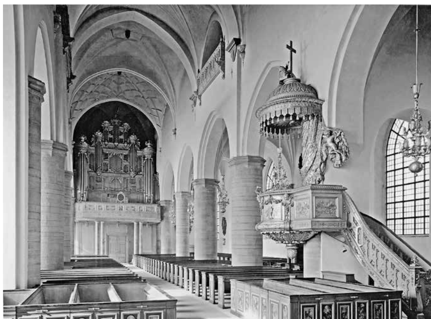
Fig. 77. Jakobs kyrka efter Ove Leijonhufvuds restaurering 1937. Dekor och inskrifter är överputsade, nya bänkar och ny orgelläktare har tillkommit. Resultatet är en enklare och kärvare interiör. Trots överväganden att delvis ta tillbaka dekoren beslöt man på 1960-talet att hålla fast vid 1937 års interiör. Foto ca 1938, ATA.
