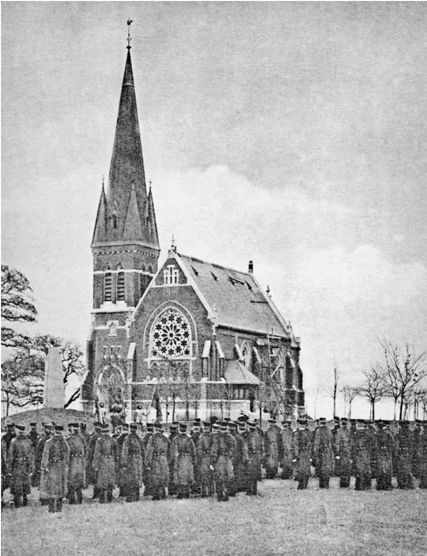
Fig. 65. Gustaf Adolfskyrkan i Stockholm, byggd 1891–92 efter ritningar av arkitekt Carl Möller som garnisonskyrka för Svea livgarde. Den upphörde som garnisonskyrka 1927 men fick snart ny funktion som stadsdelskyrka när Ladugårdsgärdet bebyggdes. En stiftelse ombesörjde driften till 1963 då Oscars församling köpte kyrkan. Äldre odaterat vykort i SvK:s arkiv, RAÄ.
