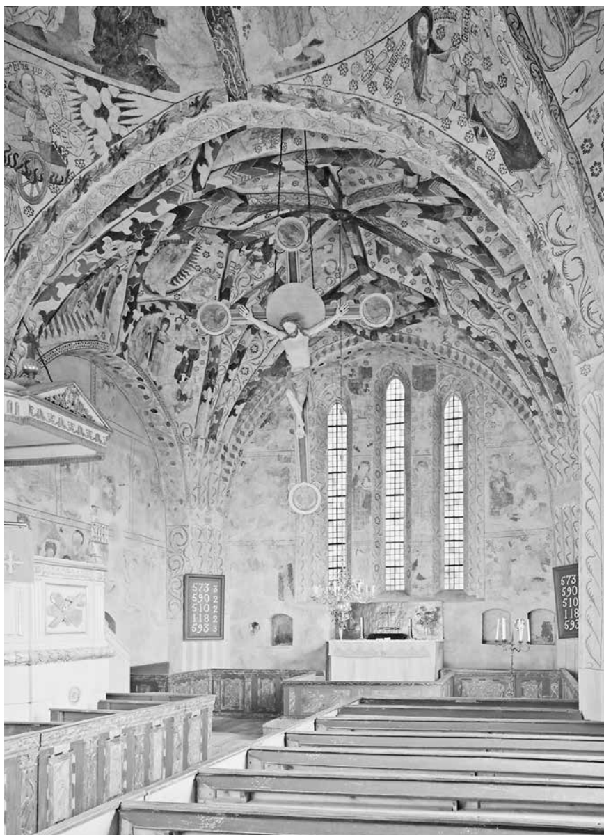
Fig. 23. Interiör av Härkeberga kyrka. Interiören är typisk för de uppländska salkyrkorna. Trefönstergruppen i koret och triumfkrucifixet visar att kyrkan byggts vid tiden omkring sekelskiftet 1300. Före de nuvarande tegelvalven från 1400-talets slut täcktes kyrkorummet av ett trätunnvalv. Samtidigt med valvslagningen fick kyrkan också sina berömda kalkmålningar av Albertus Pictor. Målningarna i valven har aldrig varit överkalkade. Foto Sören Hallgren 1967, ATA.
