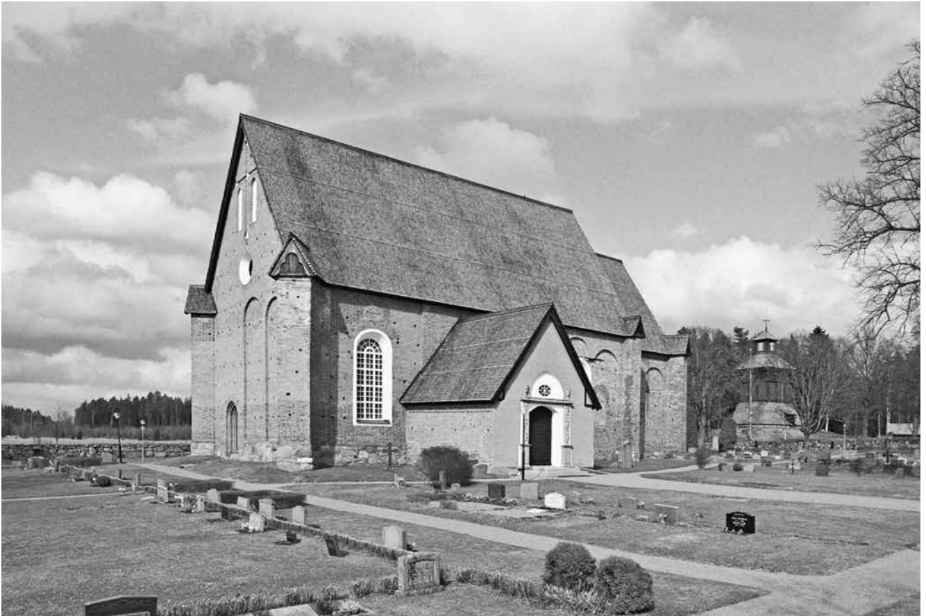
Fig. 22. I Tensta finns en av landets ståtligaste gotiska kyrkor, byggd vid tiden omkring sekelskiftet 1300. Den stora tegelkyrkan har ett smalare kor med tresidig avslutning, fasader prydda av stora blindarkader samt strävpelare i hörnen. I norra delen av västfasaden finns en portal och i gavelröret ett rundfönster samt en stor blinding. Även vapenhuset härrör från kyrkans äldsta tid. Kyrkorummet har varit övertäckt av ett högt trätunnvalv, vars konstruktion finns bevarad på vinden högt ovanför de senare inslagna 1400-talsvalven. Foto Bengt A. Lundberg 2001, ATA.
