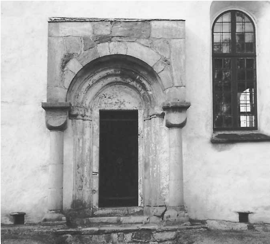
Fig. 46. Den flersprångiga baldakinportalen i Lannaskede gamla kyrka. Återställd i samband med restaureringen 1935–38. Foto Marian Ullén 1996, SvK:s arkiv, RAÄ.
