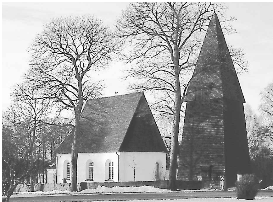
Fig. 72. Härlövs stenkyrka, uppförd 1695, ersatte en medeltida träkyrka. Kyrkan har liksom Tutaryds kyrka (fig. 64) räknats till de s.k. offerkyrkorna. Fönsteröppningarna fick sin nuvarande form 1886, då också vapenhuset flyttades från söder till väster. Timret i klockstapeln har vid en dendrokronologisk undersökning visat sig vara fällt i slutet av 1400-talet och klockstapeln är därmed den äldsta daterade i landet. Foto Jörgen Andersson 1998, Länstyrelsen i Kronobergs län.
