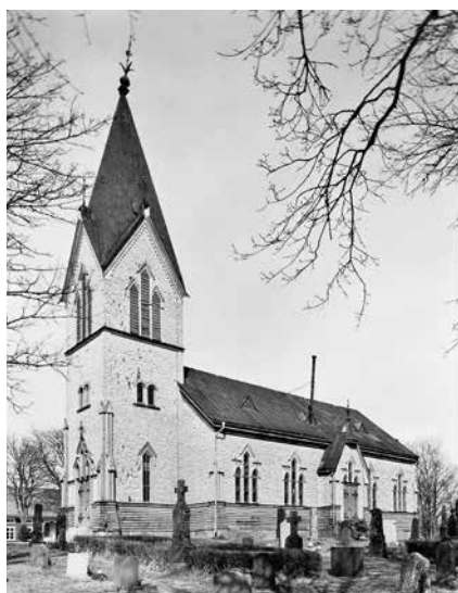
Fig. 103. Bosebo träkyrka, byggd 1894–95 men rivnen redan 1959. Kyrkan ritades av ingenjören Reinhold Hagstrand och var ett väl genomarbetat exempel på det sena 1800-talets snickeriarkitektur, där innerväggarna var klädda med laserad panel, mönsterlagd på olika ledder. Fasaderna var klädda med spån, mera troligen efter förebild från samtida amerikansk arkitektur än landskapets egna träkyrkor. Kyrkan hade tekniska brister. När församlingen inte kunde enas om att reparera kyrkan eller anta ett förslag om rivning och nybyggnad, förordade den visiterande biskopen det senare. Den nuvarande murade kyrkan, byggd på samma plats efter ritningar av arkitekt Rudolf Hall, invigdes 1962. Den träkyrka från 1600-talet som man övergav 1894 står nu på friluftsmuseet Kulturen i Lund. Foto från 1950-talets slut, ATA.
