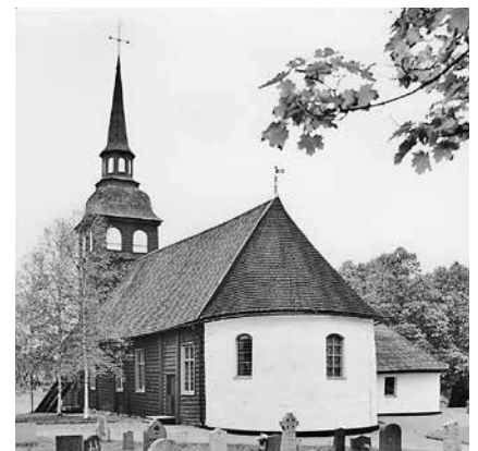
Fig. 66. Vireda kyrka. Exteriör samt planritning. Den medeltida träkyrkan har senare tillbyggnader av såväl sten som trä. Foto Rolf Hintze 1980, SvK:s arkiv, RAÄ.
