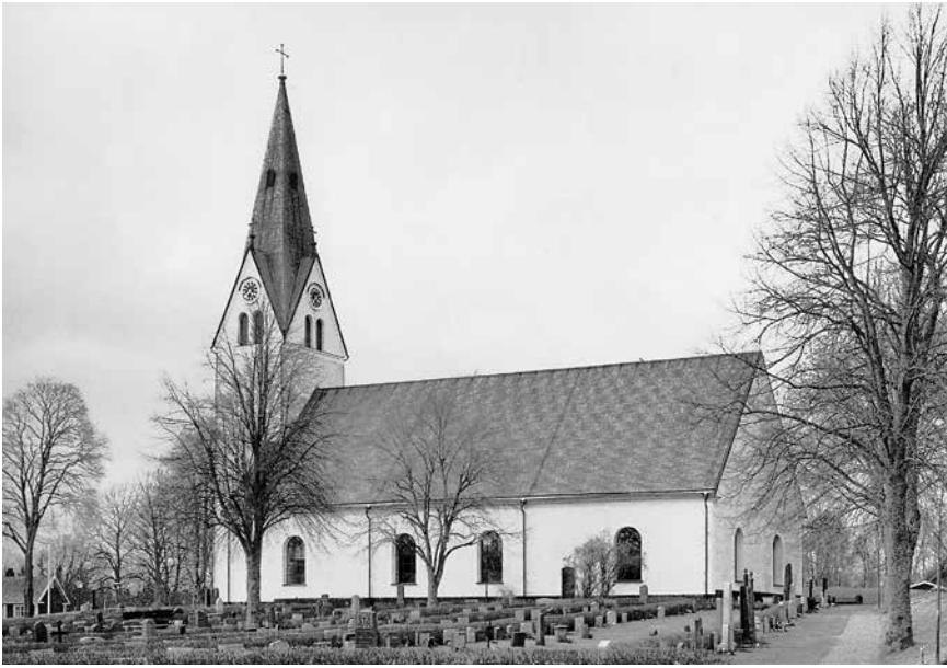
Fig. 109. Algutsboda kyrka efter Fredrik Lilljekvists genomgripande restaurering 1892–94. 1760-talets kyrka hade en ålderdomlig prägel med högre takresning och lägre ytttermurar med små, stickbågiga fönster. Tornet kröntes av en liten lanternin. Lilljekvist justerade proportionerna genom att sänka taket och ge tornet en reslig nygotisk spira. Fönstren förstorades och fick nygotisk spröjsning. Foto Albin Dahlström 1991, SuK:s arkiv, RAÄ.
