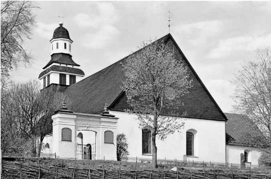
Fig. 73. Södra Vi kyrka, uppförd 1755, delvis efter ritningsförslag av biskopen Andreas Rhyzelius i Linköping. Tornet fullbordades 1764 av byggmästaren Petter Frimodig från Linköping. Äldre foto, ATA.
