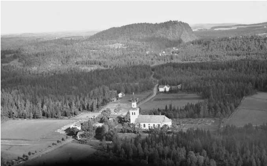
Fig. 6. Månsarps kyrka, region 2, från söder, med Tabergs karakteristiska silhuett i bakgrunden. Månsarps nya kyrka byggdes 1854 på en plats ca 300 meter öster om den gamla kyrkplatsen, där en ny träkyrka uppfördes 1714. Vid kyrkan ligger ännu skolhuset. I skogsbrynet skymtar det forna ålderdomshemmet. Tätorten Smålands Taberg är belägen ca 2 km norrut medan Månsarps stationssambälle ligger 1 km söderut. Foto Oscar Bladh 1934, RAÄ.
