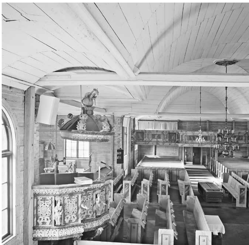
Fig. 31. Nyeds kyrka, interiör mot söder. Trävalvets breda utkragning och bindbjälkar antyder takstolens konstruktion. Predikstolen är snidad av Börje Löfman 1717 och målades 1721. Foto Göran Lindahl 1999.
