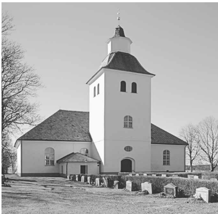
Fig. 39. Rudskoga kyrka, fasaden mot norr. Kyrkan byggdes i murverk av Johan Georg Reincke och invigdes 1777. Den är ett tidigt exempel på planformen med tornet mitt på ena långsidan. Foto Göran Lindahl 1997.
