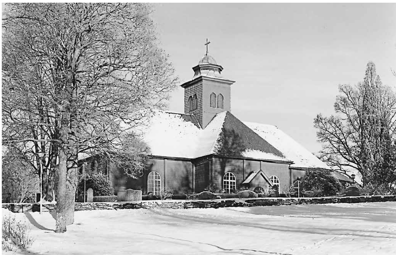
Fig 29. Alsters kyrka, exteriör. Den timrade träkyrkan med korsplan och mittorn byggdes 1693–95 av Anders Rang från Filipstad. Tak och väggar är klädda med rödfärgat spån. Vid en genomgripande restaurering 1914–15 förkortades korsarmarna. Foto Elliot Elliot 2003.
