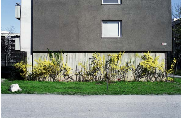
Ursprungligt utförande av sockelparti, uppmärksamma förskjutningarna av fasadlivet.
