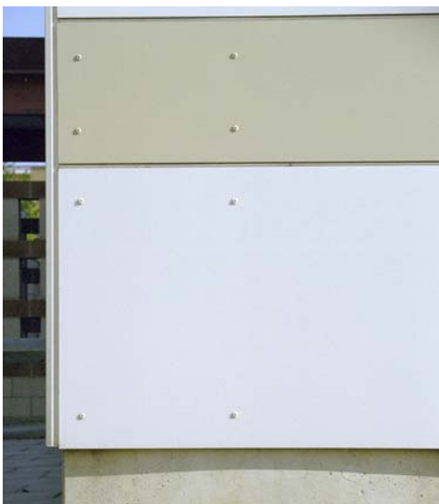
Ny fasadbeklädnad, uppmärksamma särskilt hörnprofilen och förändringen av fogarna.
