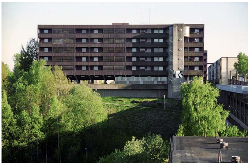
Gallerihus, norrfasad, med balkonger inklädda i mörkbrun korrugerad aluminiumplåt. Uppmärksamma den öppna delen i bottenvåningen.
