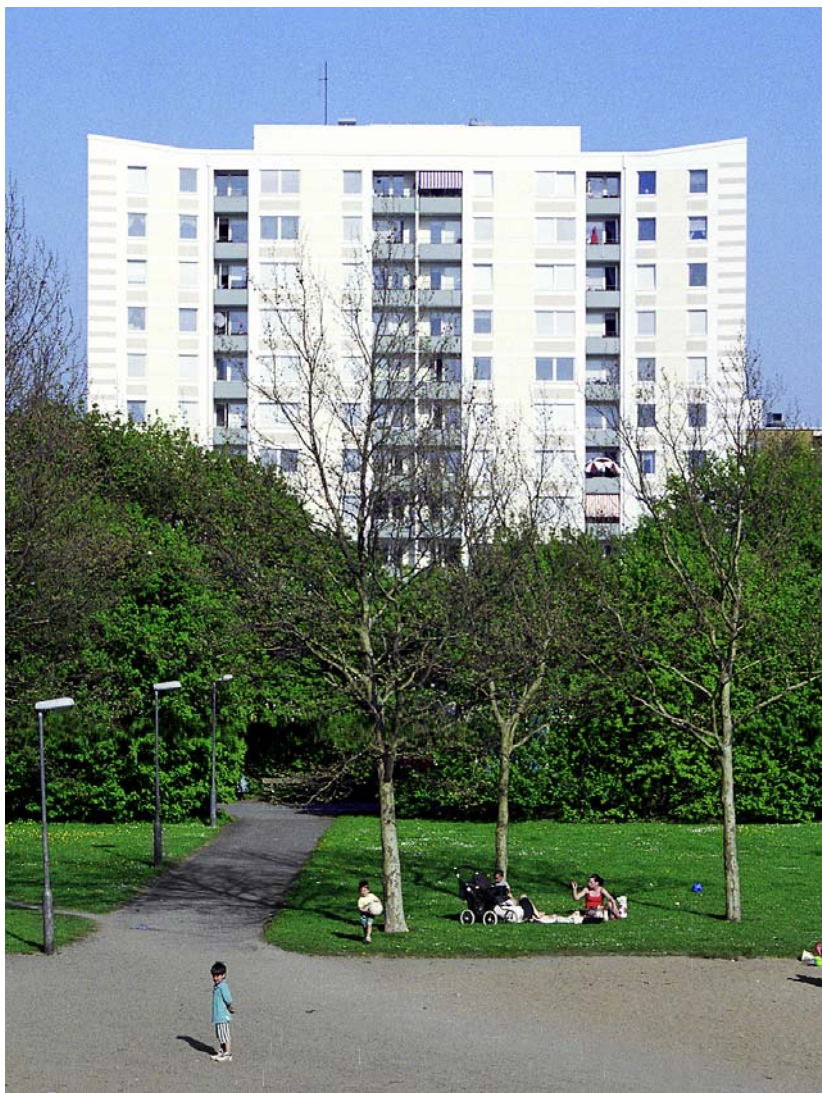
Ny gestaltning av fasad mot parken.
