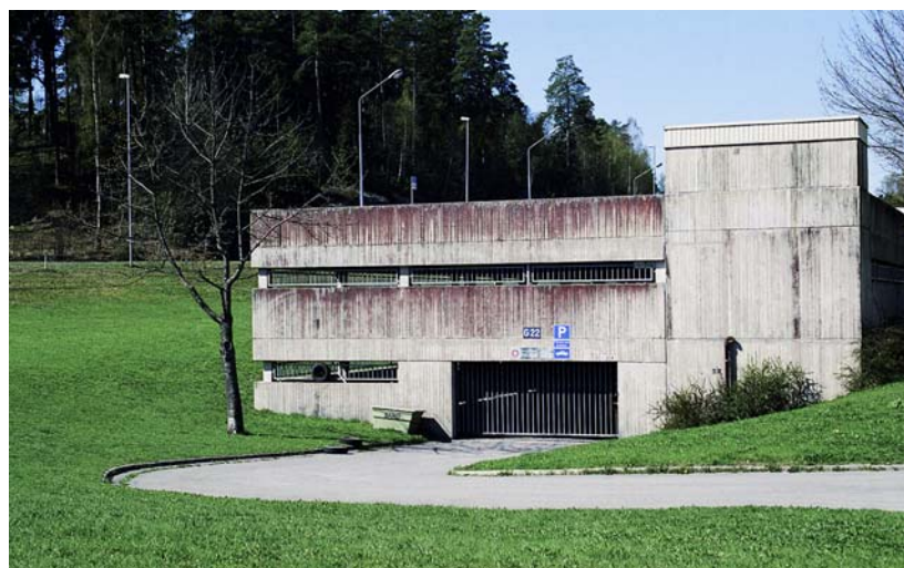
Parkeringsgaragen i obehandlad betong gjuten mot brädform.
