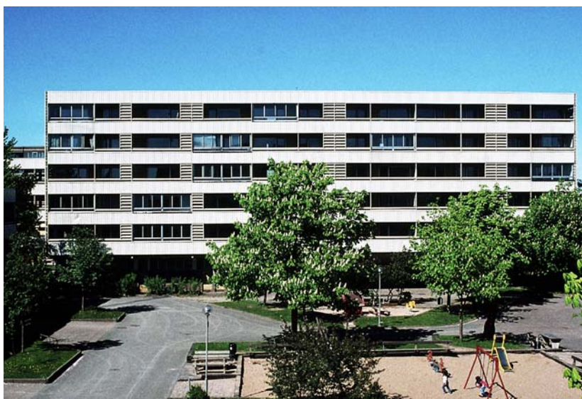
Gallerihus, sydfasad, med balkonger inklädda i vit korrugerad aluminiumplåt.
