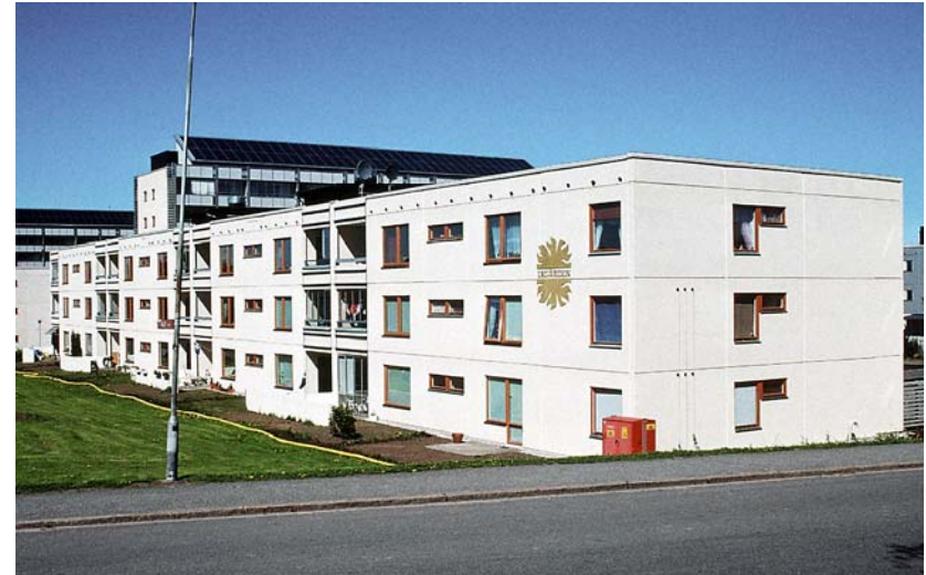
Lamellhus, utåt ny färgsättning av fasader och fönstersnickerier, i övrigt små förändringar. Uppmärksamma särskilt utförandet av takfot och balkongfronter.
