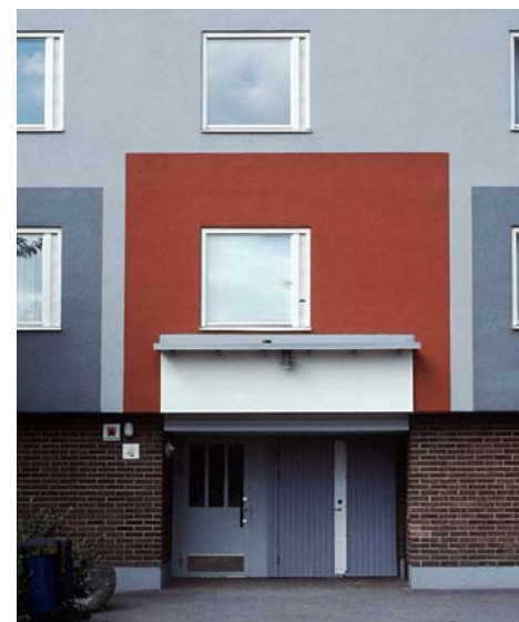
Renoverat och tilläggsisolerat entréparti med ny färgsättning.
