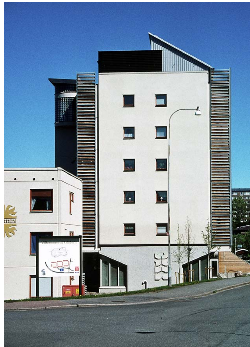
Ny gavel på gallerihus, tilläggen skapar kraftiga förändringar av helhetsintrycket. Märk att elementfogarna har försvunnit i den här lösningen med tilläggsisolering och puts.
