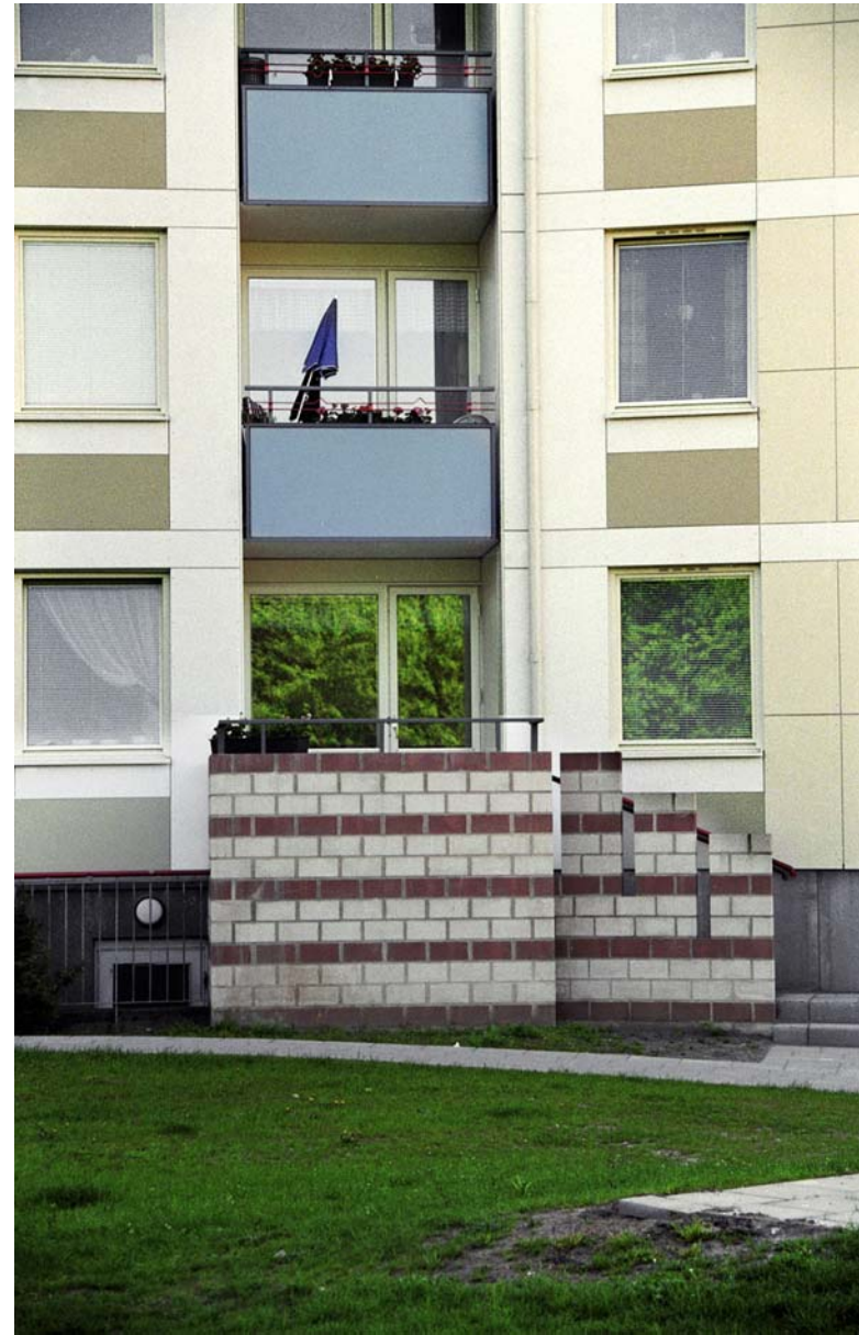
Nya balkongfronter och ombyggnad av balkong i markplan.
