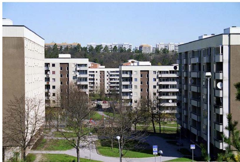
Ljusa fasader in mot gårdsmiljöerna och mörka utåt i Albydalen, Albyberget i bakgrunden. Notera de vertikala nischerna i mörkt tegel som markerar trapphusen in mot gårdarna.
