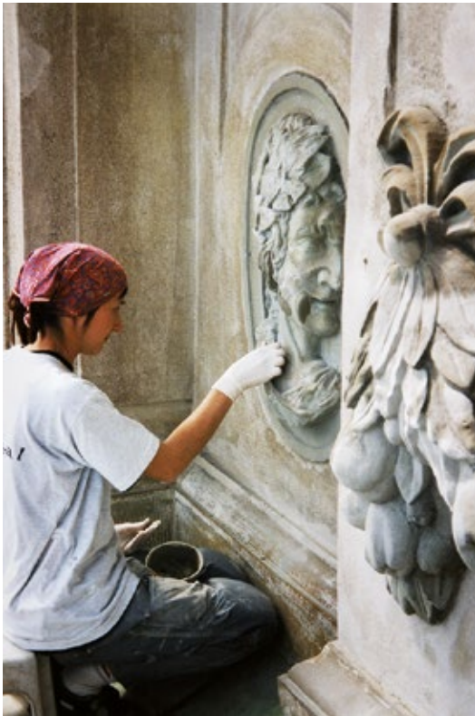
Konservering av stuckmedaljong på Bondeska palatsets fasad, Stockholm.
