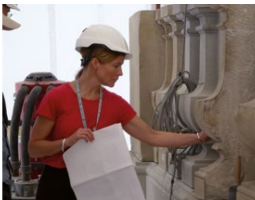
Inspektion av utbytt sandsten på Stockholms slott.
