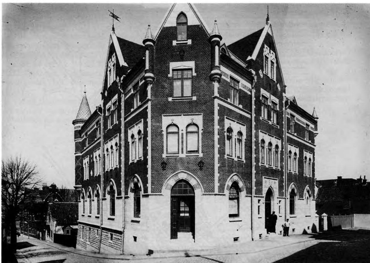
Figur 13. DBW:s sparbank från 1903 med naturstensdetaljer av gotländsk sandsten. Foto K. J. A. Gardsten 1905, Valdemar Falks bildarkiv.
