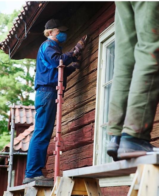
Underhåll av byggnaderna vid bergsmansgården Gamla Staberg, Falun.
