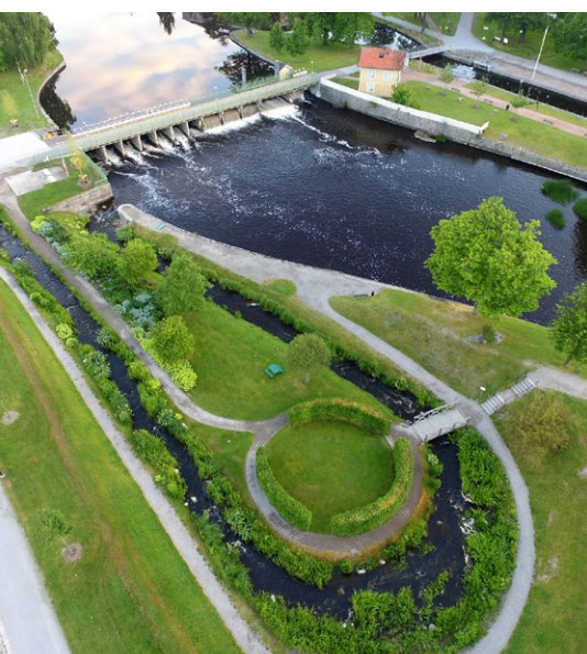
Fiskvandringväg vid slussen i Svartån, Örebro.
