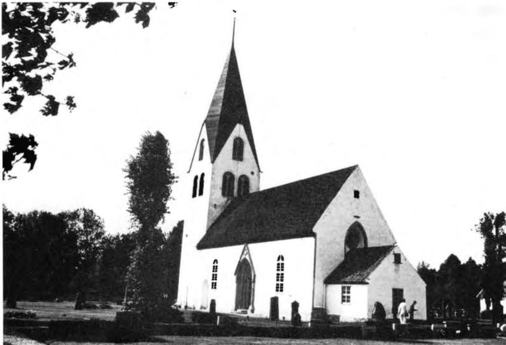
Bild 31, Eksta kyrka på Gotland putsades om 1972. Nio år senare var den fortfarande i gott skick. Det är viktigt att sådana arbeten uppmärksammas i kommande utvecklingsprojekt. Foto 1981, Arksam AB.
