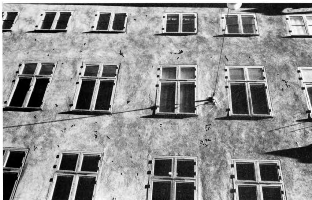
Bild 20 , Färgvittring kan vara relativt omfattande utan att behöva upplevas som störande. Fasad putsad och avfärgad 1972. Munkbrogatan 9, Gamla stan. Foto 1981, Arksam AB.
