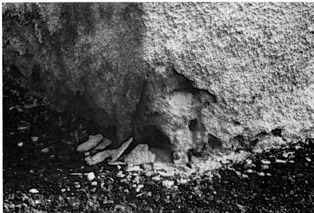
Bild 9 , Många putsskador återfinns vid sockeln. Foto 1981, Ark-sam AB.
