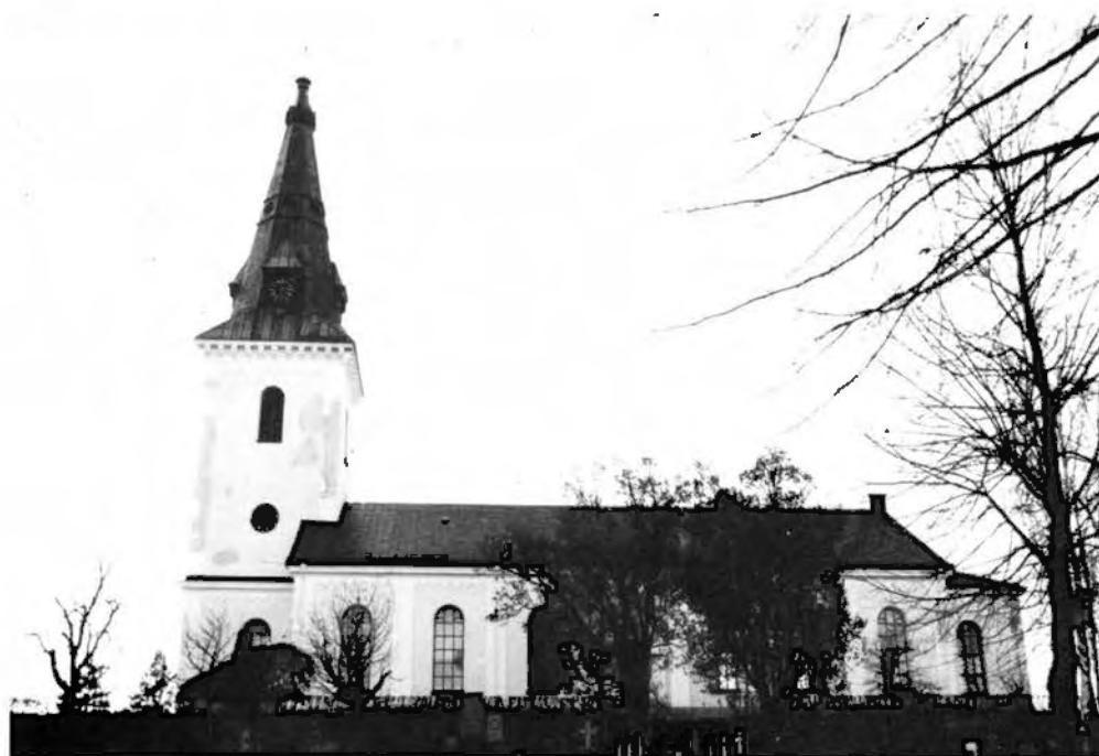
Bild 22 , Enångers kyrka i Gävleborgs län, putsad 1976. Året därpå uppstod stora putsnedfall på tornet. Samma typ av skada fanns på tornet innan omputsningen. Skadeorsaken ej klarlagd. Foto 1982, Riksantikvarieämbetet.
