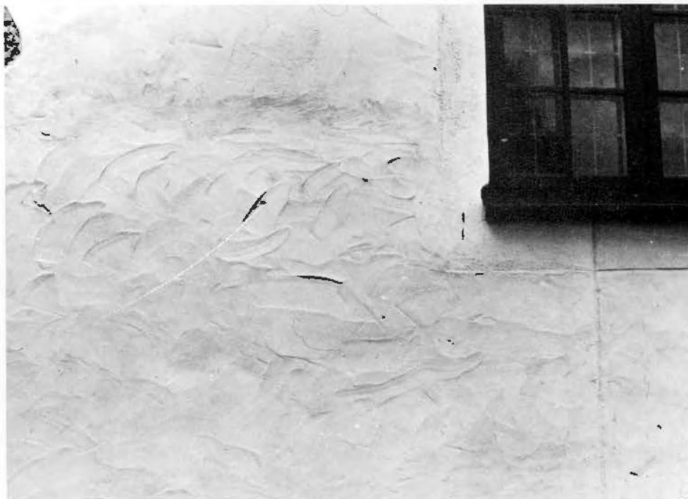
Bild 30, Vägg där man sökt uppnå samma utseende som på bild 29. Men i stället för att med slevens hjälp försöka jämna till kalkbruket har man här missuppfattat tillvägagångssättet och låtit slevan sätta alltför tydliga spår. Foto 1981, Arksam AB.
