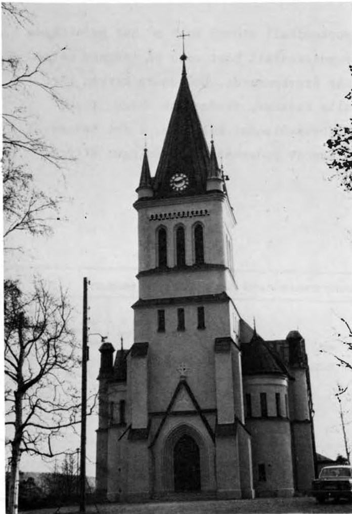
Bild 23, Skönsmons kyrka i Västernorrlands län. Avfärgades 1969. Hade dessförinnan inte avfärgats sedan 1889. I stort sett felfri. Foto 1982, Riksantikvarieämbetet.
