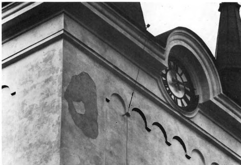
Bild 7, Å andra sidan kan mindre putsnedfall sitta så att de syns på långt håll. Foto 1981, Arksam AB.
