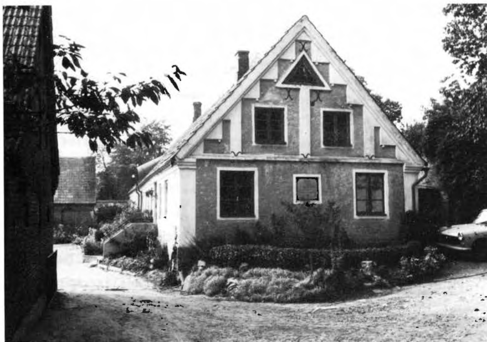
Bild 24, Kulturhistoriskt värdefulla byggnader är viktiga att vårda som vittnesbörd om sin tids byggnadsskick. Kalkputsad huvudbyggnad i Gårdlösa, Kristianstad län. Foto 1981, Arksam AB.
