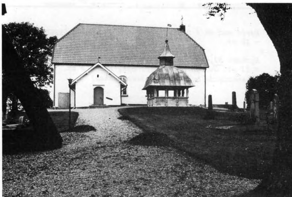
Bild 16 , Laske-Vedums kyrka, putsad 1978. Hydraulisk kalk i stockningen, ren kalk i ytputsen. Foto 1981, Arksam AB.
