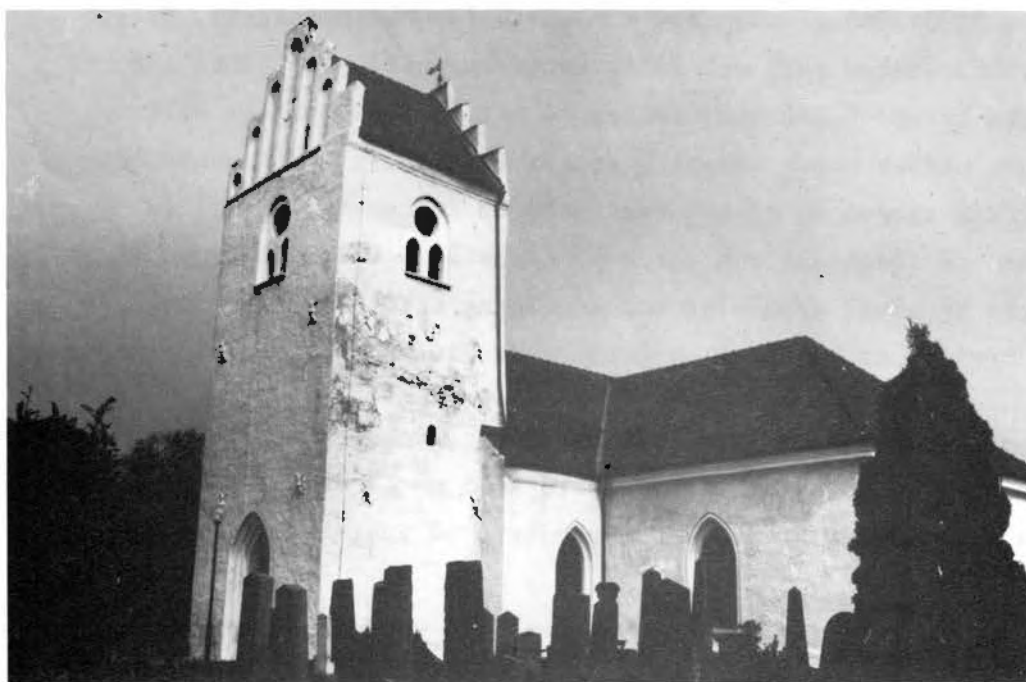
Bild 12 , Putsnedfall på tornets södra sida. Kvistofta kyrka, putsad 1978. Foto 1981, Arksam AB.
