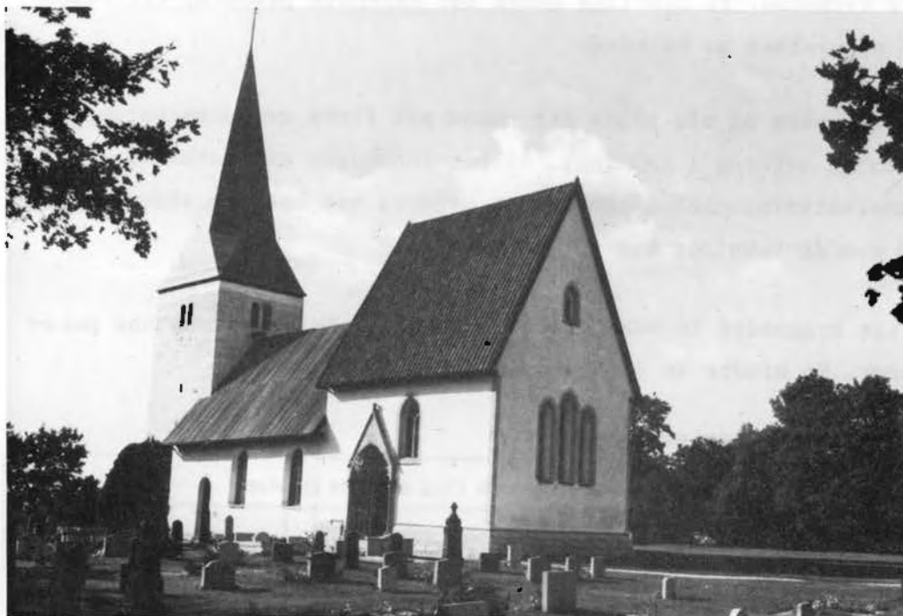
Bild 14, På Fröjels kyrka putsades koret och långhusets södra sida om 1973. Övriga delar är oputsade. Åtta år senare var putsen i mycket gott skick. Foto 1981, Arksam AB.
