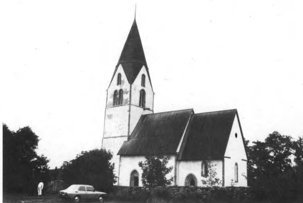
Bild 8 , Tornen är mest utsatta på kyrkorna, särskilt högt uppe på syd- och västfasaderna är putsnedfall inte ovanligt. Foto 1981, Arksam AB.
