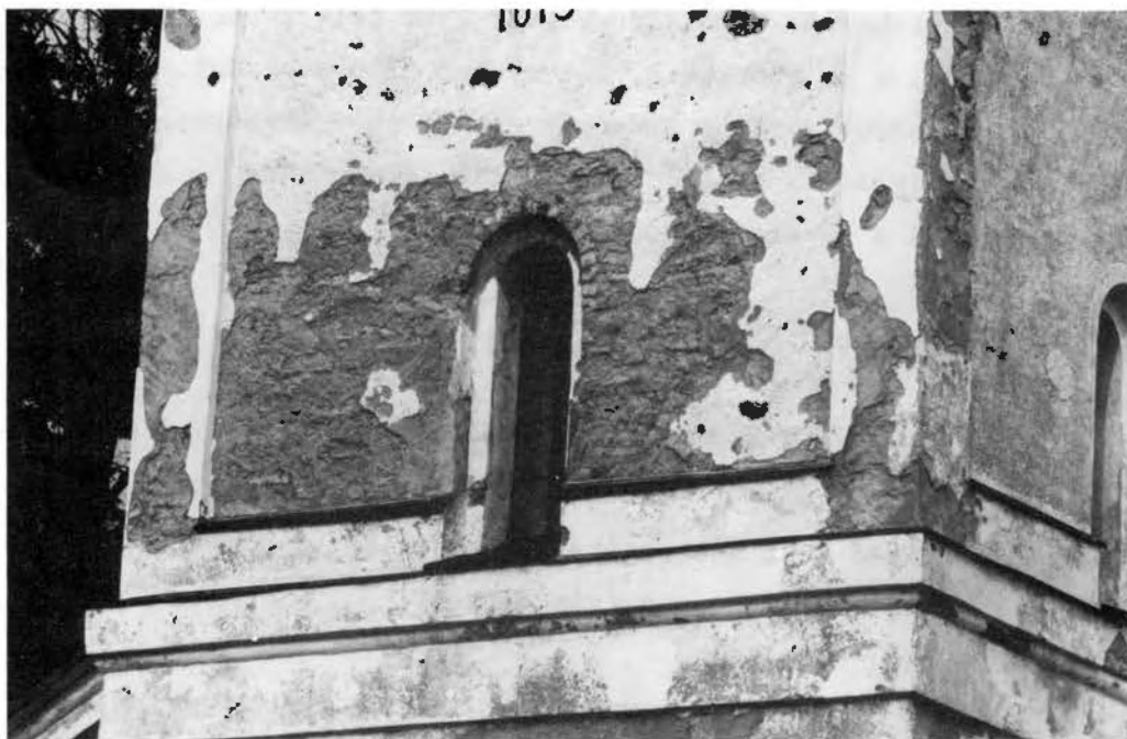
Bild 26, Kyrktornens övre delar mot söder och väster är mest utsatta när det gäller större putsnedfall. Kverrestad kyrka i Kristianstad län, putsad 1979. Foto 1981, Arksam AB.
