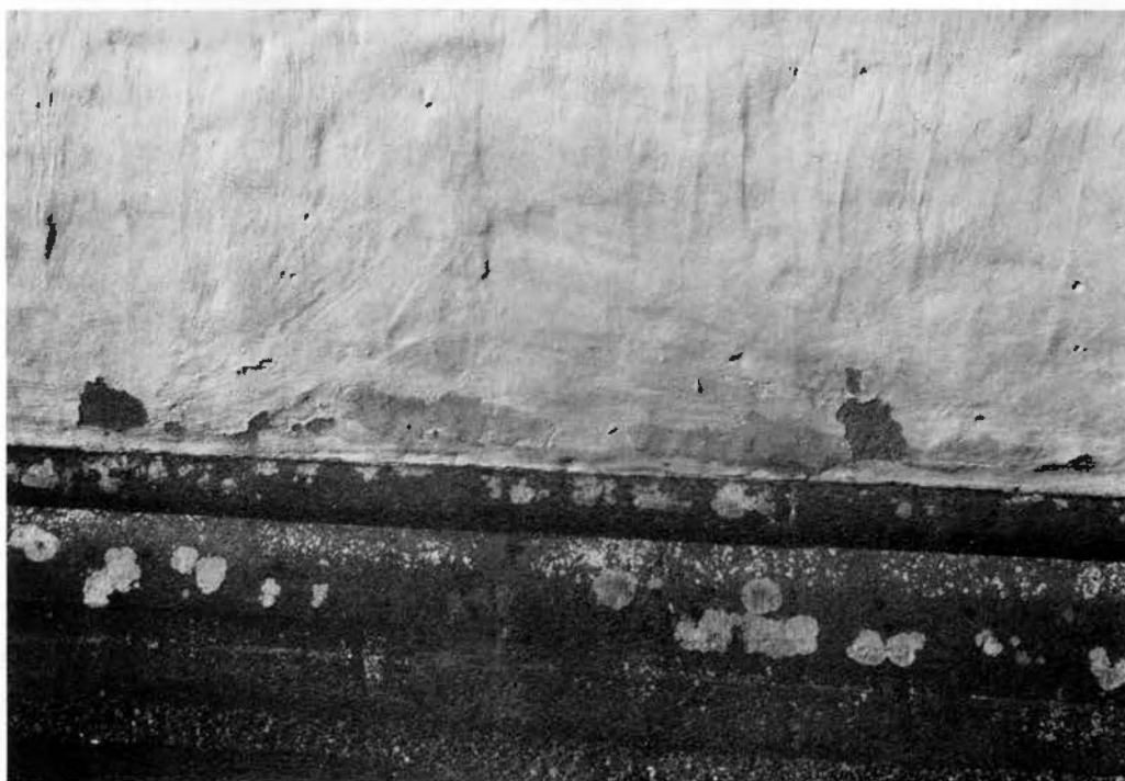
Bild 27, Där mindre putsnedfall förekommer återfinns de ofta vid sockeln. Lye kyrka på Gotland, putsad 1968. Foto 1981, Arksam AB.
