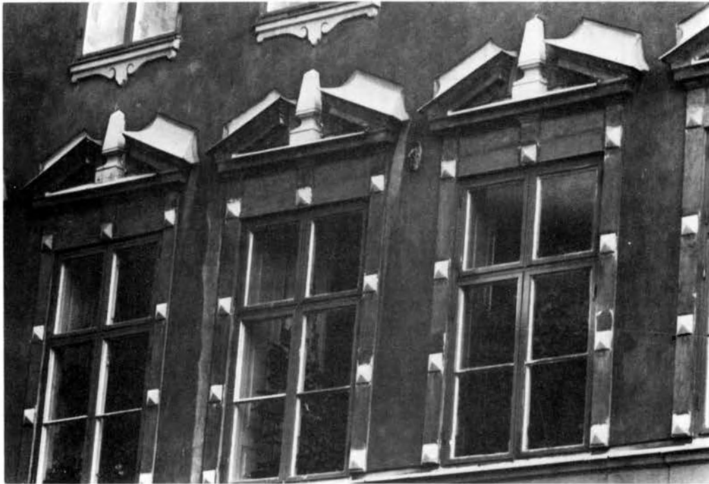
Bild 21, Studenthem vid Stortorget i Gamla stan, kalkavfärgat på kalkcementputs 1965. Foto 1981, Arksam AB.
