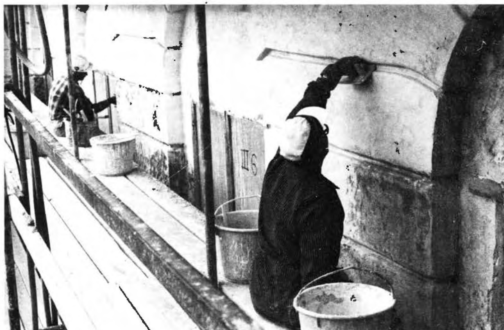
Bild 1, Putsrenovering med kalkbruk på Skokloster slott. Foto 1976, Arksam AB.
