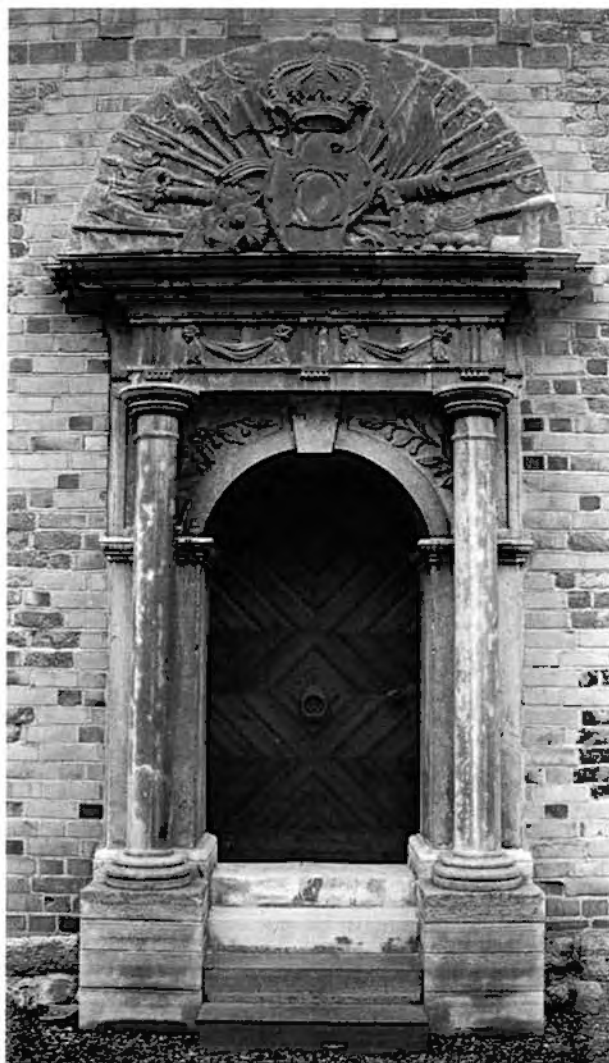
Figur 17. Portal av östgötsk kalksten från 1700-talet sekundärt insatt i det medeltida Bjälbopalatset i Vadstena. Foto J. Eriksson 1992, Östergötlands länsmuseum.
