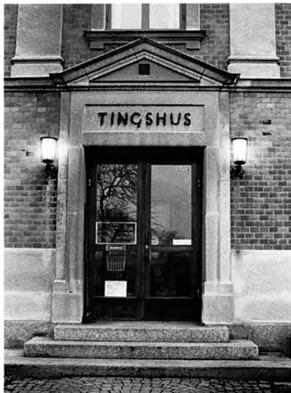
Figur 16. Tingshuset i Mjölby med portal av Yxhultskalksten från 1907. Foto J. Eriksson 1992, Östergötlands länsmuseum.
