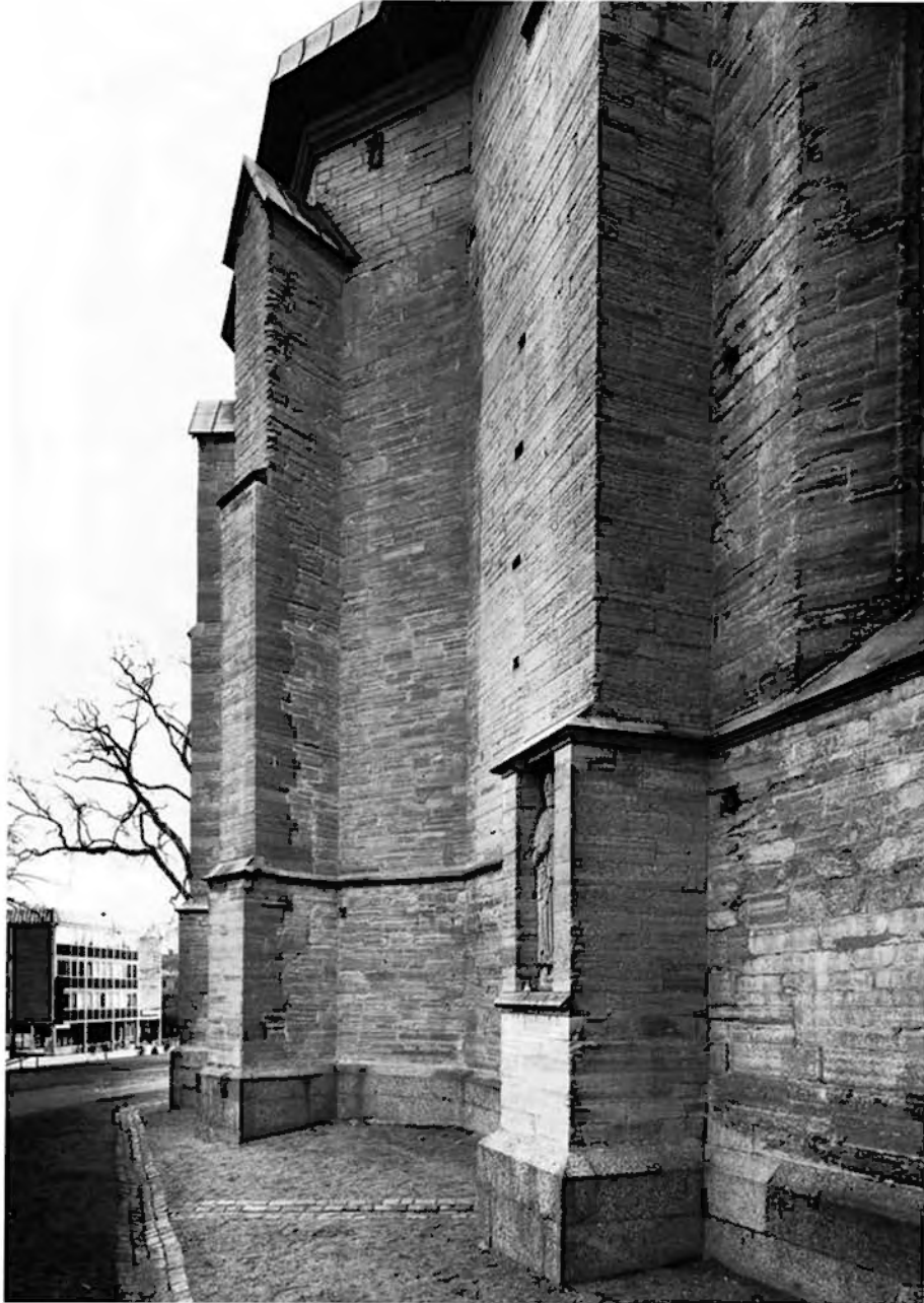
Figur 12. Linköpings domkyrka. Detalj av norra muren som är byggd av välhuggen kvader av Borghamnskalksten från 1230-tal till omkring 1500. Strävpelarna byggdes om på 1850-talet med kalksten från Vretaområdet, mörkare partier. En skulptur föreställande aposteln Petrus från 1630-talet, huggen i Vätternsandsten, skymtar i närmsta strävpelaren. Foto Bengt A. Lundberg 1995.
