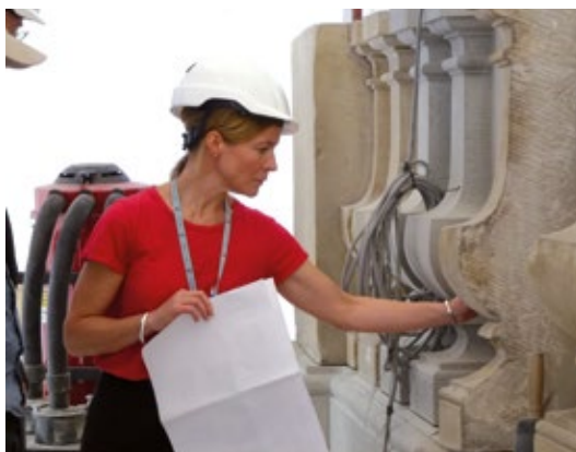
Inspektion av utbytt sandsten på Stockholms slott.
