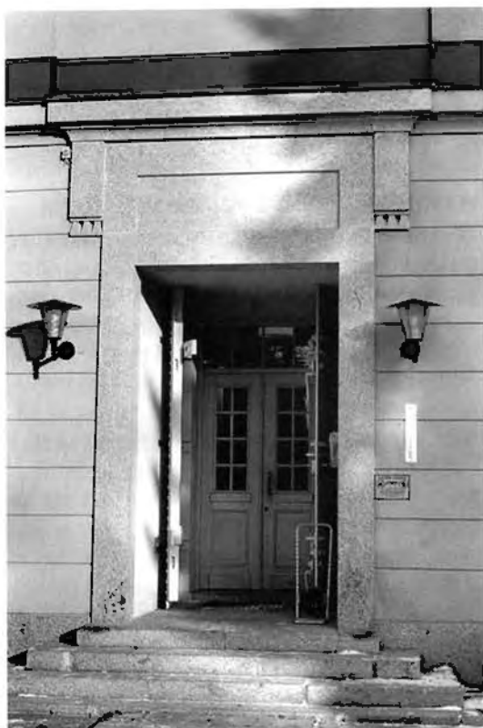
Figur 9. Portal från 1910 av urberg i Kommendantbyggnaden 119, Boden. Foto P. Moritz 1993, Norrbottens museum.
