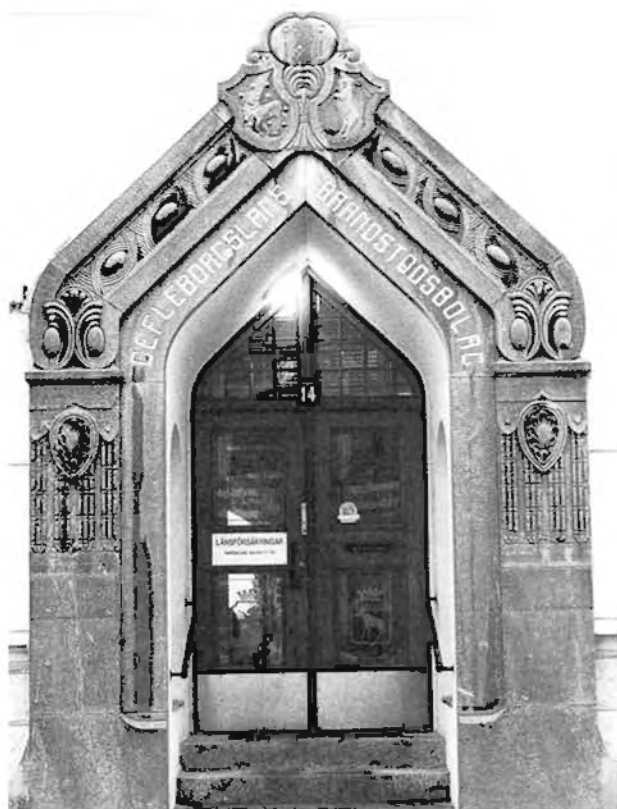
Figur 51. Portal av Yxhultskalksten från 1910 i f.d. Gefleborgs läns brandstödsbolag, nu Länsförsäkringar. Foto B. J. Sjöblom 1996, Hälsinglands museum.
