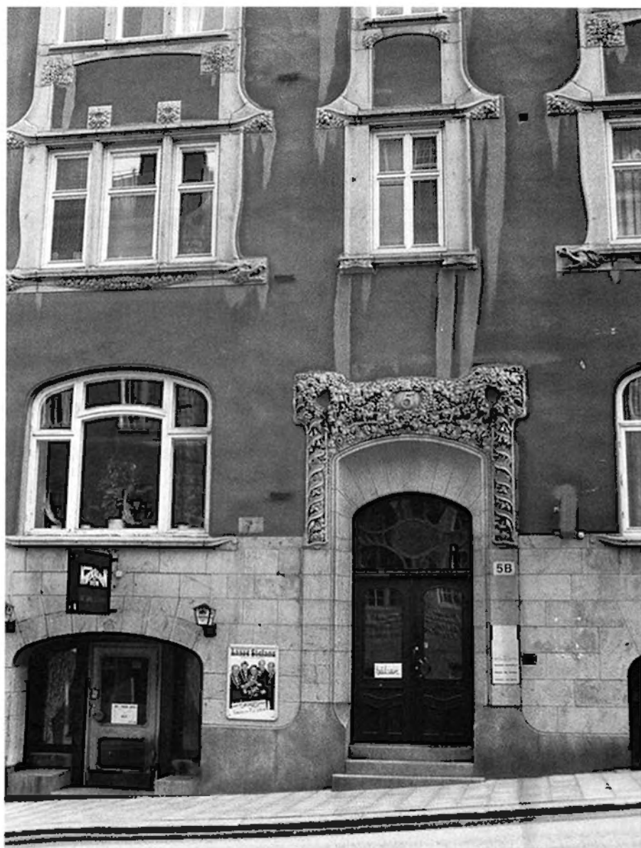
Figur 37. Portal och fasadsten av täljsten. Bostadshus vid Nybrogatan-Storgatan i Härnösand, ritat av Gustaf Hermansson 1903. Foto H. Ek 1993, Länsmuseet Västernorrland.
