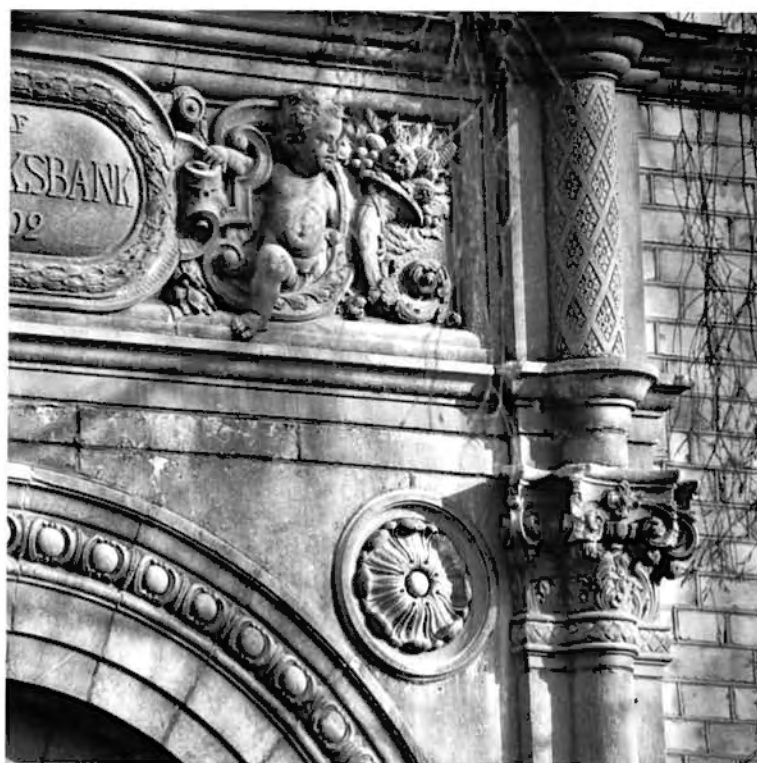
Figur 15. Gamla Riksbanken i Umeå, detalj av portalomfattning av Yxhultskalksten. Riksbanken är byggd 1900 efter ritningar av F. O. Lindström. Foto S. Wengelin 1989, Västerbottens museum.
