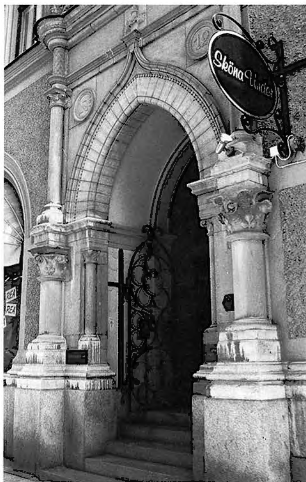
Figur 35. Portal av Yxhultskalksten i bostadshus från 1892 vid Storgatan i Sundsvall. Arkitekt Gustaf Hermansson. Foto H. Ek 1993, Länsmuseet Västernorrland.
