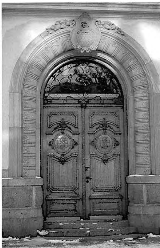
Figur 7. Portal av Orsasandsten från 1902, Riksbanken i Luleå. Foto R. Löfvendahl 1995.
