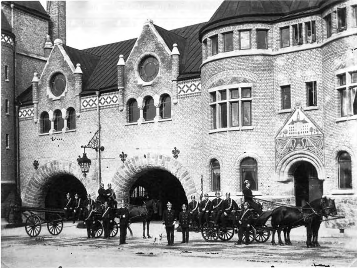
Figur 49. Brandstationen i Gävle från 1890–91 uppförd efter ritningar av Ferdinand Boberg. Sockeln är av granit, kvadergrunden, portomfattningarna och vissa fönsteromfattningar och lister är av Gävlesandsten medan kolonner, fönsterbänkar och hörnstenar är av gotländsk sandsten. Foto Läns museet i Gävleborgs län.
